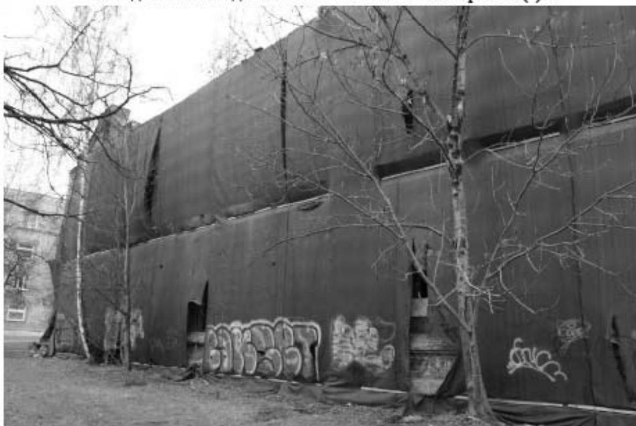
Фото 4. Вид на юго-восточный фасад выявленного объекта культурного наследия «Жилой дом Ремесленного женского приюта (?)».
