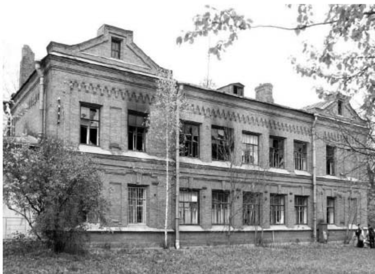
Илл. 68. Пушкин, Набережная улица, дом 3. Юго-восточный фасад. 2011 г. (источник: https://www.citywalls.ru/photo194799.html ).
