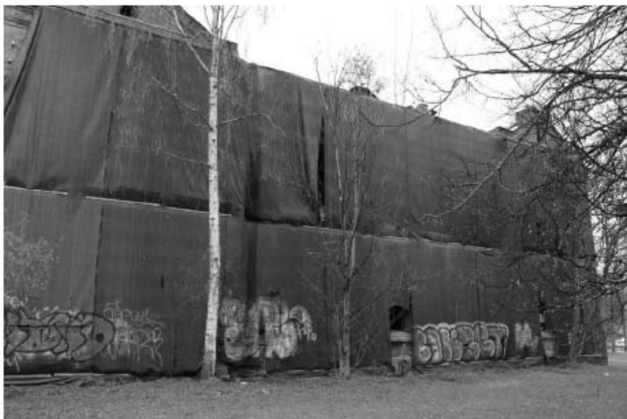
Фото 5. Вид на юго-восточный фасад выявленного объекта культурного наследия «Жилой дом Ремесленного женского приюта (?)».
