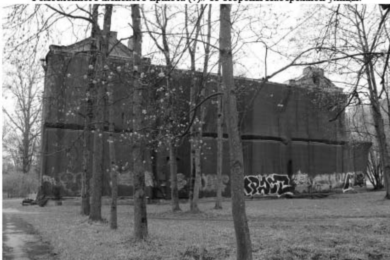
Фото 2. Вид на северо-западный фасад выявленного объекта культурного наследия «Жилой дом Ремесленного женского приюта (?)».
