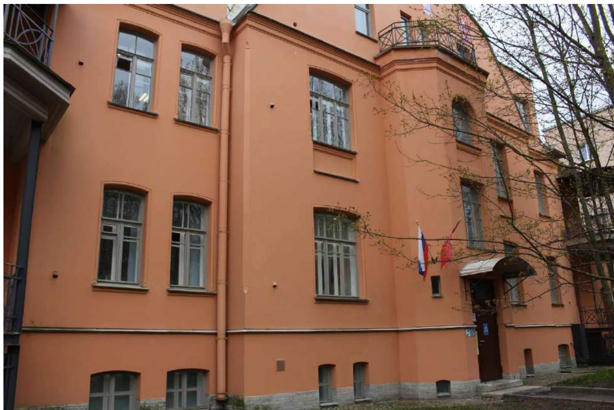
Фото 7. Вид на северо-западный фасад выявленного объекта культурного наследия «Начальное училище и приют Общества пособия бедным детям римско-католического прихода».
