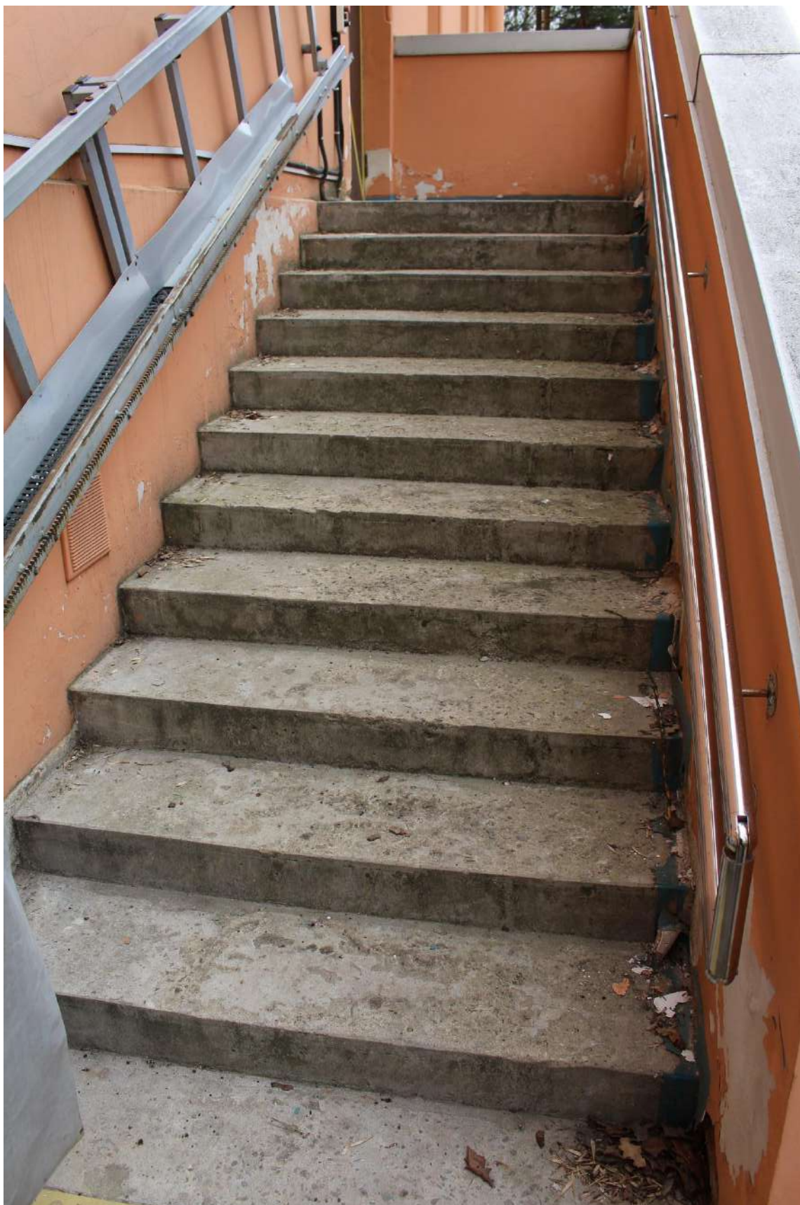
Фото 15. Вид на юго-восточный фасад выявленного объекта культурного наследия «Начальное училище и приют Общества пособия бедным детям римско-католического прихода». Поздняя лестница, ведущая в служебную лестничную клетку.
