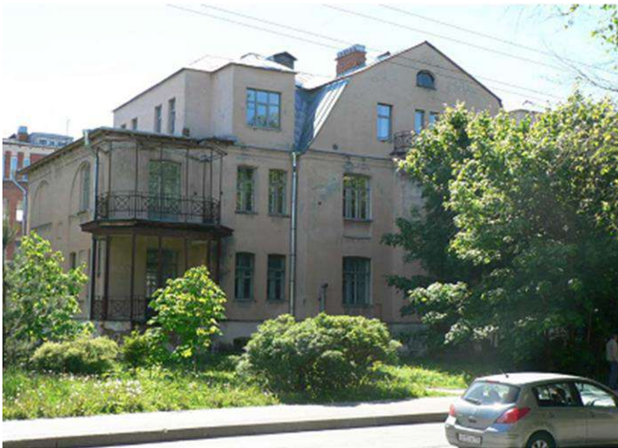
Илл. 47. Главный северо-западный фасад. Северный угол. Проектная документация ООО «Антураж». 2017 г. (источник: ГБУСОН «КЦСОН Пушкинского района»).
