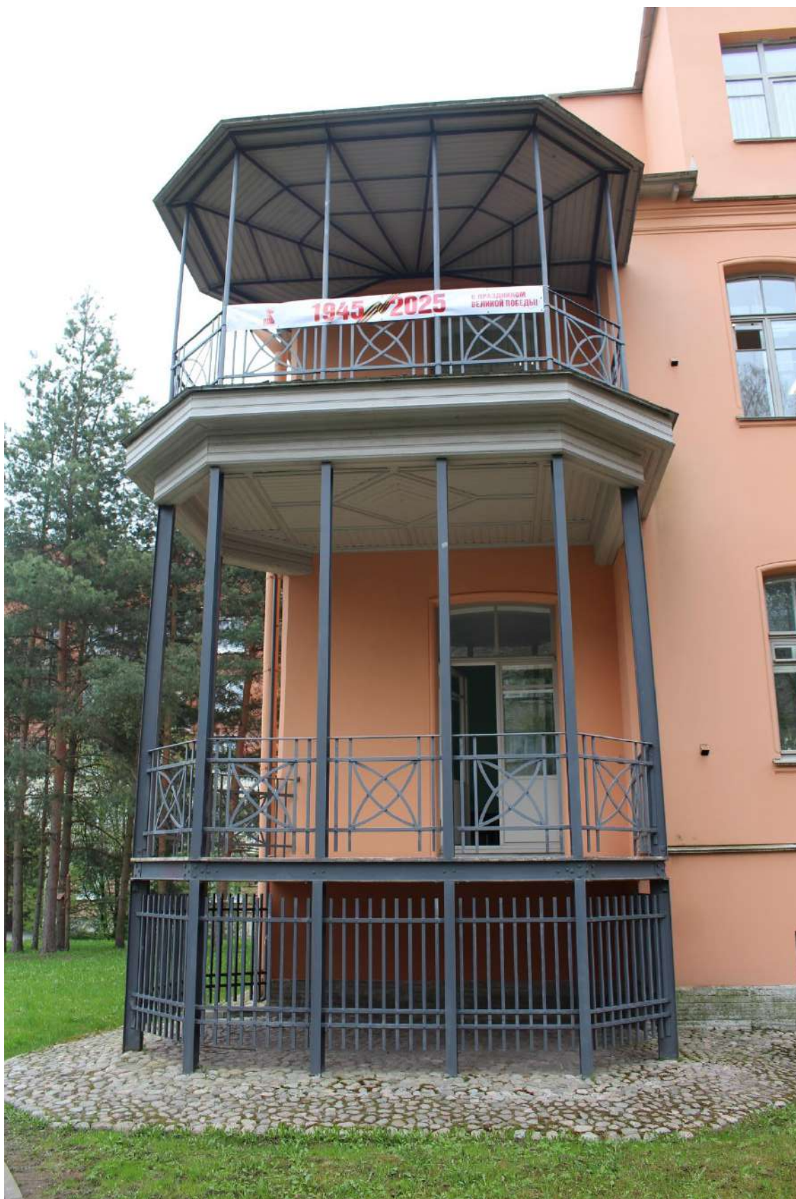
Фото 3. Вид на северо-западный фасад выявленного объекта культурного наследия «Начальное училище и приют Общества пособия бедным детям римско-католического прихода».
