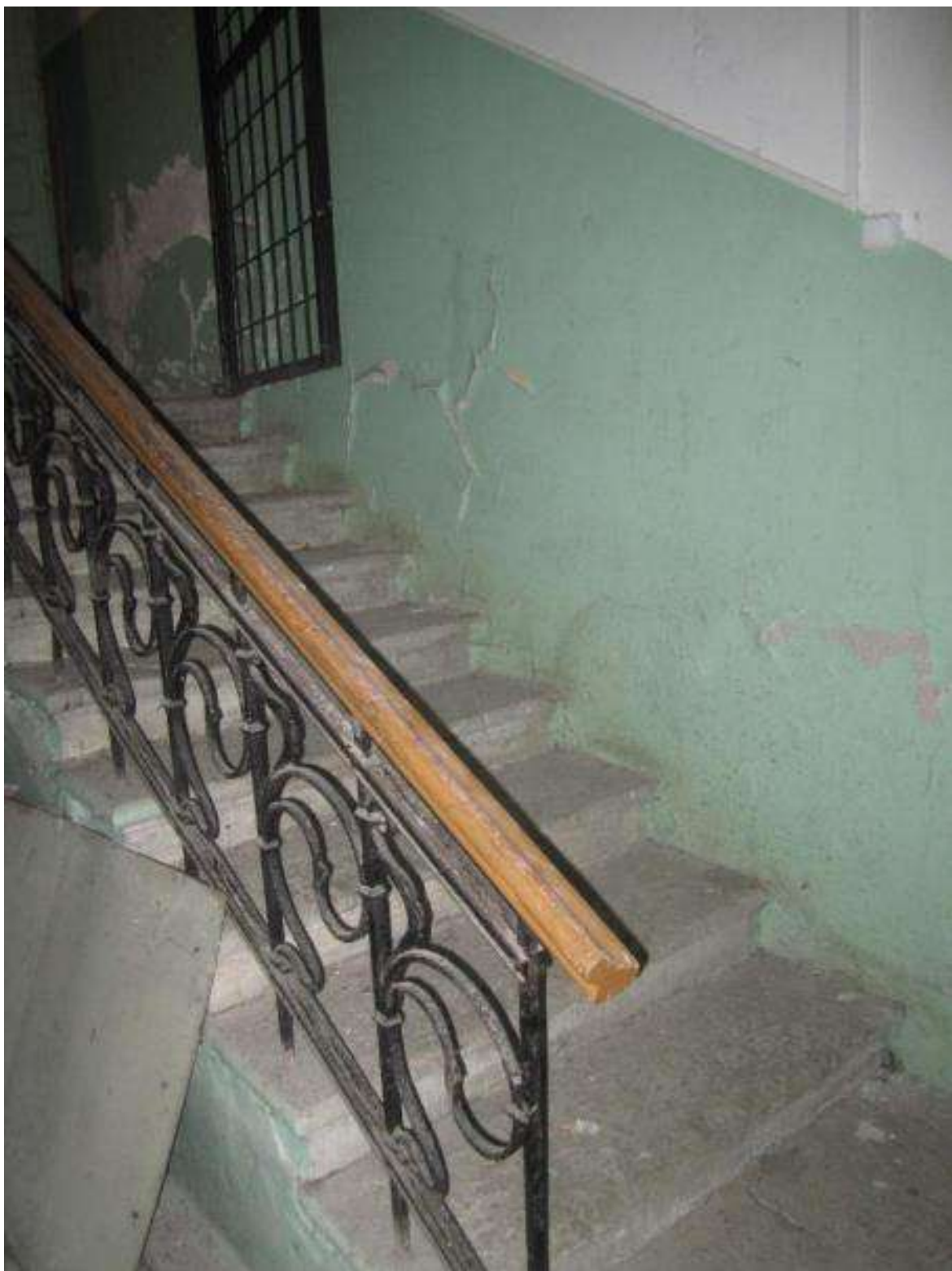
Илл. 60. Парадная лестница в уровне подвала. Проектная документация ООО «Аксиома». 2017 г. (источник: ГБУСОН «КЦСОН Пушкинского района»).
