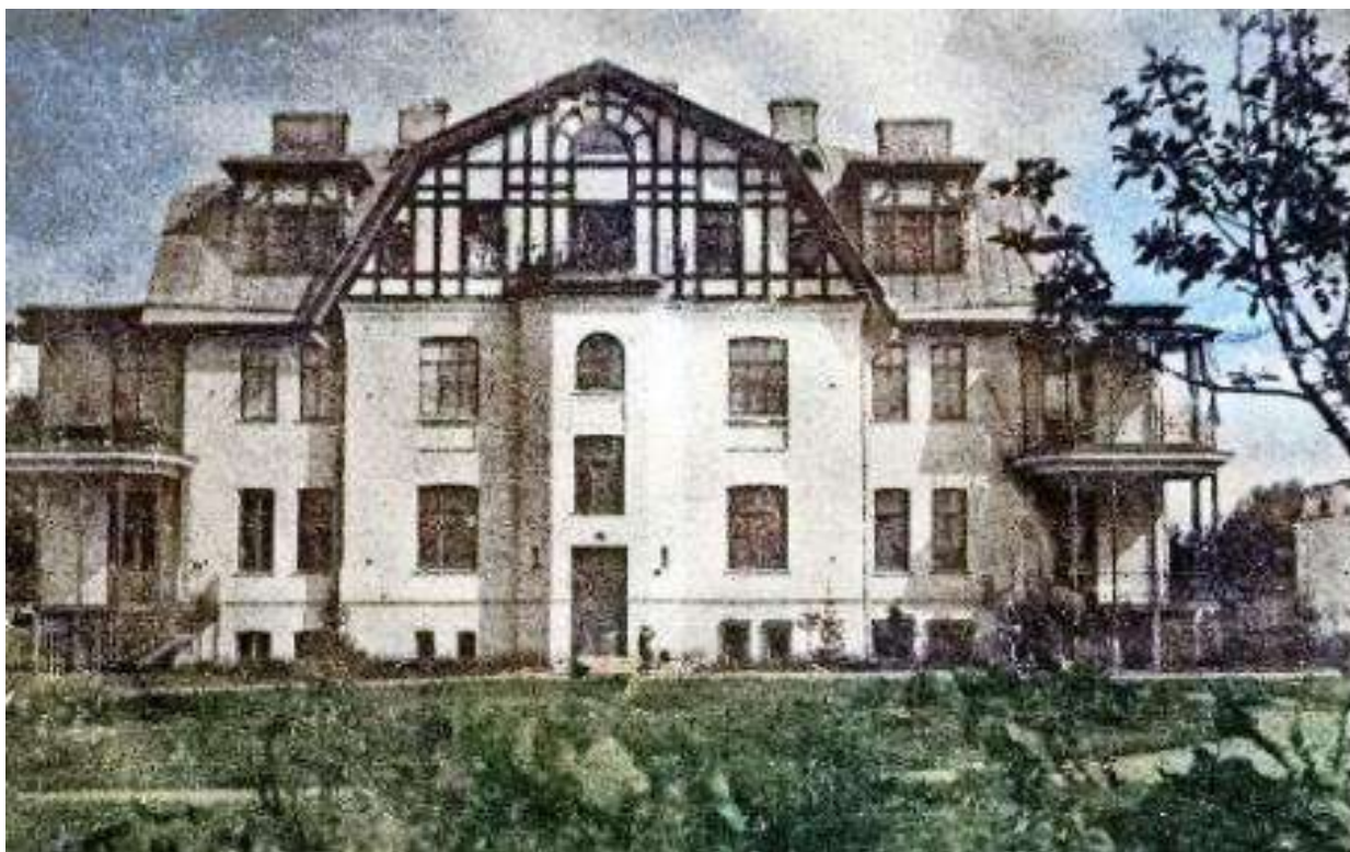
Илл. 37. Главный (северо-западный фасад). 1907 г. (источник: https://www.tsarselo.ru/разделы/адреса ).
