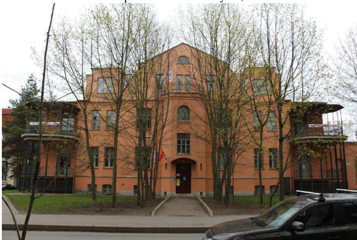
Фото 2. Вид на северо-западный фасад выявленного объекта культурного наследия «Начальное училище и приют Общества пособия бедным детям римско-католического прихода».
