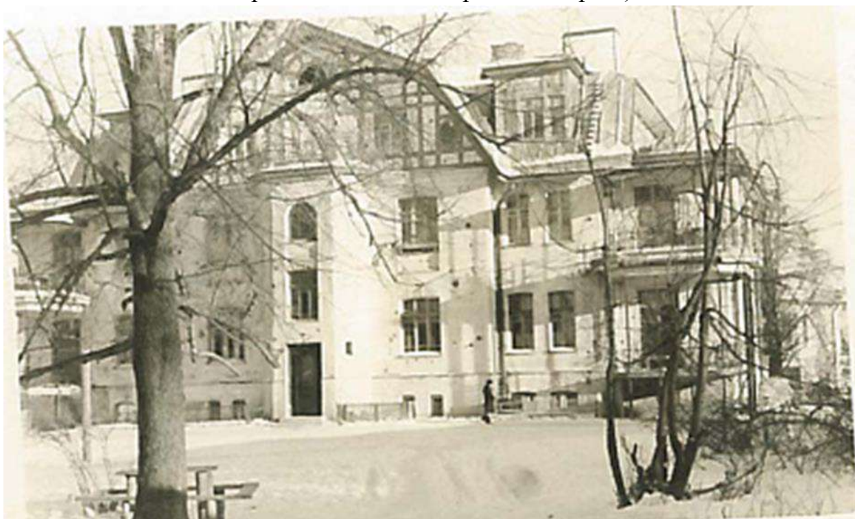
Илл. 38. Главный (северо-западный) фасад. 1956 г. (источник: https://www.tsarselo.ru/разделы/адреса ).
