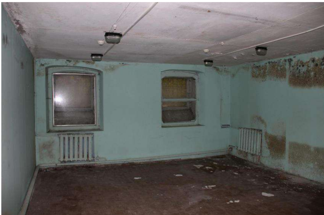
Илл. 63. Общий вид помещений подвала. Проектная документация ООО «Аксиома». 2017 г. (источник: ГБУСОН «КЦСОН Пушкинского района»).
