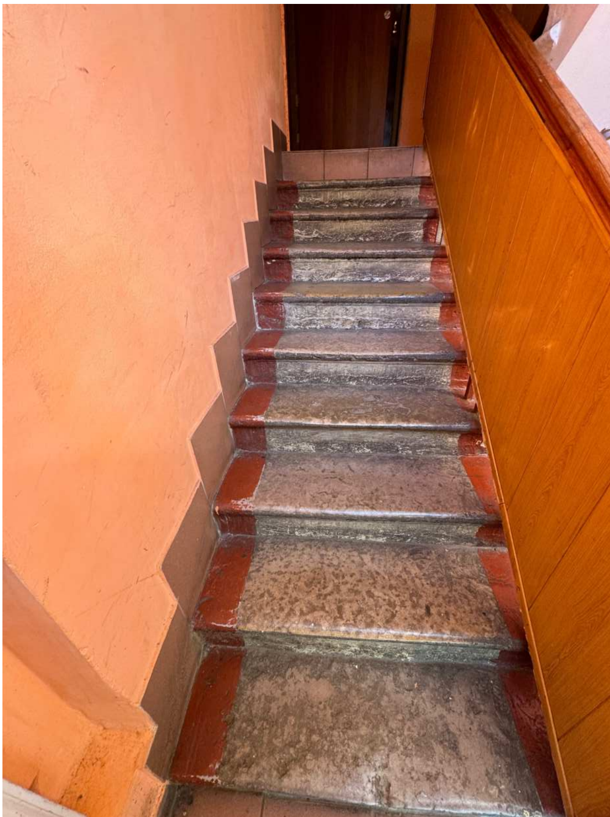
Фото 22. Помещение лестницы 1-ЛК.
