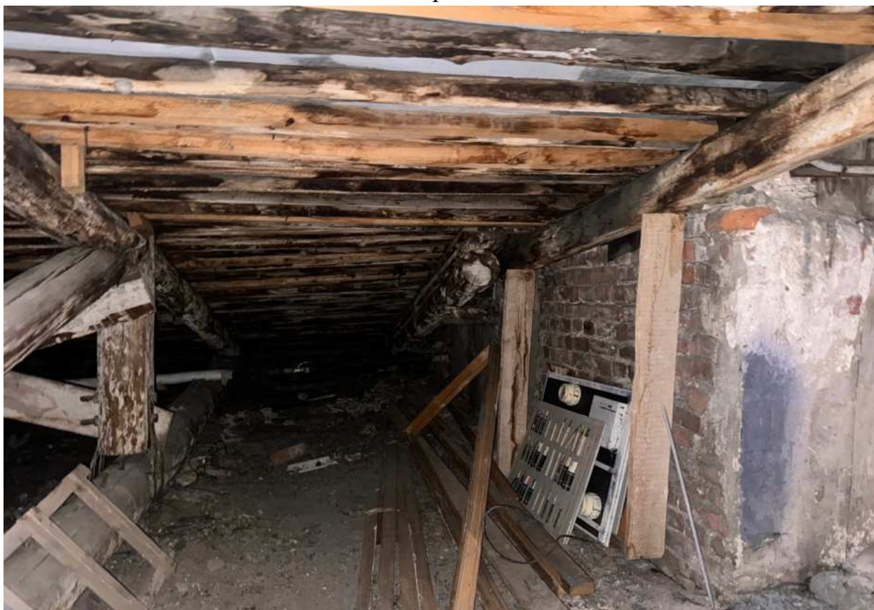
Фото 29. Вид на чердачное помещение.
