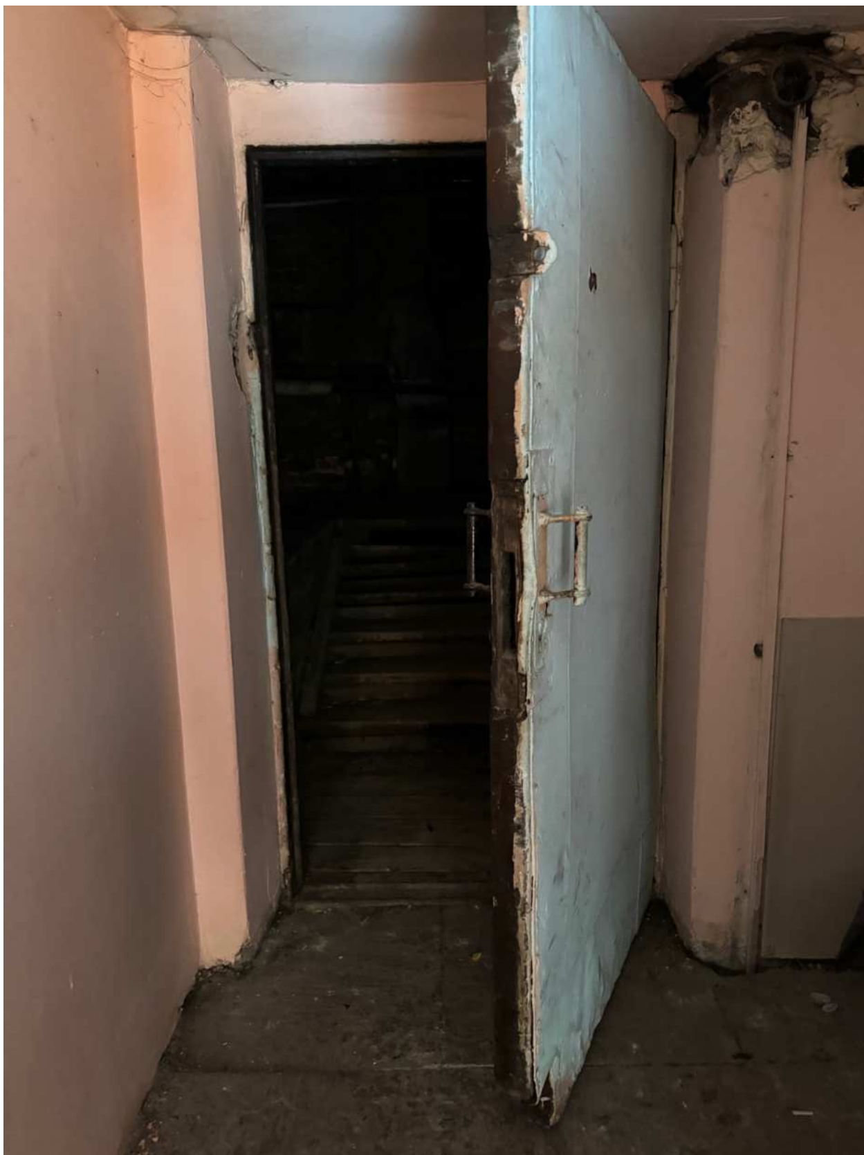
Фото 27. Вход на чердак.
