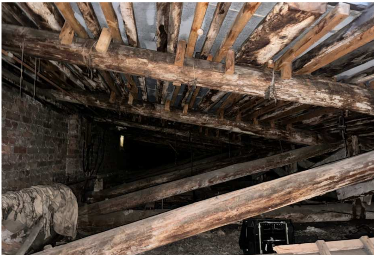
Фото 28. Вид на чердачное помещение.
