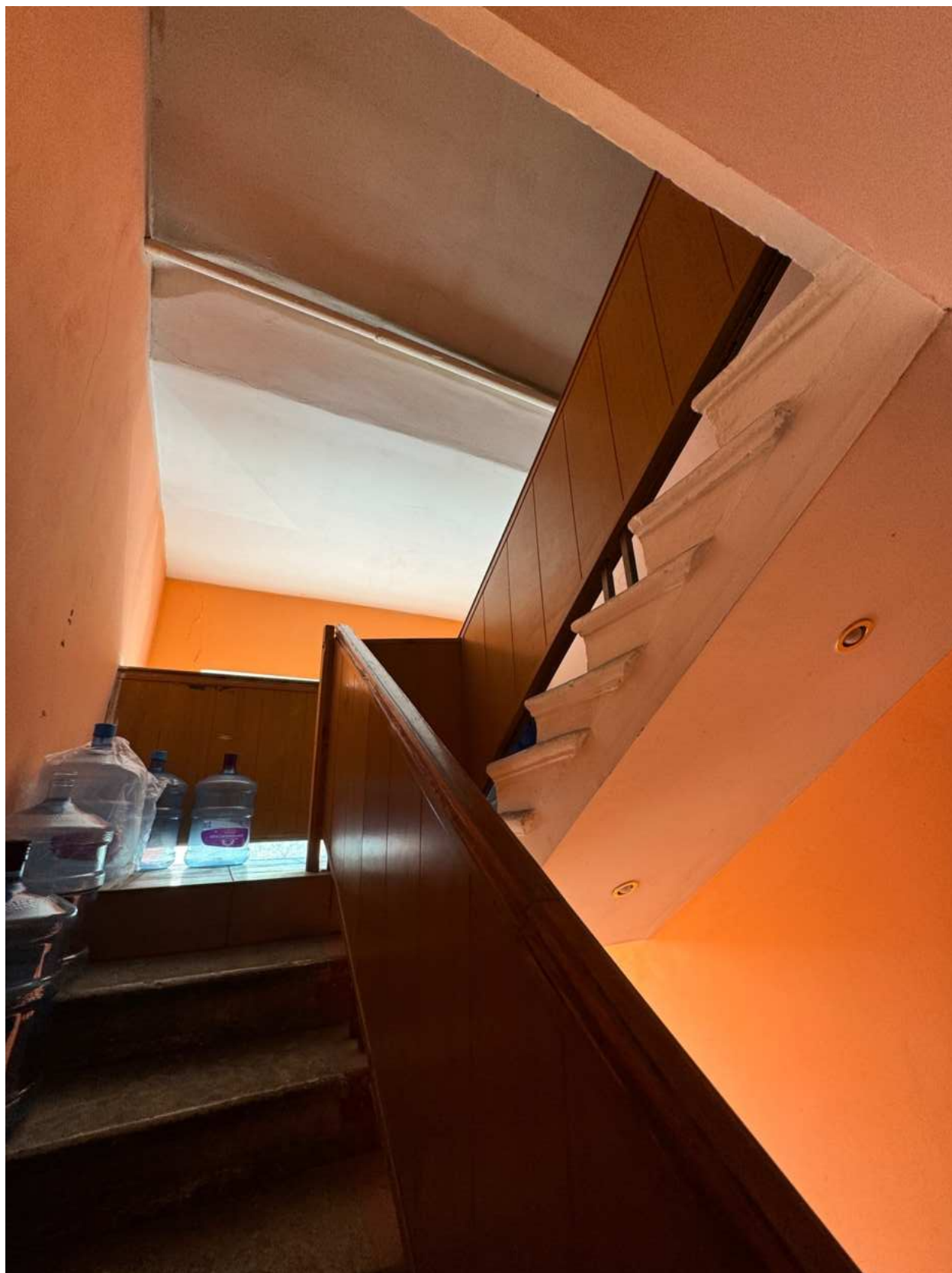
Фото 24. Помещение лестницы 1-ЛК.
