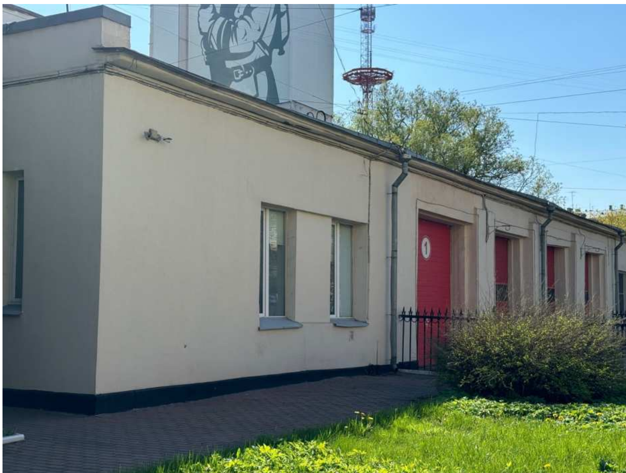
Фото 13. Фрагмент лицевого фасада по Лесному проспекту.
