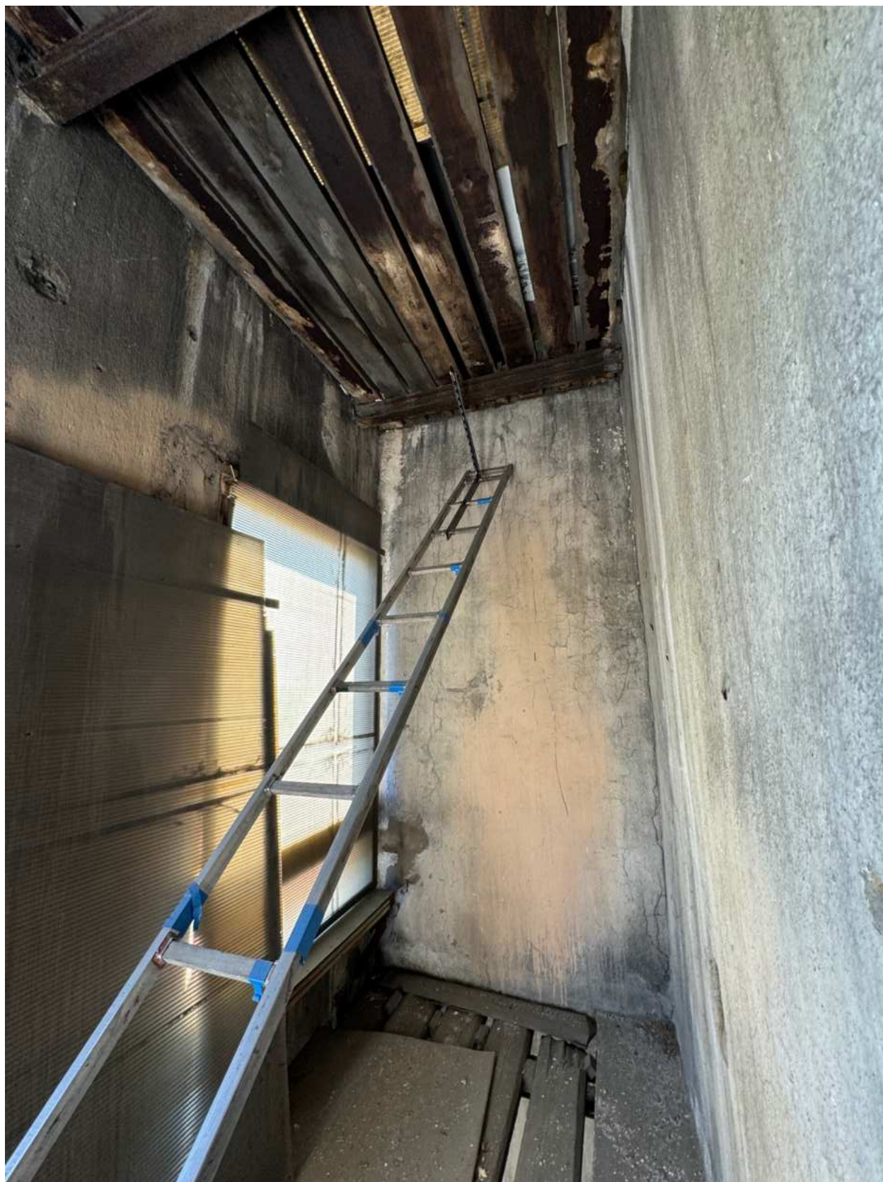
Фото 50. Вид на интерьер лоджии лестницы 2-ЛК.
