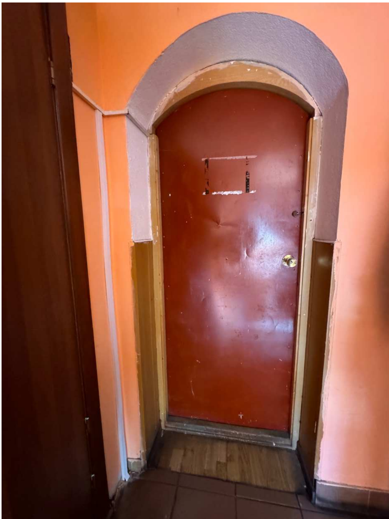
Фото 31. Вид на вход в помещения 8-Н.
