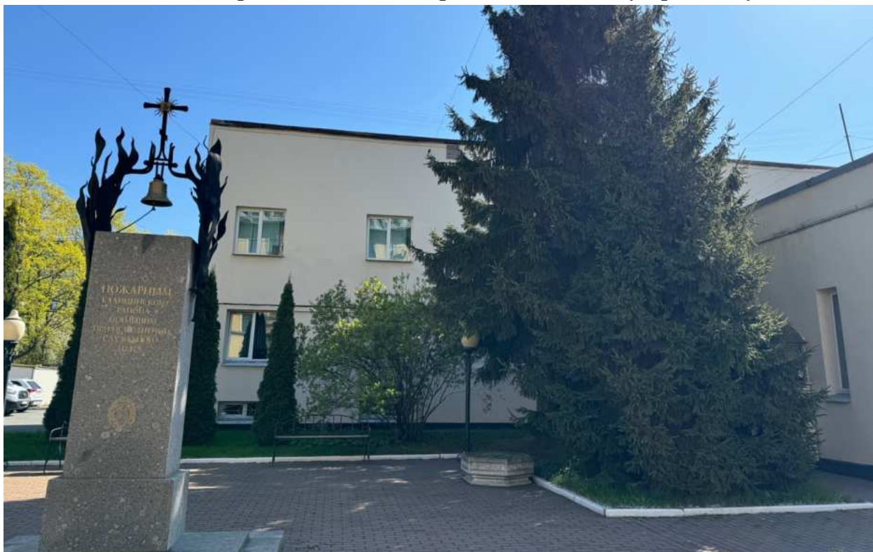
Фото 14. Фрагмент лицевого фасада по Лесному проспекту.
