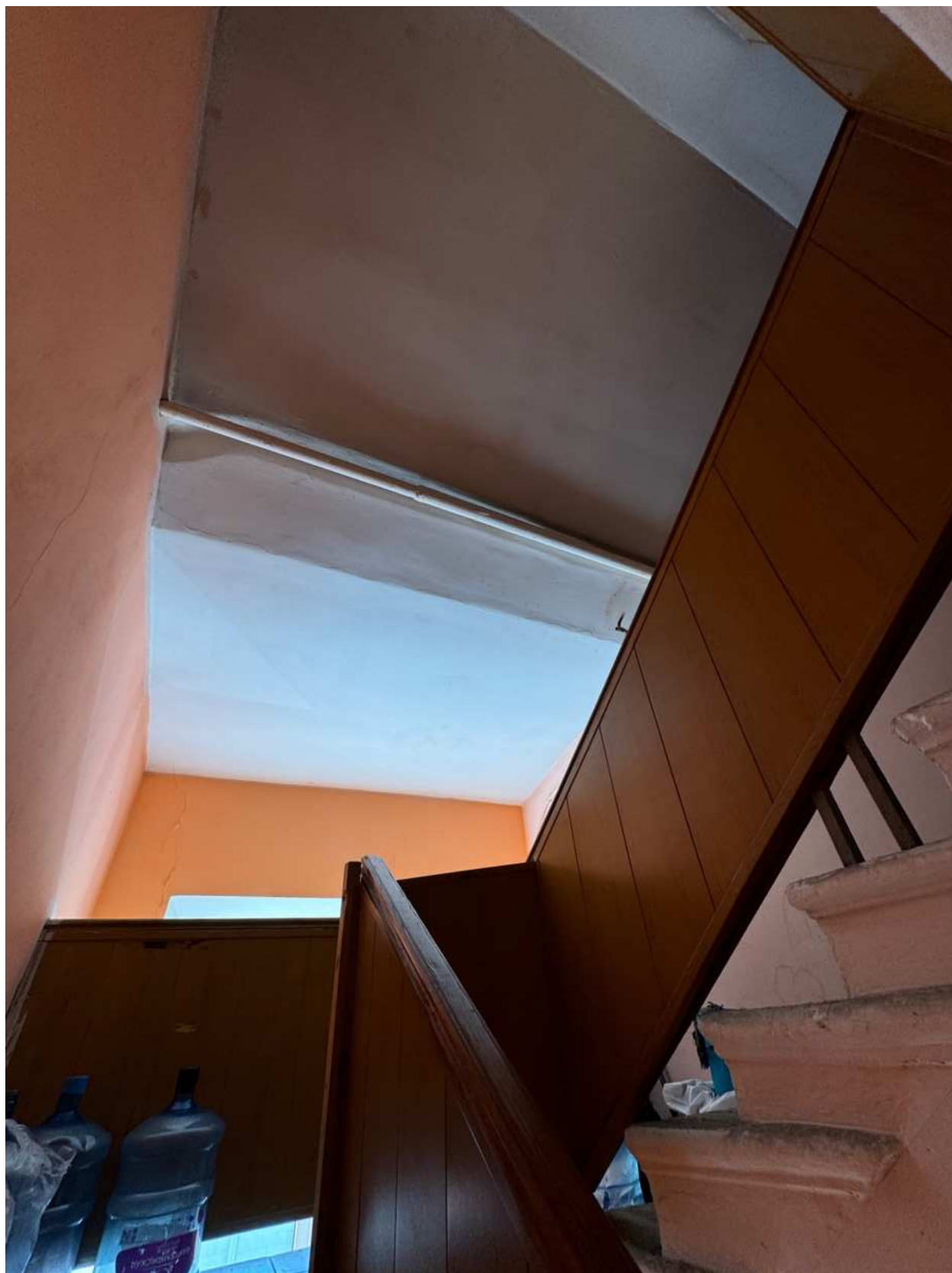
Фото 25. Помещение лестницы 1-ЛК.
