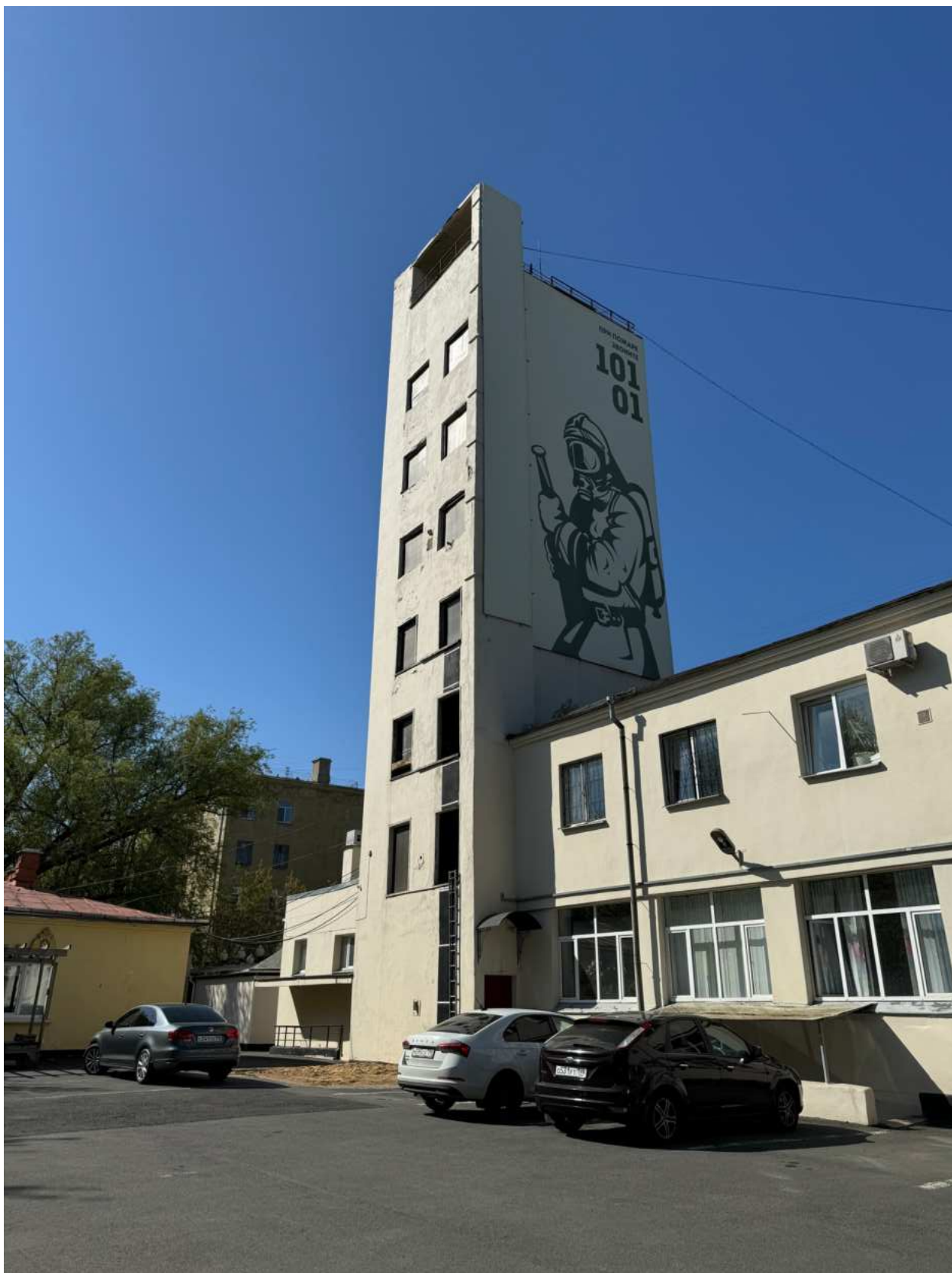
Фото 7. Фрагмент дворовых фасадов.
