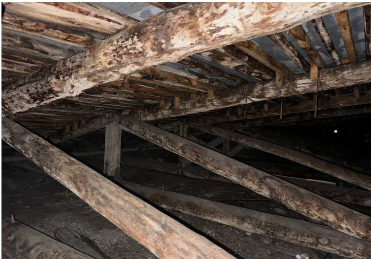
Фото 30. Вид на чердачное помещение.
