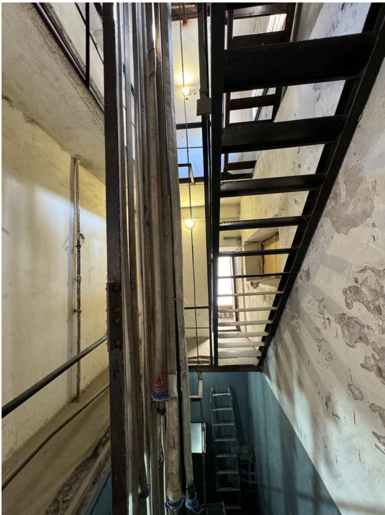
Фото 42. Вид на интерьер лестницы 2-ЛК.
