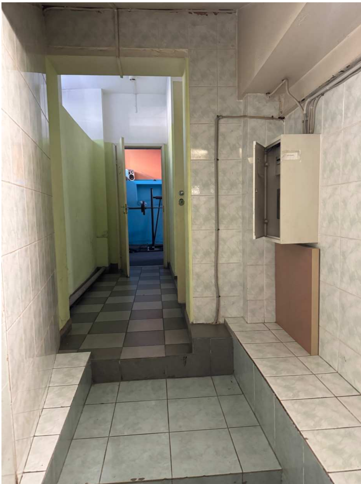
Фото 58. Вид на помещение 2-Н (1).
