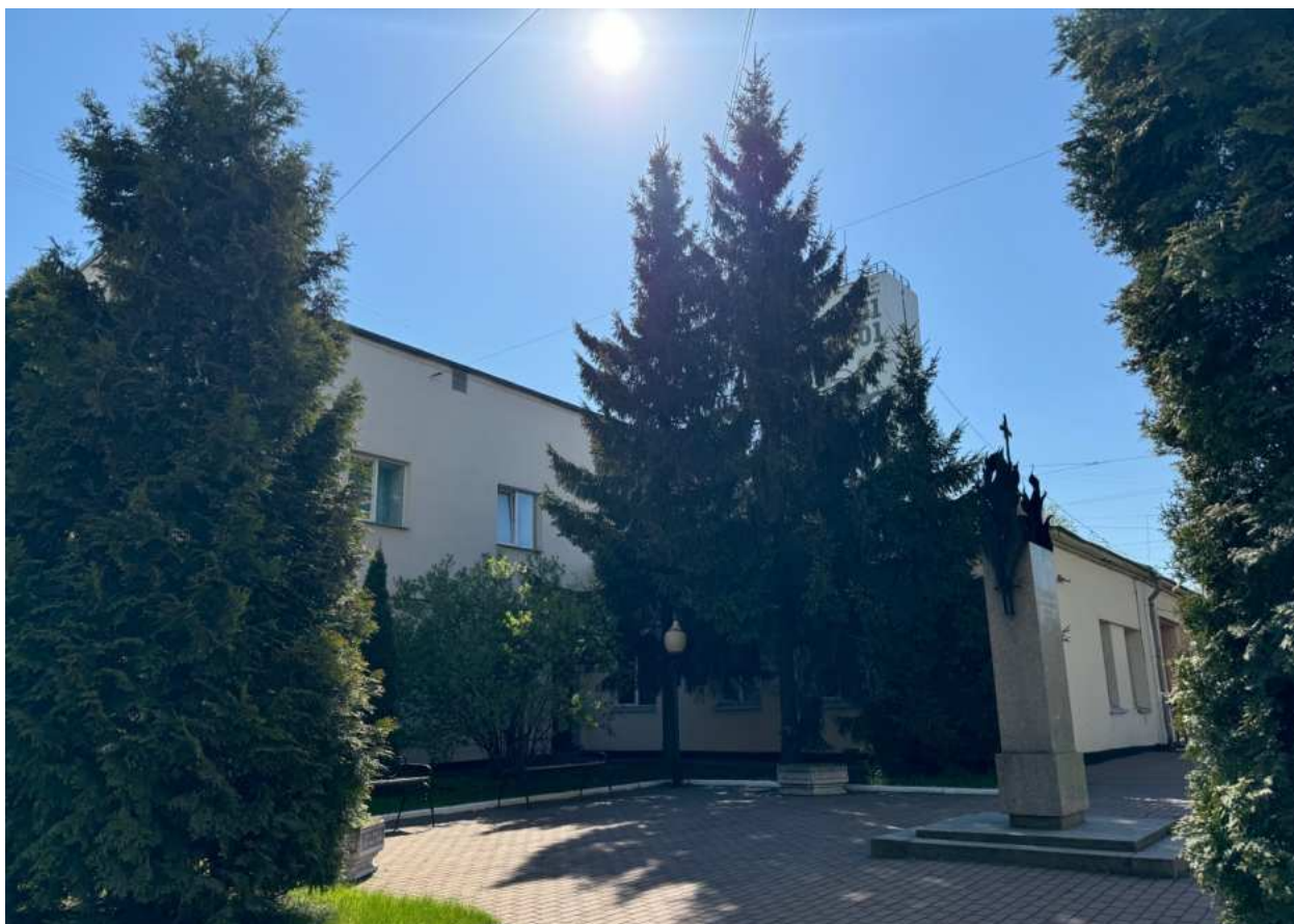
Фото 11. Фрагмент лицевого фасада по Лесному проспекту.
