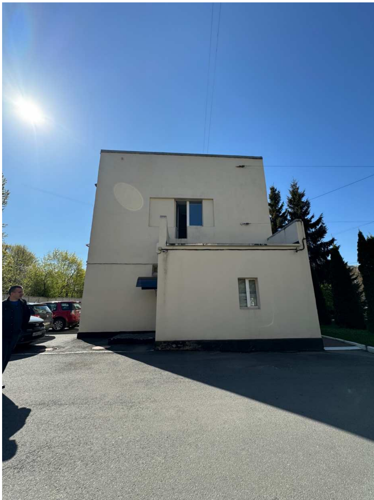
Фото 10. Общий вид северного дворового фасада.
