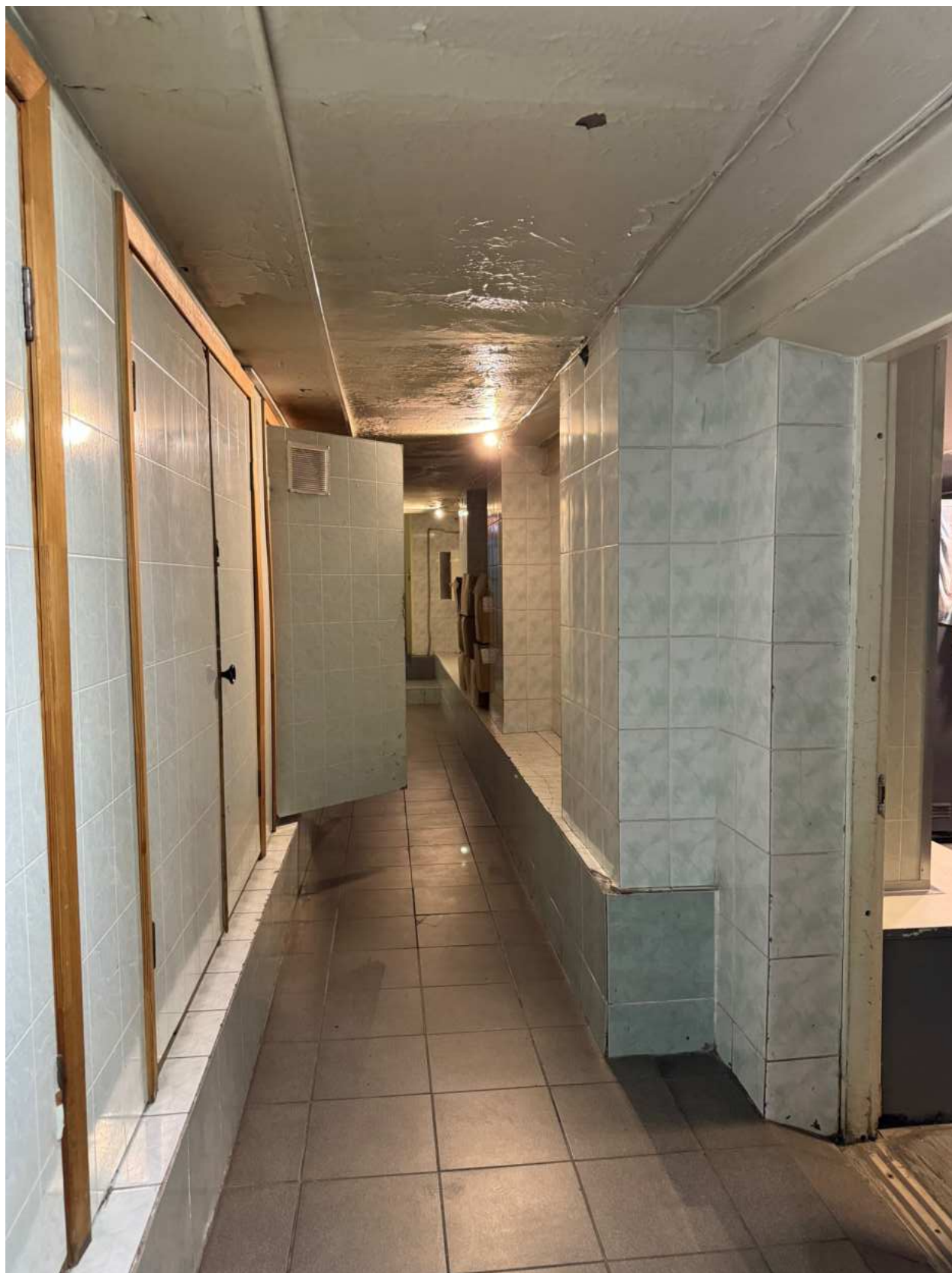
Фото 57. Вид на помещение 2-Н (1).
