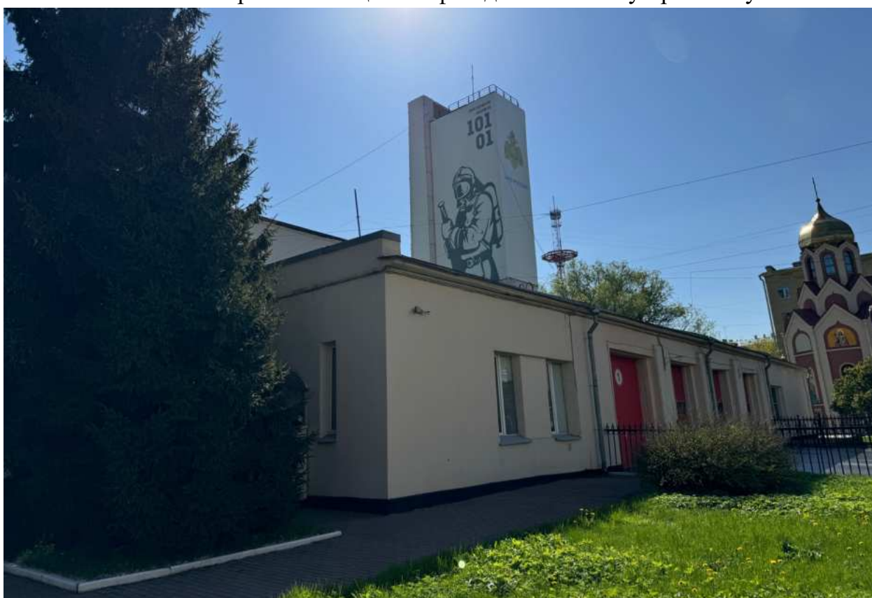
Фото 12. Фрагмент лицевого фасада по Лесному проспекту.
