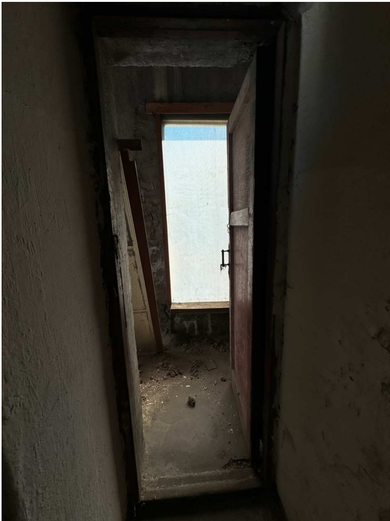
Фото 45. Вид на интерьер лоджии лестницы 2-ЛК.
