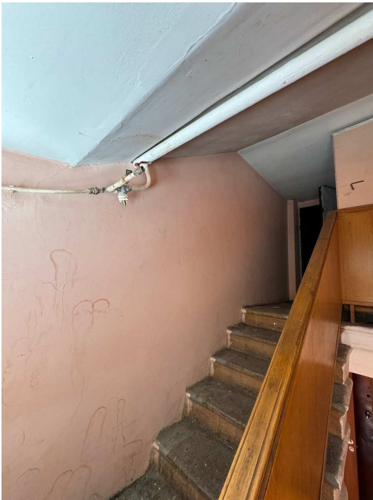
Фото 26. Помещение лестницы 1-ЛК.
