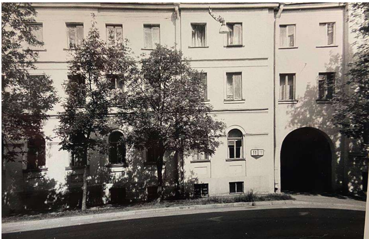
Илл. 12. Вид на дом № 11 по Гражданской ул. Дата: 1990 г. Источник: архив КГИОП.
