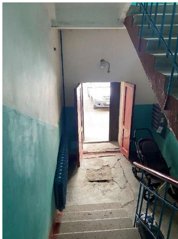
Фото 13. Вид на лестницу № 1.
