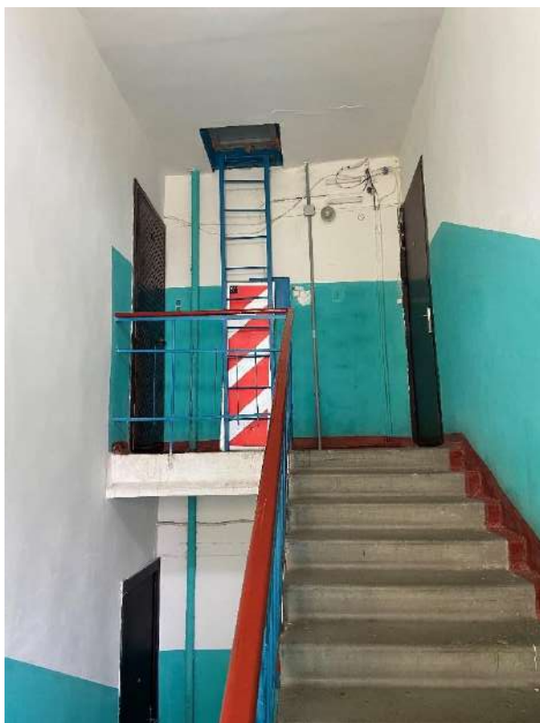
Фото 12. Вид на лестницу № 1.
