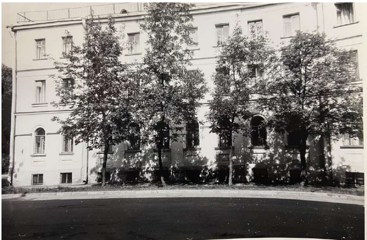
Илл. 13. Вид на дом № 11 по Гражданской ул. Дата: 1990 г. Источник: архив КГИОП.
