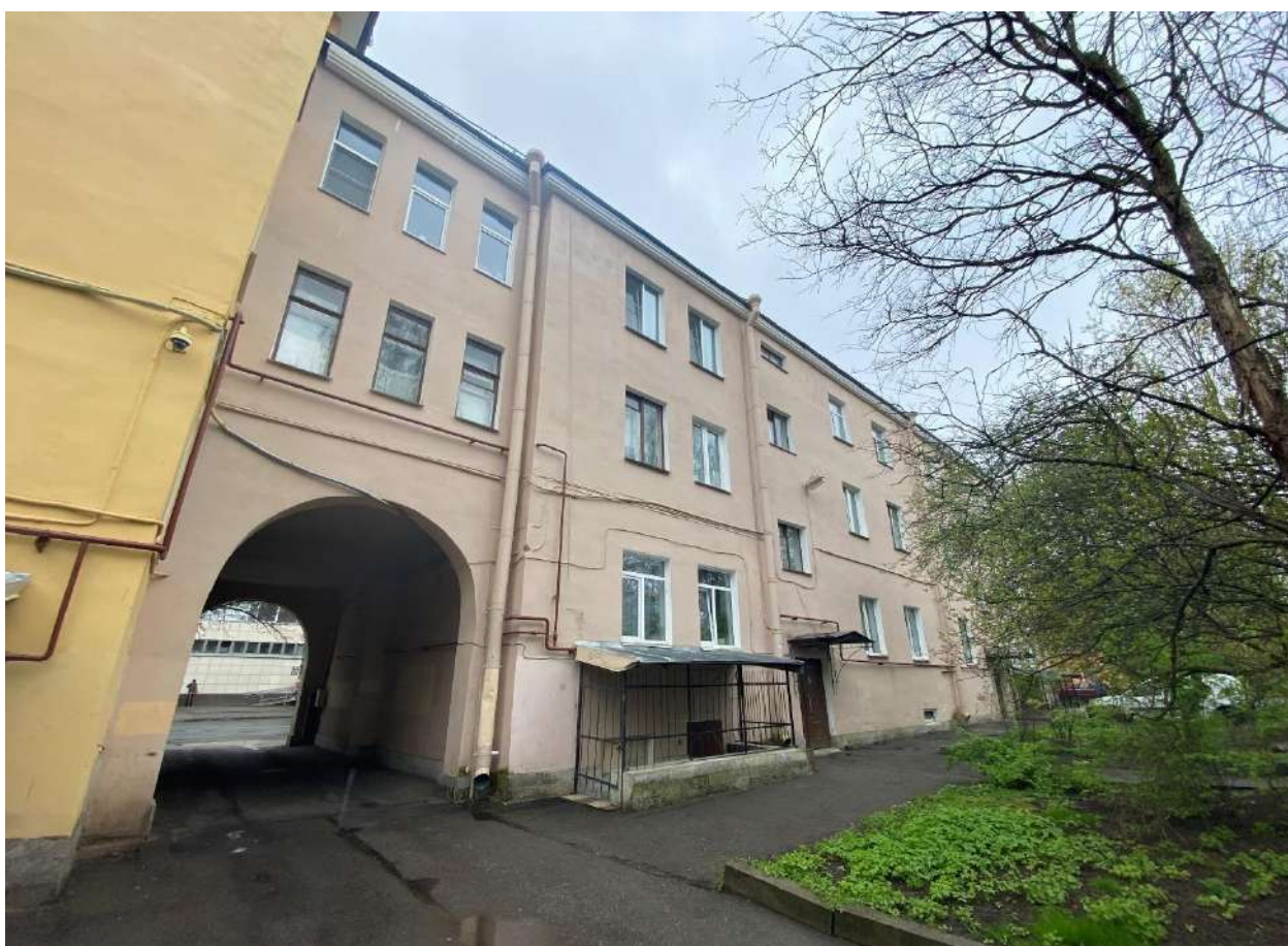
Фото 7. Вид на дворовой фасад дома № 11 по Гражданской улице.
