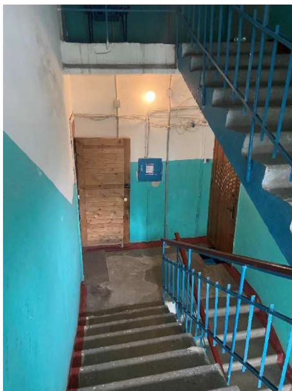
Фото 18. Вид на лестницу № 2.
