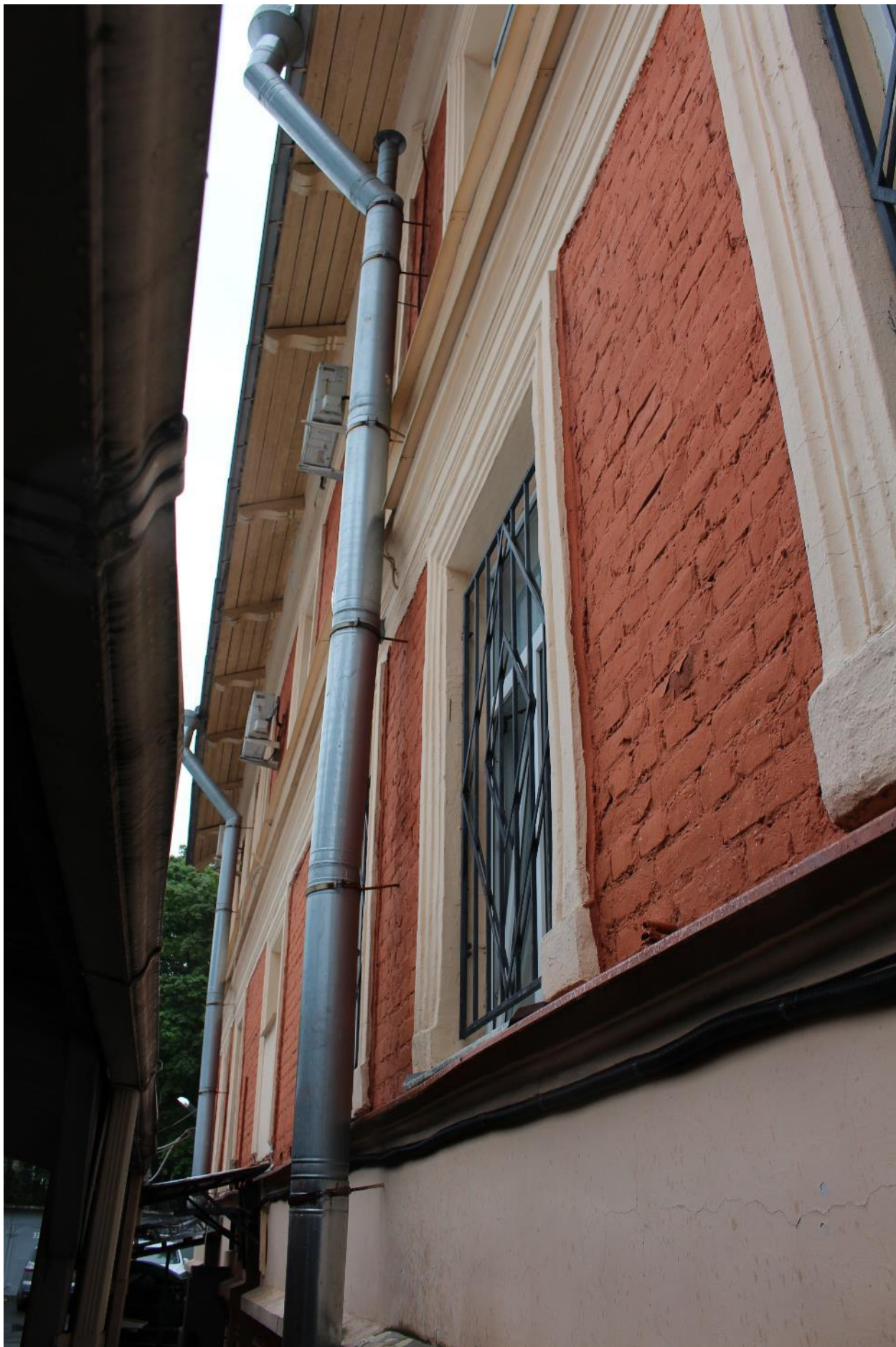
Фото 13. Фрагмент восточного фасада.
