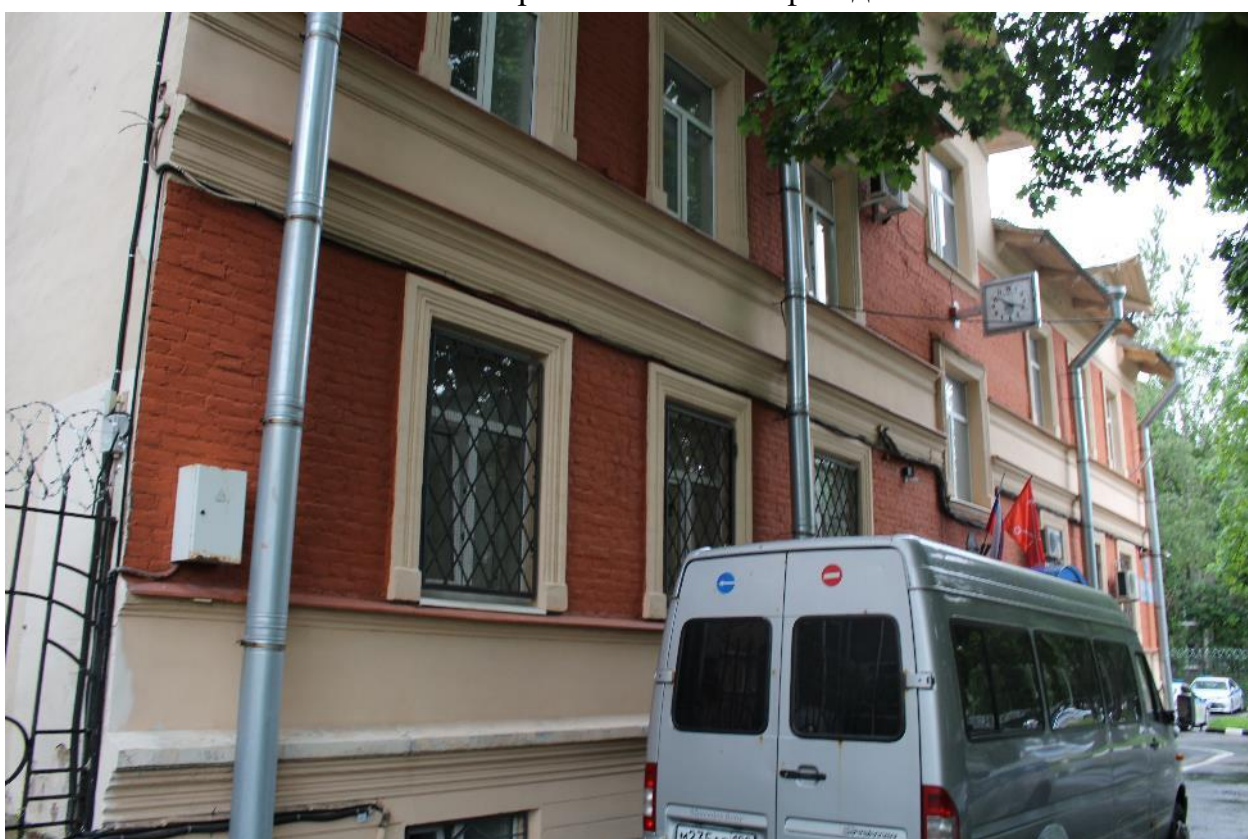
Фото 6. Вид вдоль западного фасада.
