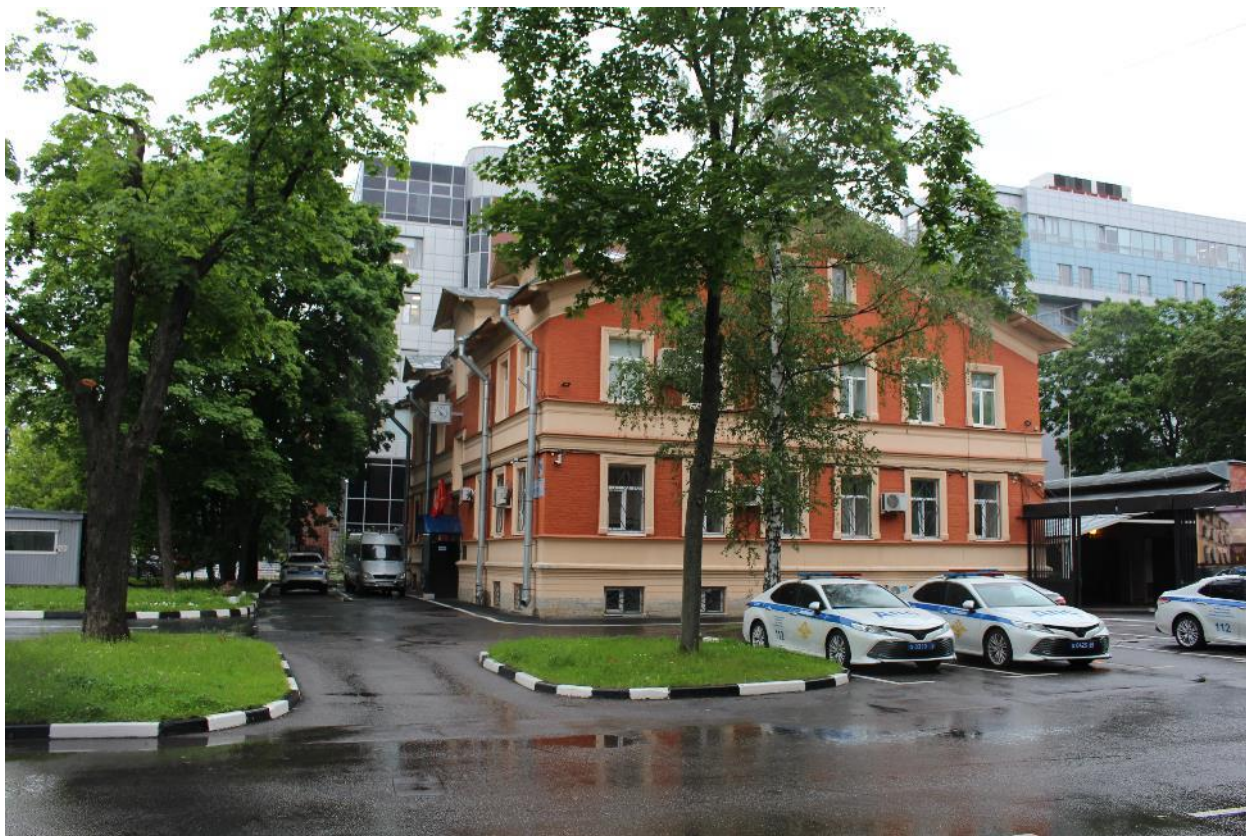
Фото 1. Общий вид объекта с юга.
