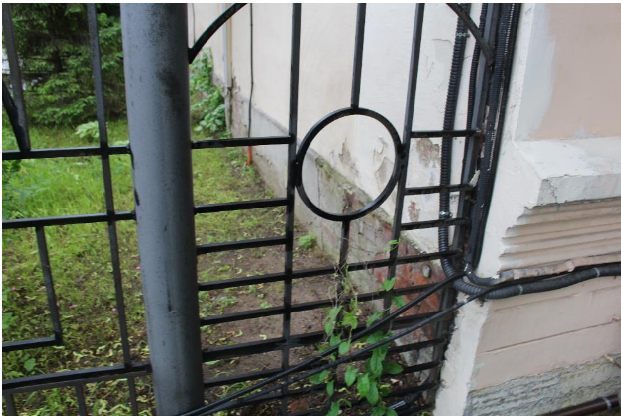
Фото 9. Вид цоколя вдоль северного фасада.
