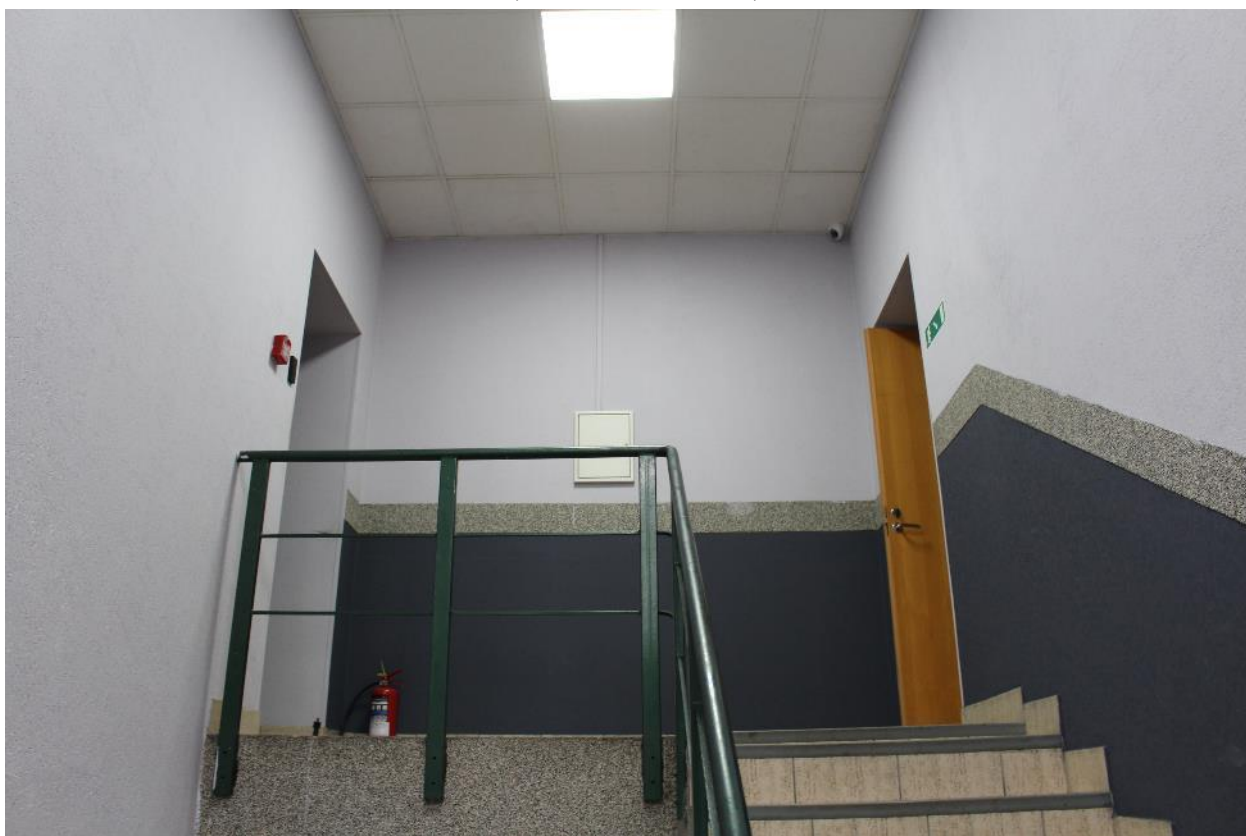
Фото 27. Восточная лестница, вид на второй этаж.
