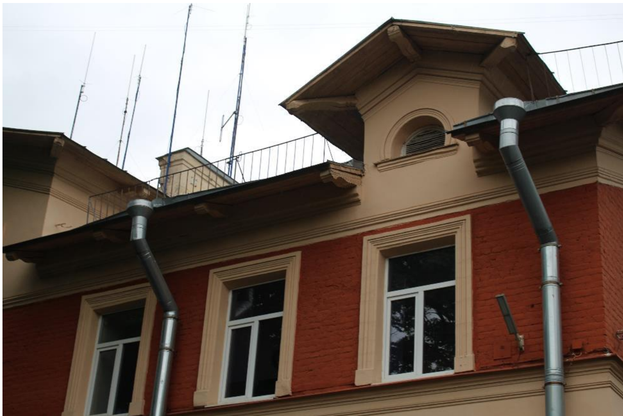
Фото 3. Фрагмент окна в чердаке с западного фасада.
