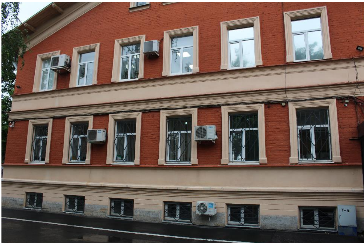
Фото 5. Фрагмент южного фасада.
