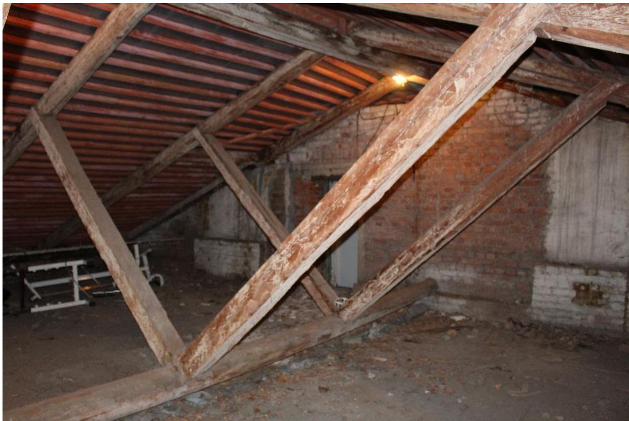
Фото 36. Чердак, южная часть.
