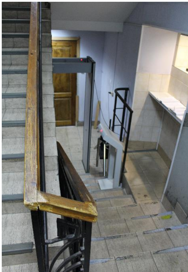
Фото 16. Лестницы в пом. 32.
