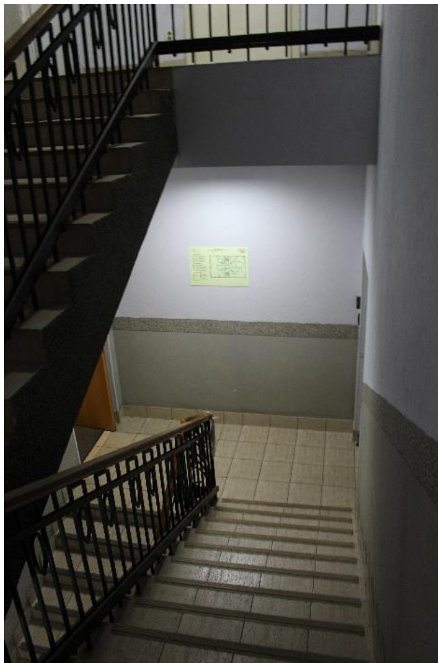
Фото 32. Помещение 53, вид на площадку 2 этажа.
