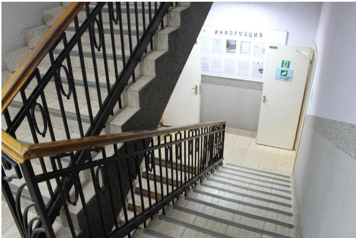
Фото 30. Лестница, пом. 53, вид на первый этаж.
