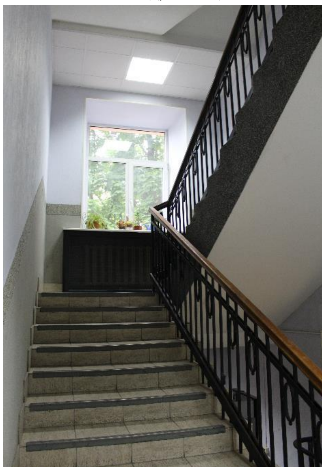
Фото 15. Лестницы в пом. 32.
