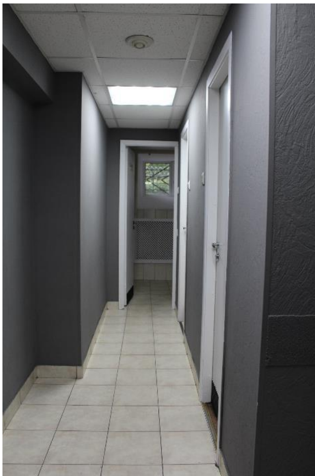
Фото 23. Подвал, вид южной части.
