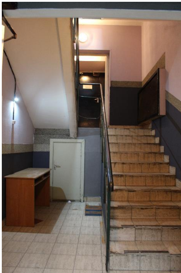
Фото 21. Восточная лестница, пом. 36.
