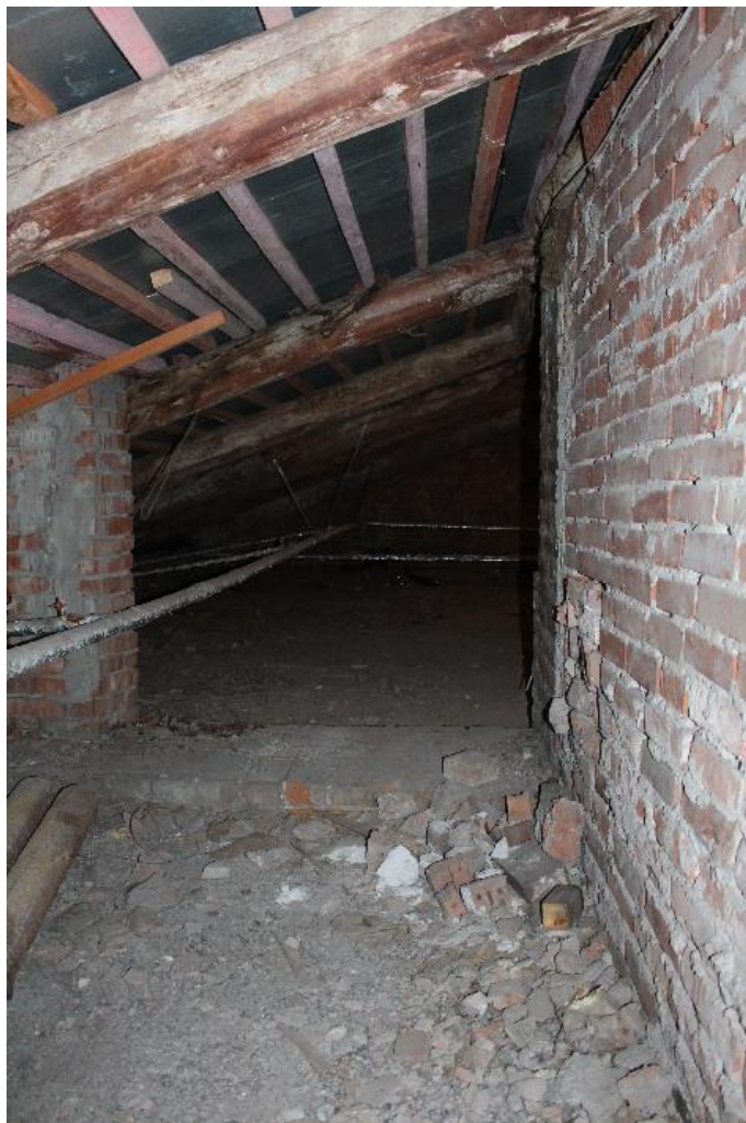
Фото 38. Чердак, стена лестничной клетки, проход.
