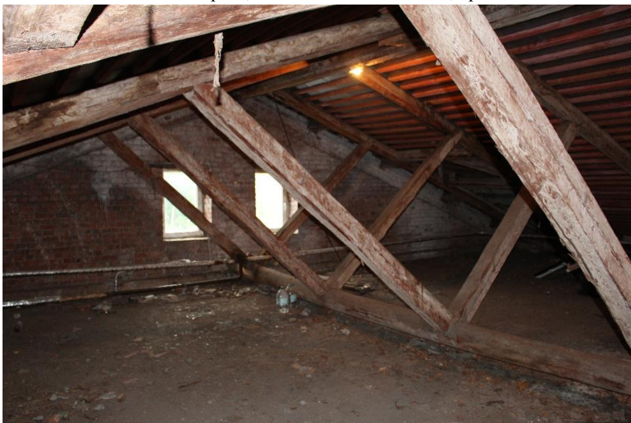
Фото 39. Чердак, вид на южную стену.
