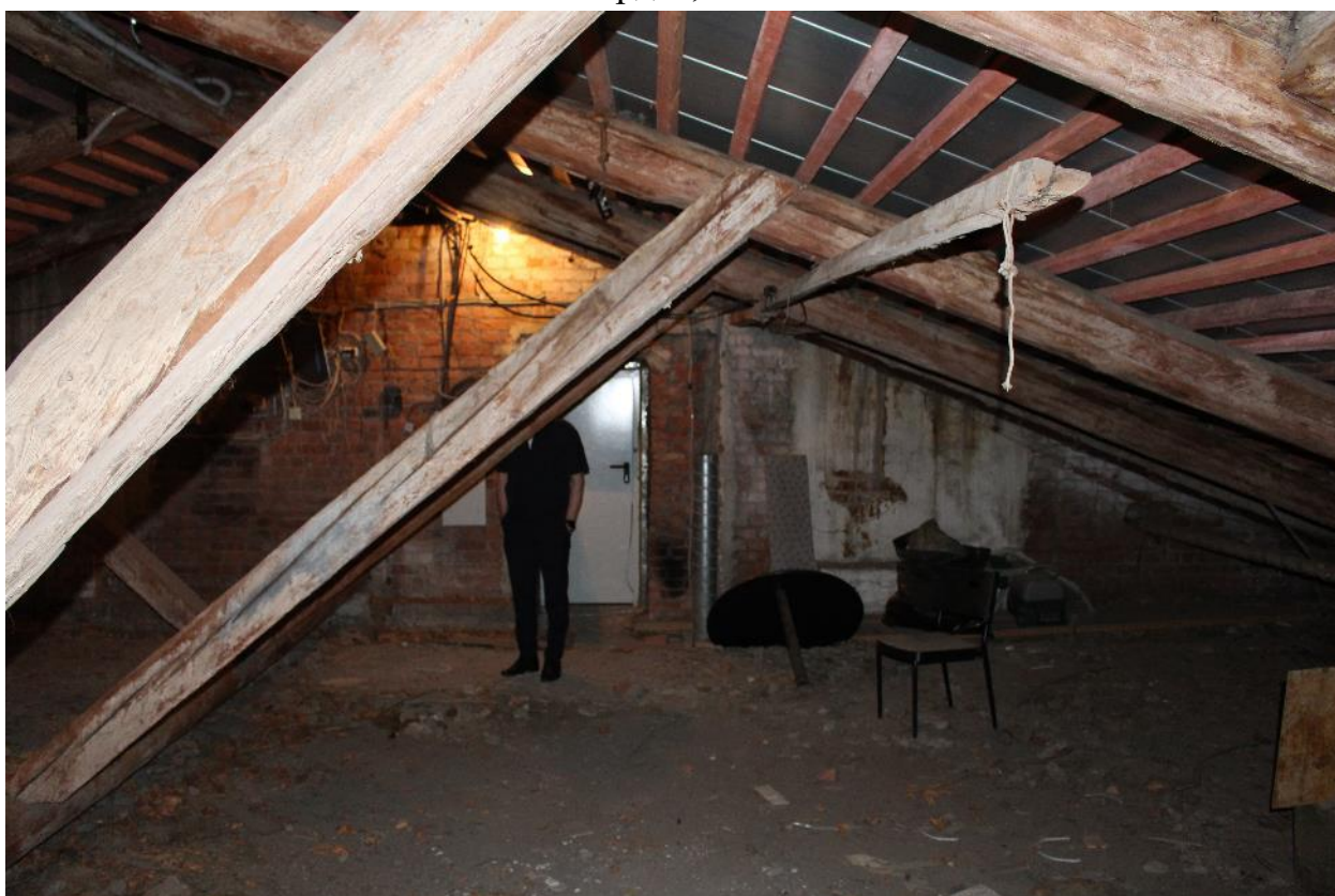
Фото 37. Чердак, северная часть.
