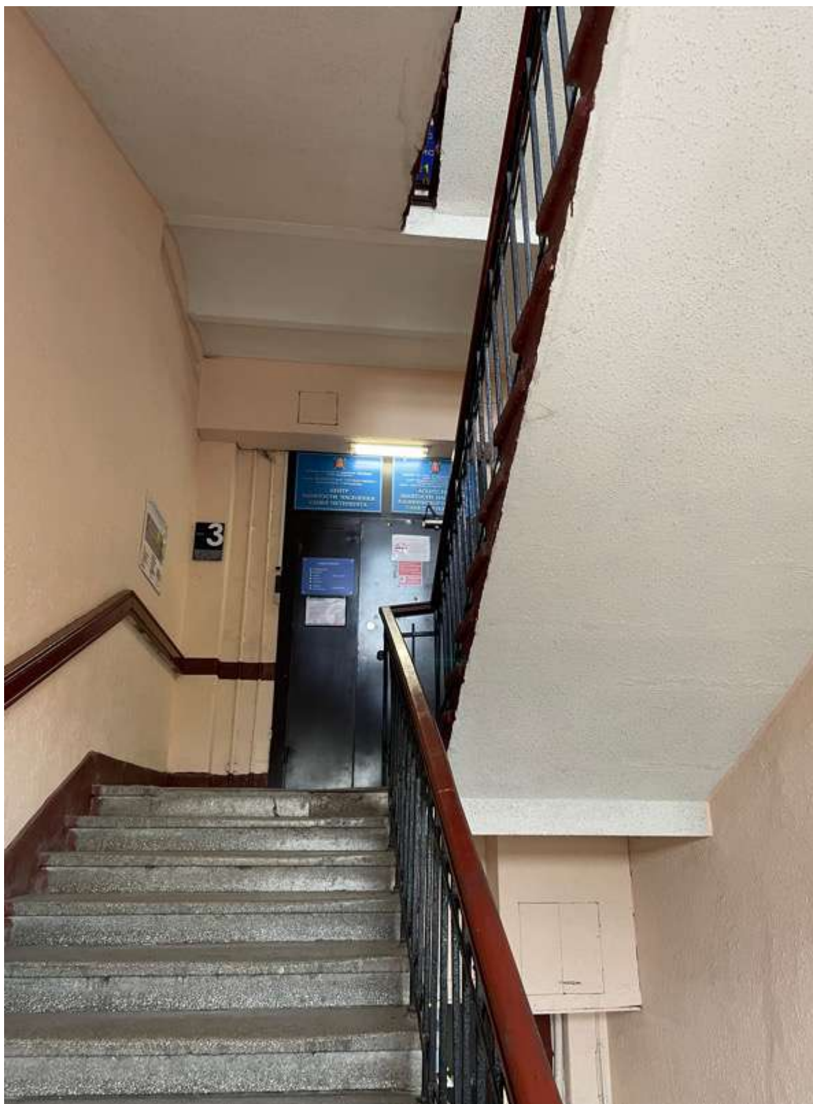
19. Фрагмент интерьера лестницы
