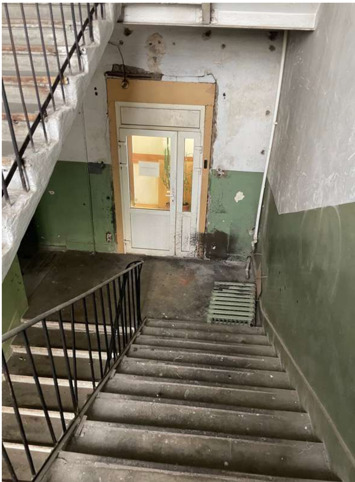
33. Фрагмент интерьера лестницы
