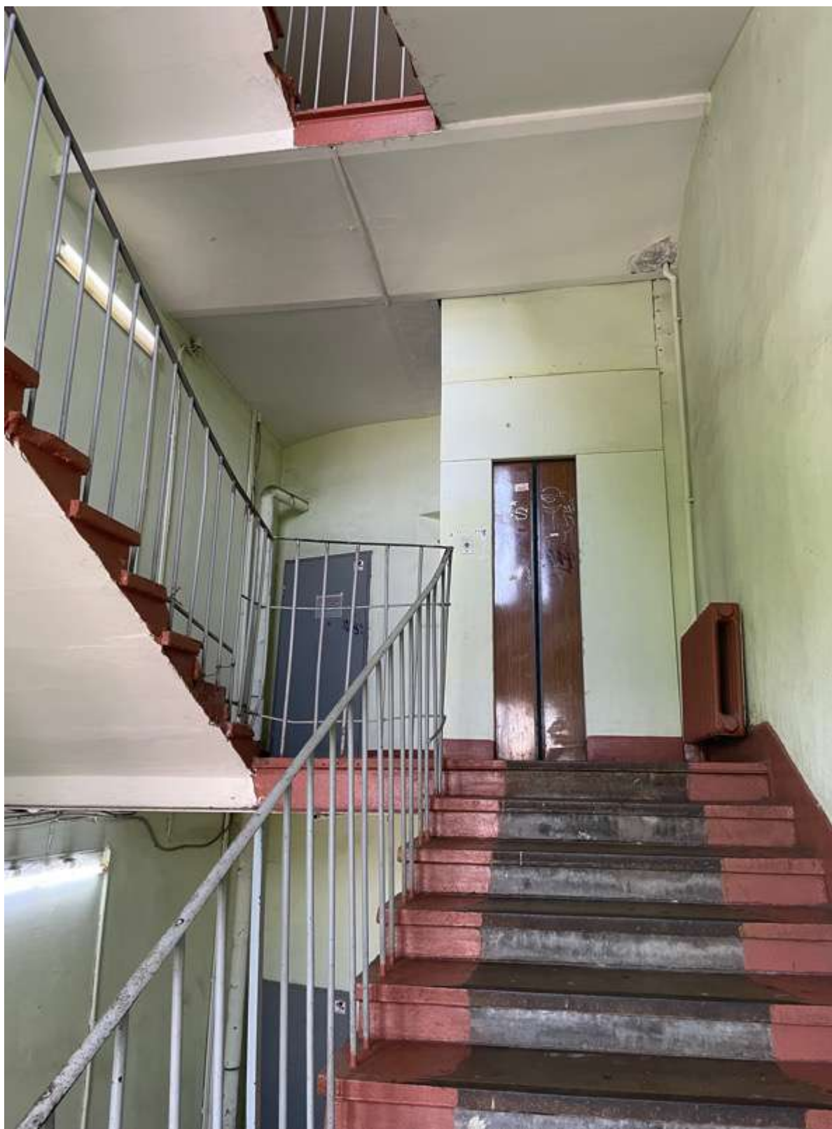
92. Фрагмент интерьера лестницы
