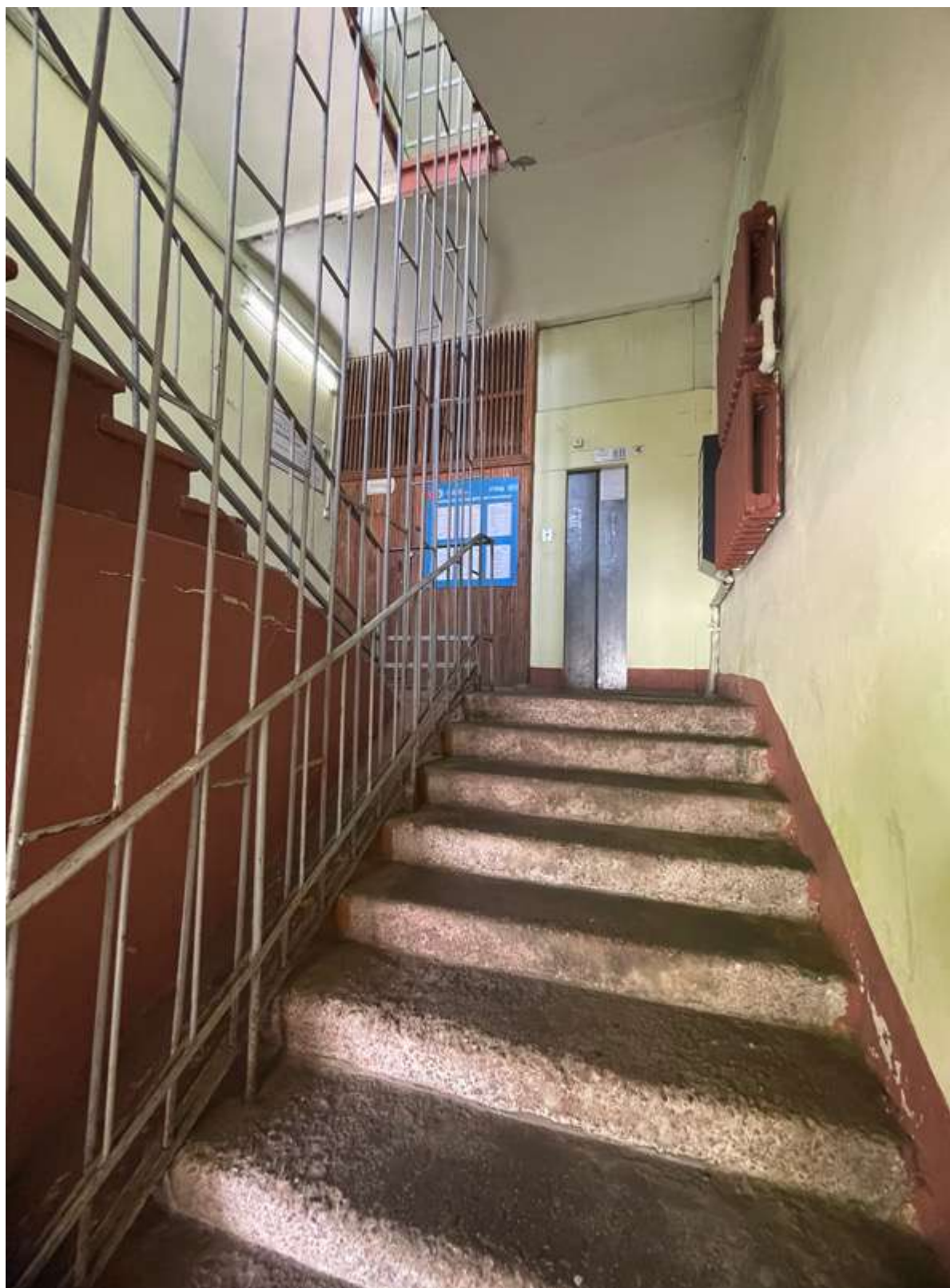
88. Фрагмент интерьера лестницы
