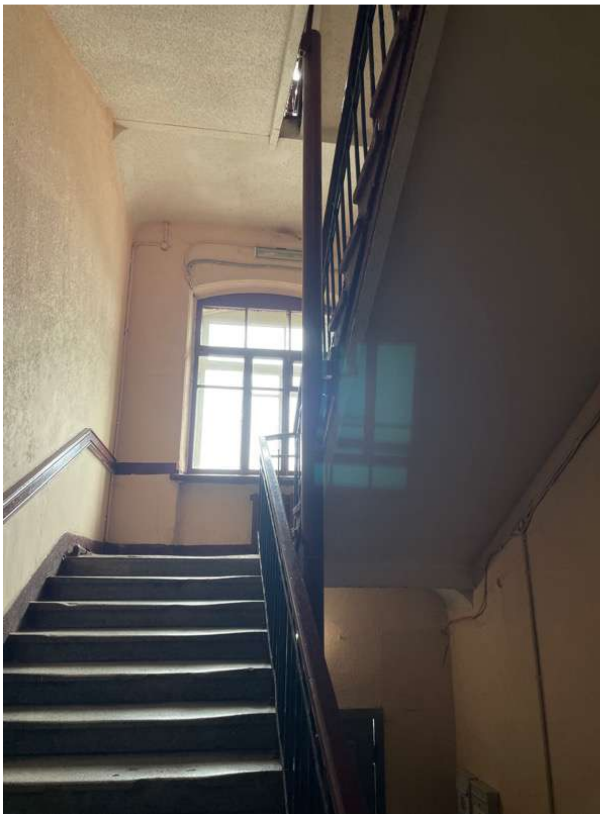
16. Фрагмент интерьера лестницы
