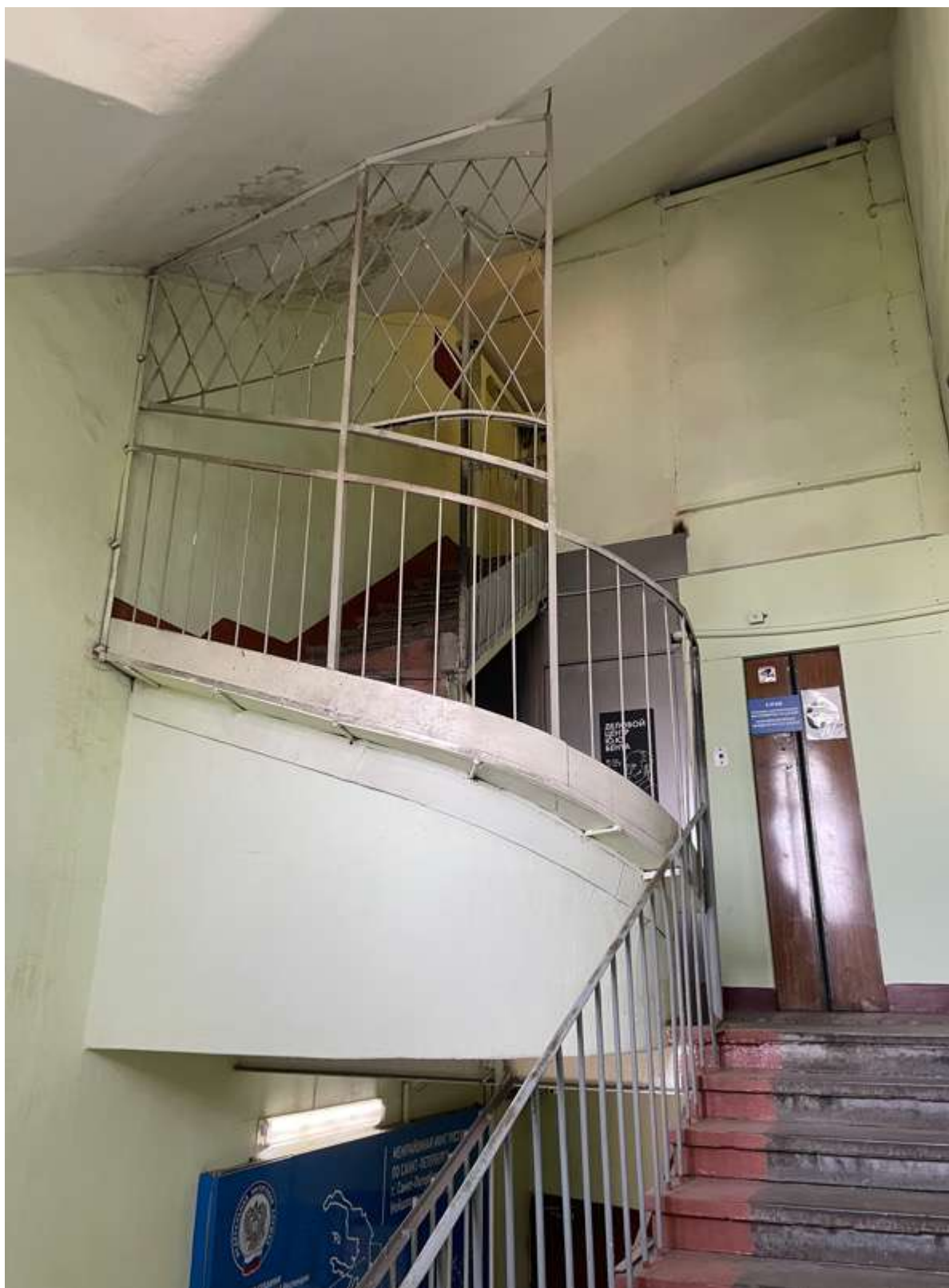
98. Фрагмент интерьера лестницы
