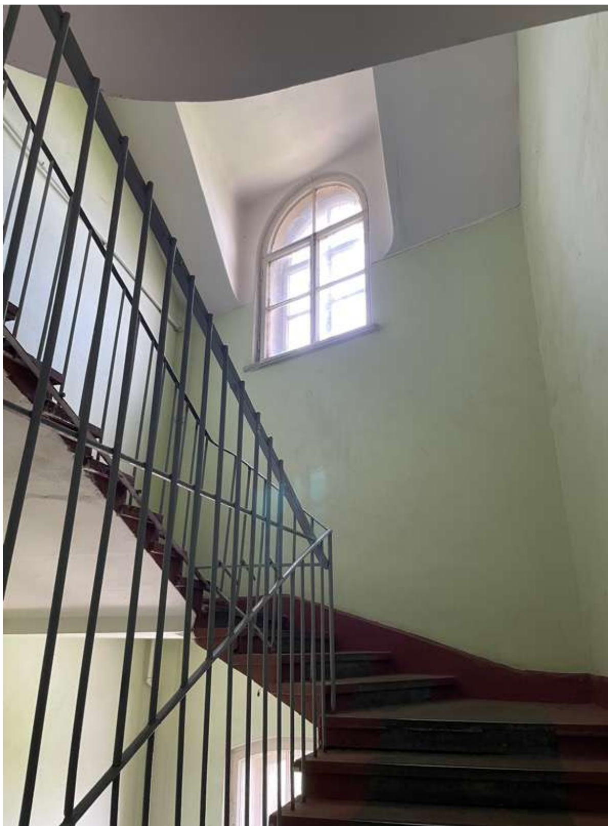
97. Фрагмент интерьера лестницы
