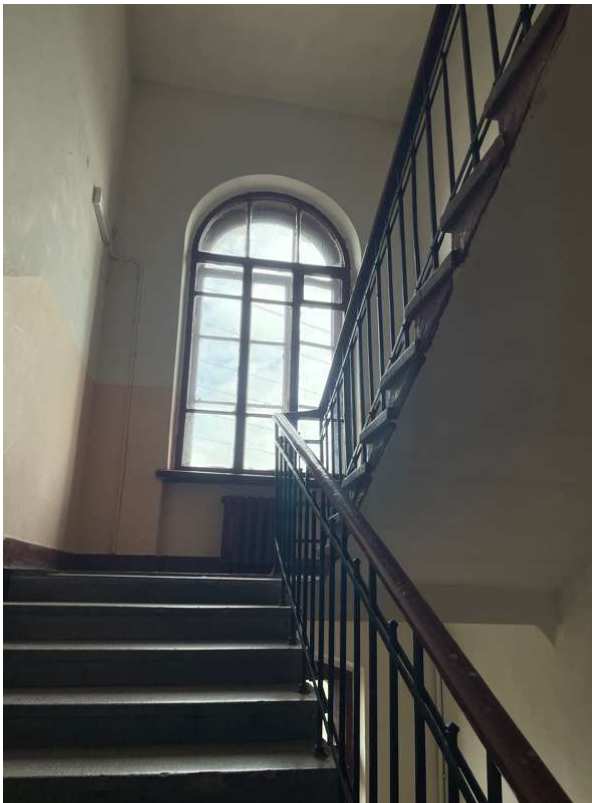
24. Фрагмент интерьера лестницы
