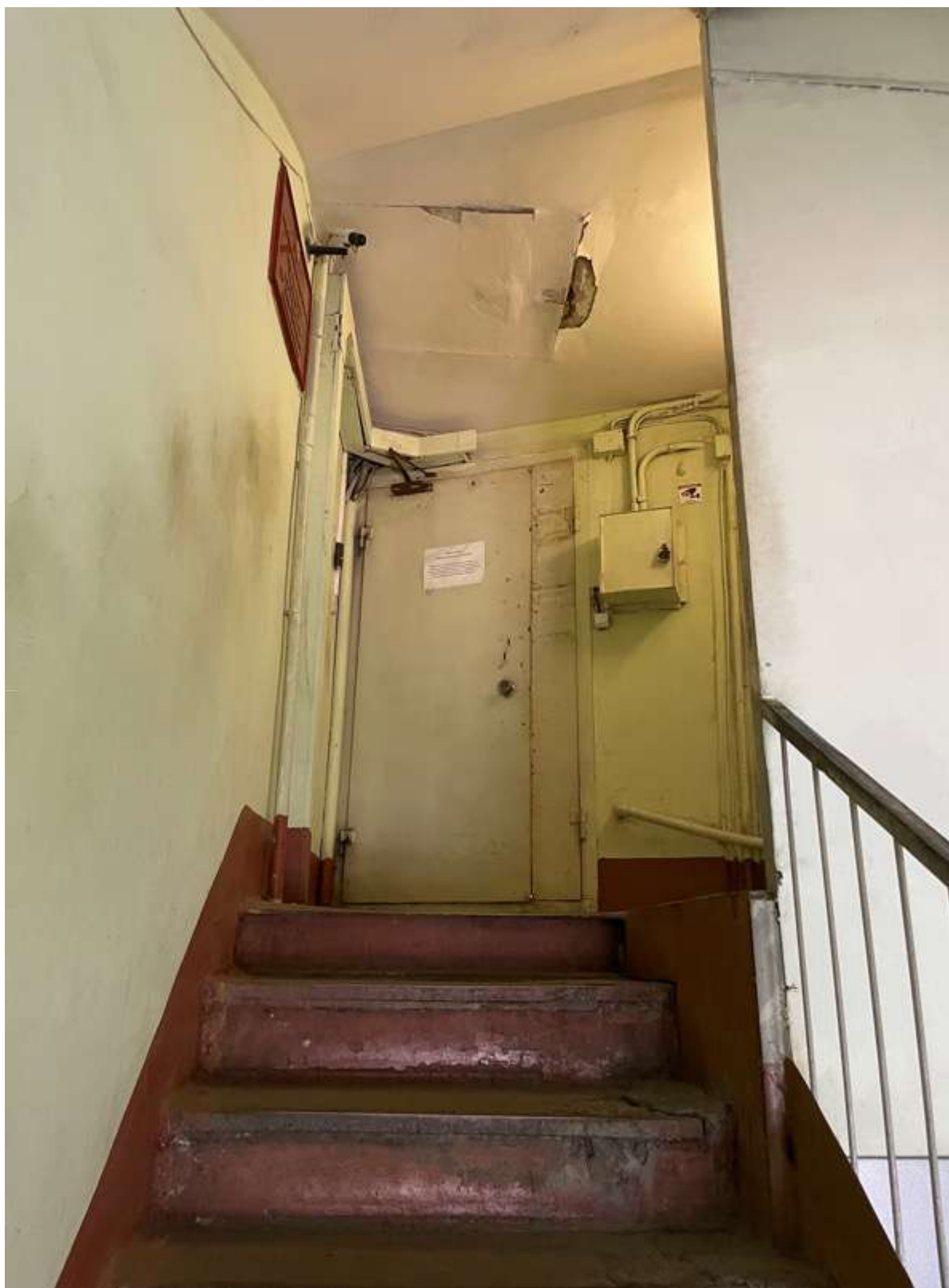
99. Фрагмент интерьера лестницы
