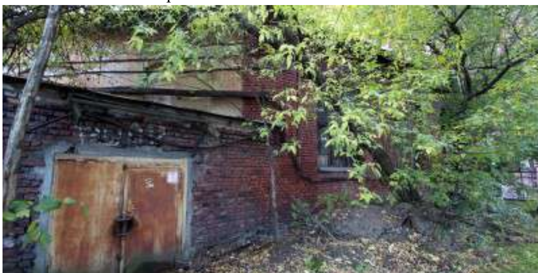
32. Здание Молочного комплекса. 2015 г. [Электронный ресурс] URL: https://kanoner.com/2015/09/29/147153/
