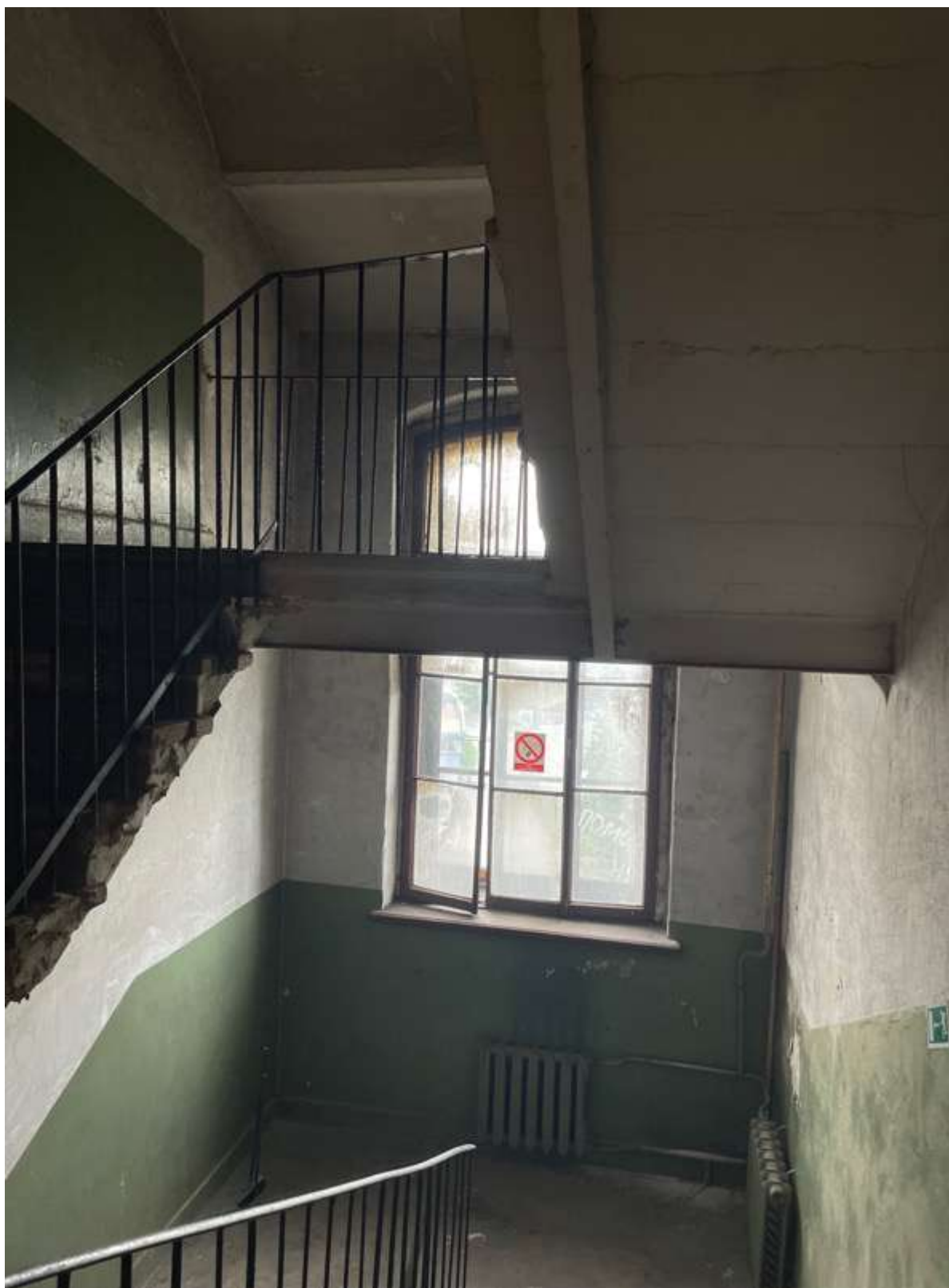
32. Фрагмент интерьера лестницы
