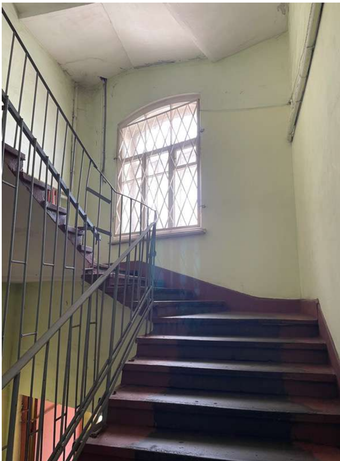
89. Фрагмент интерьера лестницы
