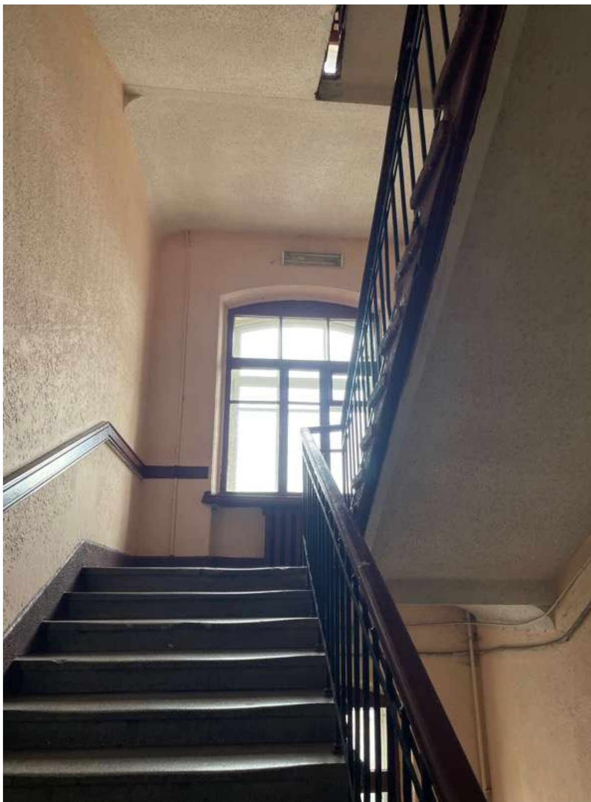
18. Фрагмент интерьера лестницы
