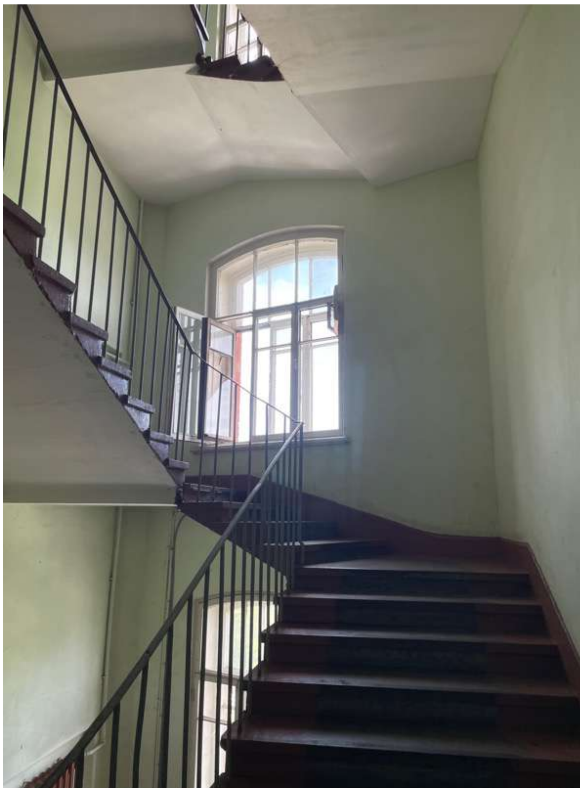
93. Фрагмент интерьера лестницы
