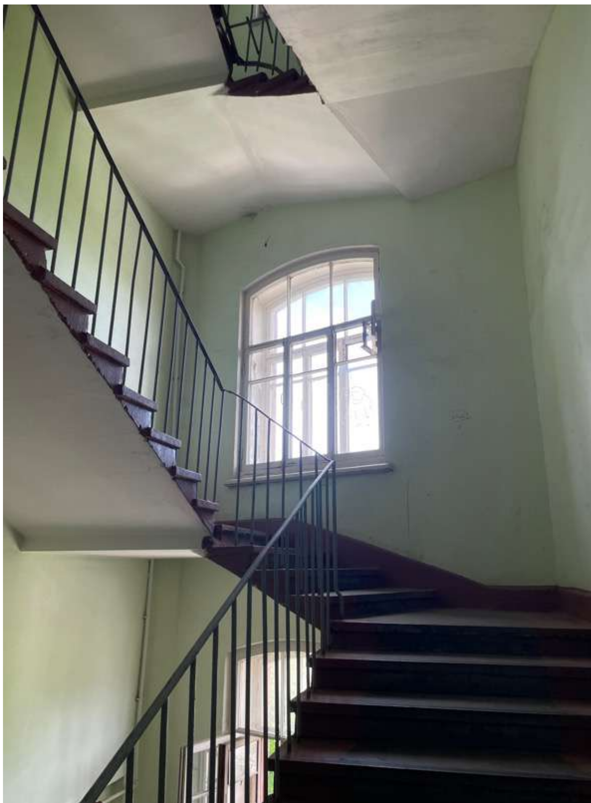
95. Фрагмент интерьера лестницы
