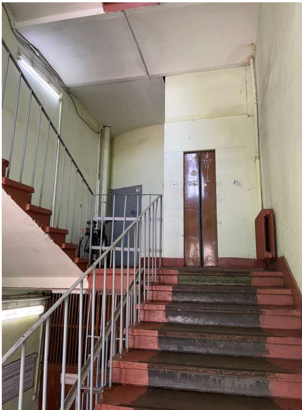
90. Фрагмент интерьера лестницы
