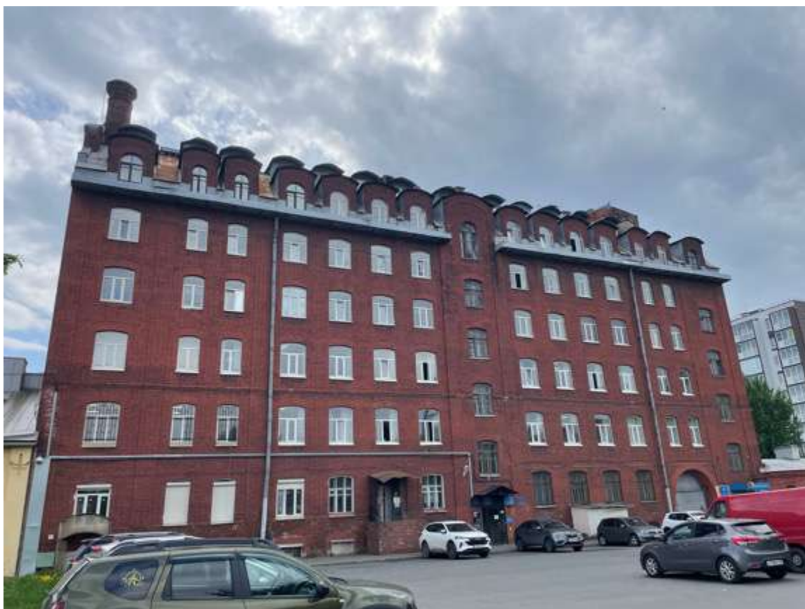
7. Фасад жилого дома со стороны Нейшлотского переуллка
