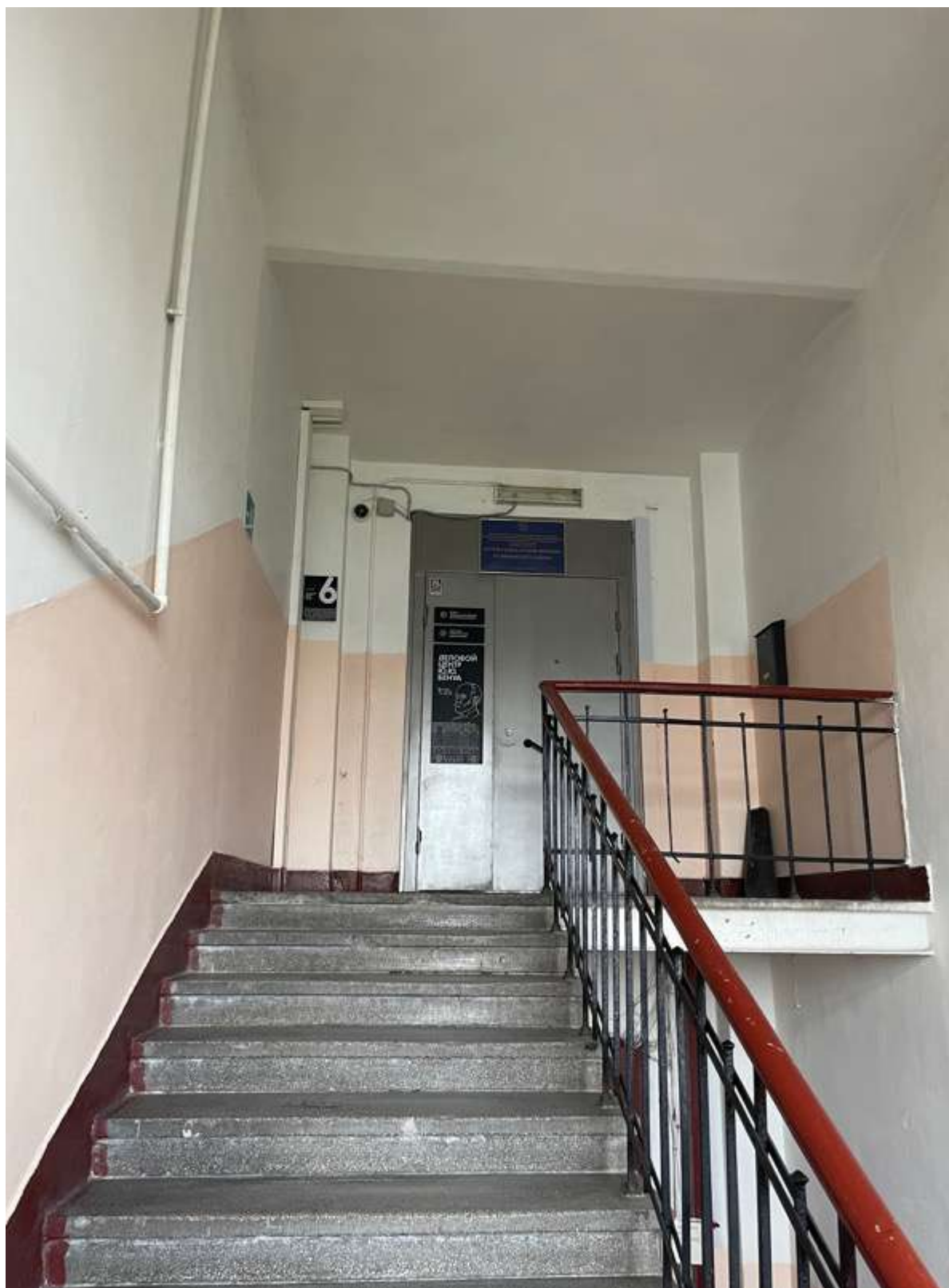
25. Фрагмент интерьера лестницы
