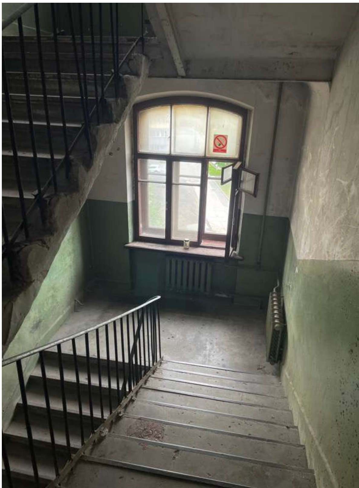
34. Фрагмент интерьера лестницы
