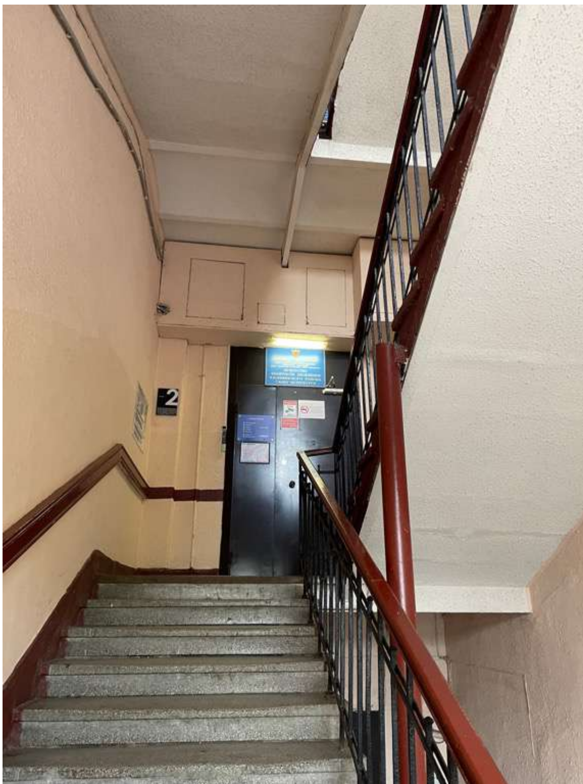
17. Фрагмент интерьера лестницы
