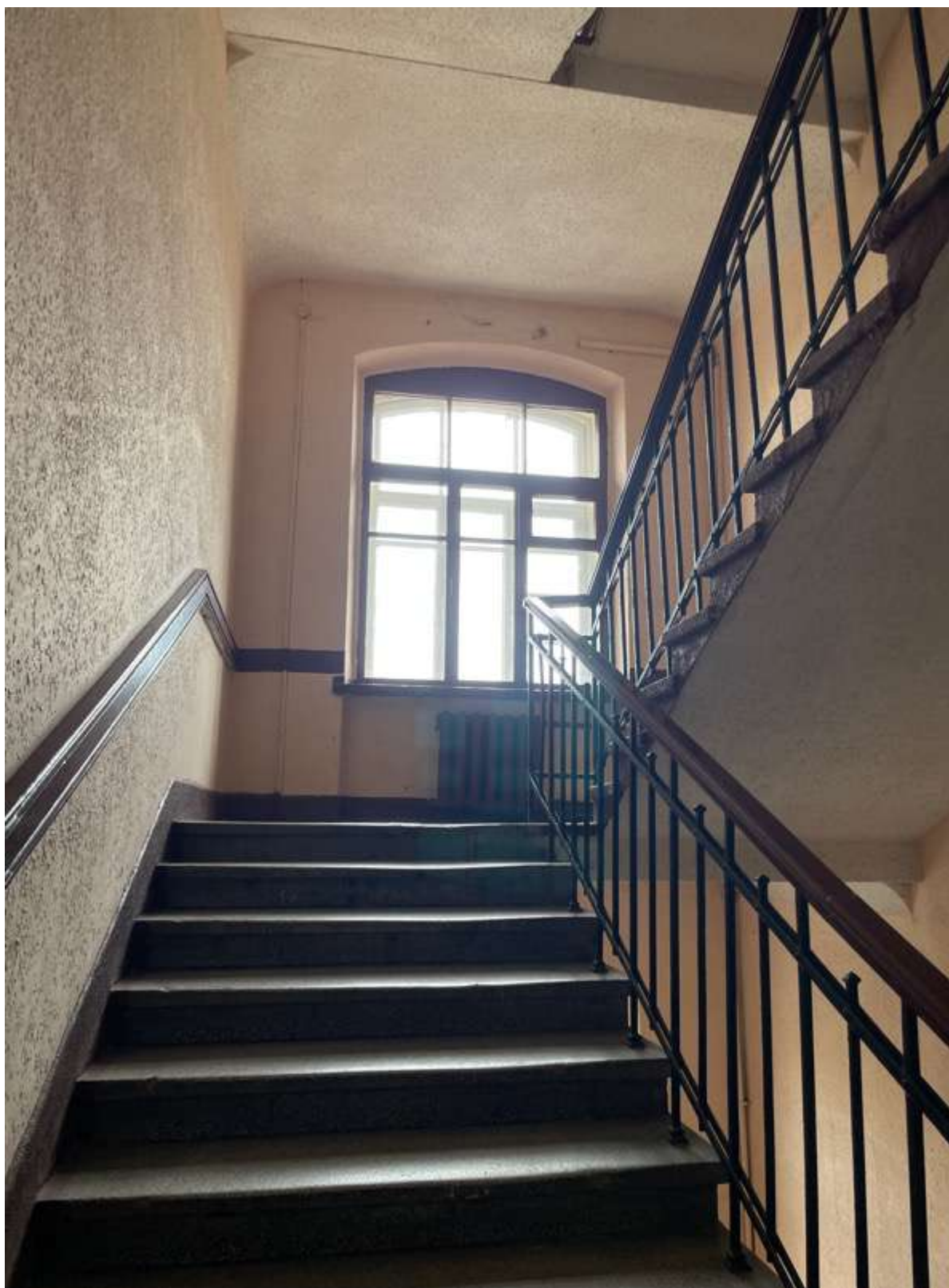
20. Фрагмент интерьера лестницы
