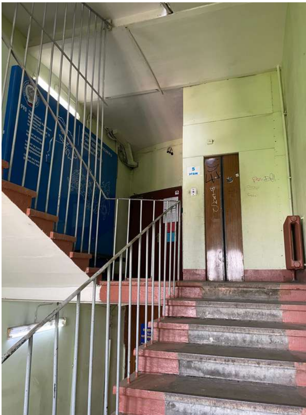
96. Фрагмент интерьера лестницы
