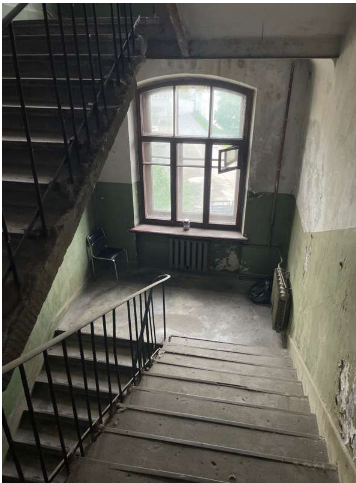
36. Фрагмент интерьера лестницы
