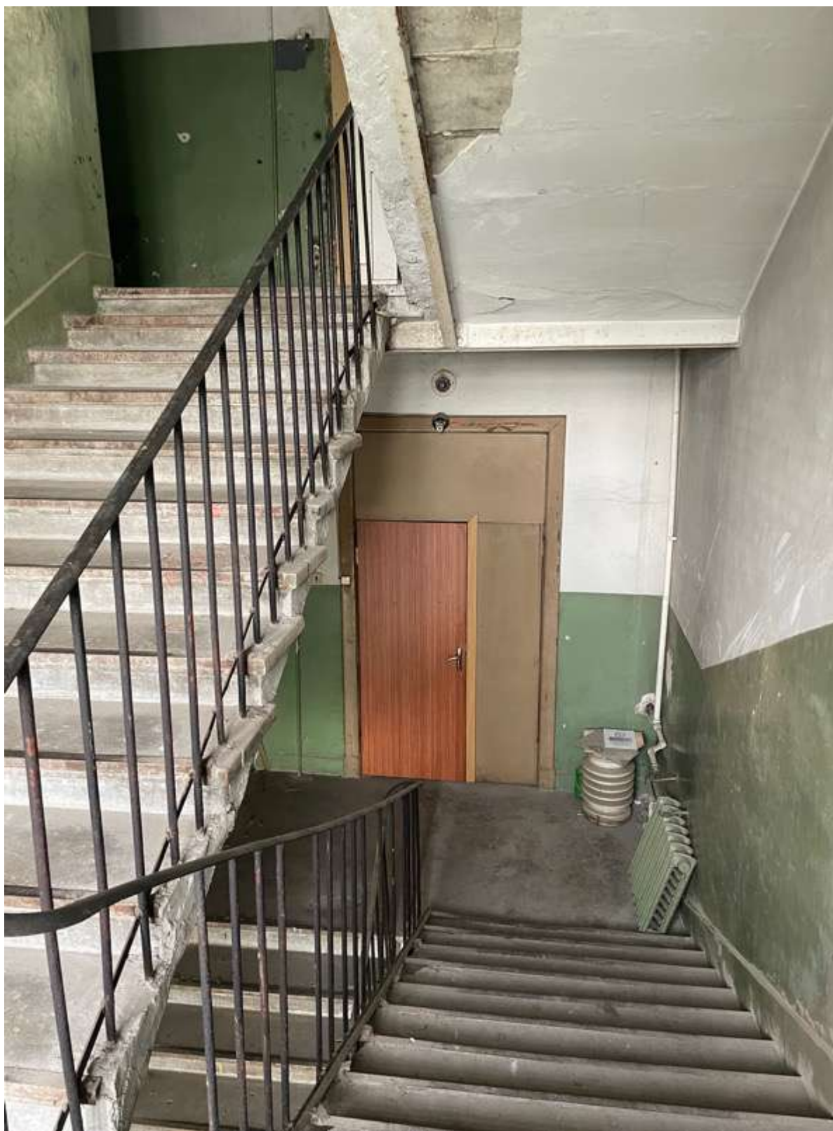
35. Фрагмент интерьера лестницы
