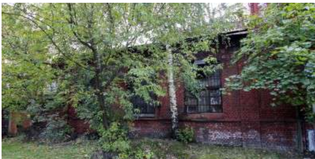
31. Здание Молочного комплекса. 2015 г. [Электронный ресурс] URL: https://kanoner.com/2015/09/29/147153/
