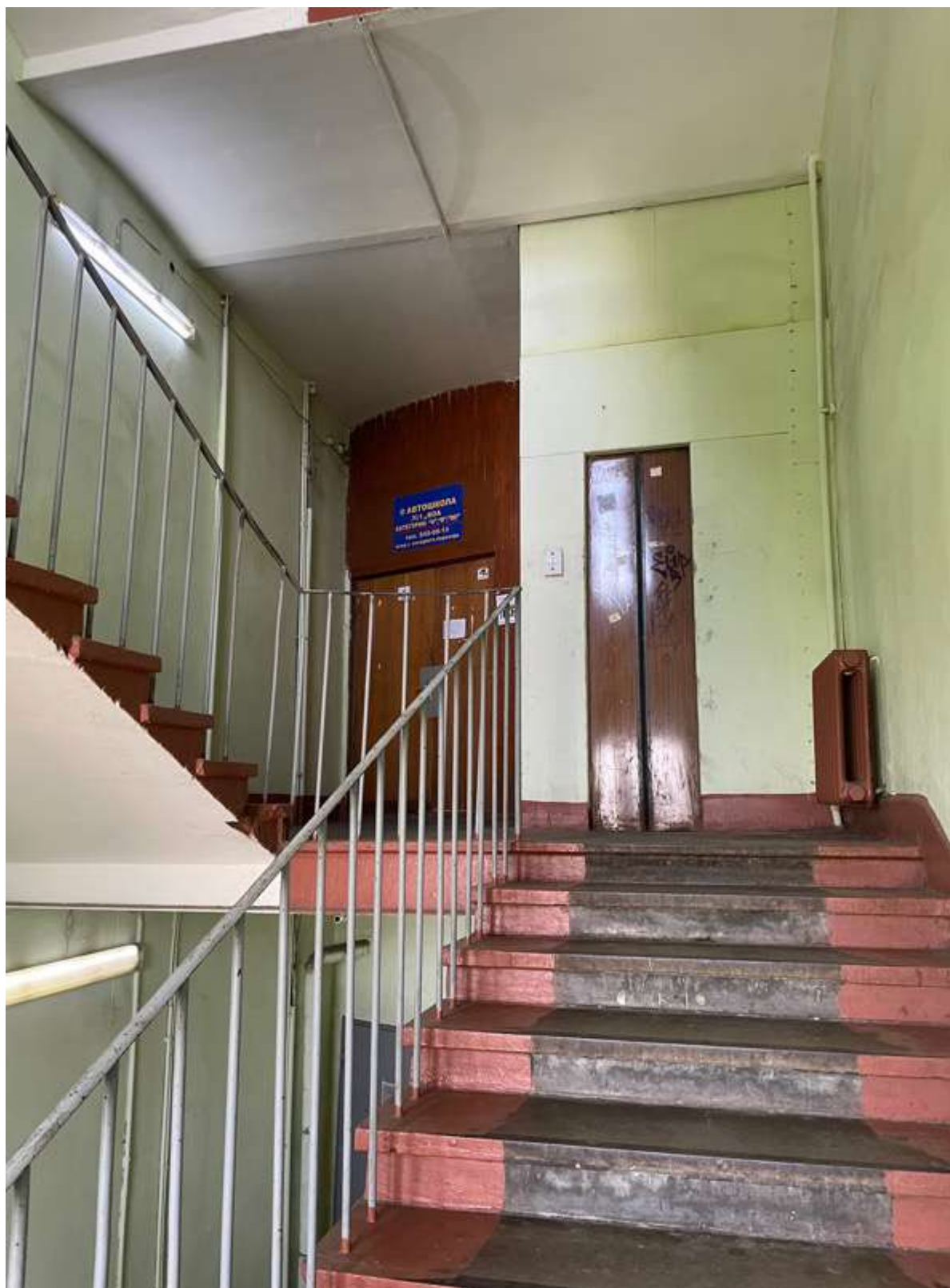
94. Фрагмент интерьера лестницы
