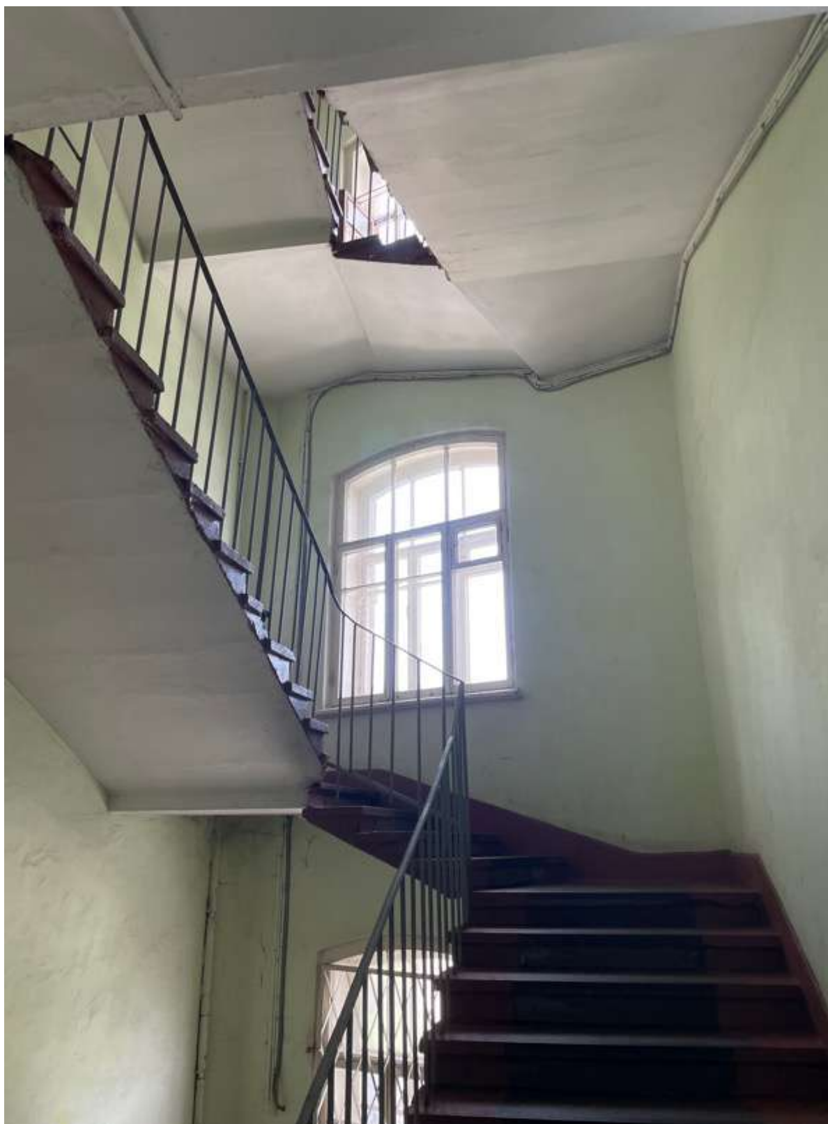
91. Фрагмент интерьера лестницы
