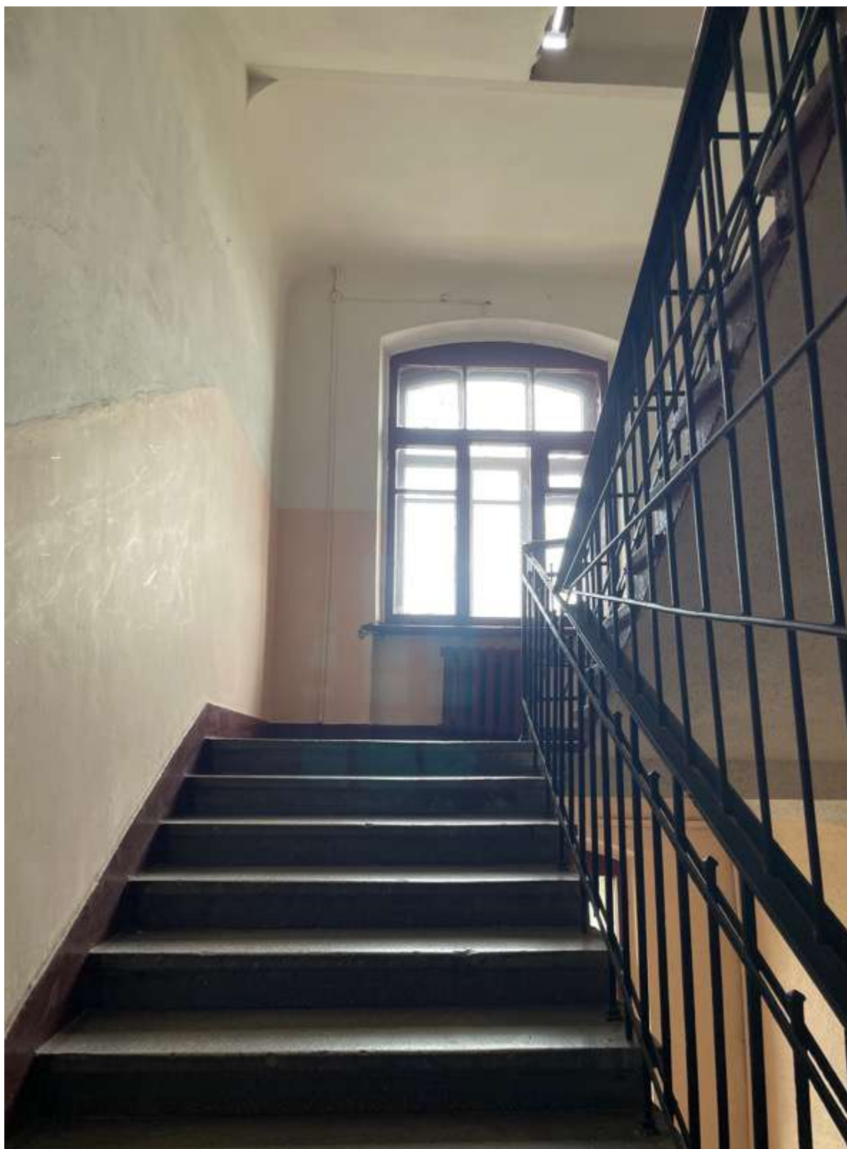
22. Фрагмент интерьера лестницы
