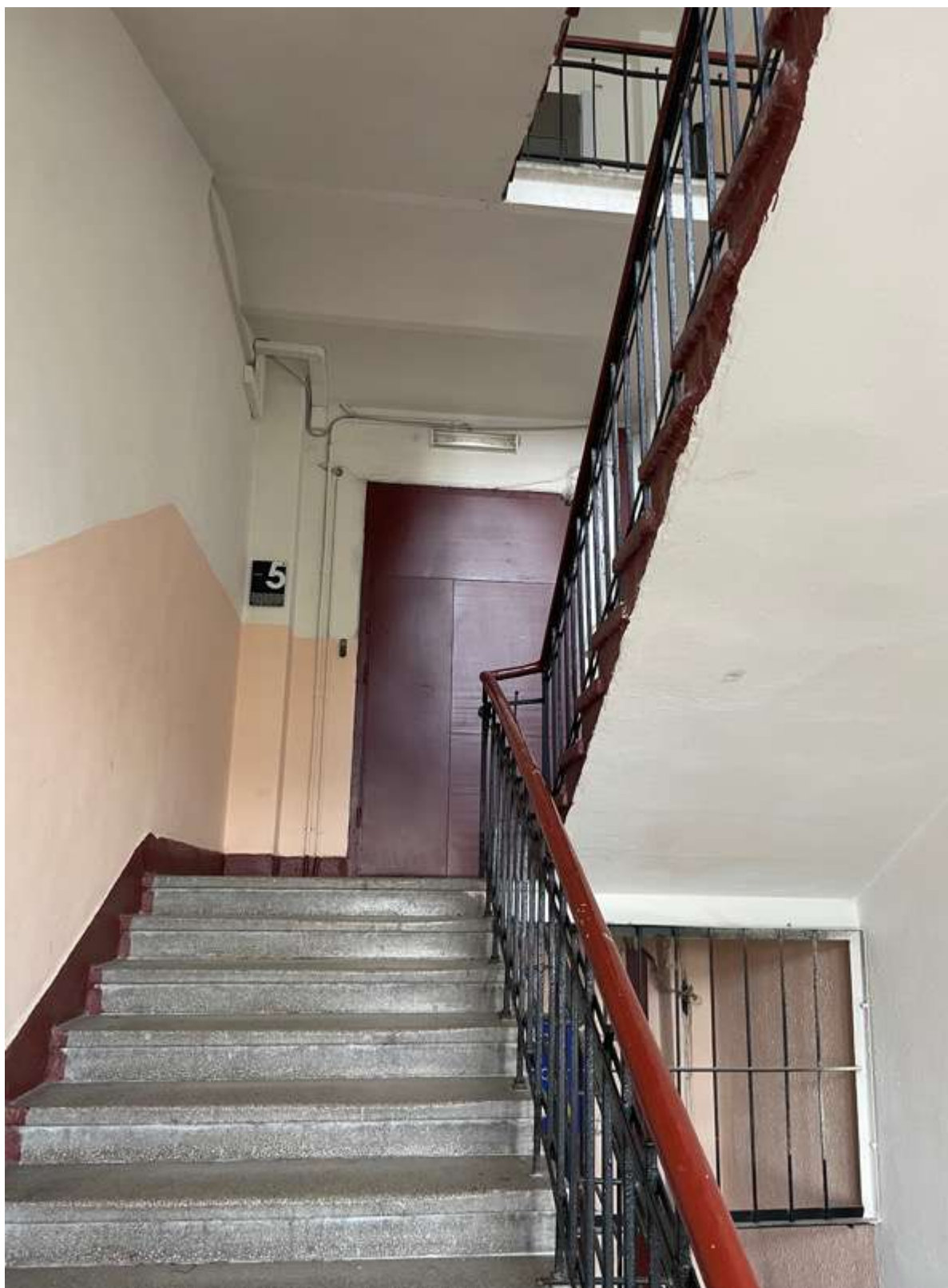
23. Фрагмент интерьера лестницы
