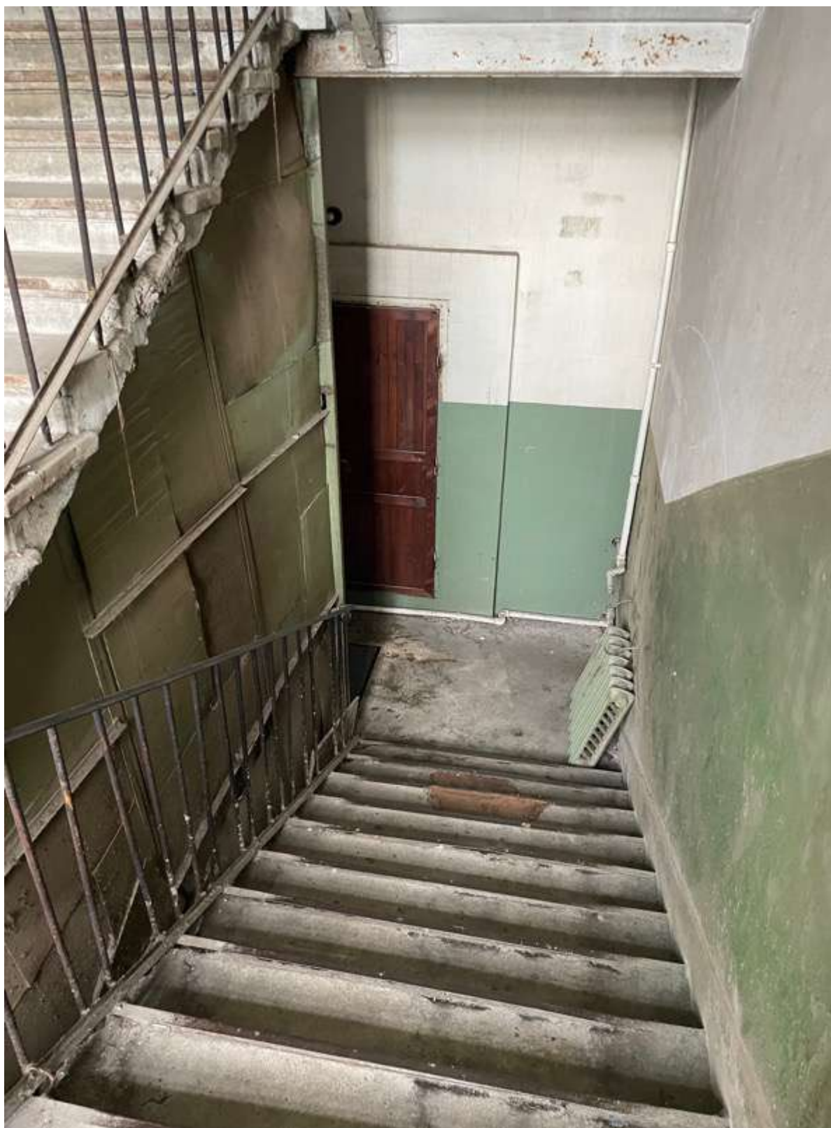
37. Фрагмент интерьера лестницы
