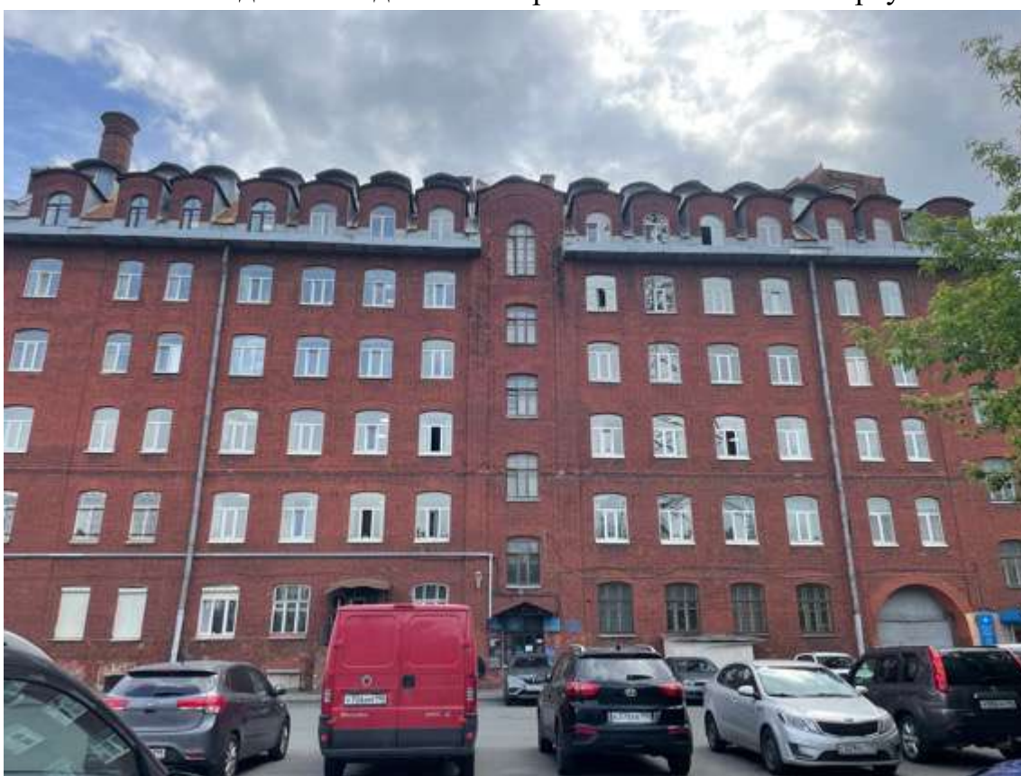
4. Фасад жилого дома со стороны Нейшлотского переуллка
