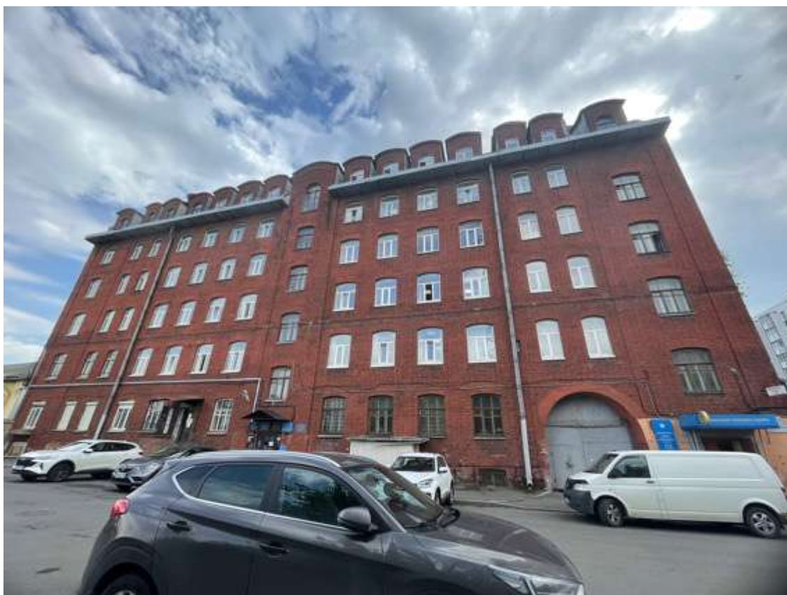
3. Фасад жилого дома со стороны Нейшлотского переуллка
