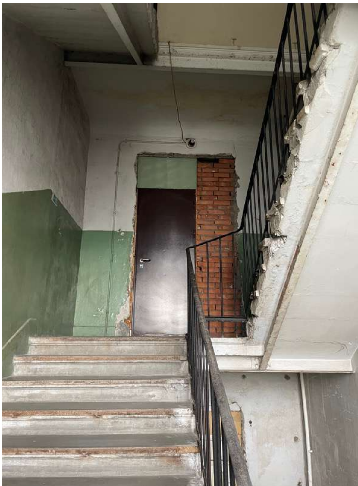
39. Фрагмент интерьера лестницы
