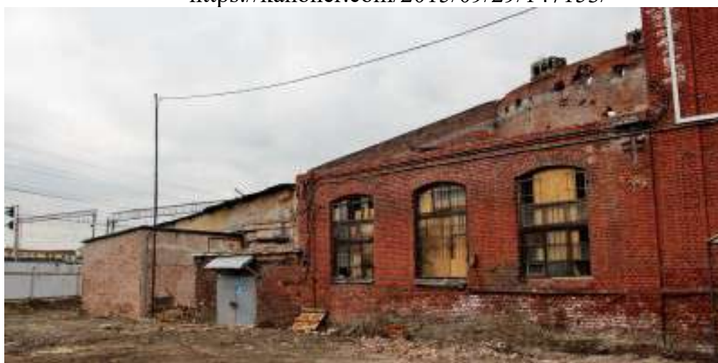
33. Здание Молочного комплекса. 2017 г. [Электронный ресурс] URL: https://kanoner.com/2017/10/12/157207/
