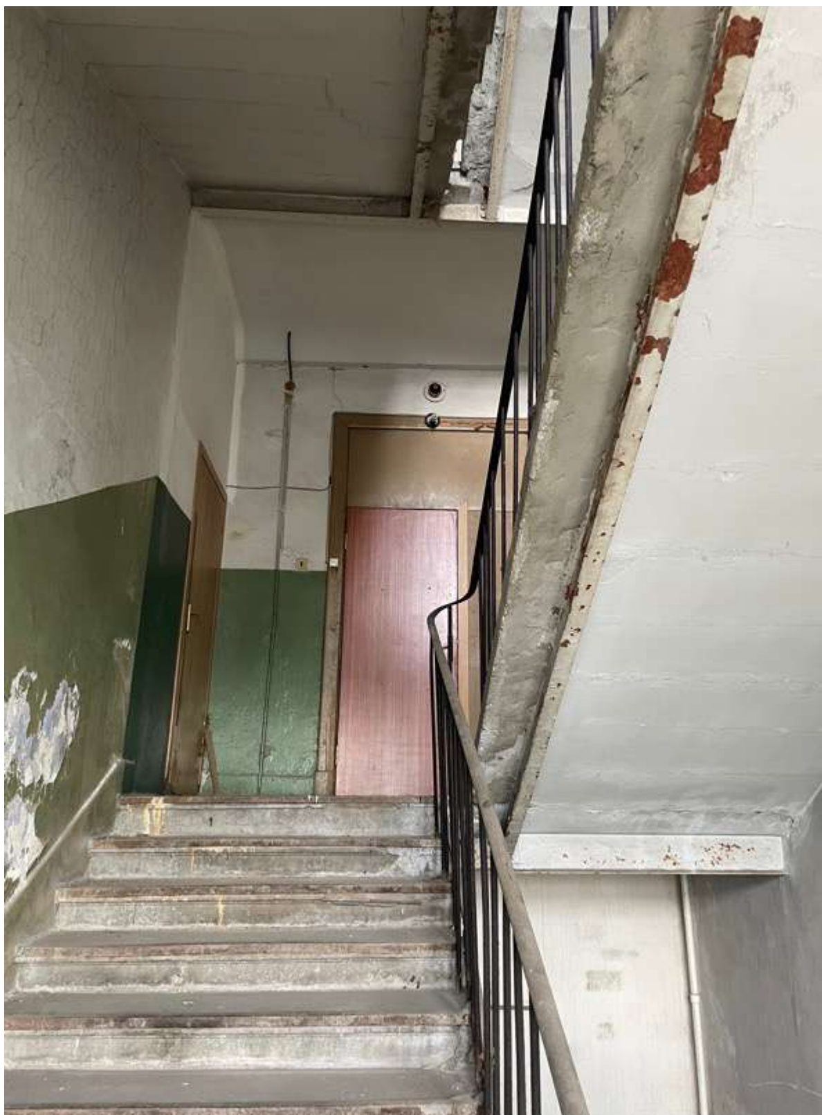
38. Фрагмент интерьера лестницы
