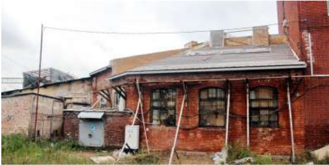
34. Здание Молочного комплекса. 2017 г. [Электронный ресурс] URL: https://kanoner.com/2017/10/12/157207/
