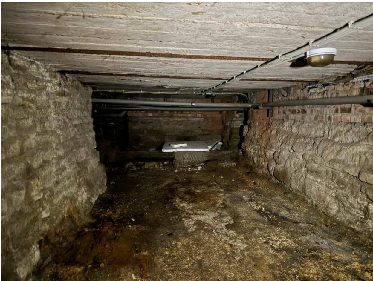
Фото 17. Вид на подвальное помещение объекта культурного наследия.
