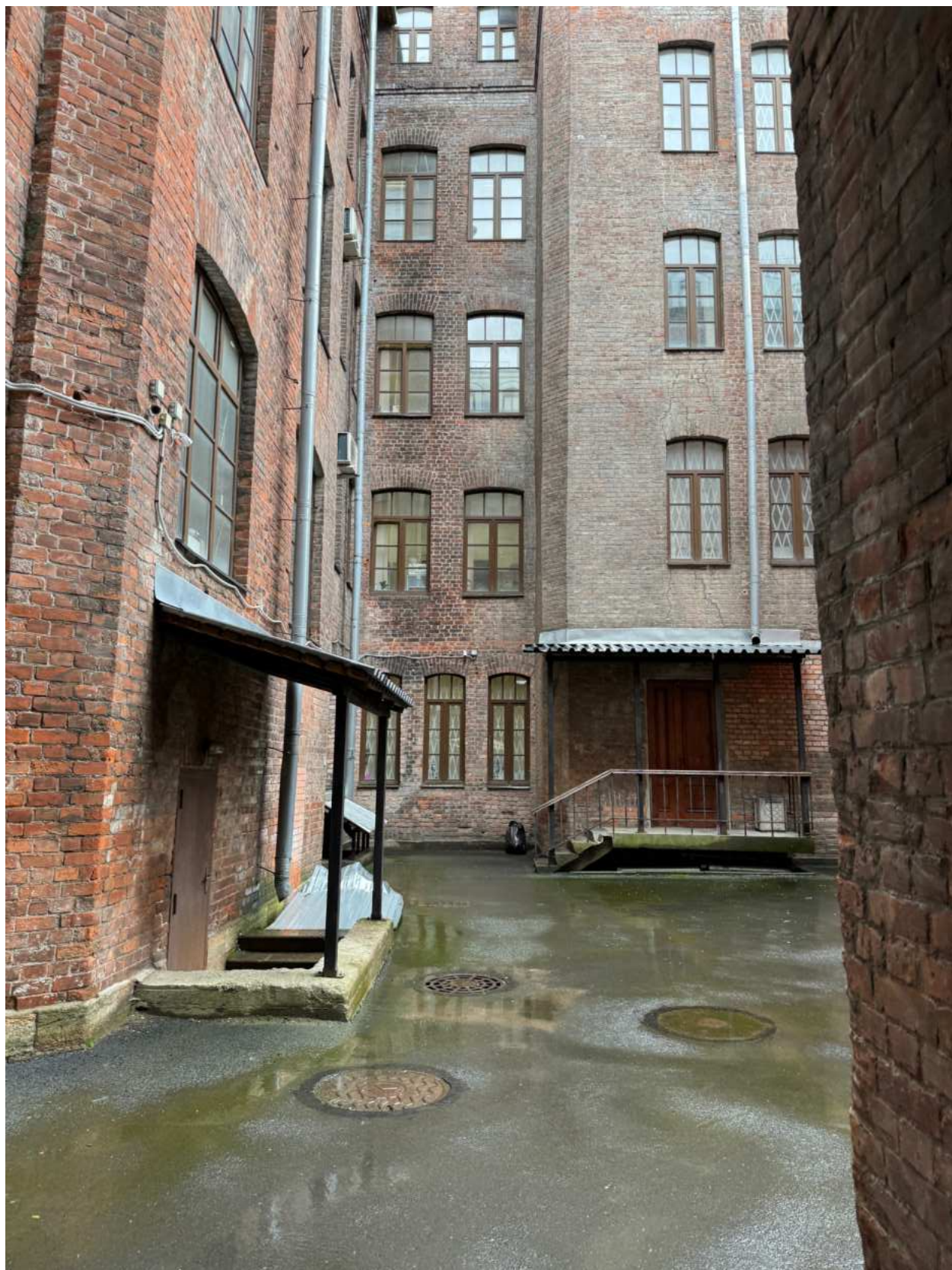
Фото 9. Общий вид дворовых фасадов объекта культурного наследия.
