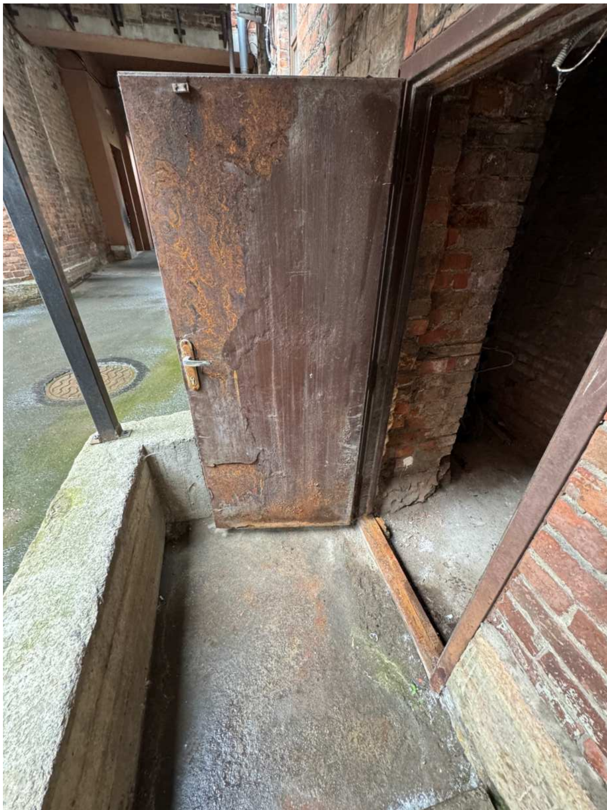
Фото 16. Вход в подвальное помещение объекта культурного наследия.
