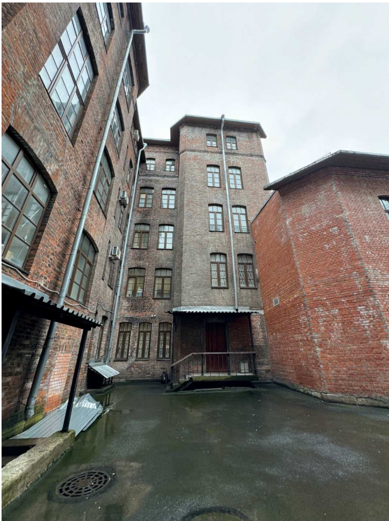
Фото 10. Общий вид дворовых фасадов объекта культурного наследия.
