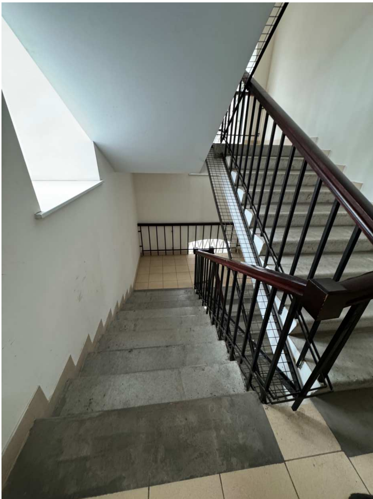
Фото 35. Вид на интерьер лестницы 2ЛК объекта культурного наследия.
