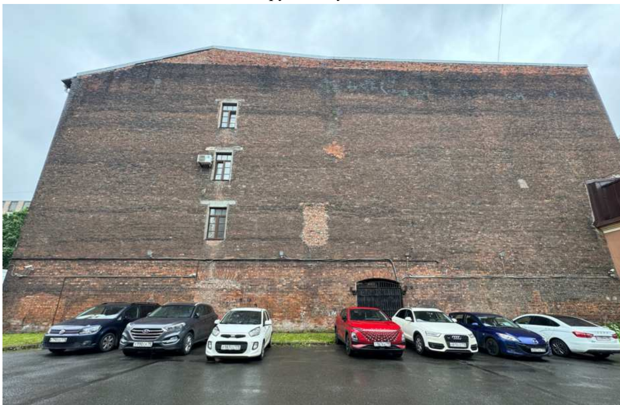
Фото 3. Общий вид brandмауэрной стены объекта культурного наследия с проезда от Бобруйской улицы.
