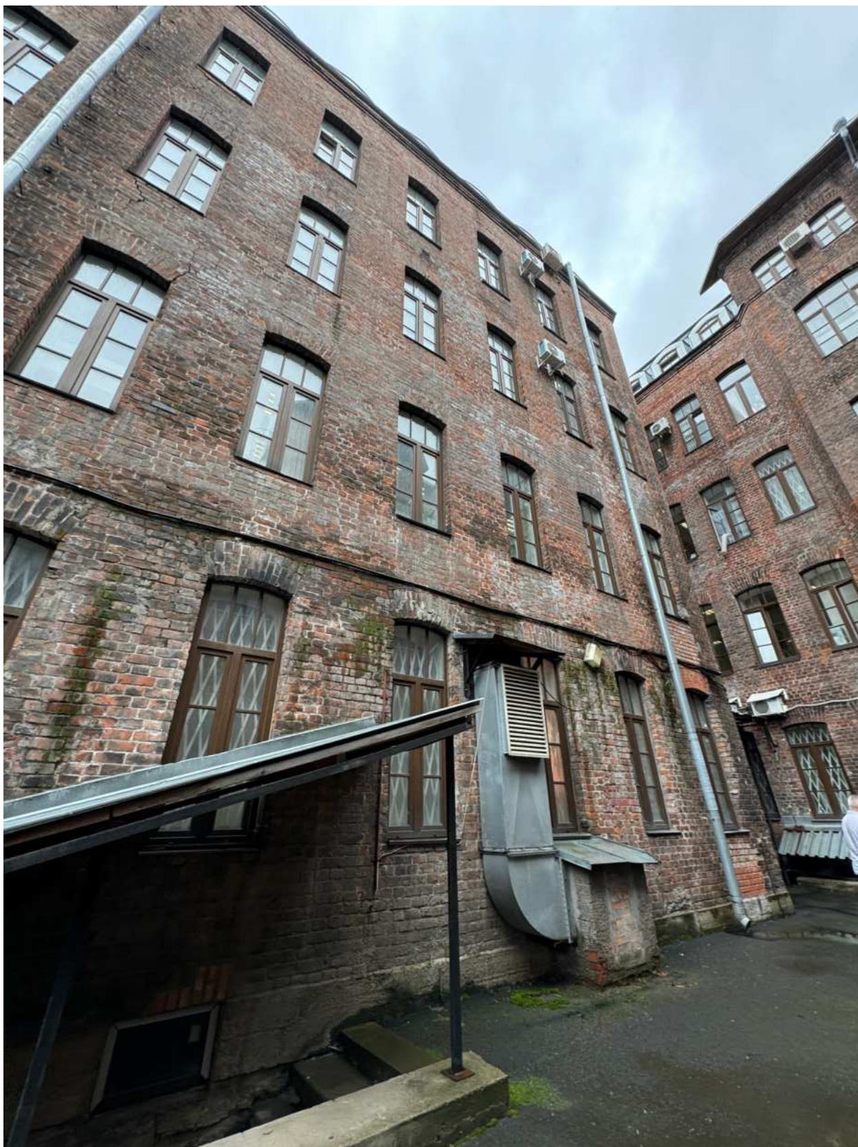
Фото 13. Общий вид дворовых фасадов объекта культурного наследия.
