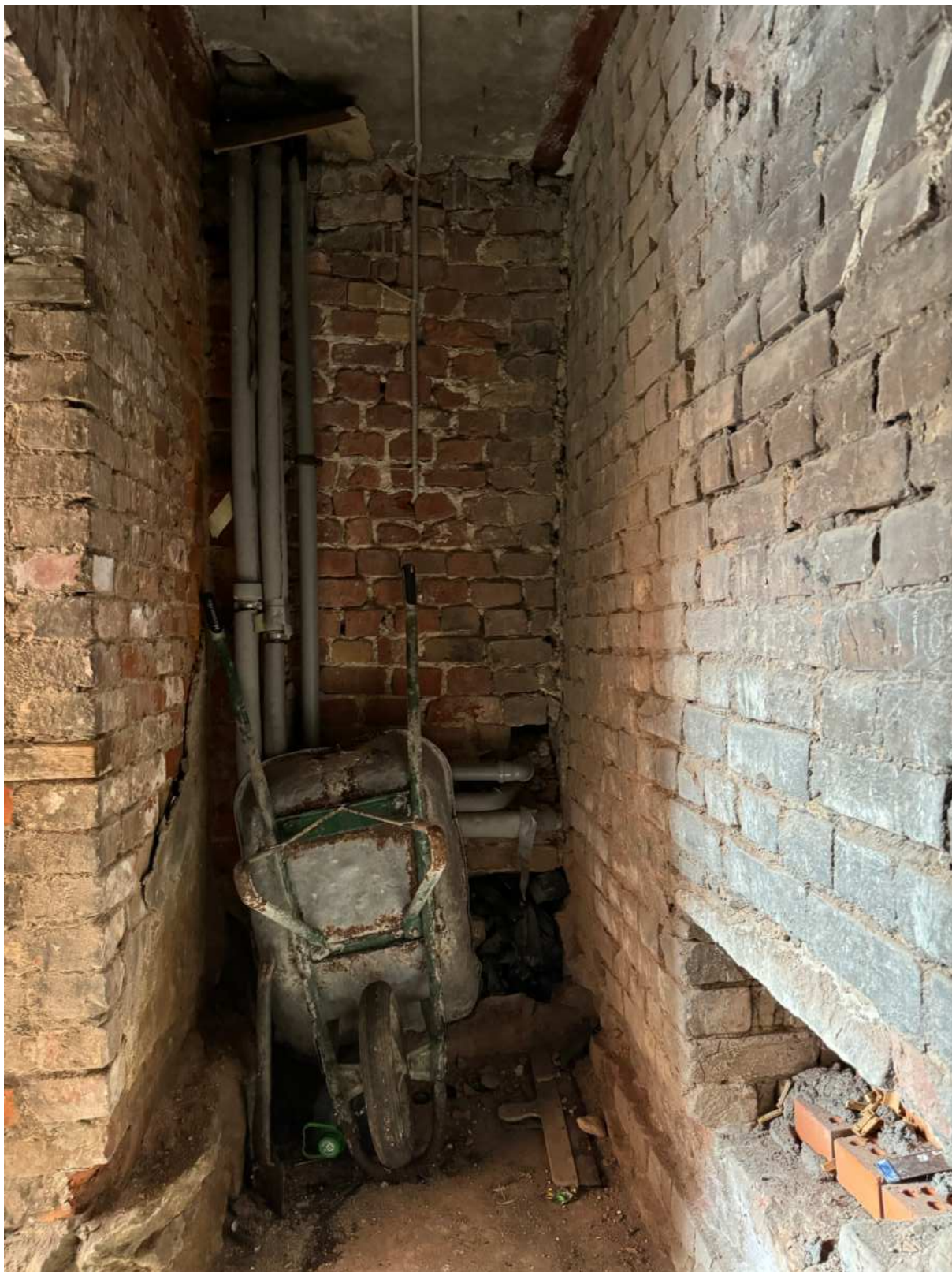
Фото 19. Вид на подвальное помещение объекта культурного наследия.
