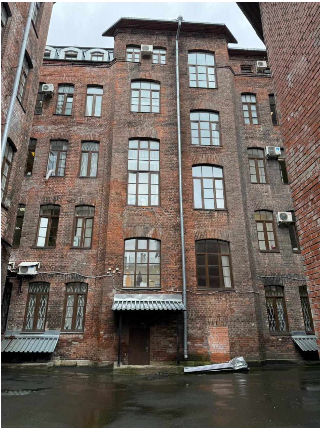
Фото 12. Общий вид дворовых фасадов объекта культурного наследия.
