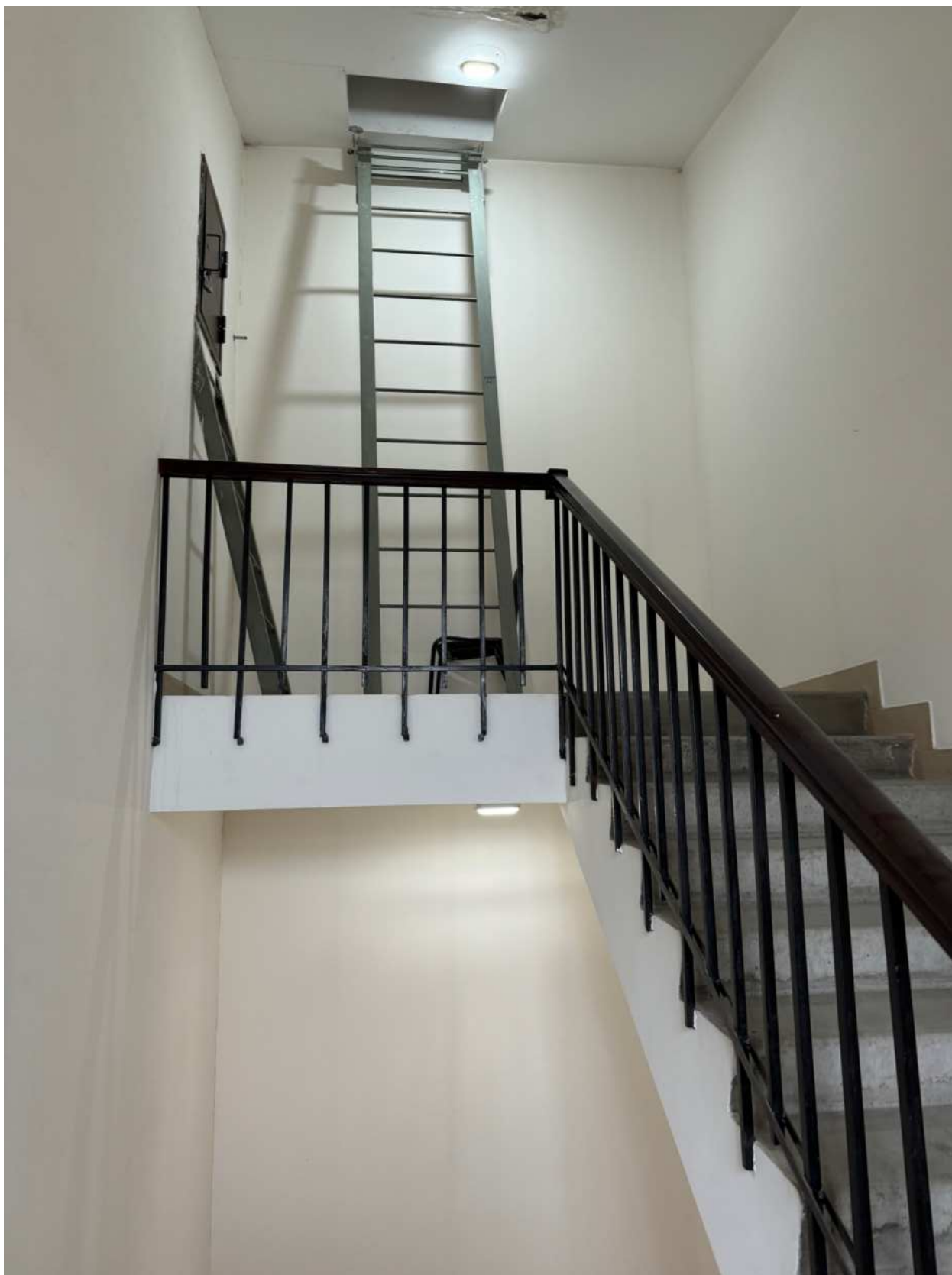
Фото 30. Вид на интерьер лестницы 2ЛК объекта культурного наследия.
