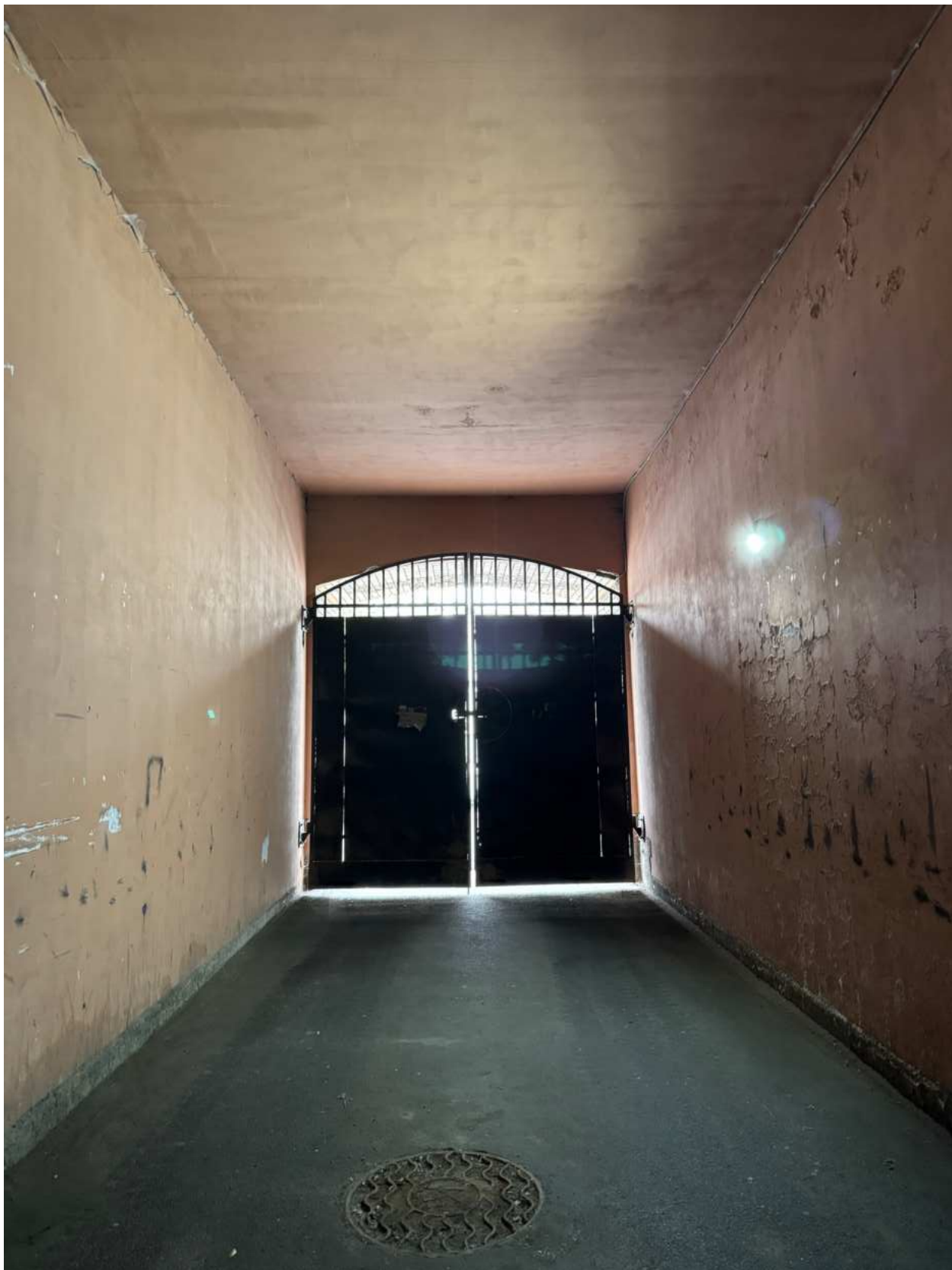
Фото 7. Вид на арку проезда объекта культурного наследия.
