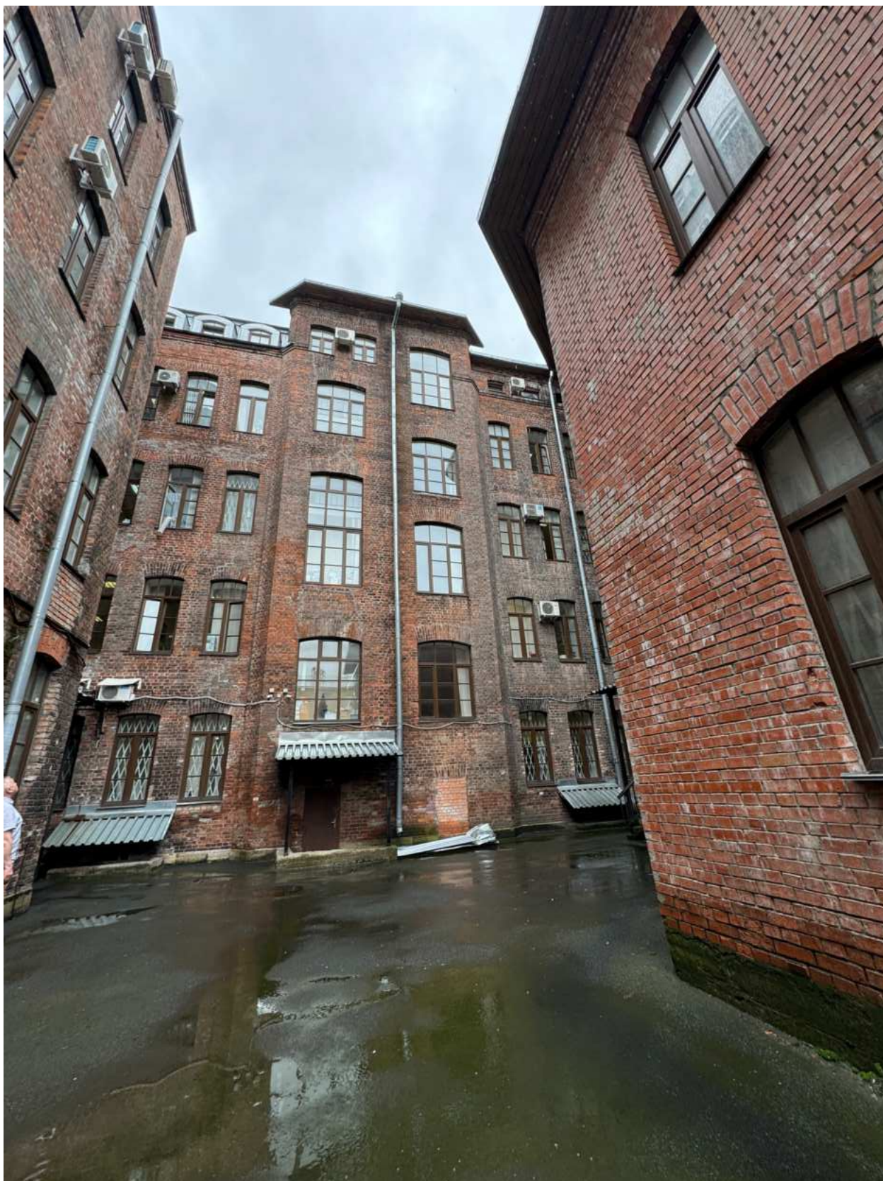
Фото 11. Общий вид дворовых фасадов объекта культурного наследия.
