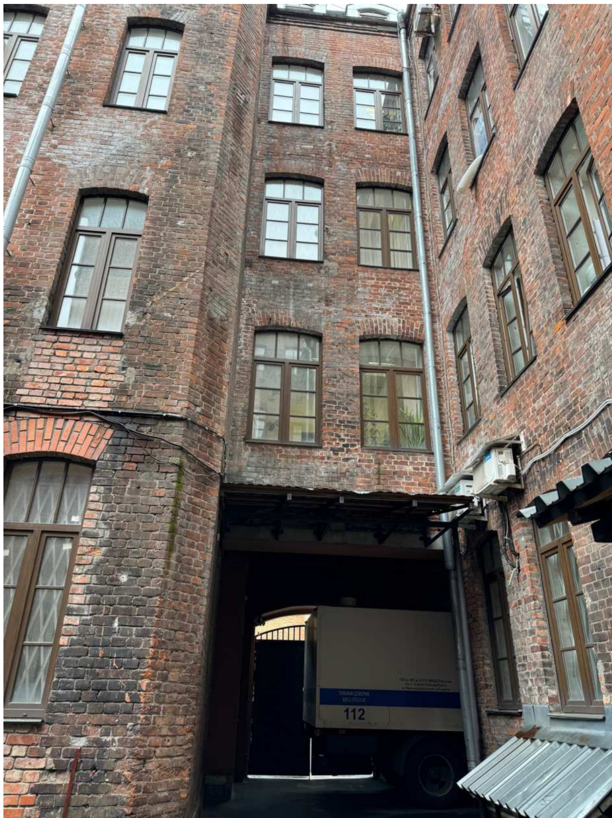
Фото 14. Общий вид дворовых фасадов объекта культурного наследия.
