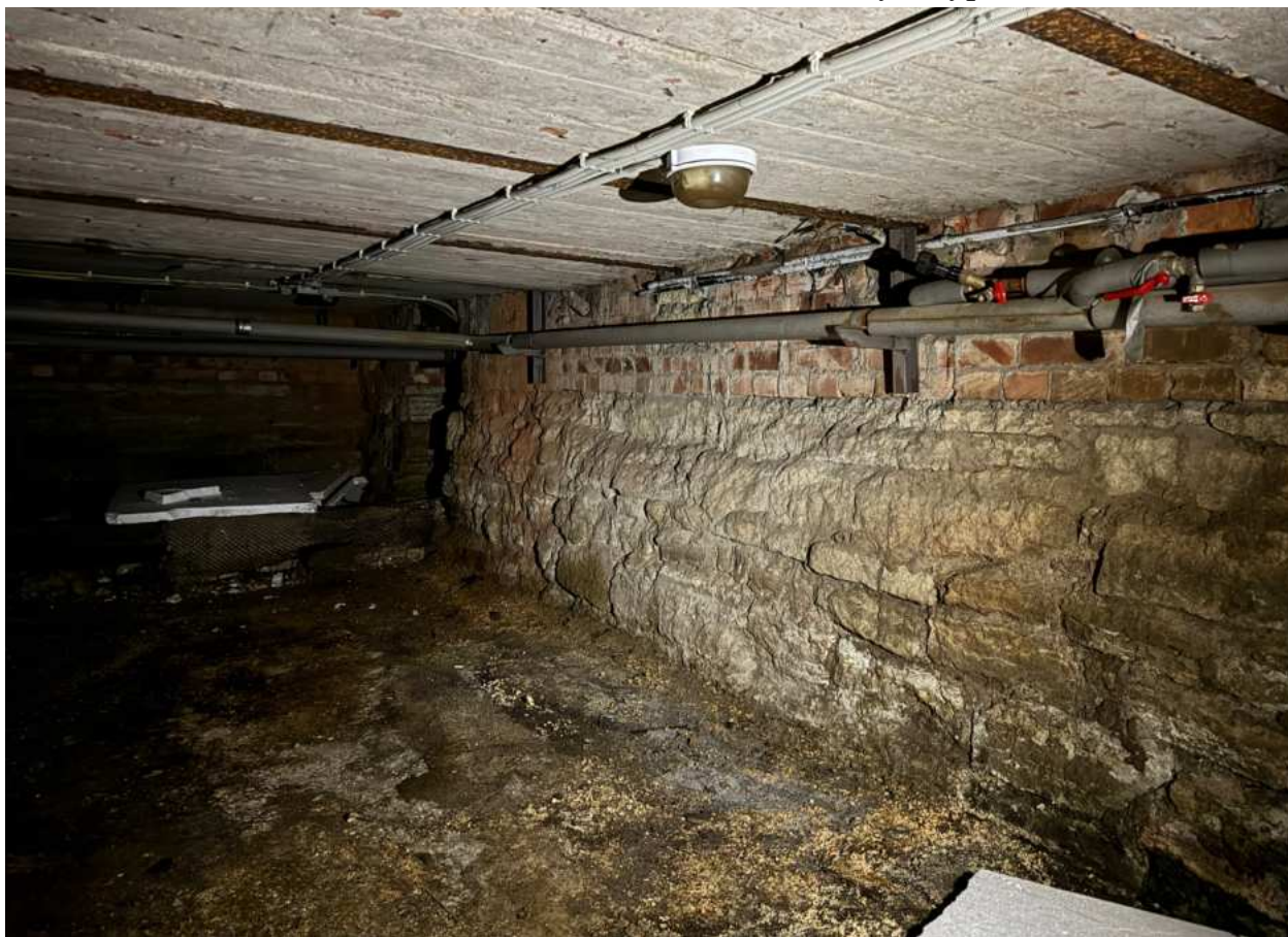
Фото 18. Вид на подвальное помещение объекта культурного наследия.
