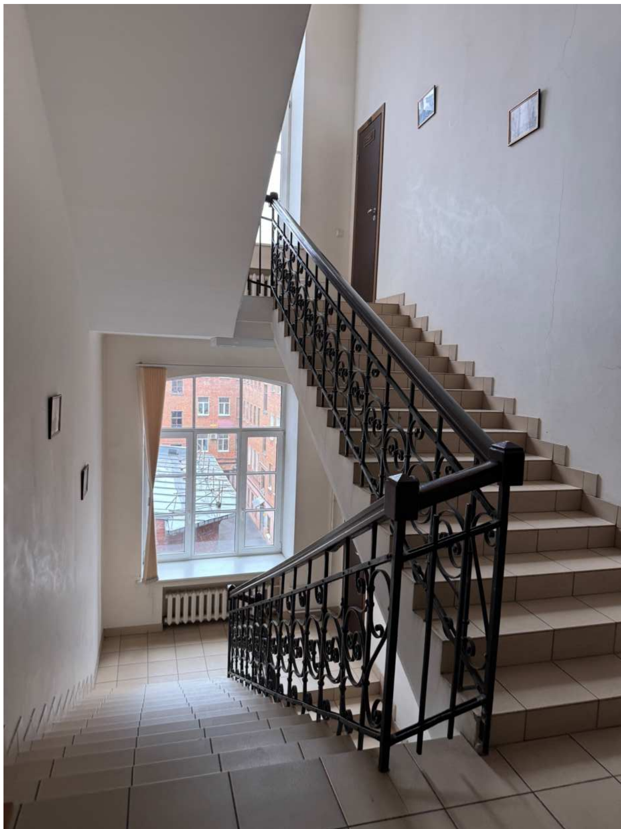
Фото 54. Вид на интерьер лестницы 1ЛК объекта культурного наследия.
