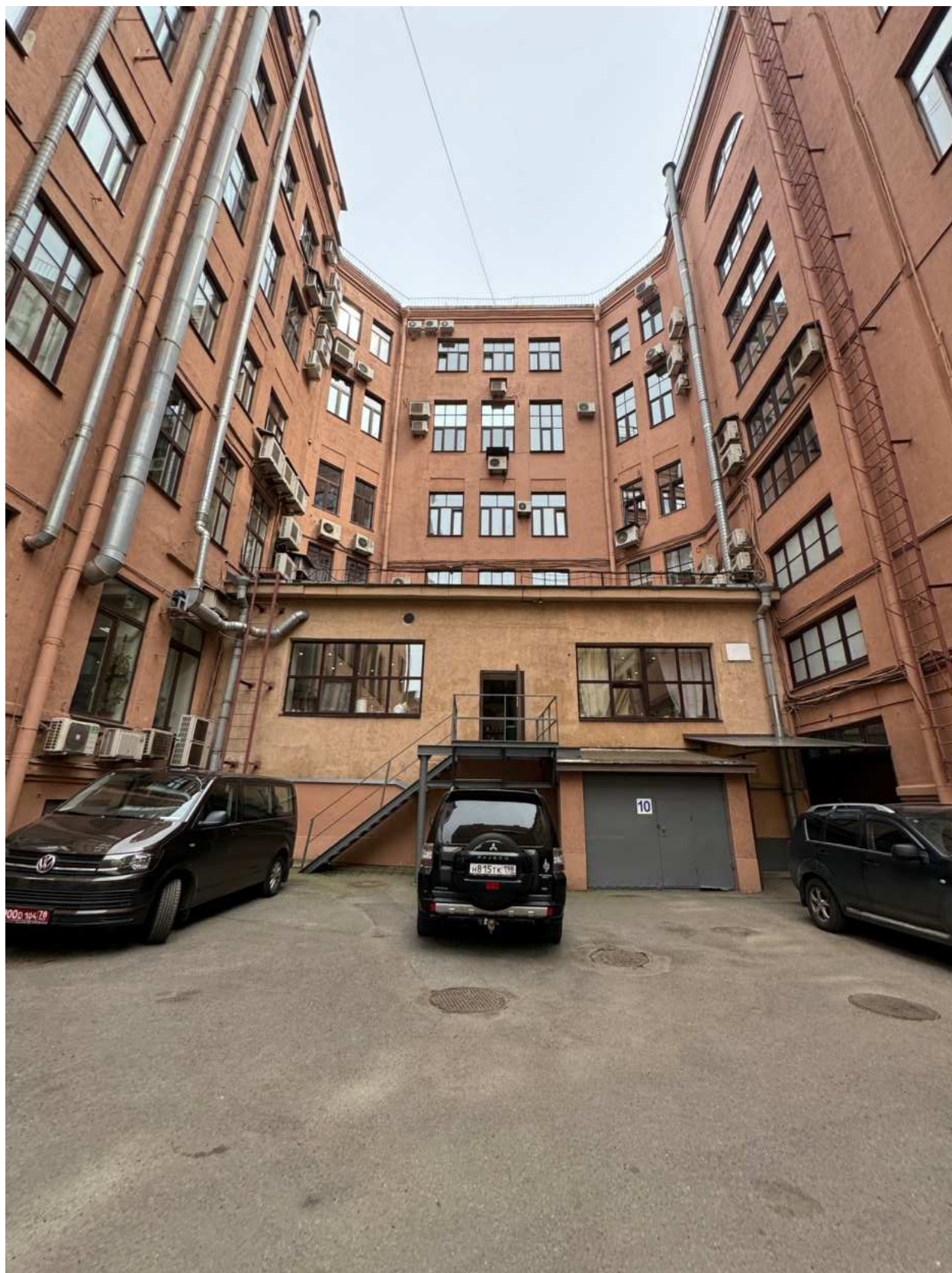
Фото 6. Вид на дворовые фасады объекта культурного наследия.
