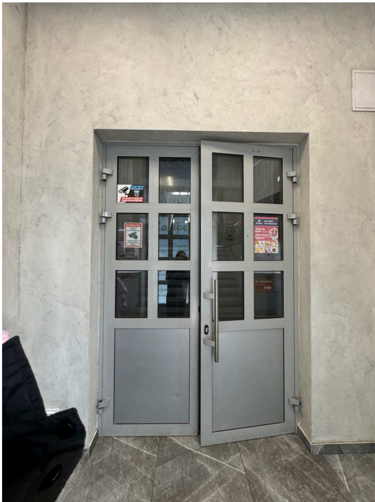
Фото 112. Вид на дверное заполнение объекта культурного наследия.
