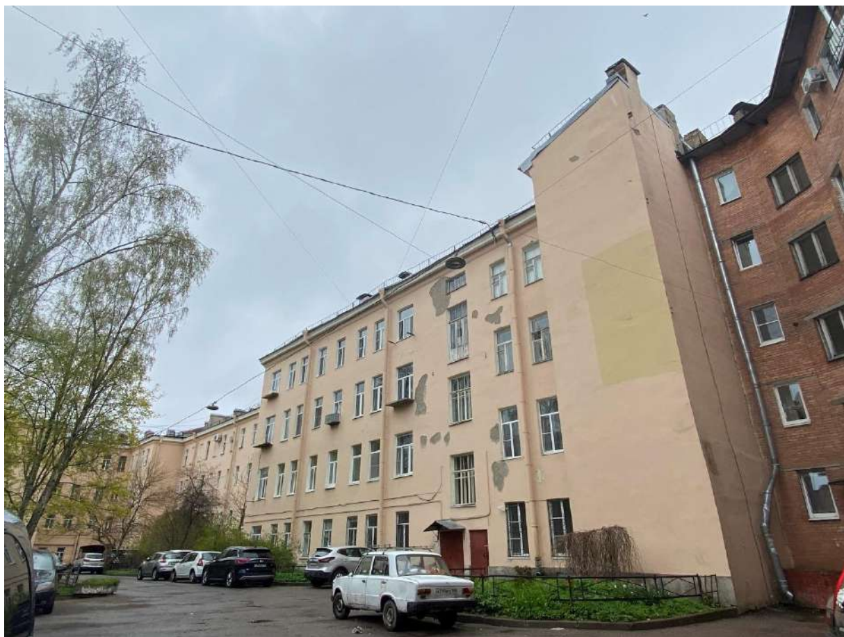
Фото 9. Вид на дворовые фасады.
