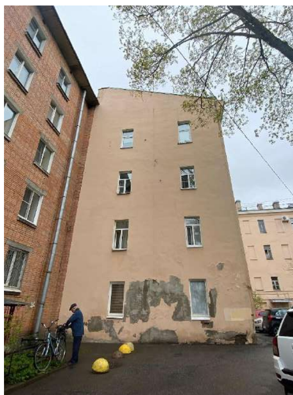
Фото 14. Вид на дворовой фасад.
