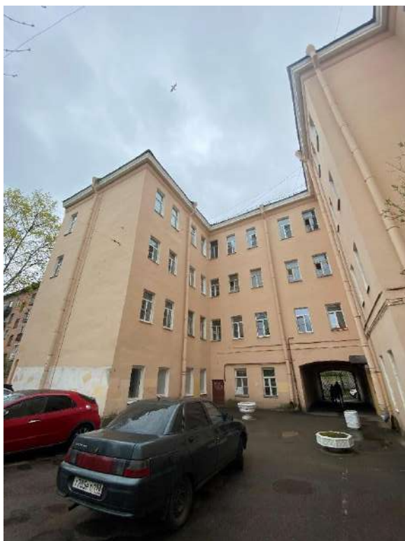
Фото 11. Вид на дворовые фасады.
