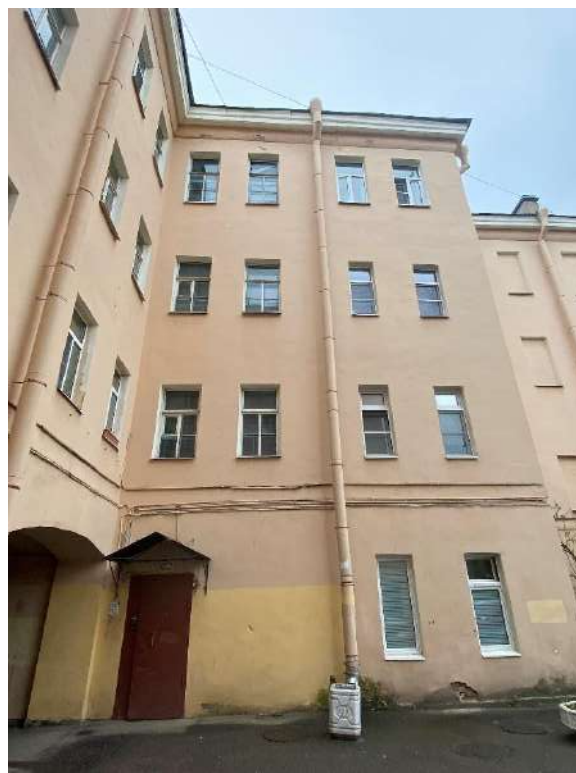
Фото 12. Вид на дворовой фасад.
