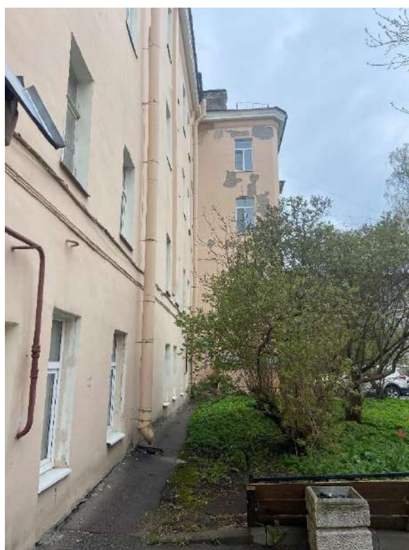
Фото 13. Вид на дворовой фасад.
