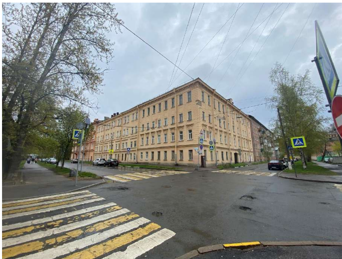
Фото 2. Вид на пересечение улиц Кронштадтской и Карла Маркса.
