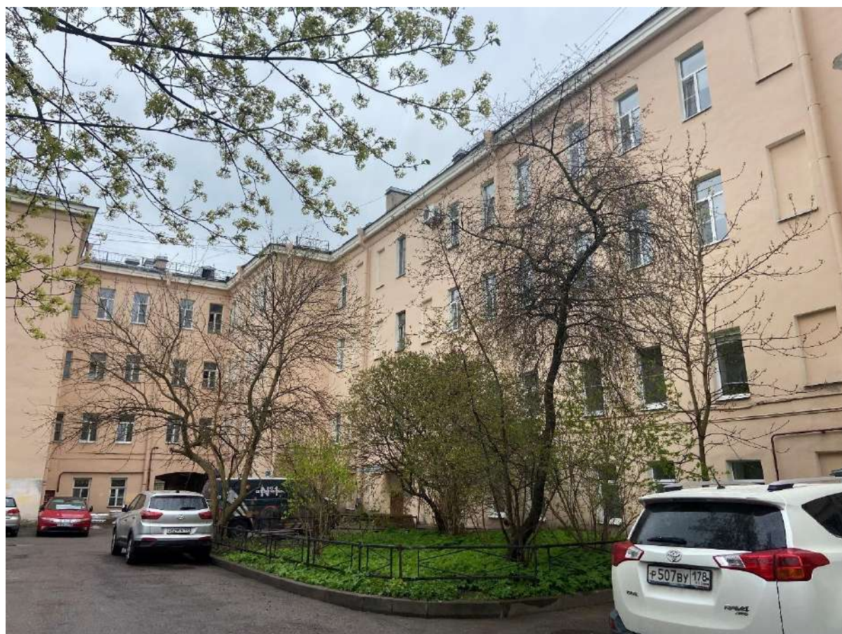
Фото 10. Вид на дворовые фасады.
