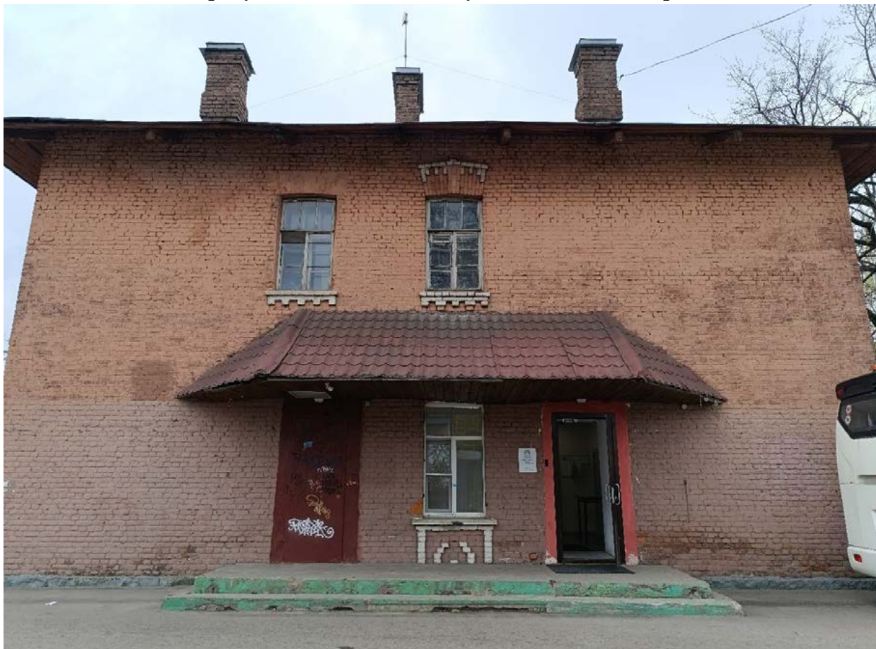
Фото 8. Восточный фасад лит. О.
