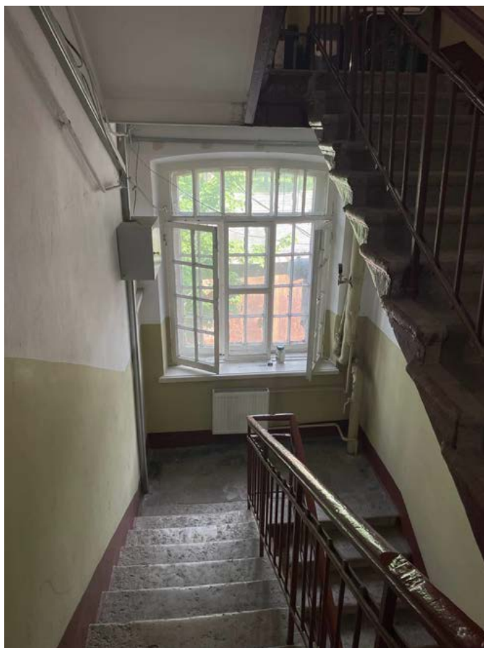
Фото 38. Междуэтажная площадка корп. 3, лит. Б.
