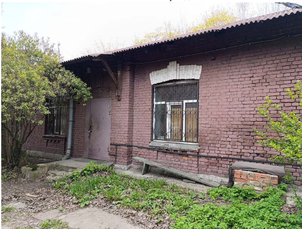
Фото 42. Фрагмент восточного фасада лит. Б, центральное крыльцо.
