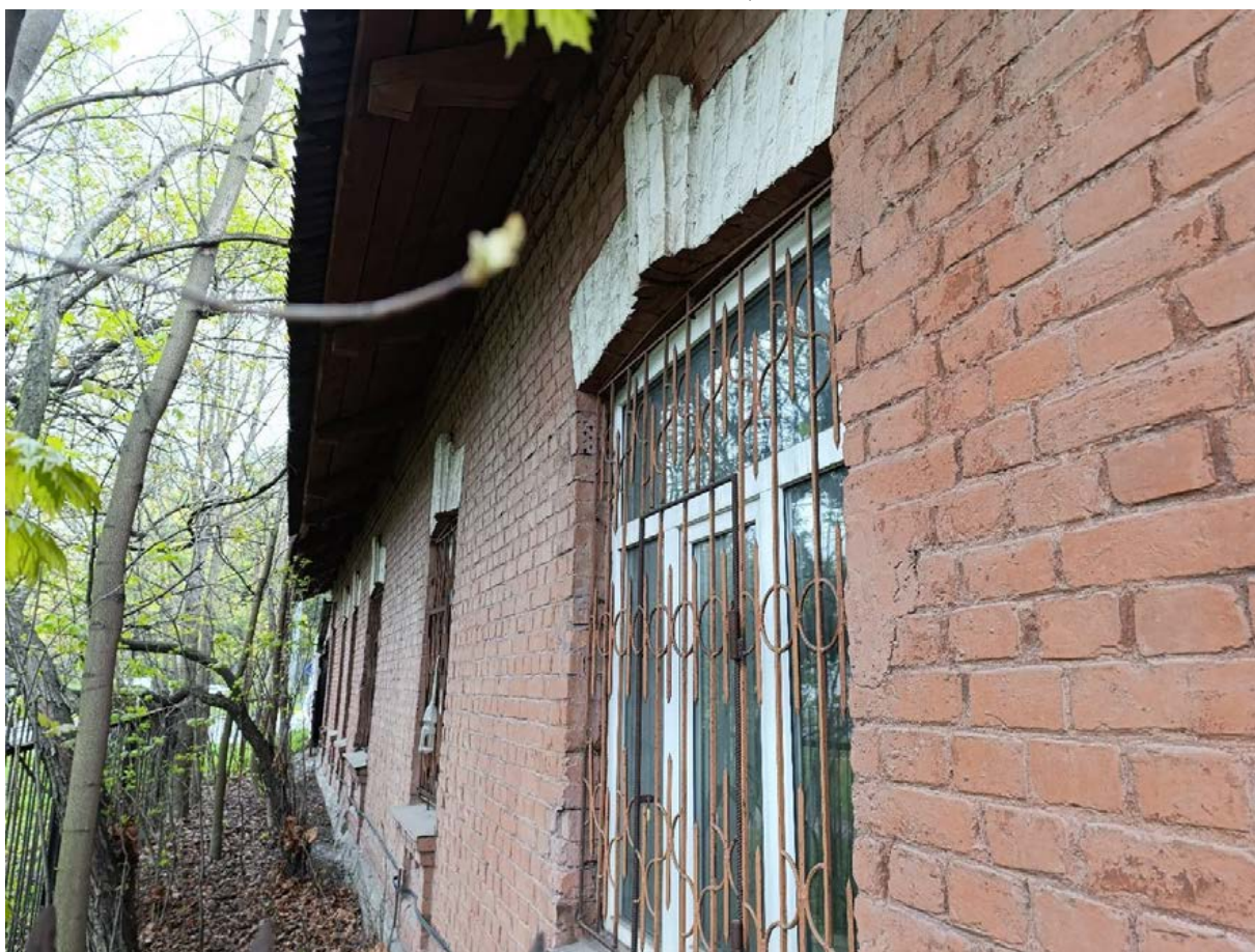
Фото 48. Вид вдоль западного фасада лит. Б.
