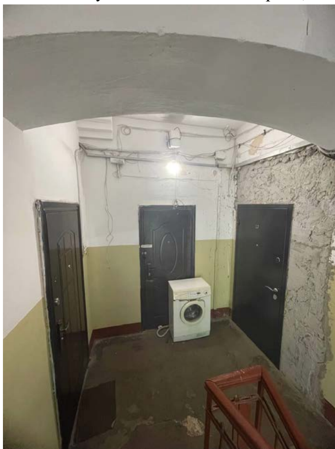
Фото 39. Площадка 2 этажа корп. 3, лит. Б.
