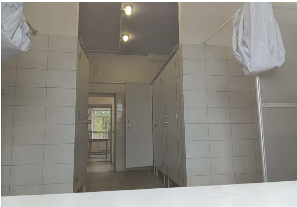
Фото 26. Санузлы 1 этажа в лит. В.
