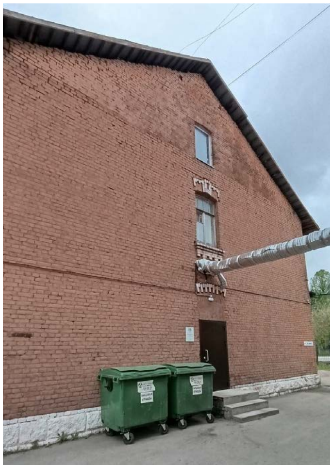
Фото 19. Восточный фасад лит. В.
