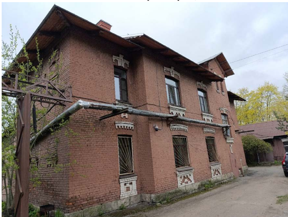
Фото 29. Общий вид корп. 3, лит. Б с северо-востока.
