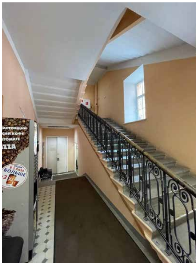
Фото 19. Интерьер лестницы Л-3 выявленного объекта культурного наследия «Городской училищный дом им. Н.В. Гоголя»
