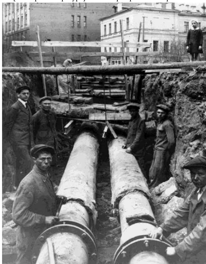
15. Строительство тепловой сети. 1930 г. — «PastVu» – ретро-фотографии стран и городов [Электронный ресурс]. URL: https://pastvu.com/p/871706 .
