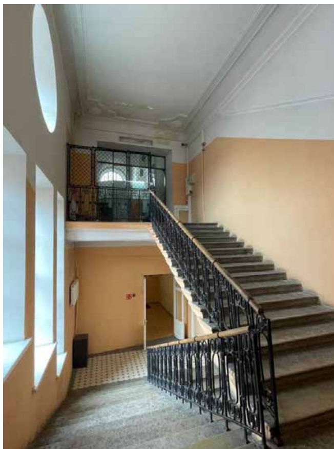
Фото 25. Интерьер лестницы Л-3 выявленного объекта культурного наследия «Городской училищный дом им. Н.В. Гоголя»
