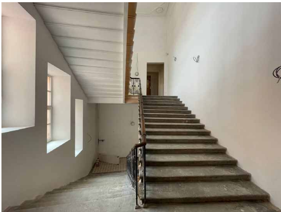
Фото 34. Интерьер лестницы Л-4 выявленного объекта культурного наследия «Городской училищный дом им. Н.В. Гоголя»
