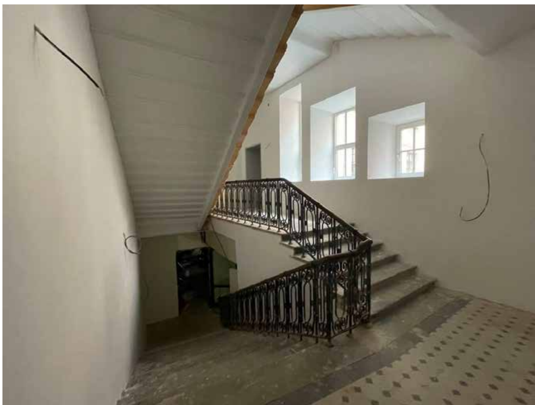
Фото 26. Интерьер лестницы Л-4 выявленного объекта культурного наследия «Городской училищный дом им. Н.В. Гоголя»
