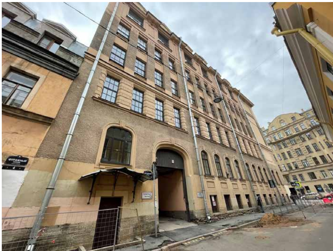
Фото 4. Лицевой фасад выявленного объекта культурного наследия «Городской училищный дом им. Н.В. Гоголя» (по Фуражному пер.)
