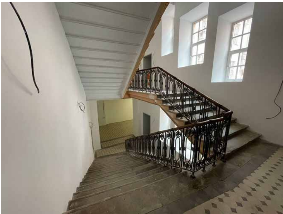
Фото 29. Интерьер лестницы Л-4 выявленного объекта культурного наследия «Городской училищный дом им. Н.В. Гоголя»
