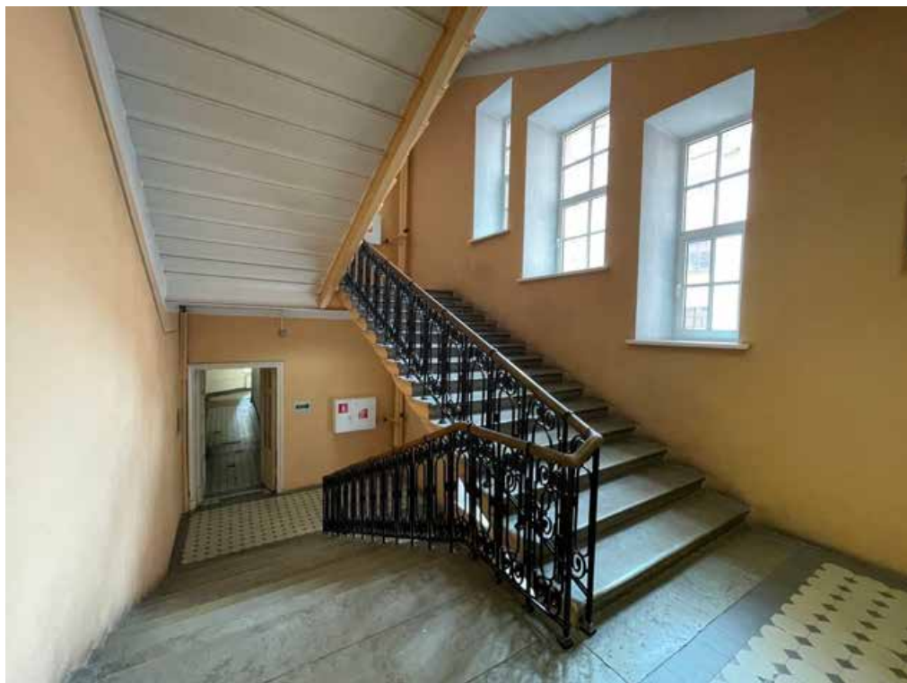
Фото 23. Интерьер лестницы Л-3 выявленного объекта культурного наследия «Городской училищный дом им. Н.В. Гоголя»
