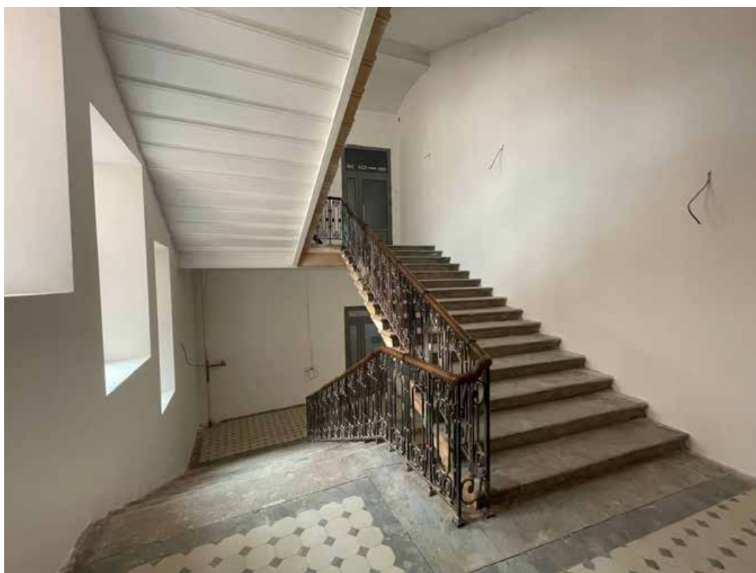
Фото 32. Интерьер лестницы Л-4 выявленного объекта культурного наследия «Городской училищный дом им. Н.В. Гоголя»
