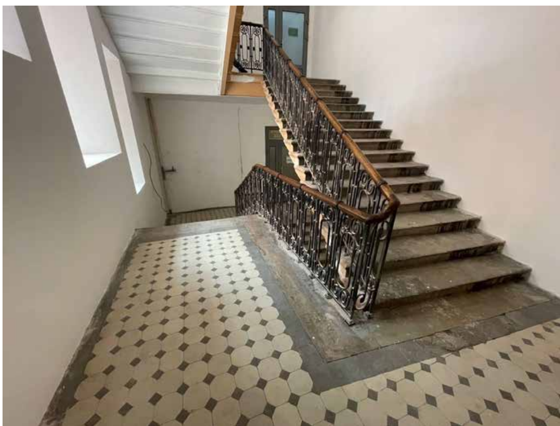
Фото 30. Интерьер лестницы Л-4 выявленного объекта культурного наследия «Городской училищный дом им. Н.В. Гоголя»
