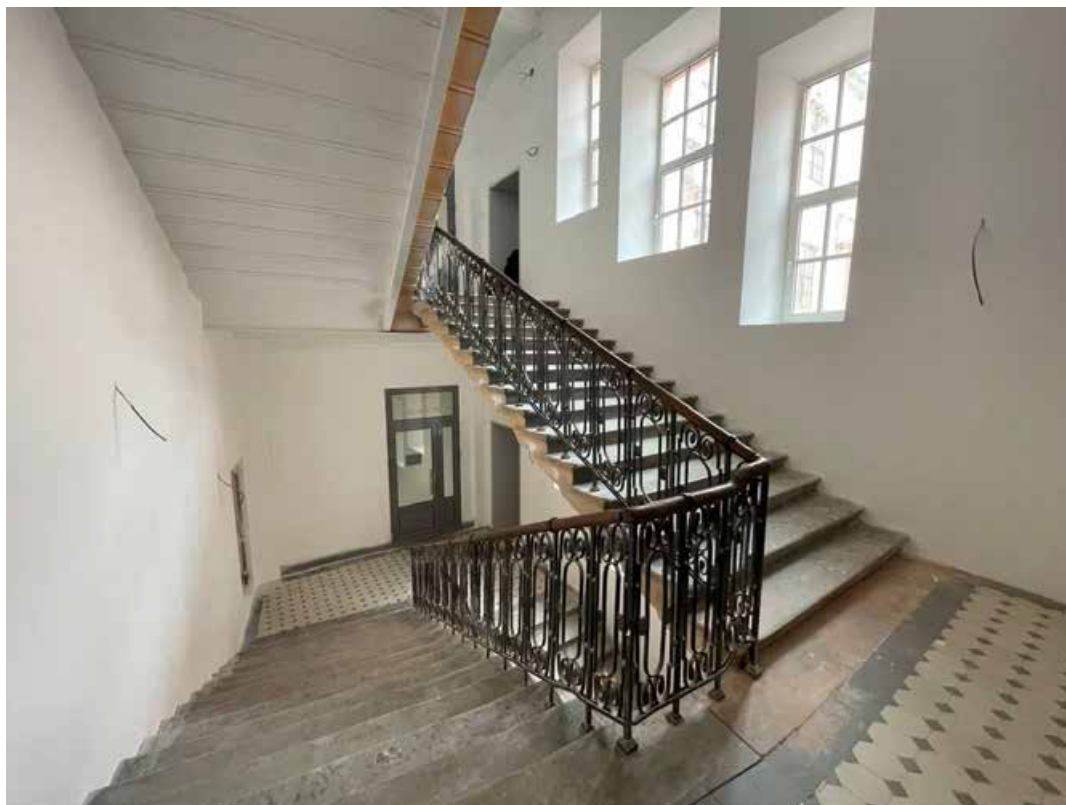
Фото 33. Интерьер лестницы Л-4 выявленного объекта культурного наследия «Городской училищный дом им. Н.В. Гоголя»
