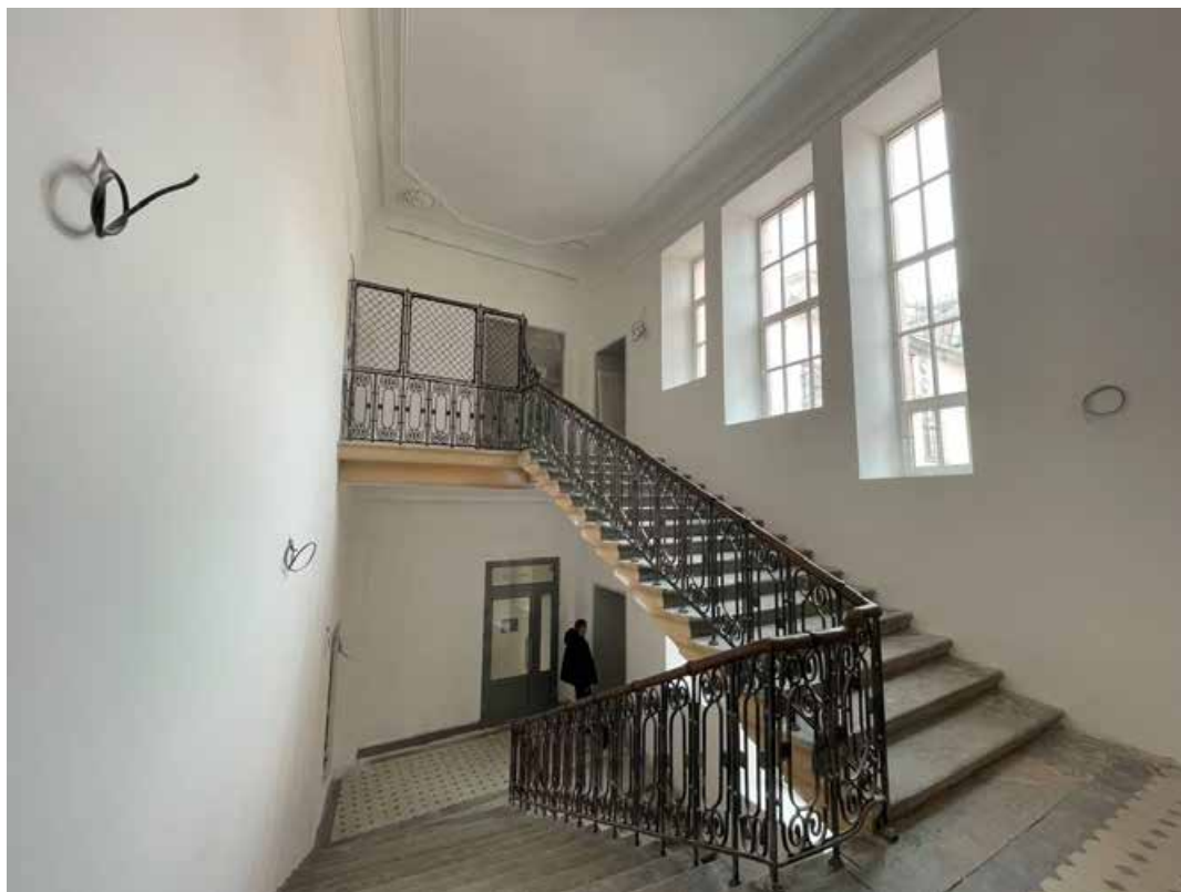
Фото 35. Интерьер лестницы Л-4 выявленного объекта культурного наследия «Городской училищный дом им. Н.В. Гоголя»
