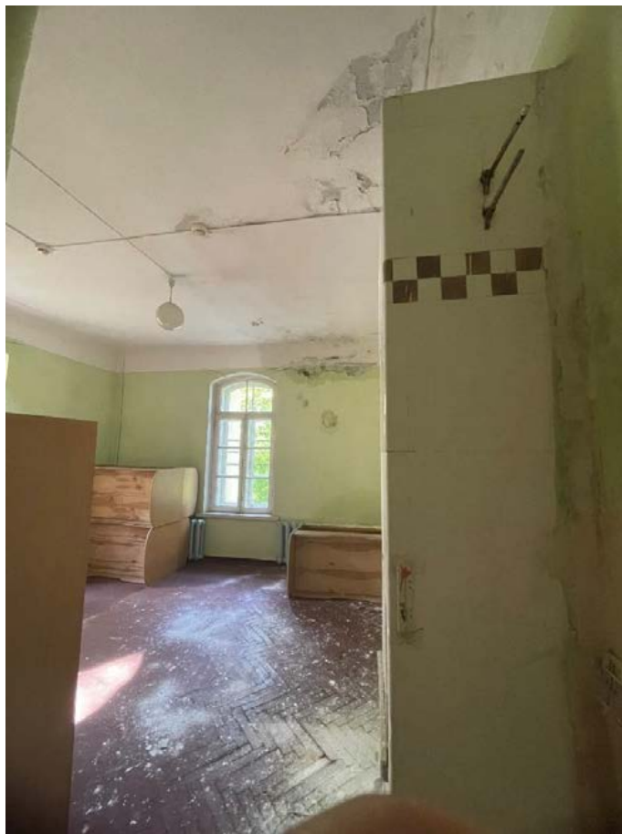
Фото 52. Второй этаж Помещение 1.
