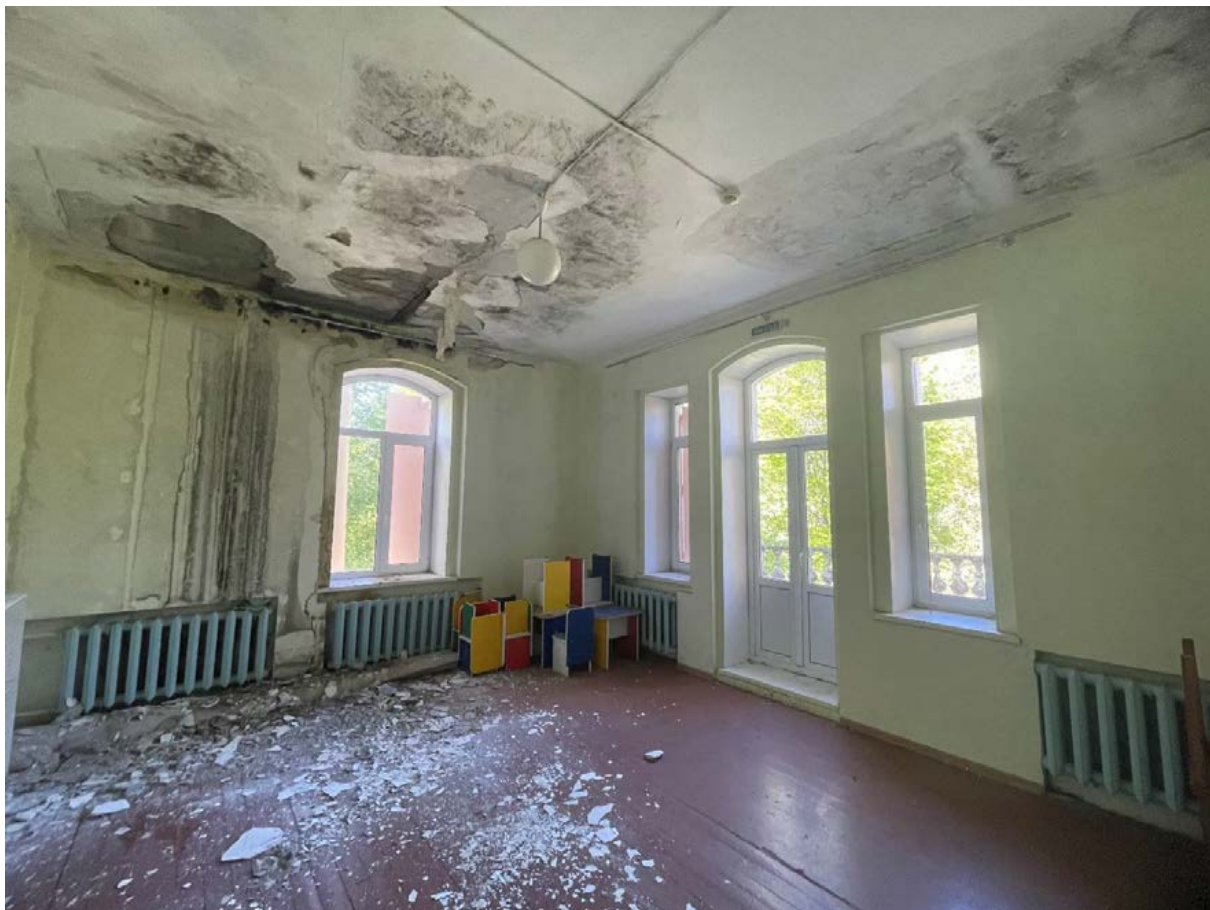
Фото 56. Второй этаж. Помещение 3.
