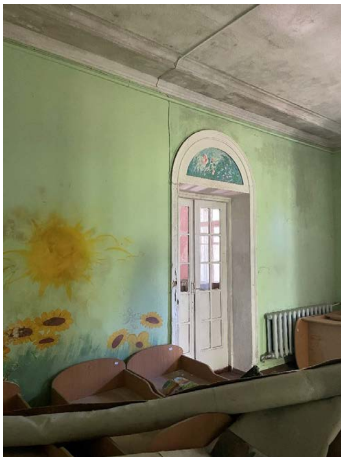
Фото 42. Первый этаж. Вид на вход в помещение 3.
