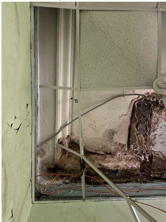
Фото 39. Первый этаж. Оформление потолка в помещении 9.
