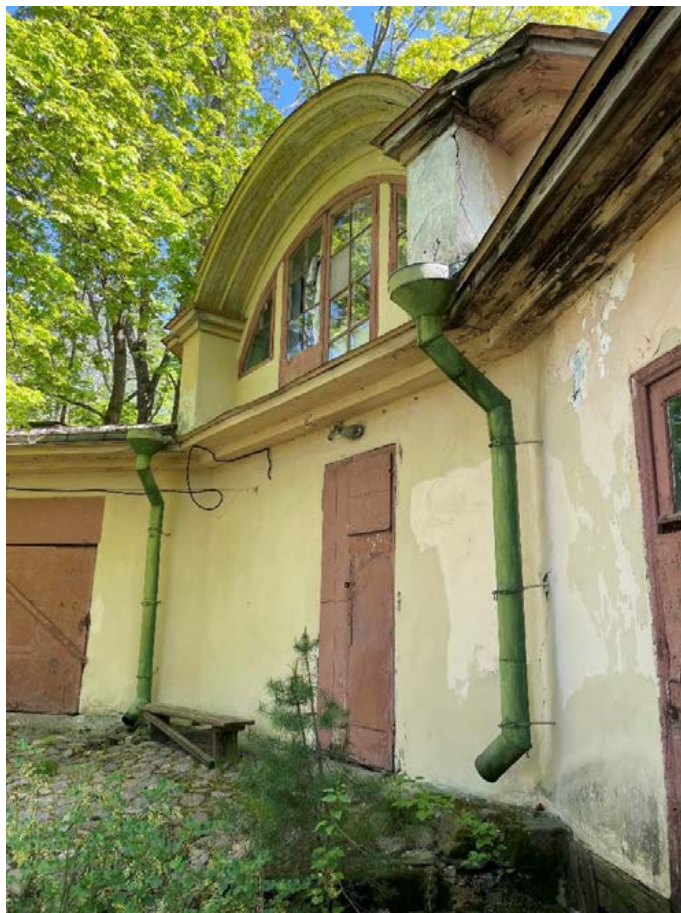
Фото 62. Фрагмент западного фасада, центральный угол.
