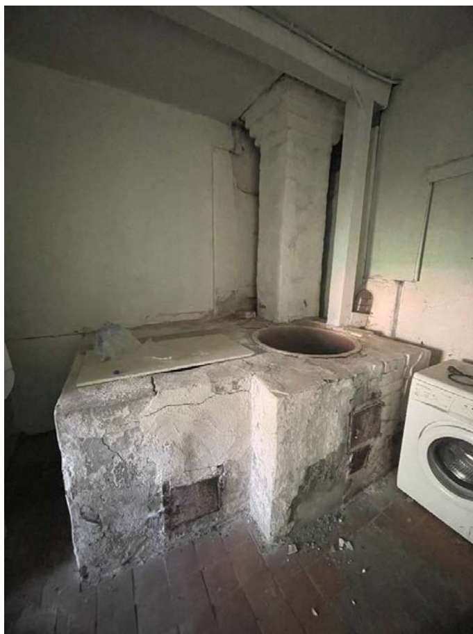
Фото 72. Западная часть, помещение 3.
