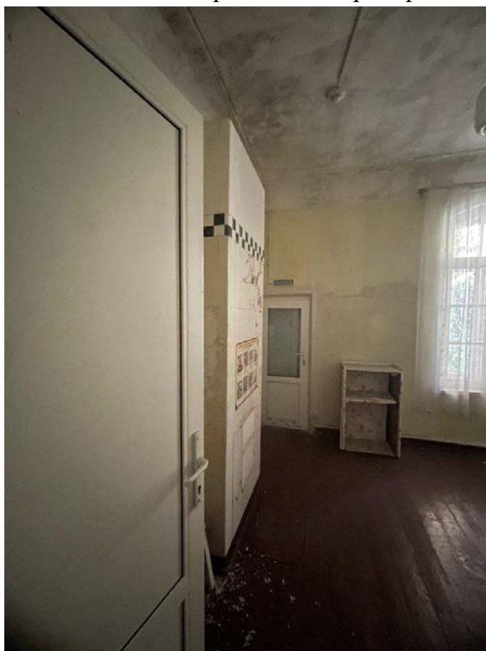
Фото 55. Второй этаж. Помещение 4.
