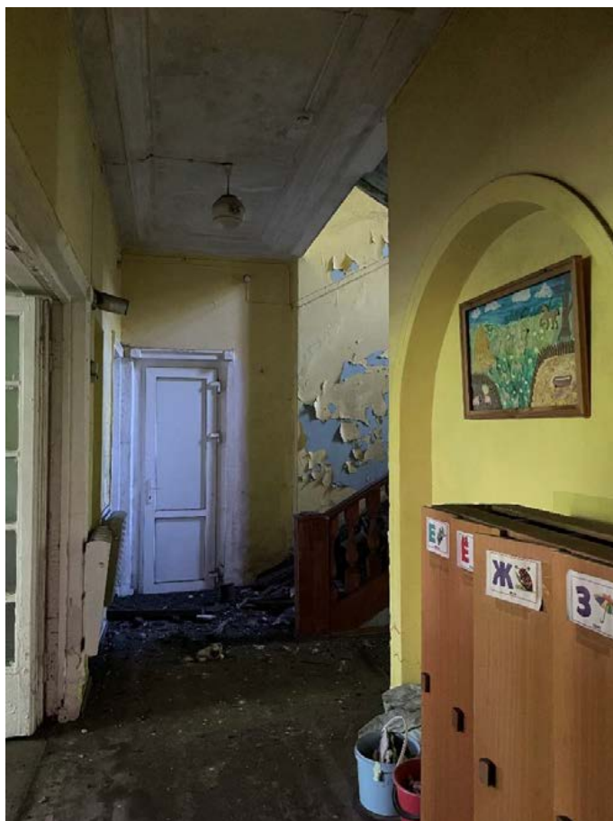
Фото 40. Первый этаж. Помещение 7, коридор.
