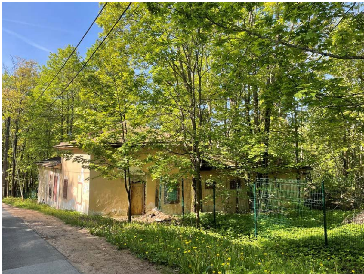
Фото 7. Вид на северо-западный угол объекта, лит. Б.
