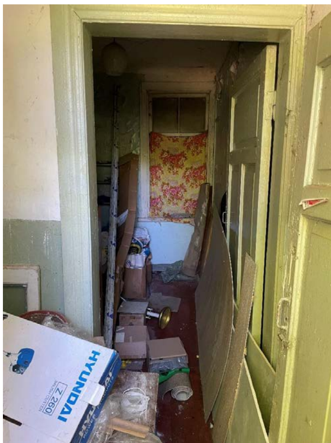
Фото 69. Южная часть. Помещение 3.
