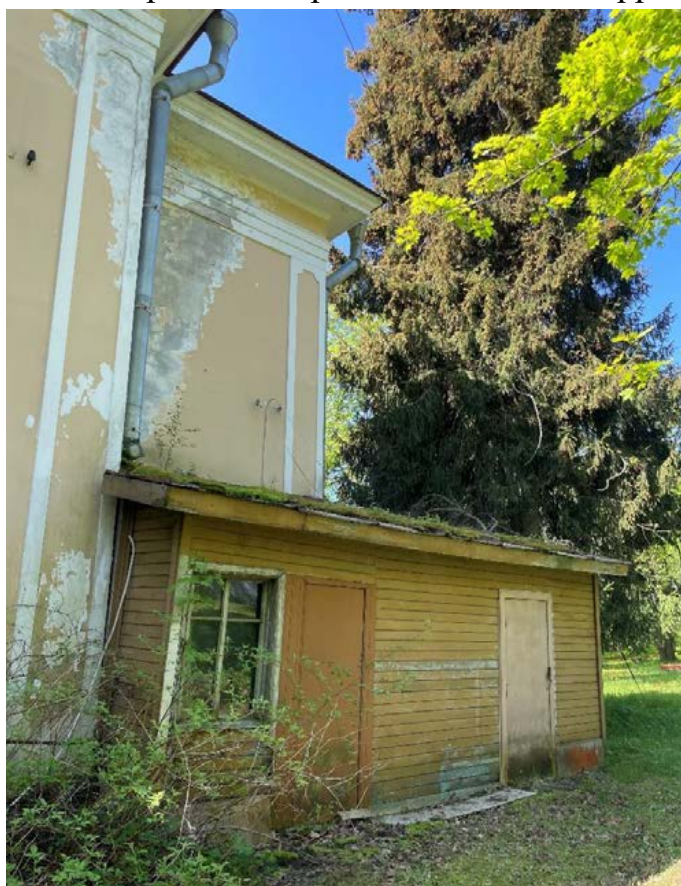
Фото 31. Пристройка в северо-западной части.
