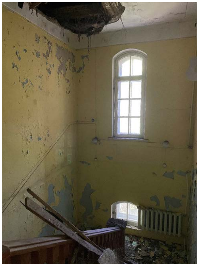
Фото 50. Лестница общий вид со второго этажа.
