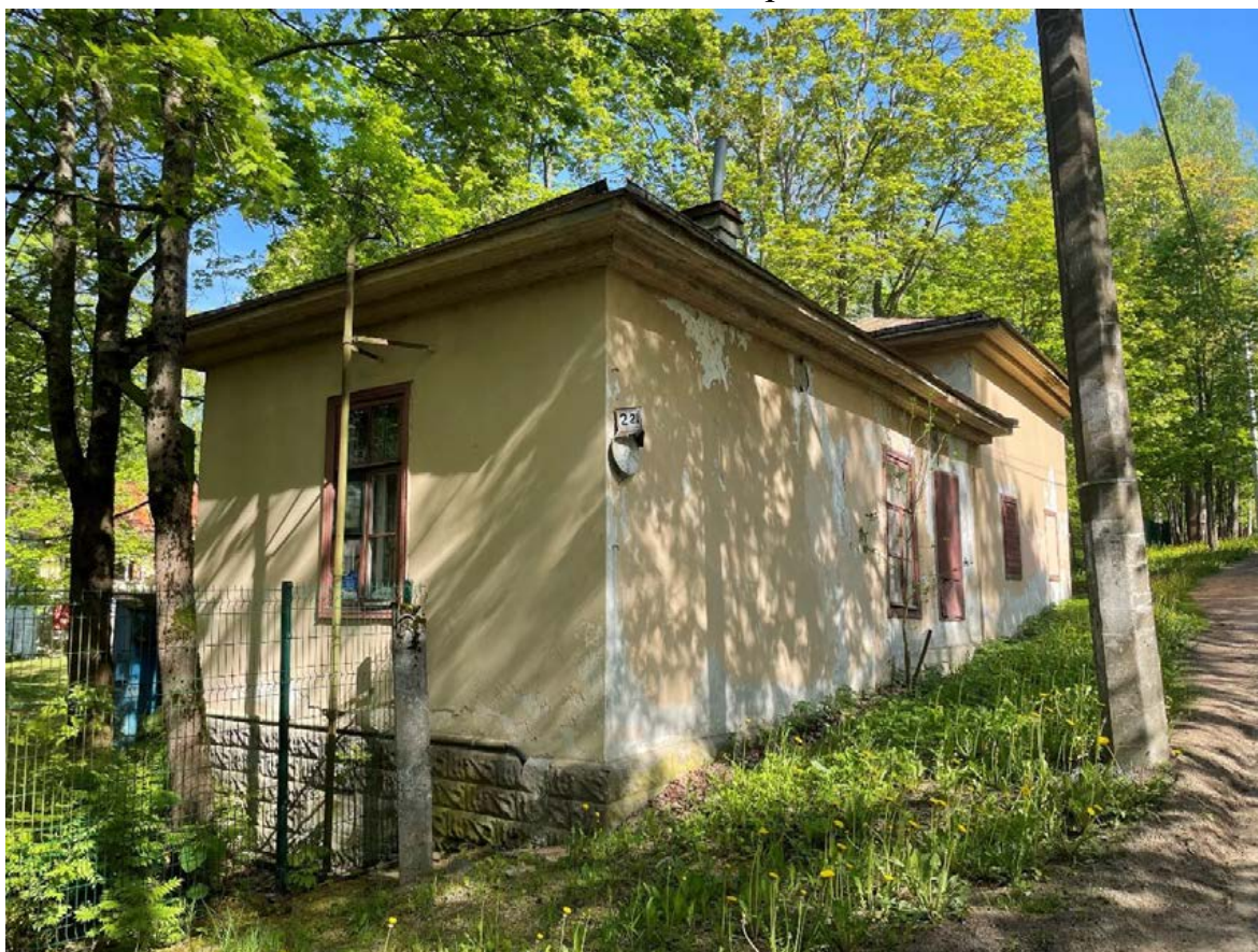
Фото 61. Общий вид с юго-востока.
