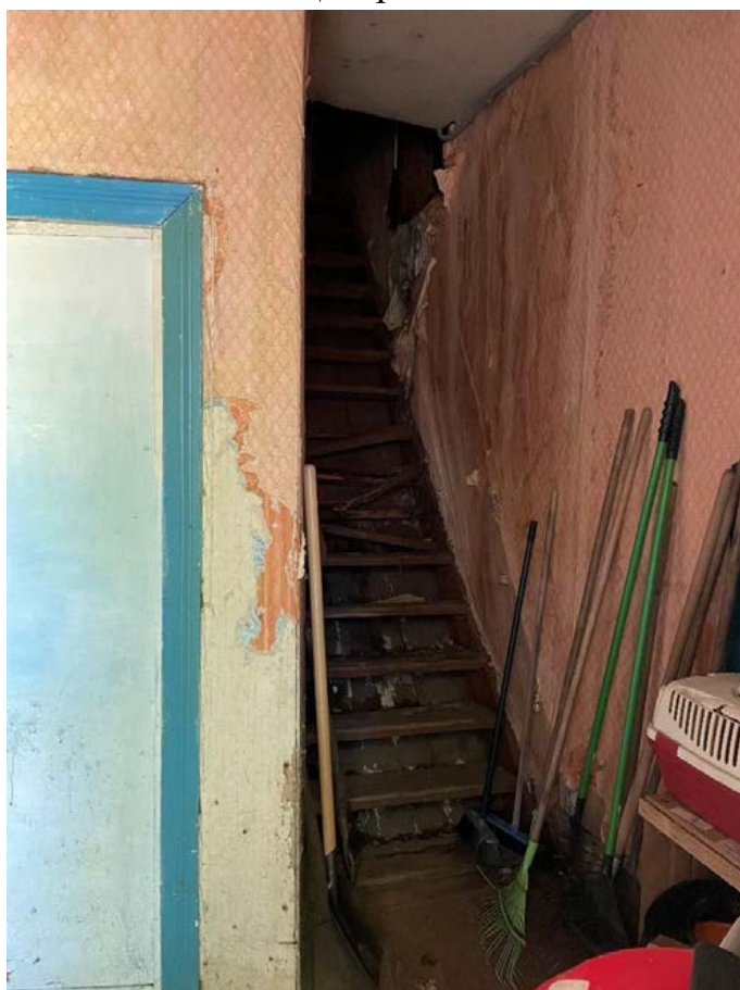
Фото 71. Центральная часть лестница на мансарду.
