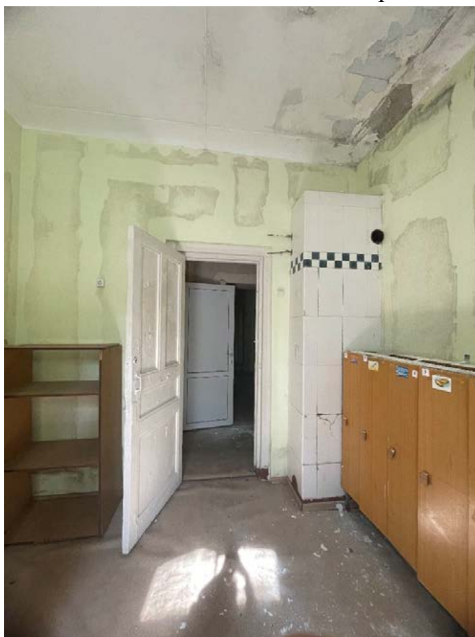
Фото 51. Второй этаж. Помещение 13.
