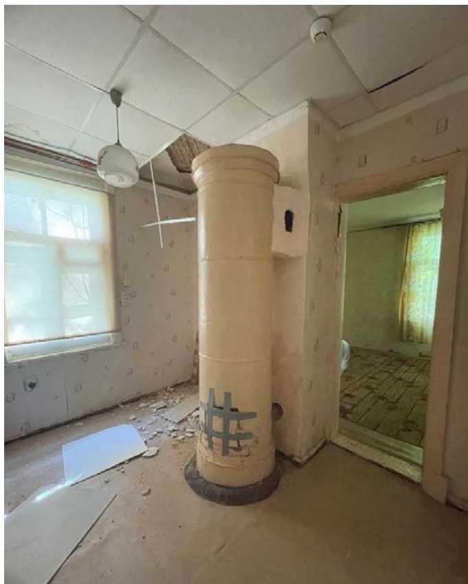
Фото 67. Южная часть. Помещение 2.
