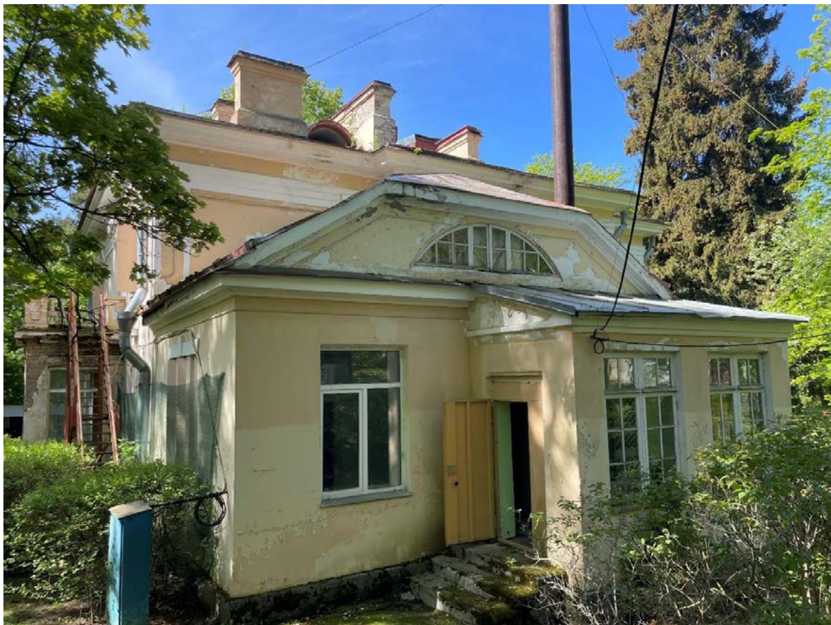
Фото 32. Общий вид северного фасада.
