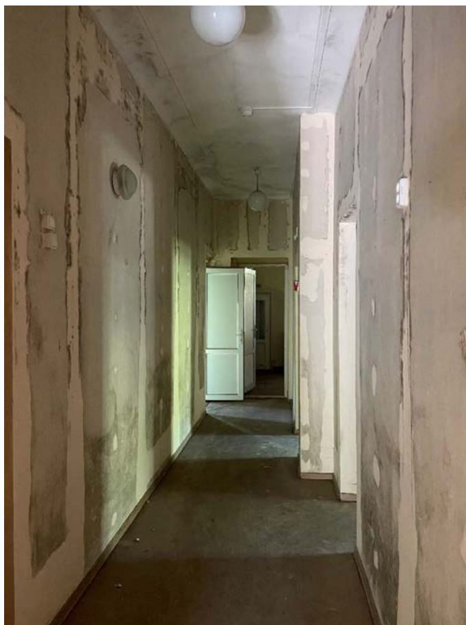
Фото 54. Второй этаж. Коридор.
