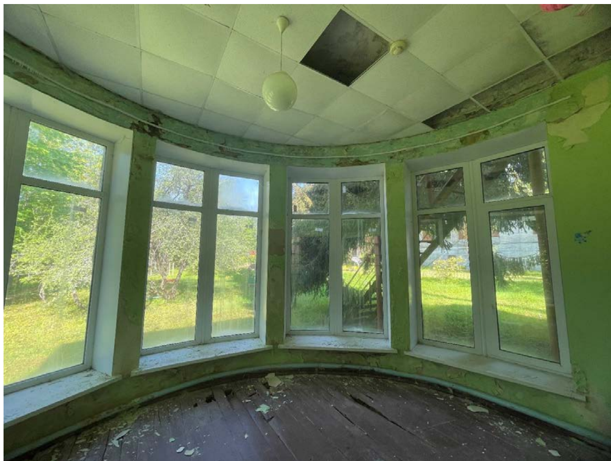
Фото 46. Первый этаж. Помещение ризалита.
