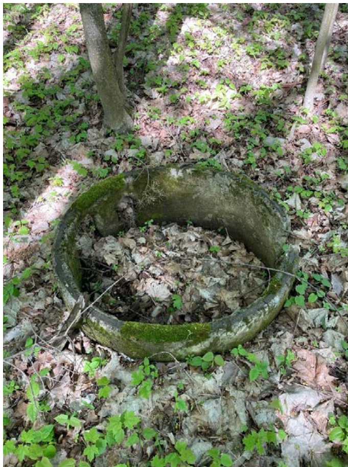
Фото 23. Фрагмент сооружения в юго-восточной части территории объекта.
