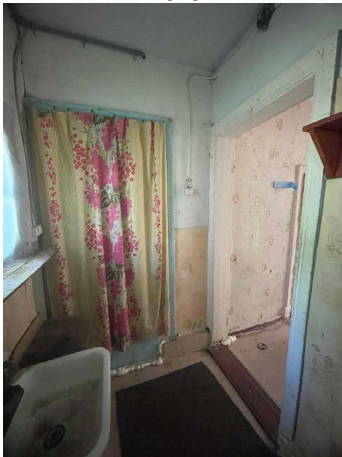
Фото 66. Южная часть. Помещение 5.
