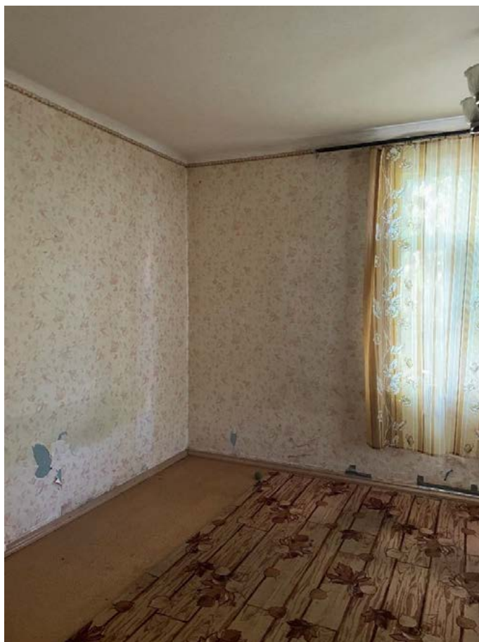
Фото 68. Южная часть. Помещение 1.
