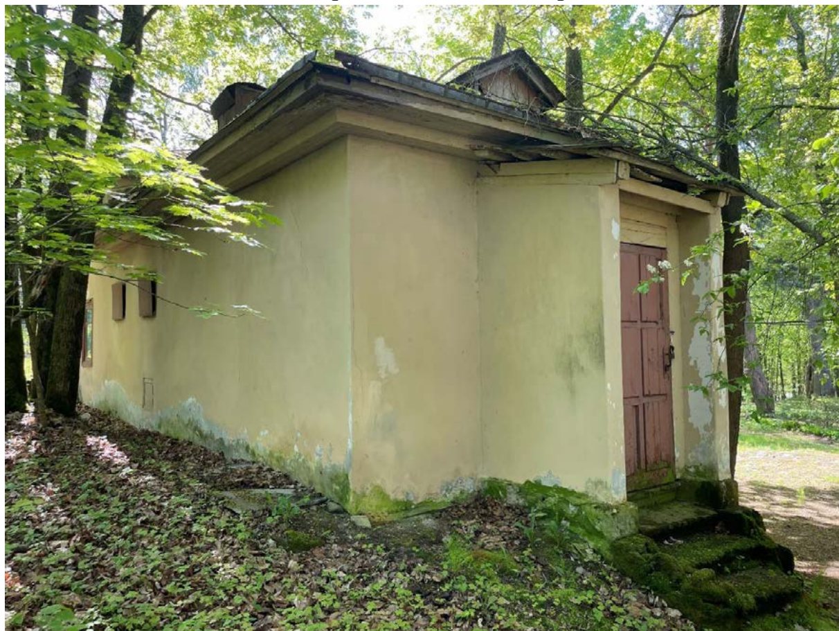
Фото 65. Общий вид с северо-запада.
