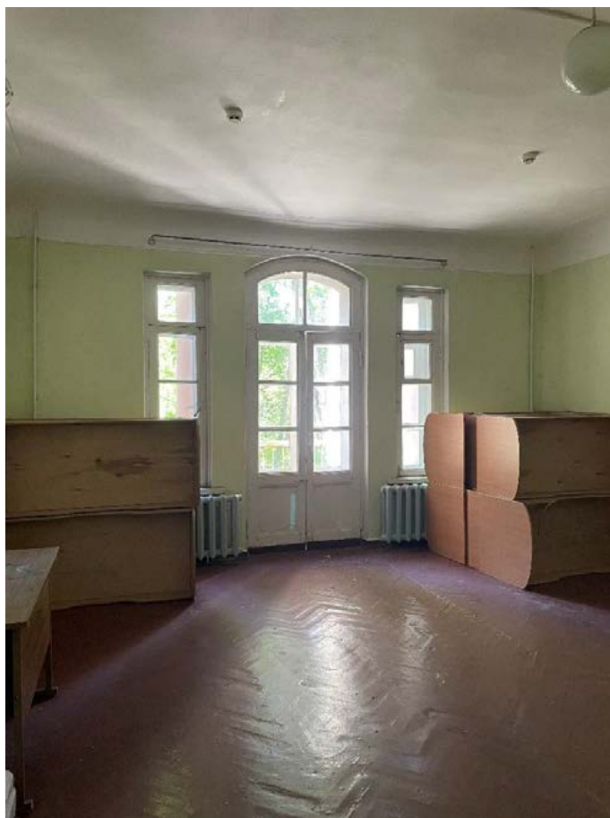
Фото 58. Второй этаж. Помещение 2.
