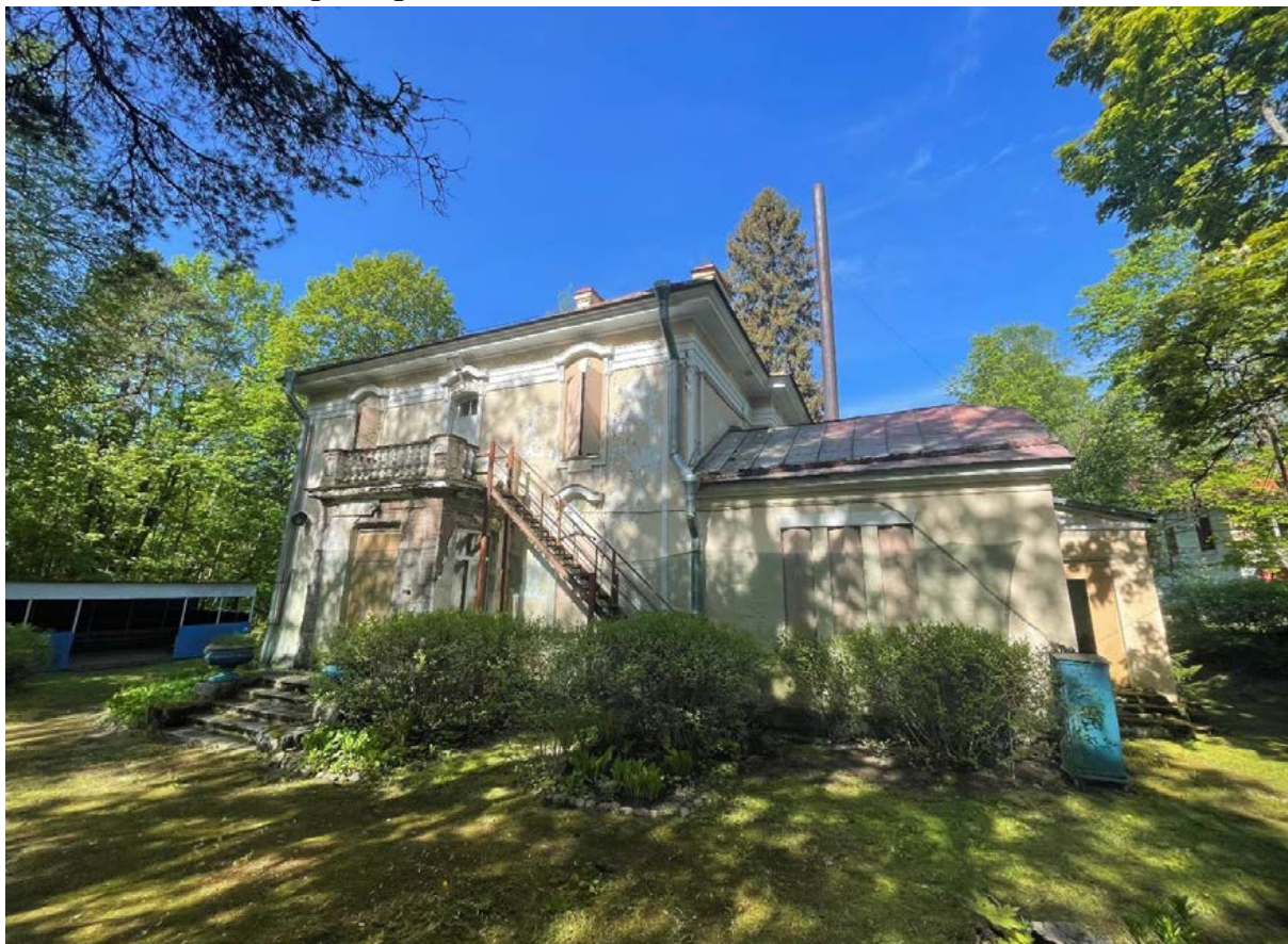
Фото 25. Восточный фасад, вид с северо-востока.
