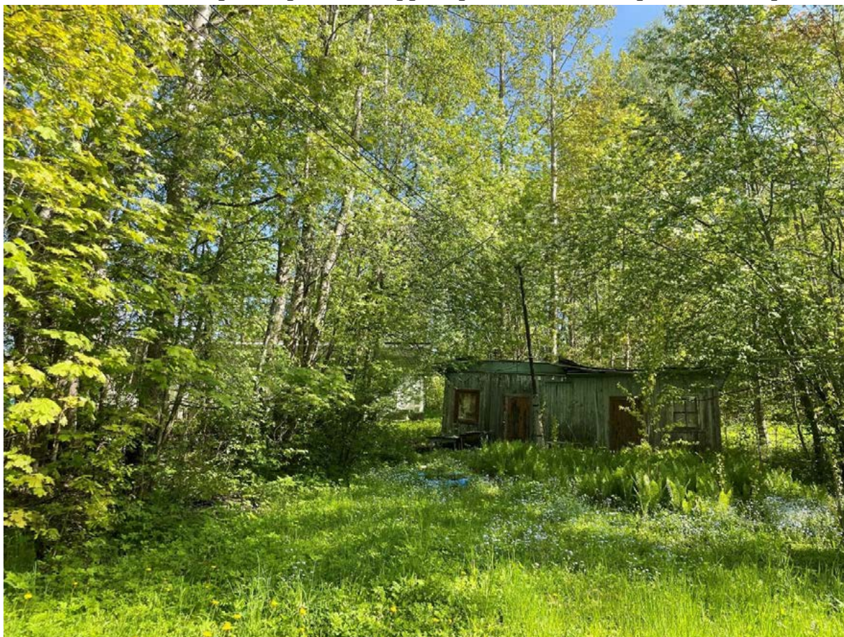
Фото 12. Вид на строения на северо-западе объекта.
