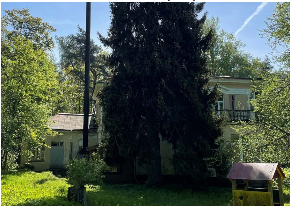
Фото 33. Общий вид западного фасада, перекрыт насаждениями.
