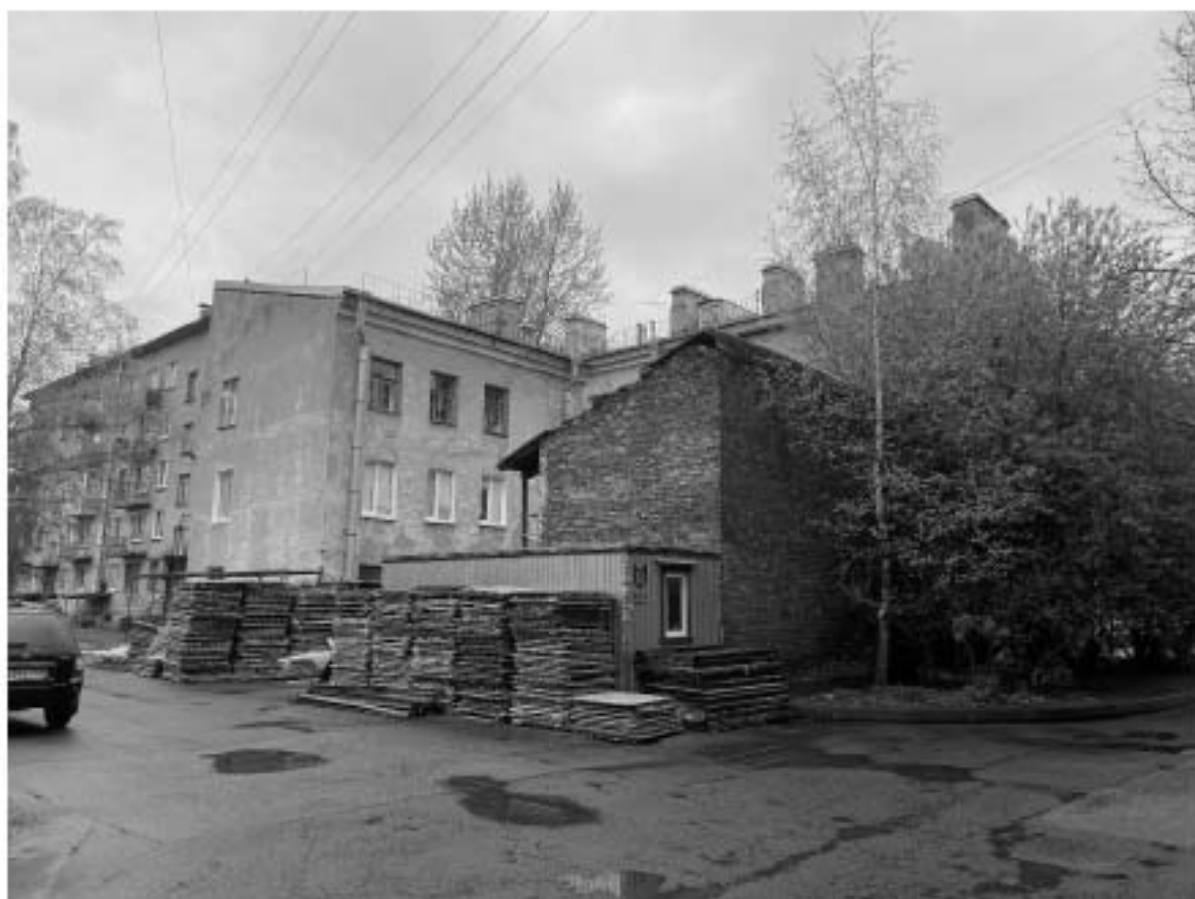
Фото 6. Вид на дворовые фасады
