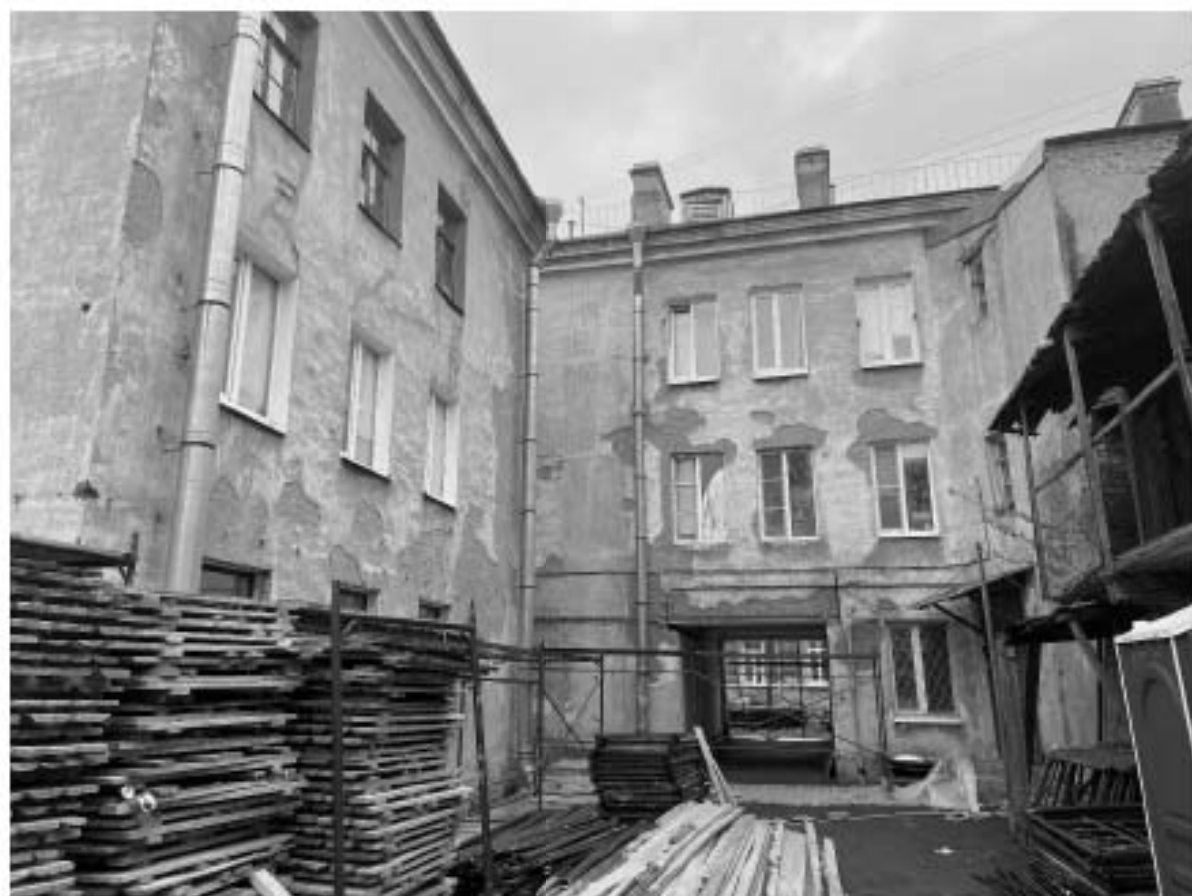
Фото 7. Вид на дворовые фасады
