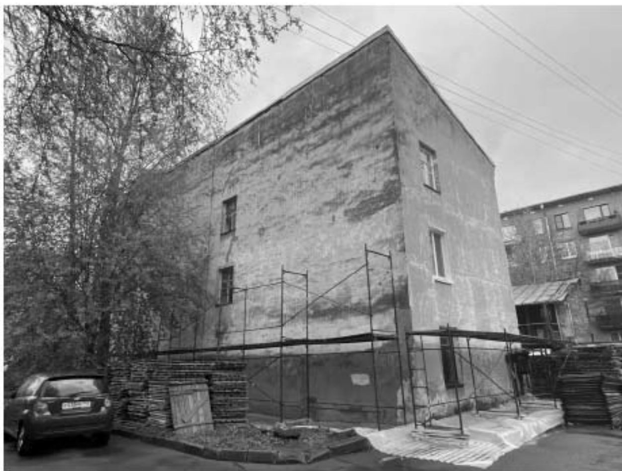
Фото 10. Торцевой и дворовый фасады дома № 4 по улице Гусева.
