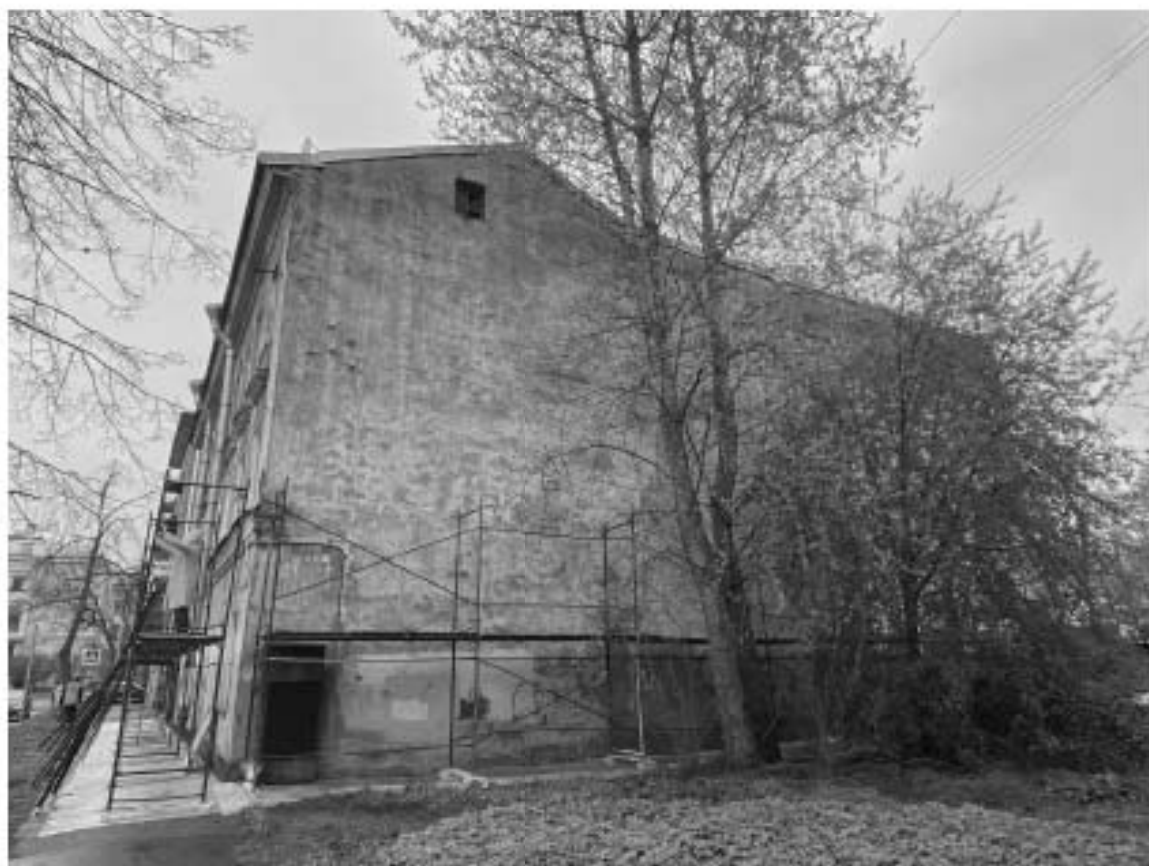
Фото 2. Торцевой фасад дома № 4 по улице Гусева.
