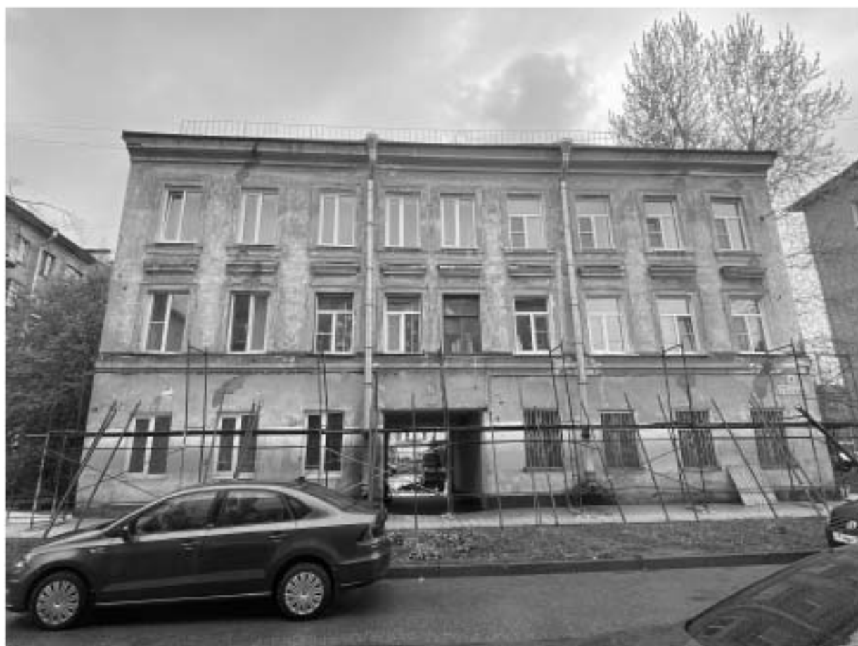
Фото 3. Лицевой фасад дома № 4 по улице Гусева.
