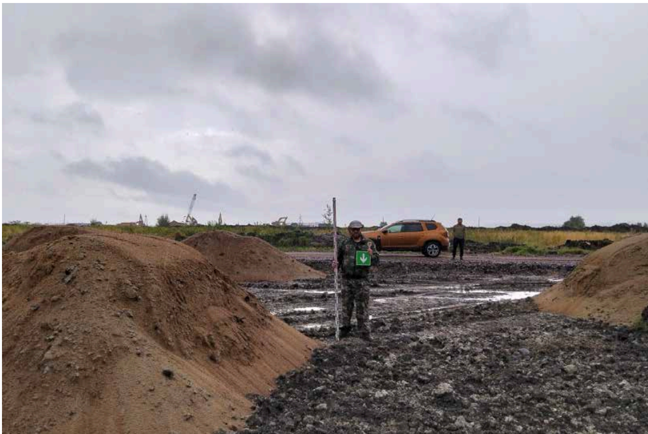
Рис. 26. Санкт-Петербург, пос. Шушары, ул. Школьная, ЗУ 30 (дом 181, литера А по Школьной улице), земельный участок с кадастровым номером: 78:42:0015104:4812. Точка фотофиксации 2. Вид с С.
