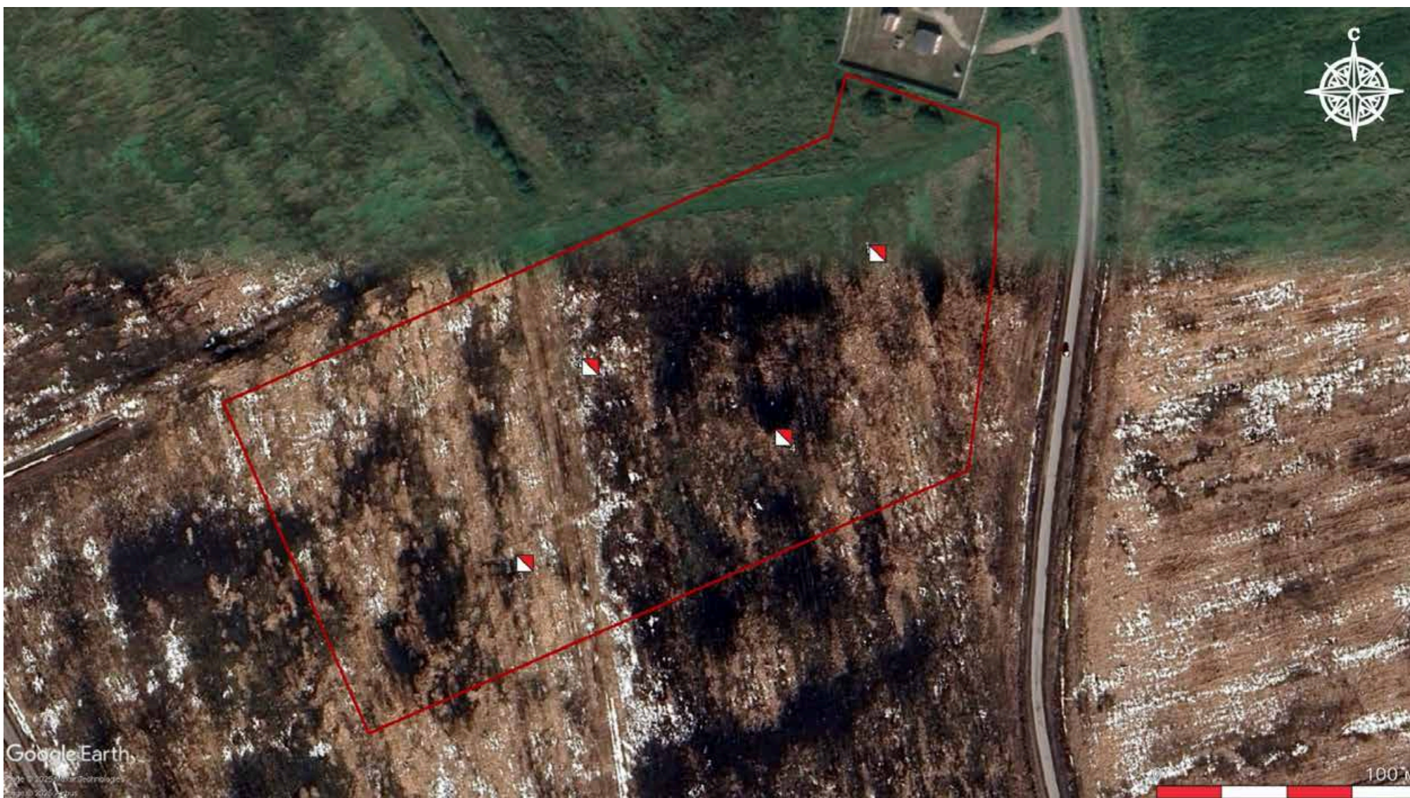
Рис. 16. Санкт-Петербург, пос. Шушары, ул. Школьная, ЗУ 30 (дом 181, литера А по Школьной улице), земельный участок с кадастровым номером: 78:42:0015104:4812. Местоположение шурфа и зачистки на обследованной территории. Использованы данные электронного ресурса https://www.google.ru/maps/ .
