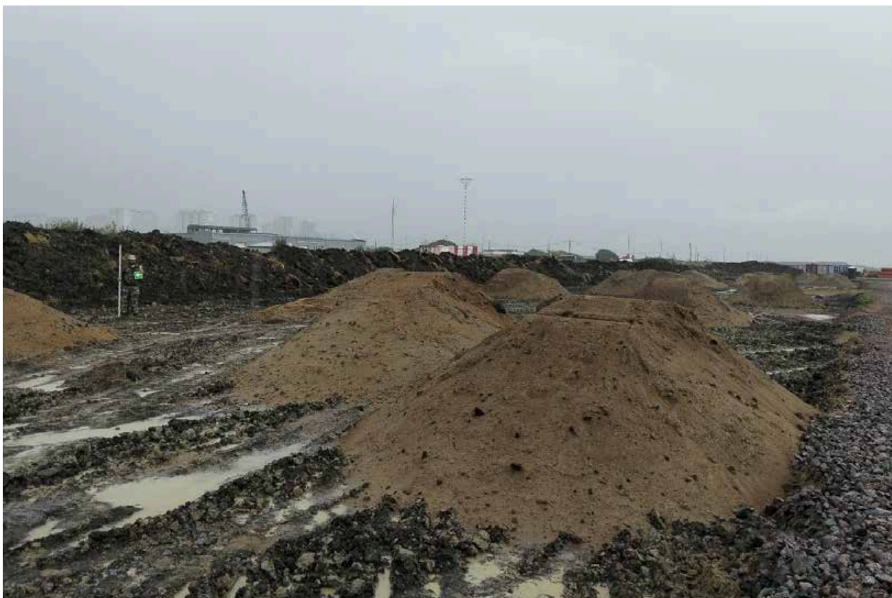
Рис. 25. Санкт-Петербург, пос. Шушары, ул. Школьная, ЗУ 30 (дом 181, литера А по Школьной улице), земельный участок с кадастровым номером: 78:42:0015104:4812. Точка фотофиксации 2. Вид с ЗЮЗ.
