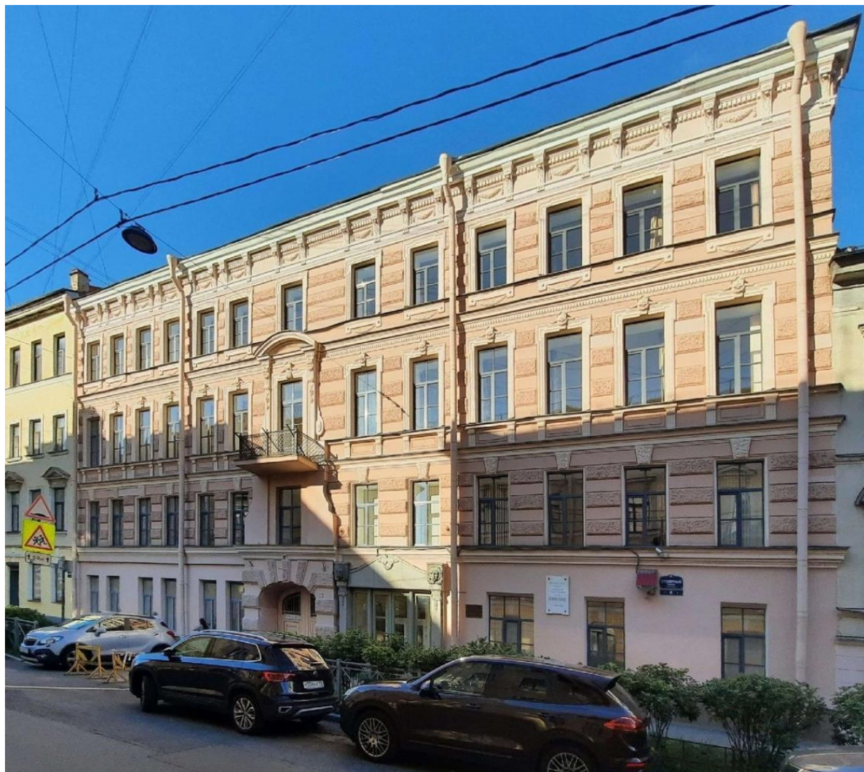
24. Объект культурного наследия федерального значения «Дом, где жили: в 1881-1888 гг. – путешественник Пржевальский Н.М., в 1876-1877 гг. и в 1879-1880 гг. - писатель Успенский Г.И.» по адресу: Санкт-Петербург, Столярный пер., дом 6, литера А (Столярный пер., 6). Общий вид. Фотография. 2022 г. Приведено на: https://www.citywalls.ru/
