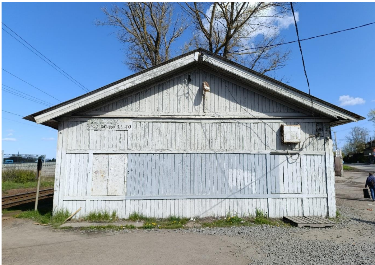
Фото 1. Южный фасад объекта «Железнодорожный вокзал платформы Горская».
