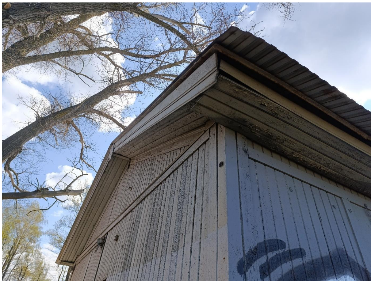
Фото 7. Фрагмент карниза северного и западного фасадов.
