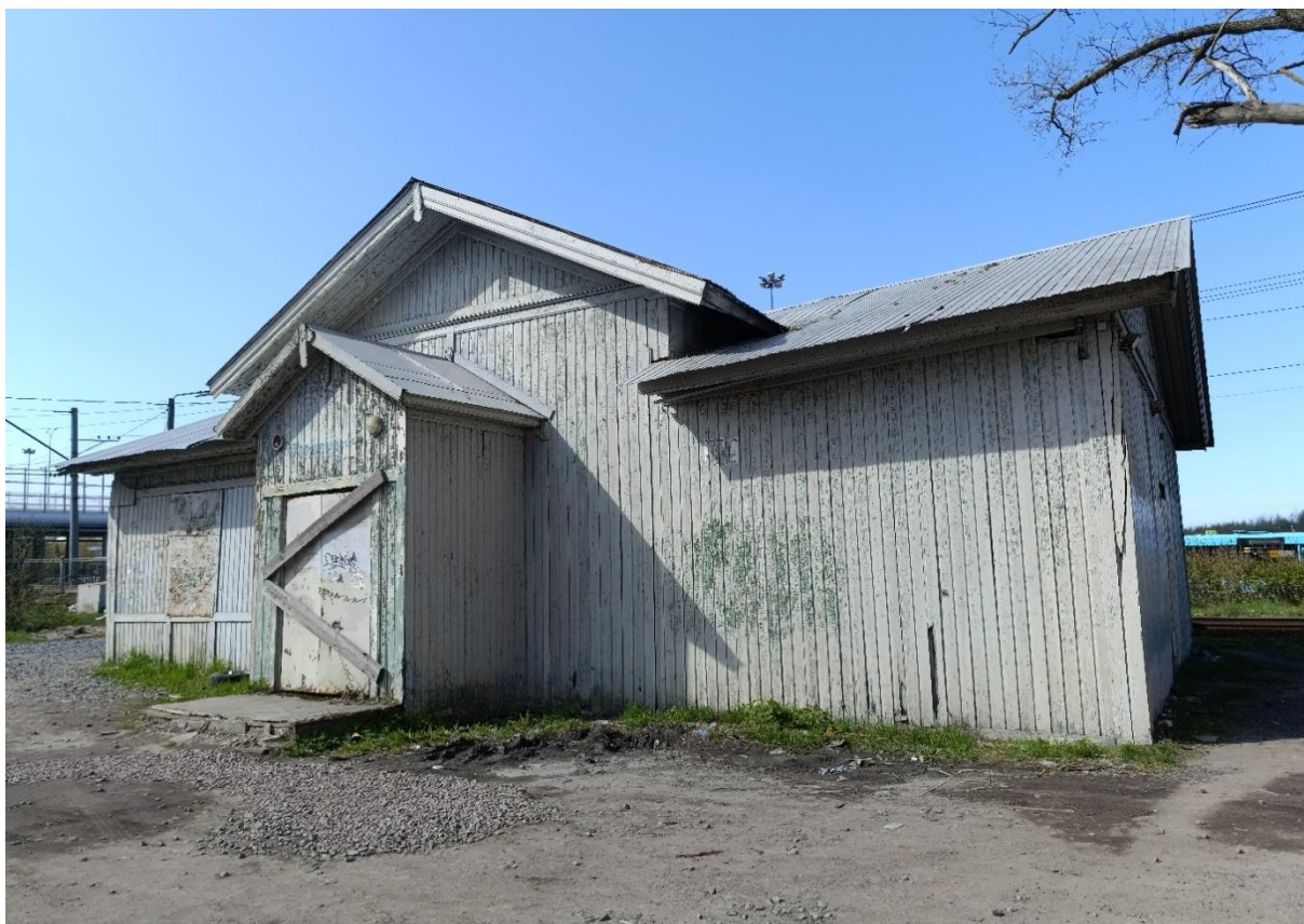
Фото 5. Общий вид объекта с северо-востока.
