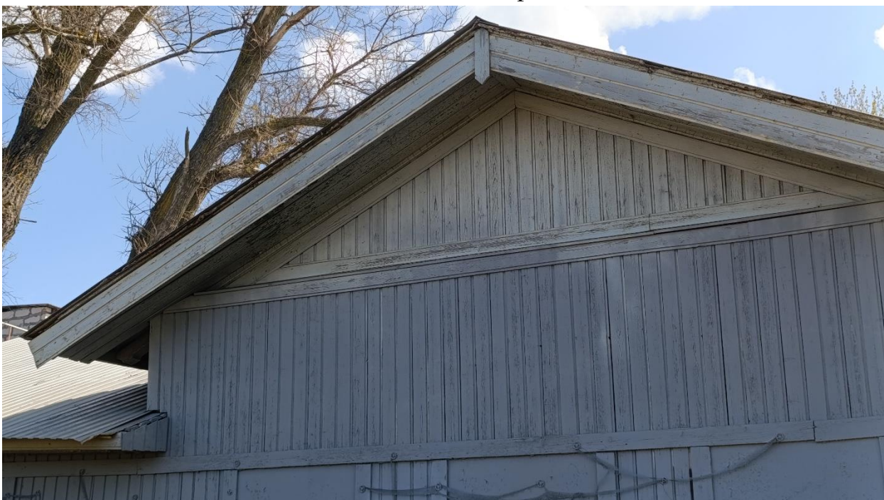
Фото 10. Фрагмент западного фасада, карниз.
