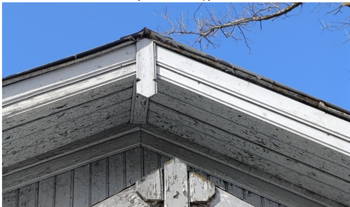
Фото 4. Фрагмент карниза восточного фасада.
