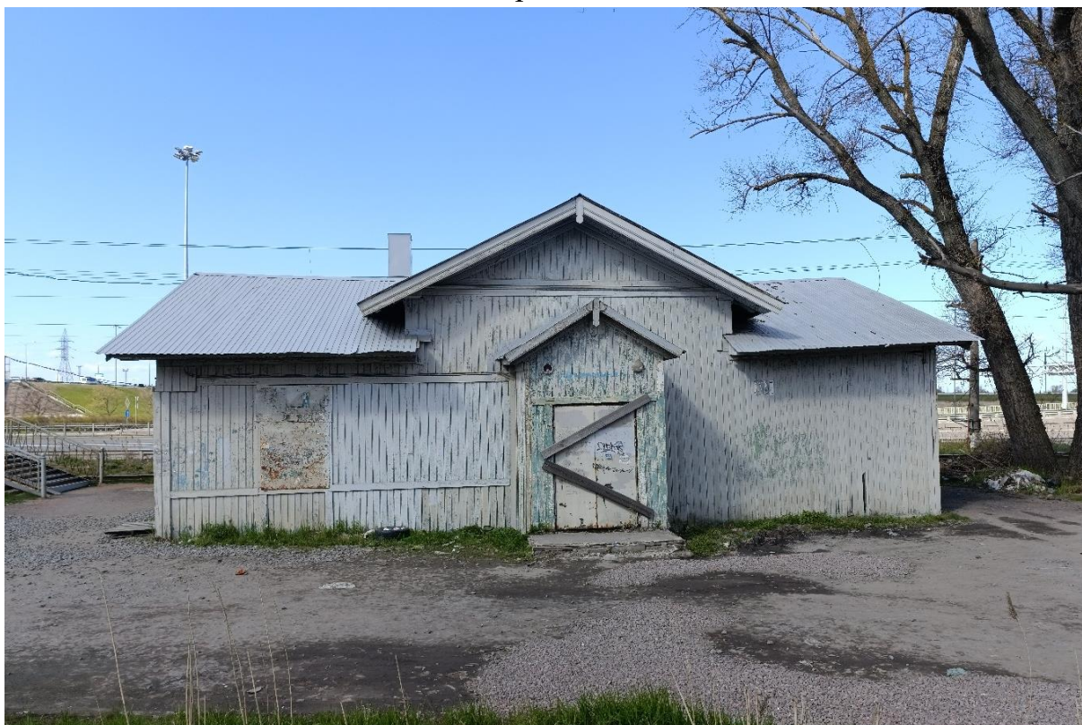
Фото 2. Восточный фасад, общий вид.
