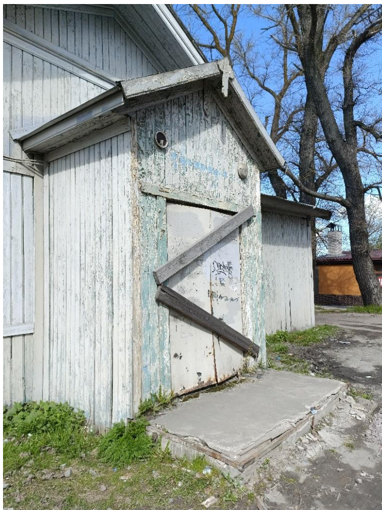
Фото 3. Крыльцо и тамбур с востока.
