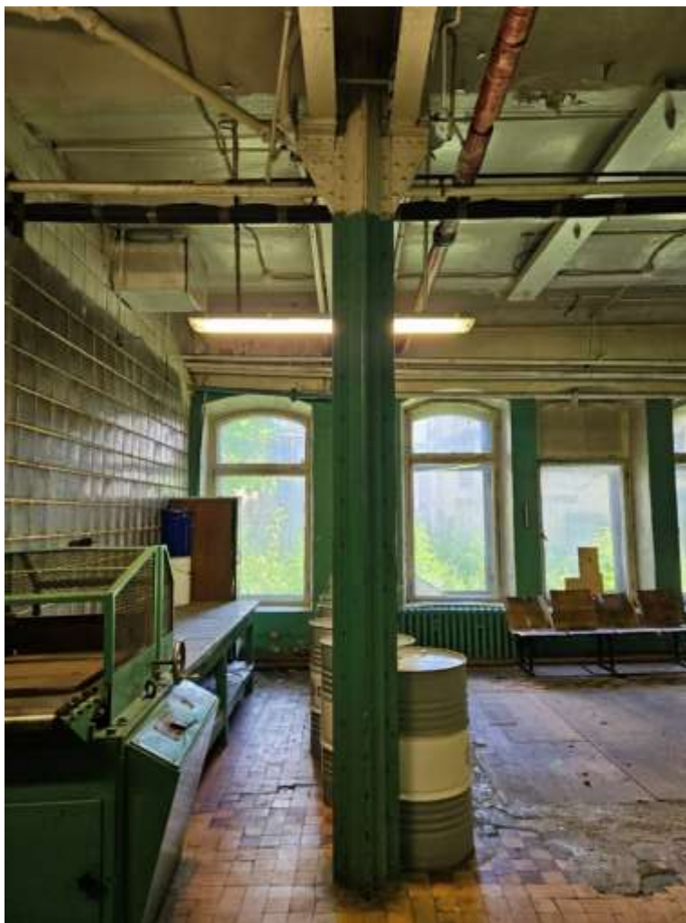
Фото 72. Выявленный объект культурного наследия «Два производственных корпуса». Главный производственный корпус. Металлический клепаный опорный столб в помещении 1-Н (69) 1-го этажа.
