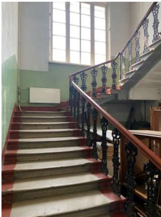
Фото 11. Выявленный объект культурного наследия «Два производственных корпуса». Западный производственный корпус. Трехмаршевая лестница ЛК-3 в южной части
