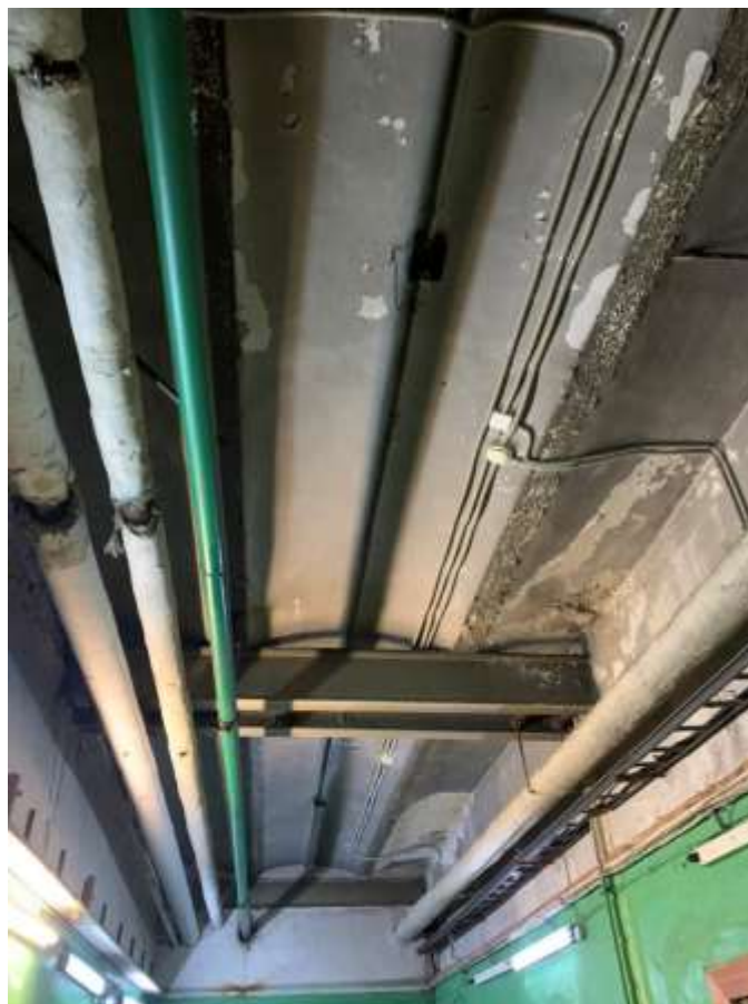
Фото 69. Выявленный объект культурного наследия «Два производственных корпуса». Главный производственный корпус. Своды по балкам («пруссские») в помещении 1-Н (55) 1-го этажа
