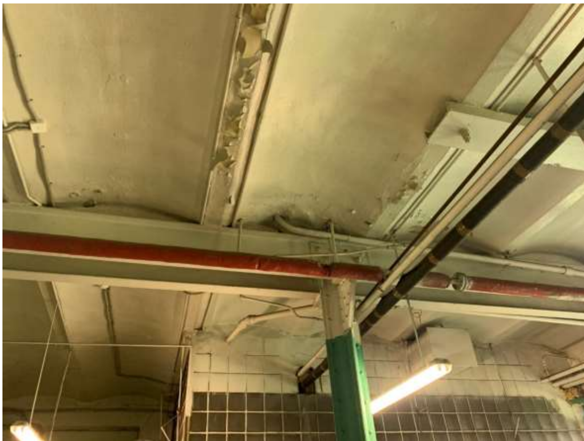
Фото 71. Выявленный объект культурного наследия «Два производственных корпуса». Главный производственный корпус. Своды по балкам («прусские») в помещении 1-Н (69) 1-го этажа.
