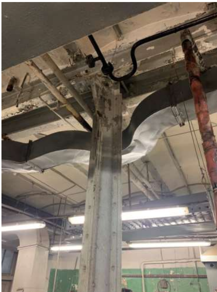
Фото 75. Выявленный объект культурного наследия «Два производственных корпуса». Главный производственный корпус. Металлический клепанный опорный столб и своды по балкам («пруссские») в помещении 1-Н (74) 1-го этажа
