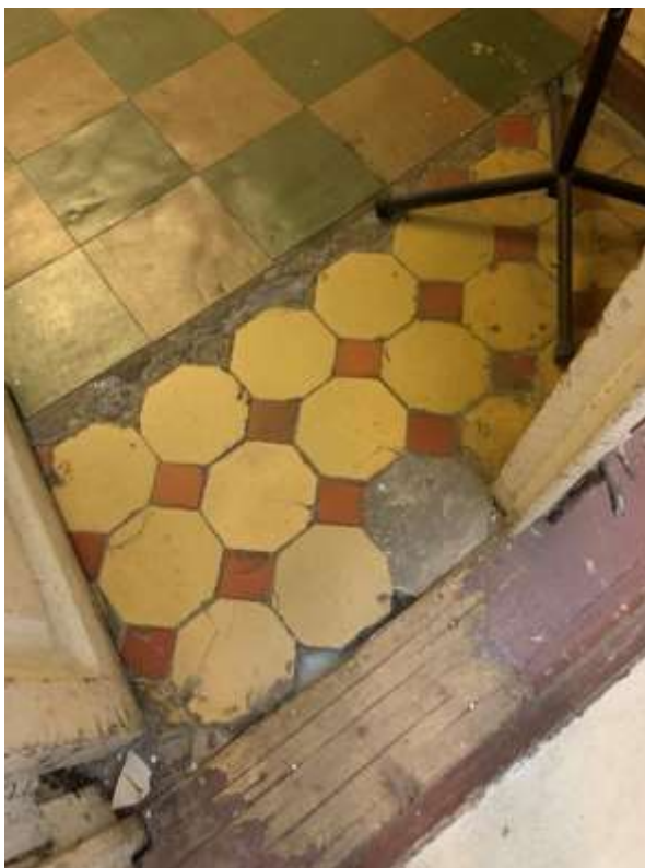
Фото 17. Выявленный объект культурного наследия «Два производственных корпуса». Западный производственный корпус. Покрытие пола метлахской плиткой в помещении 11-Н (2) 1-го этажа
