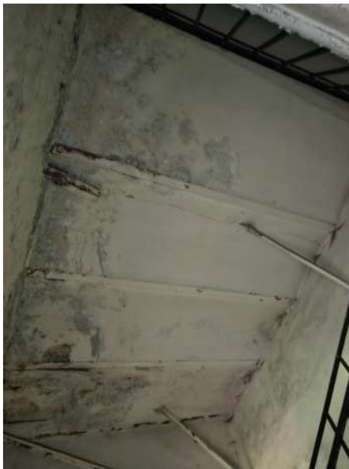
Фото 81. Выявленный объект культурного наследия «Два производственных корпуса». Главный производственный корпус. Своды по балкам («пруссские») над помещением трехмаршевой межэтажной лестница ЛК-1
