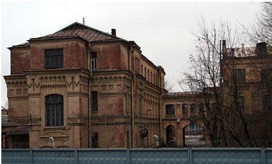
47. Вид западной части главного корпуса Спиртоочистного завода. Фото 2009 г. Источник: CityWalls. URL: https://www.citywalls.ru/photo18090.html
