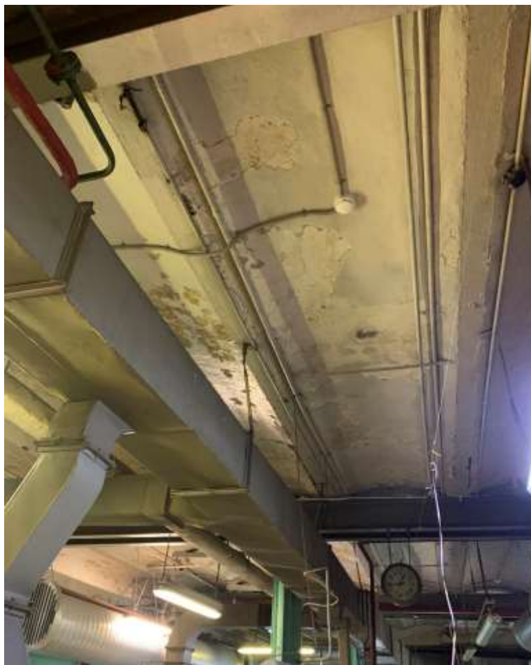
Фото 73. Выявленный объект культурного наследия «Два производственных корпуса». Главный производственный корпус. Своды по балкам («пруссские») в помещении 1-Н (72) 1-го этажа.
