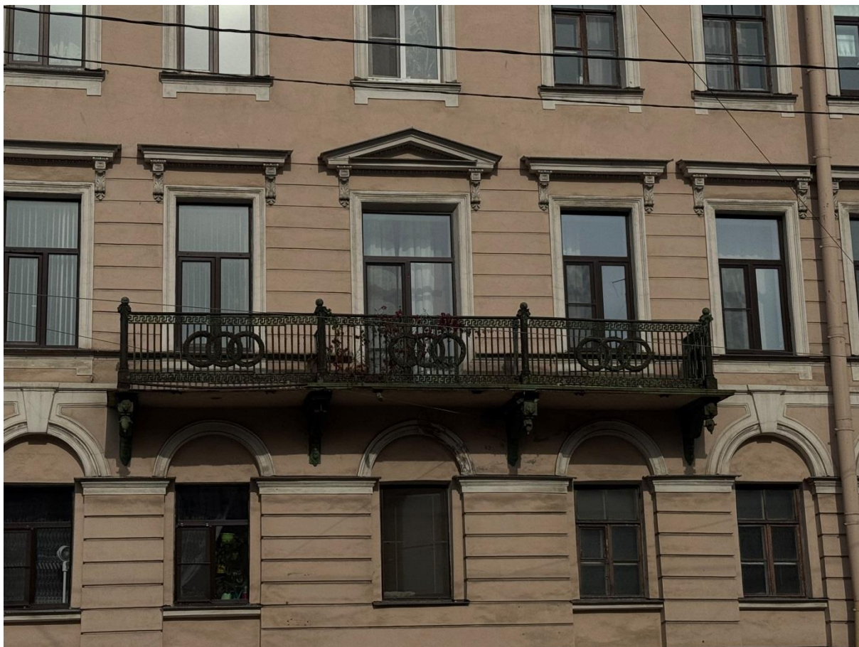
Фот. 2 Фрагмент лицевого фасада, балкон в уровне 3 этажа.
