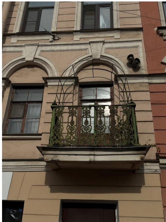
Фот. 8. Балкон на лицевом фасаде над входной группой
