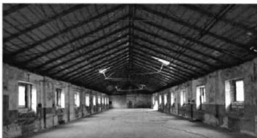
9. «Хлебный амбар» (наб. Обводного кан., 5, лит. А). Металлические фермы перекрытия.
