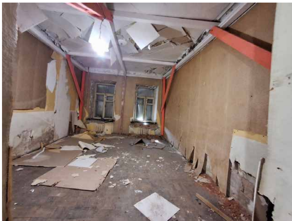
Фото №26. Помещение 1.32 ОКН РЗ «Дом С. Н. Завальевского-М.В. Северова», расположенный по адресу: Санкт-Петербург, муниципальный округ Коломна, пер. Прядильный, д. 12/163, литера А. Дата: 19.04.2025 г.
