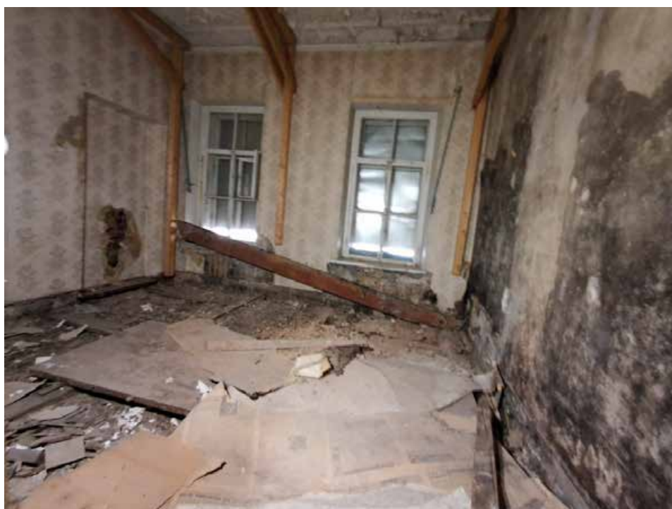
Фото №32. Помещение 2.18 ОКН РЗ «Дом С. Н. Завальевского-М.В. Северова», расположенный по адресу: Санкт-Петербург, муниципальный округ Коломна, пер. Прядильный, д. 12/163, литера А. Дата: 19.04.2025 г.
