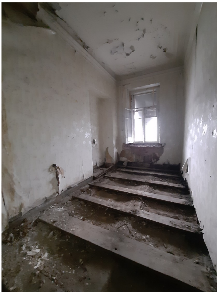
Фото №19. Помещение 3.26 ОКН РЗ «Дом С. Н. Завальевского-М.В. Северова», расположенный по адресу: Санкт-Петербург, муниципальный округ Коломна, пер. Прядильный, д. 12/163, литера А. Дата: 19.04.2025 г.
