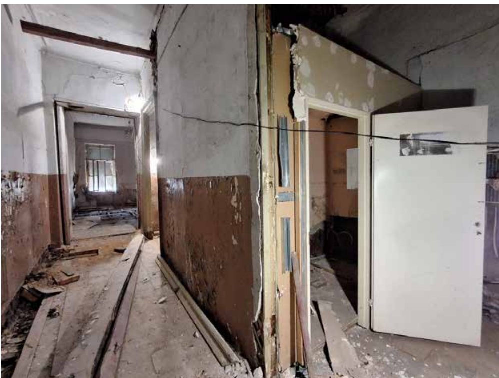
Фото №6. Помещения 2.39 и 2.35 ОКН РЗ «Дом С. Н. Завальевского-М.В. Северова», расположенный по адресу: Санкт-Петербург, муниципальный округ Коломна, пер. Прядильный, д. 12/163, литера А. Дата: 19.04.2025 г.
