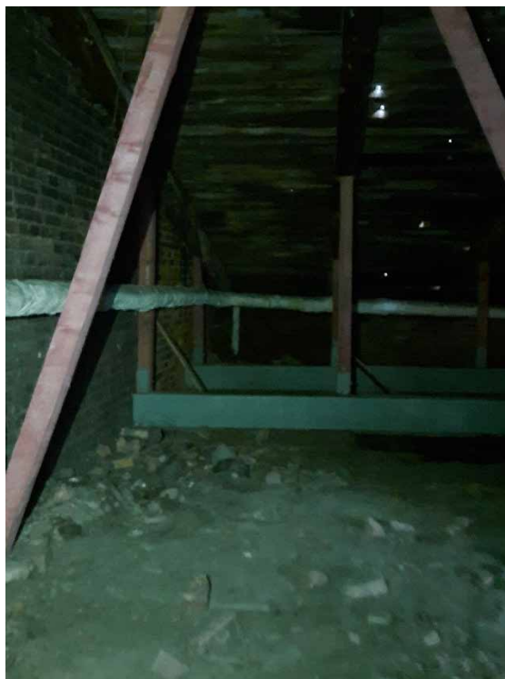
Фото №6. Помещение 4.2. ОКН РЗ «Дом С. Н. Завальевского-М.В. Северова», расположенный по адресу: Санкт-Петербург, муниципальный округ Коломна, пер. Прядильный, д. 12/163, литера А. Дата: 19.04.2025 г.
