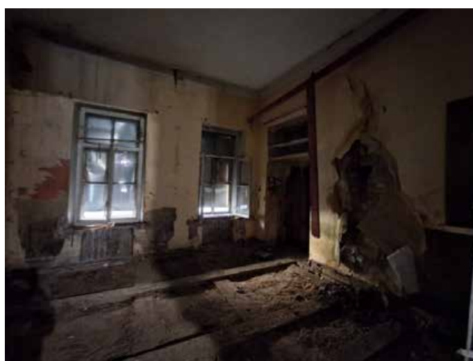
Фото №14. Помещение 2.50 ОКН РЗ «Дом С. Н. Завальевского-М.В. Северова», расположенный по адресу: Санкт-Петербург, муниципальный округ Коломна, пер. Прядильный, д. 12/163, литера А. Дата: 19.04.2025 г.
