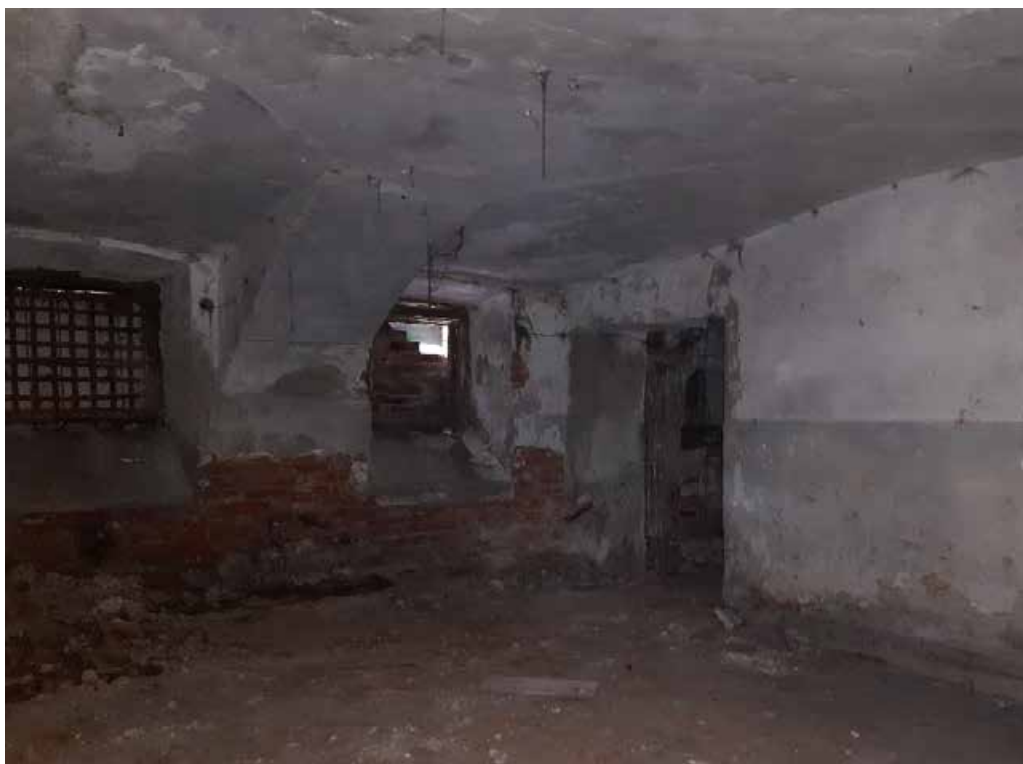
Фото №7. Помещение 0.24 ОКН РЗ «Дом С. Н. Завальевского-М.В. Северова», расположенный по адресу: Санкт-Петербург, муниципальный округ Коломна, пер. Прядильный, д. 12/163, литера А. Дата: 19.04.2025 г.
