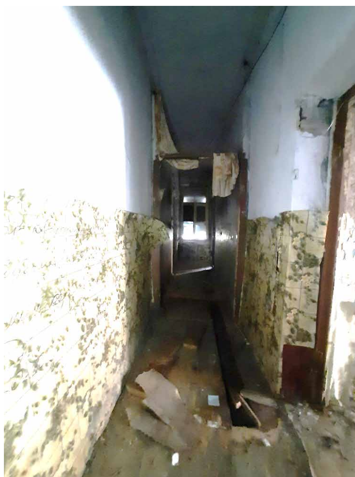
Фото №38. Помещение 3.9 ОКН РЗ «Дом С. Н. Завальевского-М.В. Северова», расположенный по адресу: Санкт-Петербург, муниципальный округ Коломна, пер. Прядильный, д. 12/163, литера А. Дата: 19.04.2025 г.
