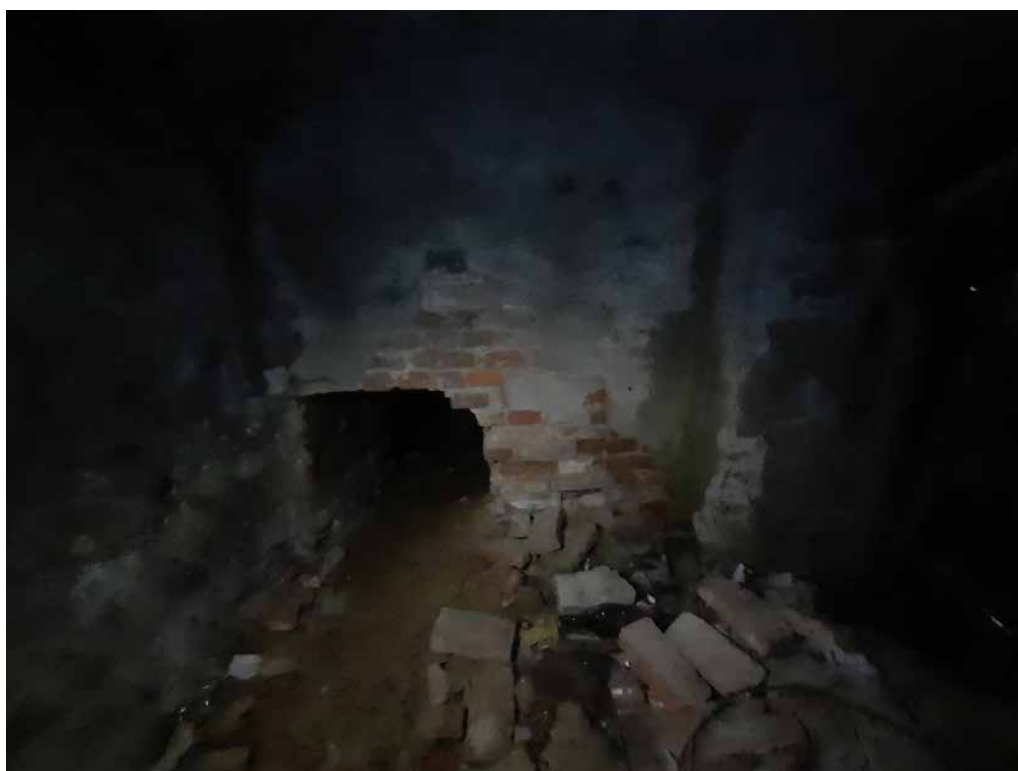
Фото №4. Помещение 0.21 ОКН РЗ «Дом С. Н. Завальевского-М.В. Северова», расположенный по адресу: Санкт-Петербург, муниципальный округ Коломна, пер. Прядильный, д. 12/163, литера А. Дата: 19.04.2025 г.
