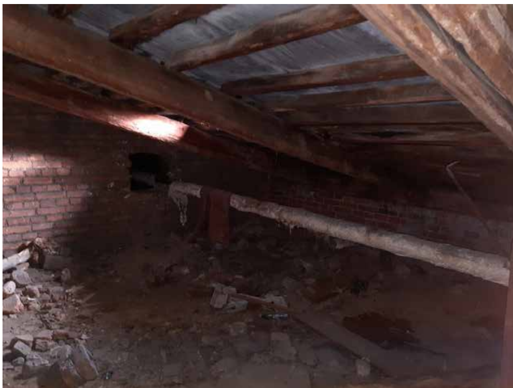
Фото №23. Помещение 4.1. ОКН РЗ «Дом С. Н. Завальевского-М.В. Северова», расположенный по адресу: Санкт-Петербург, муниципальный округ Коломна, пер. Прядильный, д. 12/163, литера А. Дата: 19.04.2025 г.
