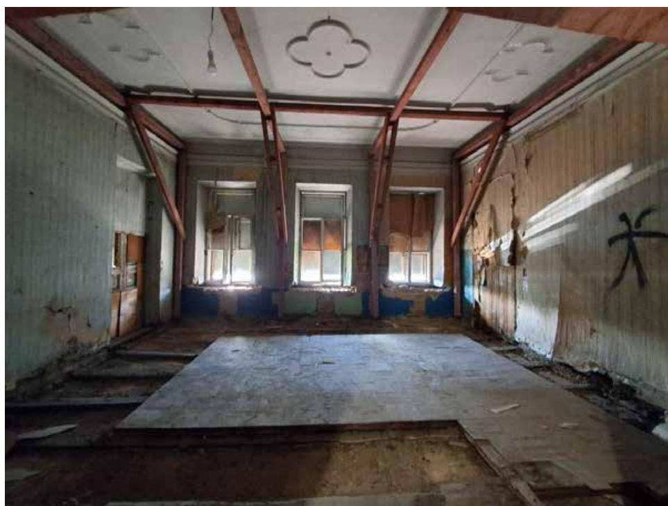
Фото №12. Помещение 2.33 ОКН РЗ «Дом С. Н. Завальевского-М.В. Северова», расположенный по адресу: Санкт-Петербург, муниципальный округ Коломна, пер. Прядильный, д. 12/163, литера А. Дата: 19.04.2025 г.
