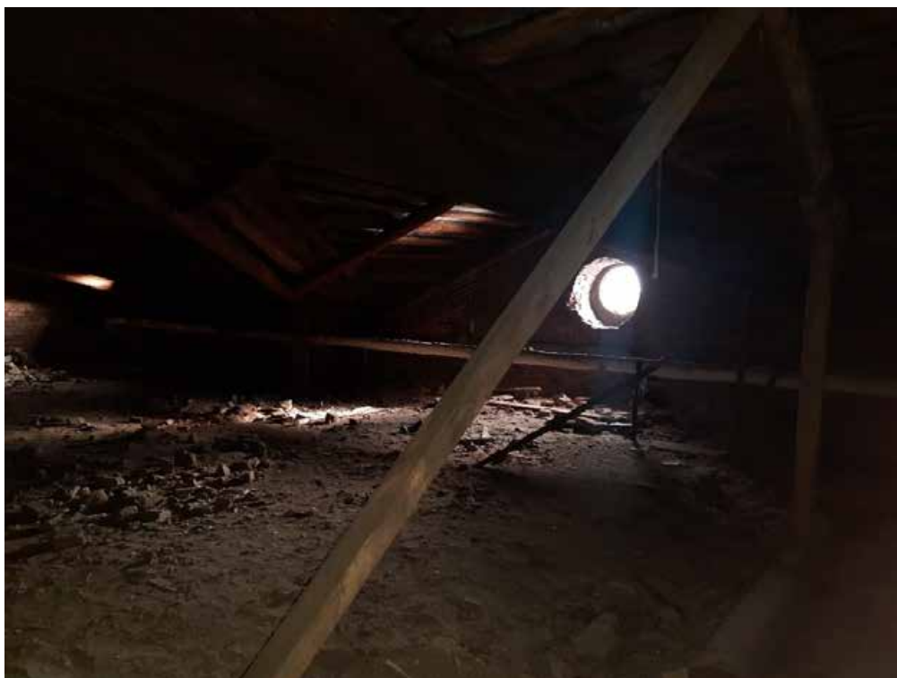
Фото №19. Помещение 4.1. ОКН РЗ «Дом С. Н. Завальевского-М.В. Северова», расположенный по адресу: Санкт-Петербург, муниципальный округ Коломна, пер. Прядильный, д. 12/163, литера А. Дата: 19.04.2025 г.
