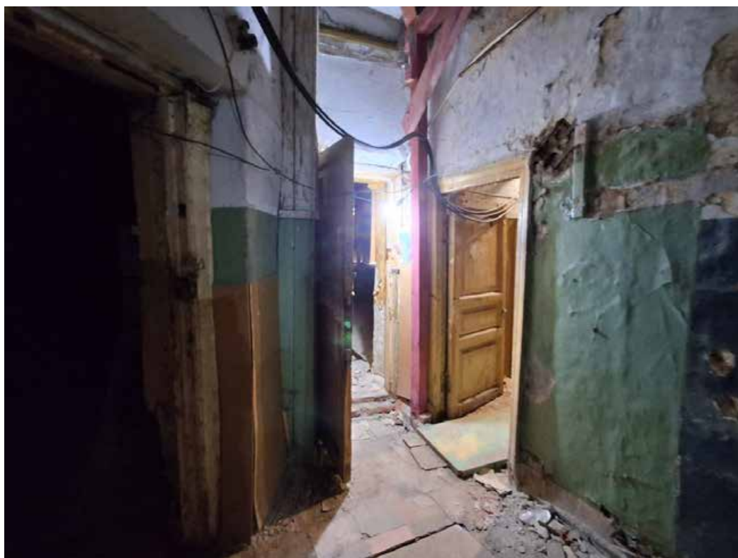
Фото №10. Помещение 1.10 ОКН РЗ «Дом С. Н. Завальевского-М.В. Северова», расположенный по адресу: Санкт-Петербург, муниципальный округ Коломна, пер. Прядильный, д. 12/163, литера А. Дата: 19.04.2025 г.
