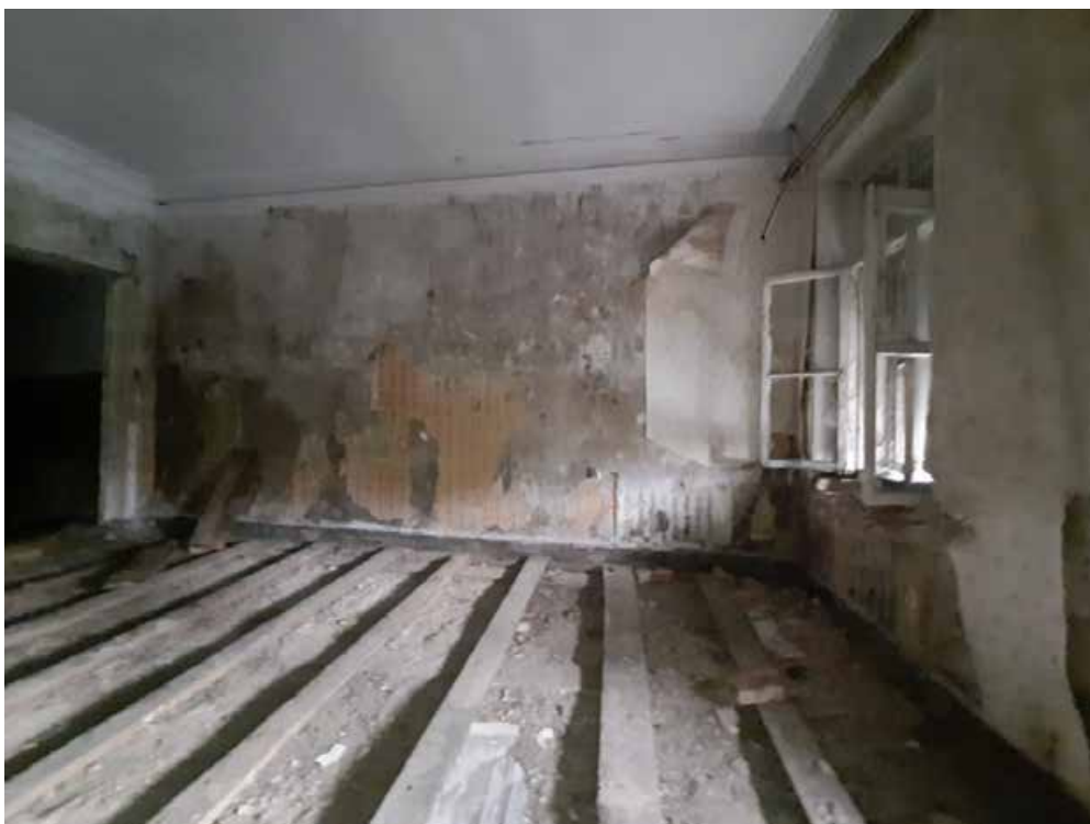
Фото №15. Помещение 3.29 ОКН РЗ «Дом С. Н. Завальевского-М.В. Северова», расположенный по адресу: Санкт-Петербург, муниципальный округ Коломна, пер. Прядильный, д. 12/163, литера А. Дата: 19.04.2025 г.
