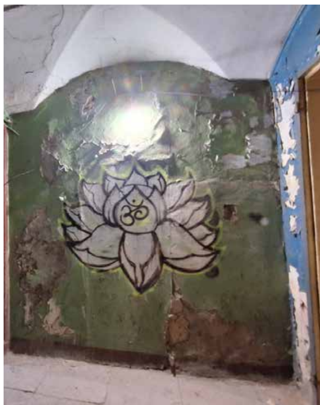
Фото №22. Помещение 1.2 ОКН РЗ «Дом С. Н. Завальевского-М.В. Северова», расположенный по адресу: Санкт-Петербург, муниципальный округ Коломна, пер. Прядильный, д. 12/163, литера А. Дата: 19.04.2025 г.
