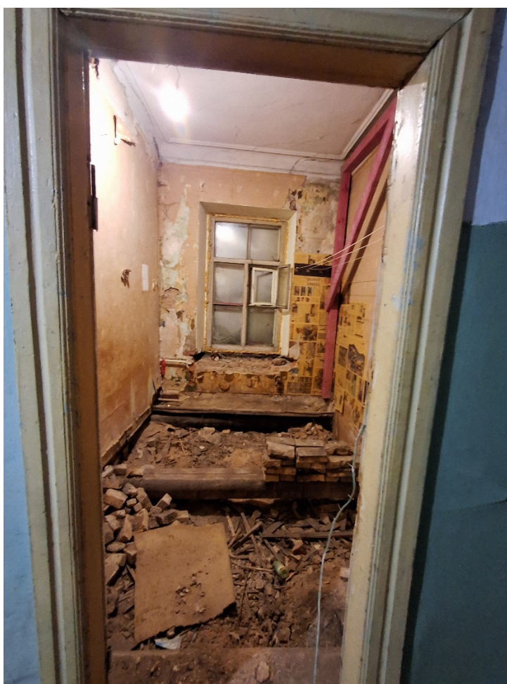
Фото №18. Помещение 1.5 ОКН РЗ «Дом С. Н. Завальевского-М.В. Северова», расположенный по адресу: Санкт-Петербург, муниципальный округ Коломна, пер. Прядильный, д. 12/163, литера А. Дата: 19.04.2025 г.
