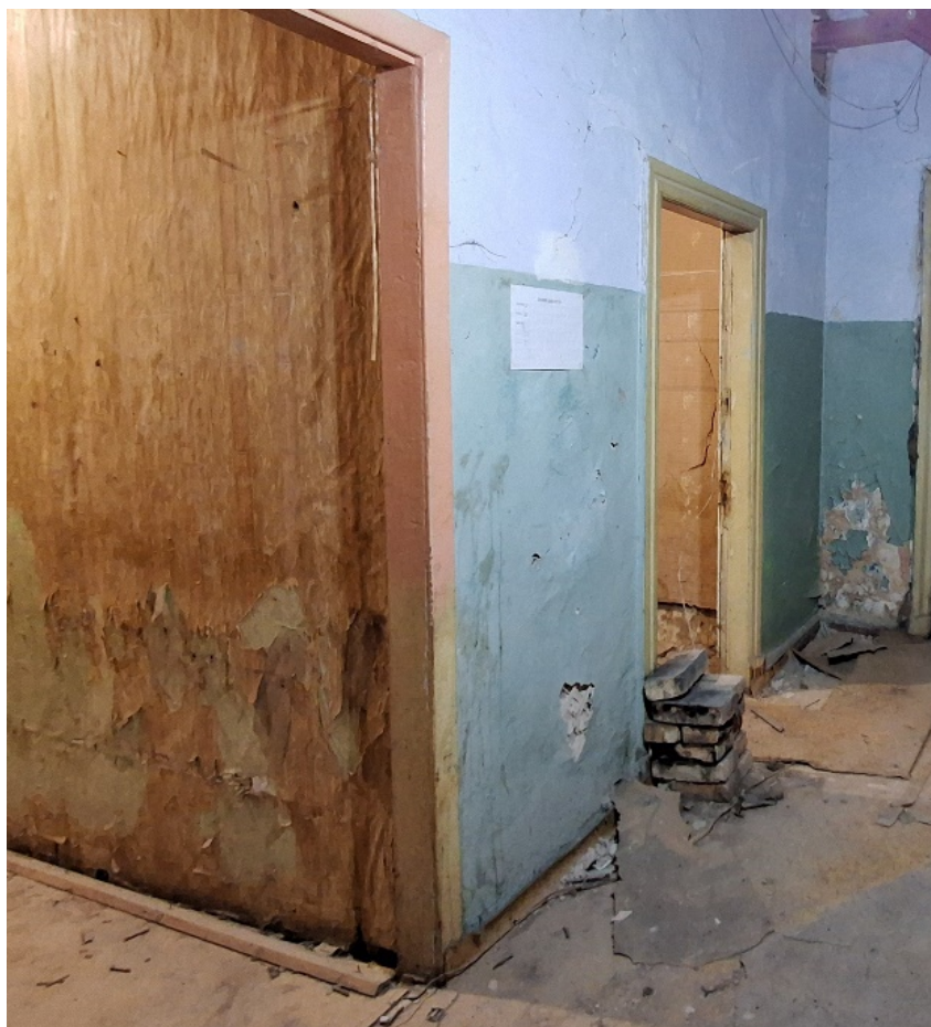
Фото №13. Помещение 1.4 ОКН РЗ «Дом С. Н. Завальевского-М.В. Северова», расположенный по адресу: Санкт-Петербург, муниципальный округ Коломна, пер. Прядильный, д. 12/163, литера А. Дата: 19.04.2025 г.
