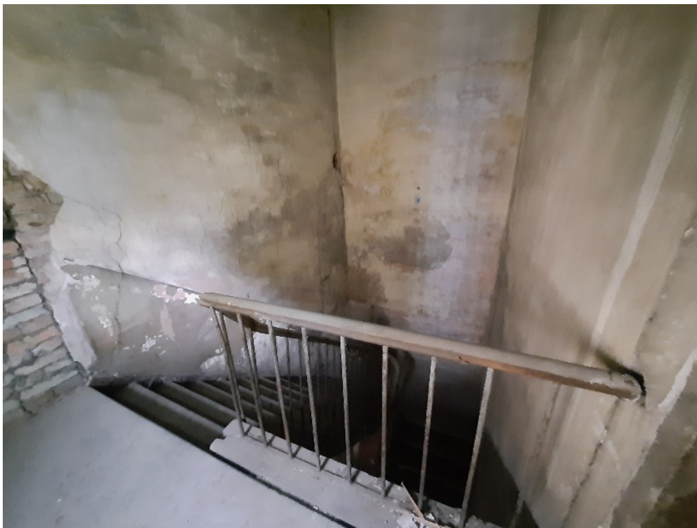
Фото №35. Помещение 3.13 ОКН РЗ «Дом С. Н. Завальевского-М.В. Северова», расположенный по адресу: Санкт-Петербург, муниципальный округ Коломна, пер. Прядильный, д. 12/163, литера А. Дата: 19.04.2025 г.
