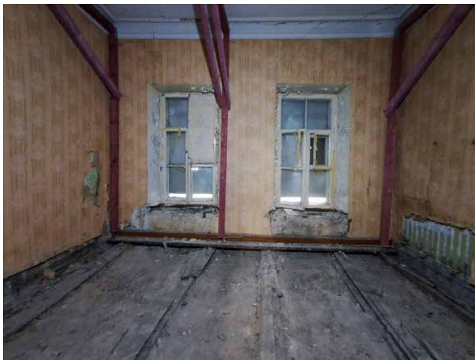
Фото №21. Помещение 2.3 ОКН РЗ «Дом С. Н. Завальевского-М.В. Северова», расположенный по адресу: Санкт-Петербург, муниципальный округ Коломна, пер. Прядильный, д. 12/163, литера А. Дата: 19.04.2025 г.
