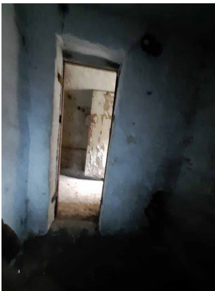
Фото №10. Помещение 0.16 ОКН РЗ «Дом С. Н. Завальевского-М.В. Северова», расположенный по адресу: Санкт-Петербург, муниципальный округ Коломна, пер. Прядильный, д. 12/163, литера А. Дата: 19.04.2025 г.
