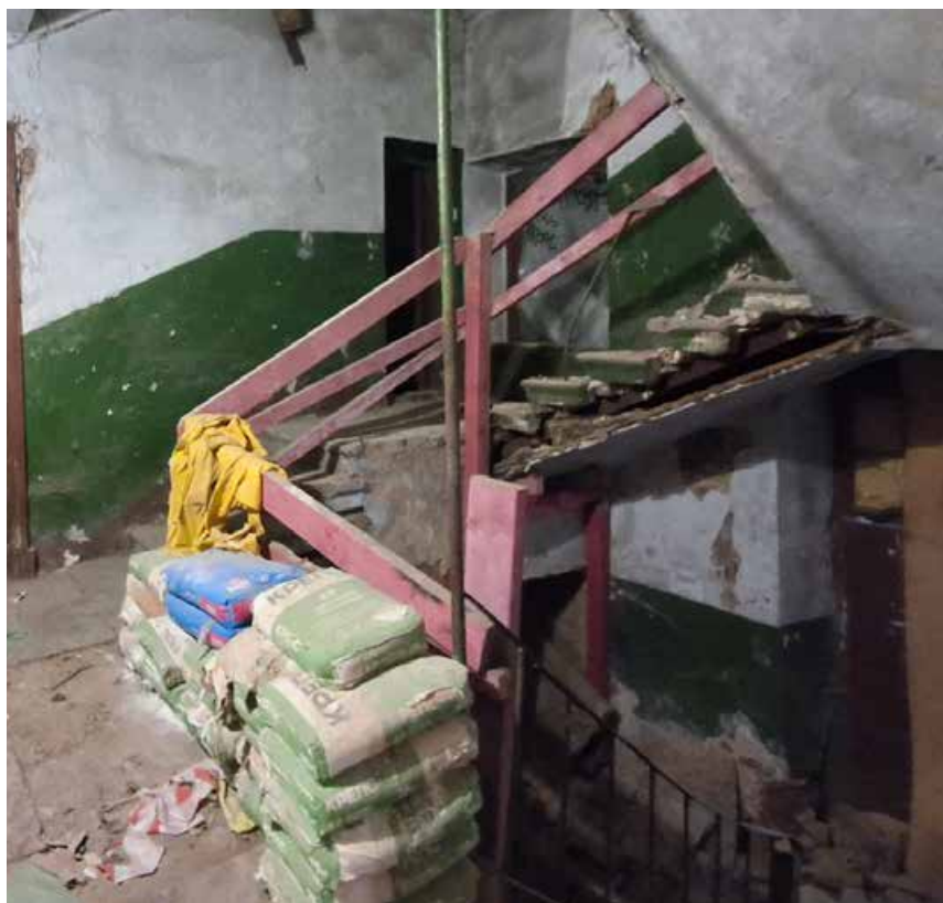
Фото №7. Помещение 1.12 ОКН РЗ «Дом С. Н. Завальевского-М.В. Северова», расположенный по адресу: Санкт-Петербург, муниципальный округ Коломна, пер. Прядильный, д. 12/163, литера А. Дата: 19.04.2025 г.
