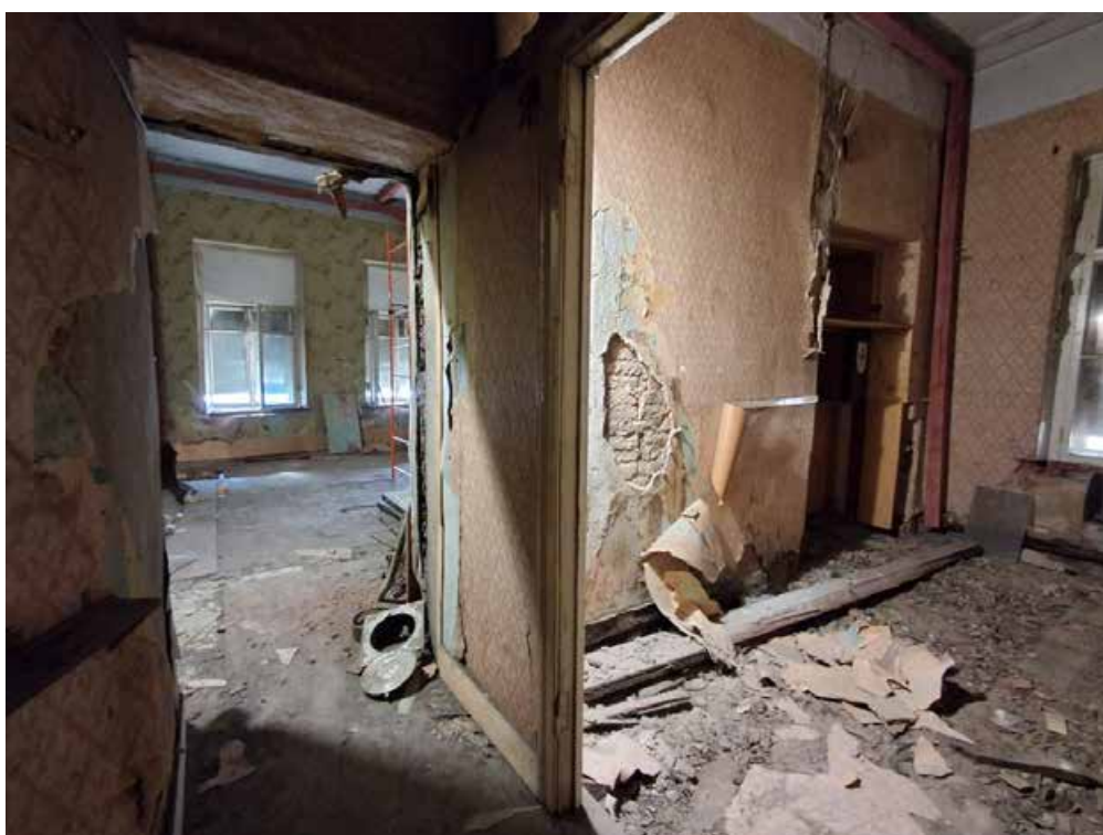
Фото №24. Помещения 2.23 и 2.24 ОКН РЗ «Дом С. Н. Завальевского-М.В. Северова», расположенный по адресу: Санкт-Петербург, муниципальный округ Коломна, пер. Прядильный, д. 12/163, литера А. Дата: 19.04.2025 г.
