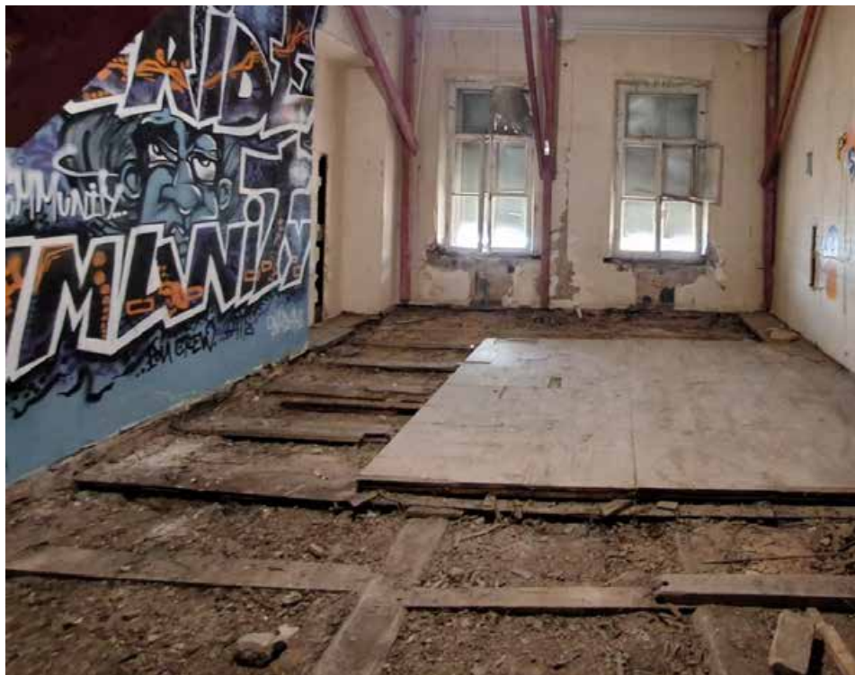
Фото №15. Помещение 2.32 ОКН РЗ «Дом С. Н. Завальевского-М.В. Северова», расположенный по адресу: Санкт-Петербург, муниципальный округ Коломна, пер. Прядильный, д. 12/163, литера А. Дата: 19.04.2025 г.
