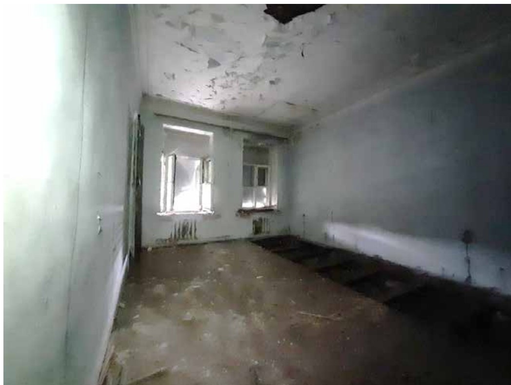
Фото №25. Помещение 3.22 ОКН РЗ «Дом С. Н. Завальевского-М.В. Северова», расположенный по адресу: Санкт-Петербург, муниципальный округ Коломна, пер. Прядильный, д. 12/163, литера А. Дата: 19.04.2025 г.
