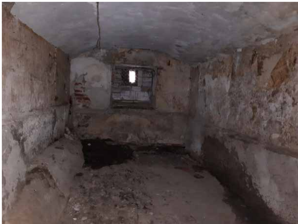
Фото №11. Помещение 0.17 ОКН РЗ «Дом С. Н. Завальевского-М.В. Северова», расположенный по адресу: Санкт-Петербург, муниципальный округ Коломна, пер. Прядильный, д. 12/163, литера А. Дата: 19.04.2025 г.
