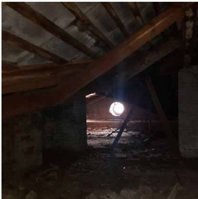
Фото №15. Помещение 4.1. ОКН РЗ «Дом С. Н. Завальевского-М.В. Северова», расположенный по адресу: Санкт-Петербург, муниципальный округ Коломна, пер. Прядильный, д. 12/163, литера А. Дата: 19.04.2025 г.
