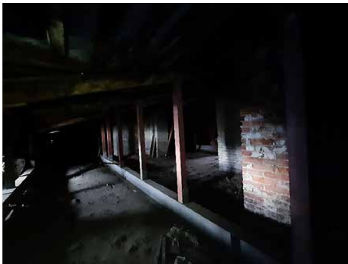
Фото №9. Помещение 4.2. ОКН РЗ «Дом С. Н. Завальевского-М.В. Северова», расположенный по адресу: Санкт-Петербург, муниципальный округ Коломна, пер. Прядильный, д. 12/163, литера А. Дата: 19.04.2025 г.
