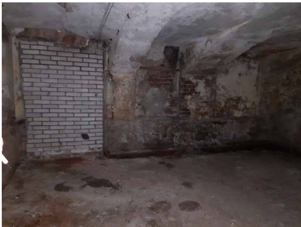
Фото №15. Помещение 0.4 ОКН РЗ «Дом С. Н. Завальевского-М.В. Северова», расположенный по адресу: Санкт-Петербург, муниципальный округ Коломна, пер. Прядильный, д. 12/163, литера А. Дата: 19.04.2025 г.
