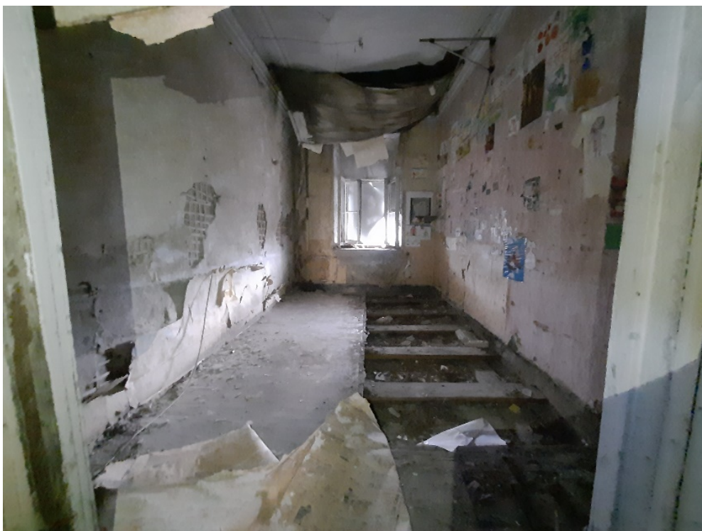
Фото №23. Помещение 3.24 ОКН РЗ «Дом С. Н. Завальевского-М.В. Северова», расположенный по адресу: Санкт-Петербург, муниципальный округ Коломна, пер. Прядильный, д. 12/163, литера А. Дата: 19.04.2025 г.
