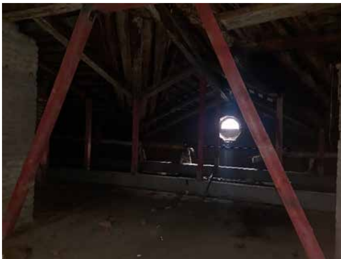
Фото №11. Помещение 4.2. ОКН РЗ «Дом С. Н. Завальевского-М.В. Северова», расположенный по адресу: Санкт-Петербург, муниципальный округ Коломна, пер. Прядильный, д. 12/163, литера А. Дата: 19.04.2025 г.
