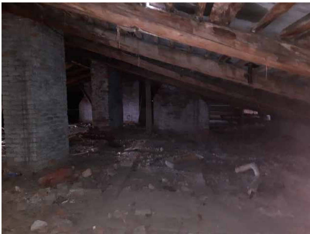
Фото №26. Помещение 4.1. ОКН РЗ «Дом С. Н. Завальевского-М.В. Северова», расположенный по адресу: Санкт-Петербург, муниципальный округ Коломна, пер. Прядильный, д. 12/163, литера А. Дата: 19.04.2025 г.
