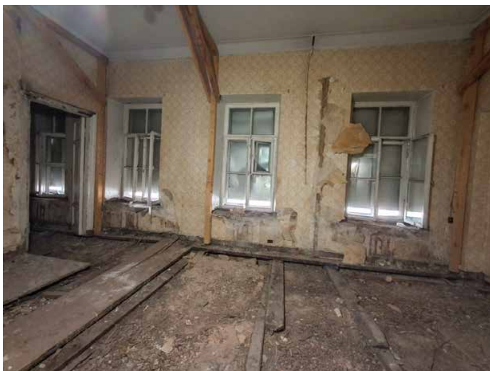
Фото №30. Помещение 2.19 ОКН РЗ «Дом С. Н. Завальевского-М.В. Северова», расположенный по адресу: Санкт-Петербург, муниципальный округ Коломна, пер. Прядильный, д. 12/163, литера А. Дата: 19.04.2025 г.
