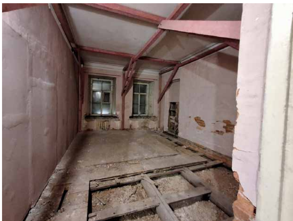
Фото №28. Помещение 1.33 ОКН РЗ «Дом С. Н. Завальевского-М.В. Северова», расположенный по адресу: Санкт-Петербург, муниципальный округ Коломна, пер. Прядильный, д. 12/163, литера А. Дата: 19.04.2025 г.
