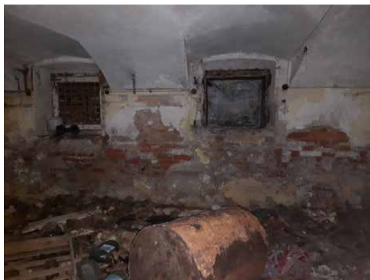
Фото №18. Помещение 0.7 ОКН РЗ «Дом С. Н. Завальевского-М.В. Северова», расположенный по адресу: Санкт-Петербург, муниципальный округ Коломна, пер. Прядильный, д. 12/163, литера А. Дата: 19.04.2025 г.
