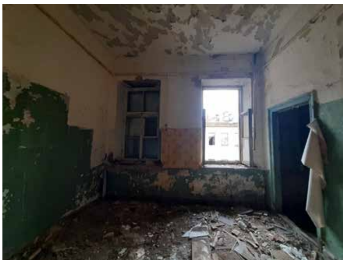
Фото №5. Помещение 3.37 ОКН РЗ «Дом С. Н. Завальевского-М.В. Северова», расположенный по адресу: Санкт-Петербург, муниципальный округ Коломна, пер. Прядильный, д. 12/163, литера А. Дата: 19.04.2025 г.
