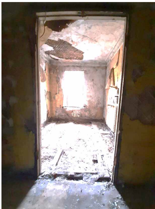
Фото №22. Помещение 3.47 ОКН РЗ «Дом С. Н. Завальевского-М.В. Северова», расположенный по адресу: Санкт-Петербург, муниципальный округ Коломна, пер. Прядильный, д. 12/163, литера А. Дата: 19.04.2025 г.
