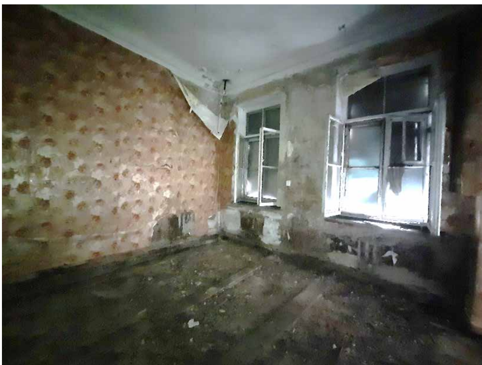
Фото №36. Помещение 3.12 ОКН РЗ «Дом С. Н. Завальевского-М.В. Северова», расположенный по адресу: Санкт-Петербург, муниципальный округ Коломна, пер. Прядильный, д. 12/163, литера А. Дата: 19.04.2025 г.
