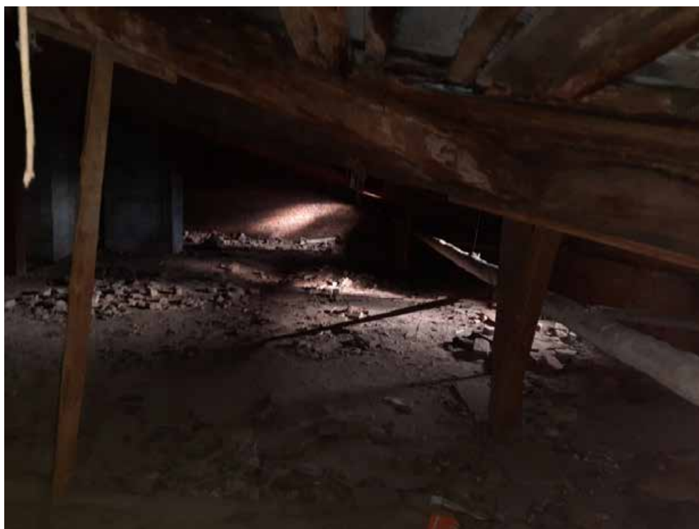
Фото №20. Помещение 4.1. ОКН РЗ «Дом С. Н. Завальевского-М.В. Северова», расположенный по адресу: Санкт-Петербург, муниципальный округ Коломна, пер. Прядильный, д. 12/163, литера А. Дата: 19.04.2025 г.
