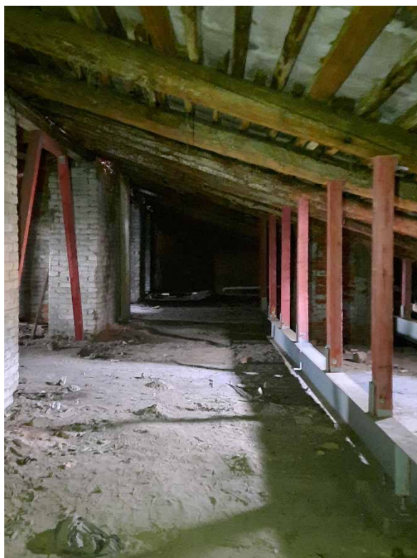
Фото №7. Помещение 4.2. ОКН РЗ «Дом С. Н. Завальевского-М.В. Северова», расположенный по адресу: Санкт-Петербург, муниципальный округ Коломна, пер. Прядильный, д. 12/163, литера А. Дата: 19.04.2025 г.
