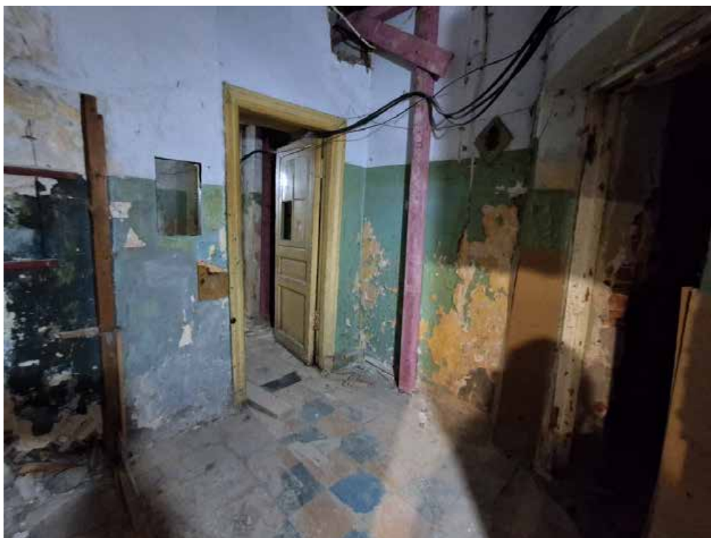
Фото №9. Помещение 1.11 ОКН РЗ «Дом С. Н. Завальевского-М.В. Северова», расположенный по адресу: Санкт-Петербург, муниципальный округ Коломна, пер. Прядильный, д. 12/163, литера А. Дата: 19.04.2025 г.
