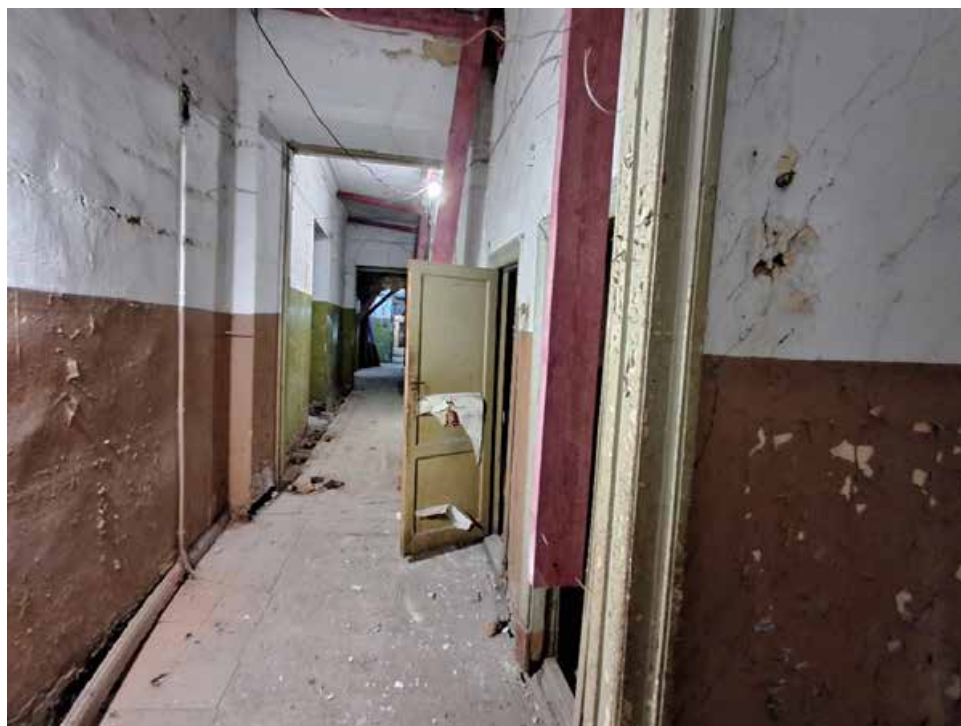
Фото №7. Помещение 2.46 ОКН РЗ «Дом С. Н. Завальевского-М.В. Северова», расположенный по адресу: Санкт-Петербург, муниципальный округ Коломна, пер. Прядильный, д. 12/163, литера А. Дата: 19.04.2025 г.
