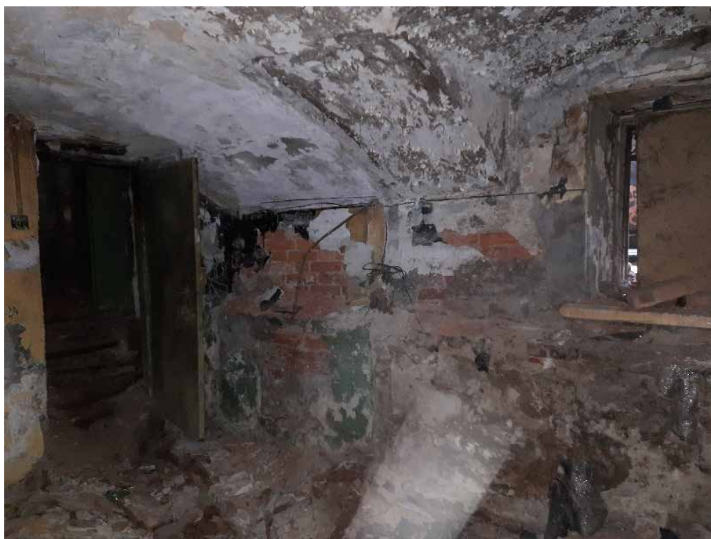
Фото №16. Помещение 0.10 ОКН РЗ «Дом С. Н. Завальевского-М.В. Северова», расположенный по адресу: Санкт-Петербург, муниципальный округ Коломна, пер. Прядильный, д. 12/163, литера А. Дата: 19.04.2025 г.
