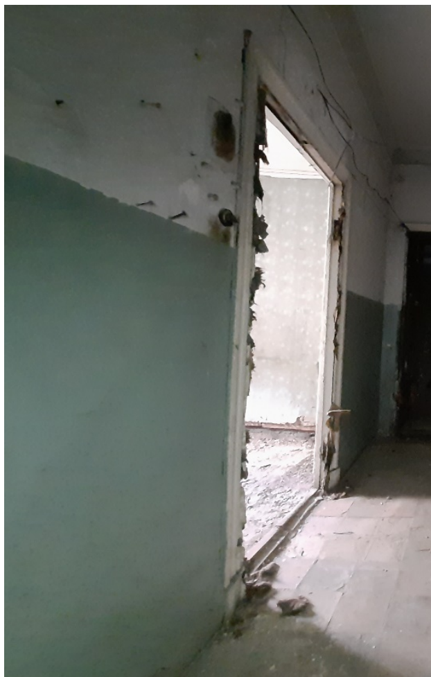
Фото №42. Помещение 3.2 ОКН РЗ «Дом С. Н. Завальевского-М.В. Северова», расположенный по адресу: Санкт-Петербург, муниципальный округ Коломна, пер. Прядильный, д. 12/163, литера А. Дата: 19.04.2025 г.
