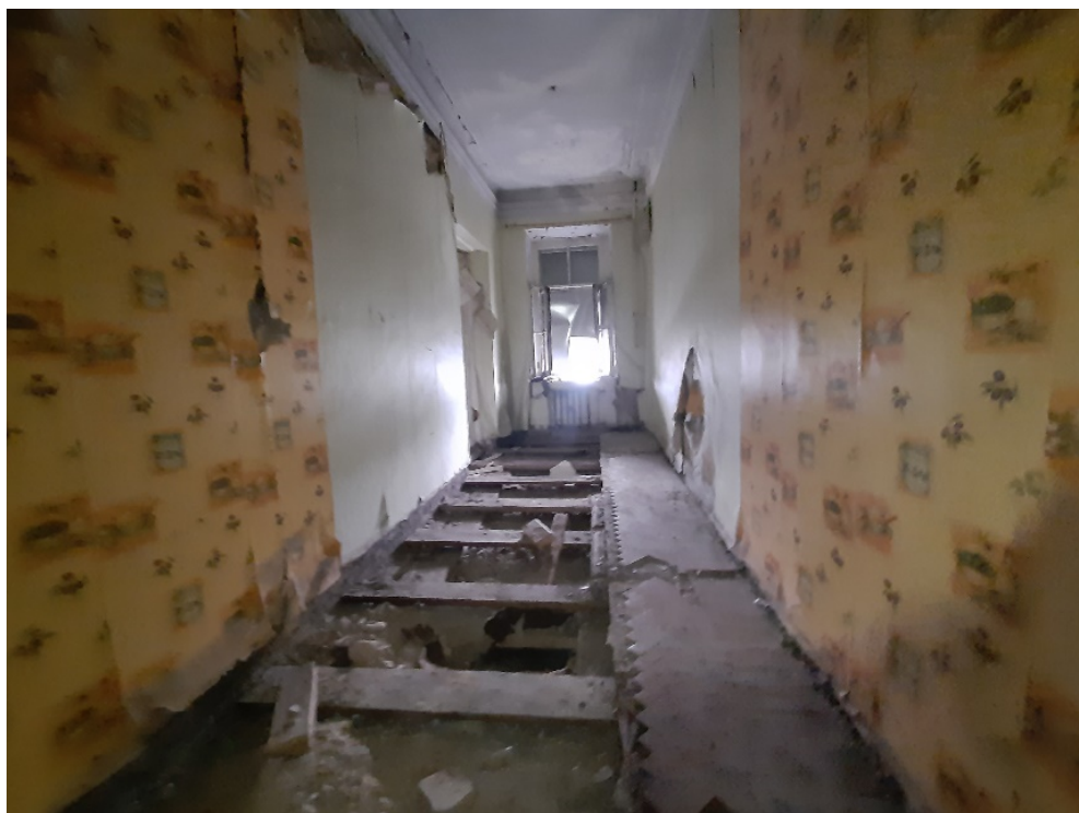
Фото №16. Помещение 3.28 ОКН РЗ «Дом С. Н. Завальевского-М.В. Северова», расположенный по адресу: Санкт-Петербург, муниципальный округ Коломна, пер. Прядильный, д. 12/163, литера А. Дата: 19.04.2025 г.
