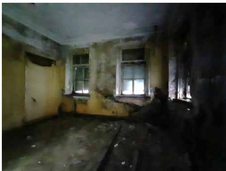
Фото №34. Помещение 3.14 ОКН РЗ «Дом С. Н. Завальевского-М.В. Северова», расположенный по адресу: Санкт-Петербург, муниципальный округ Коломна, пер. Прядильный, д. 12/163, литера А. Дата: 19.04.2025 г.
