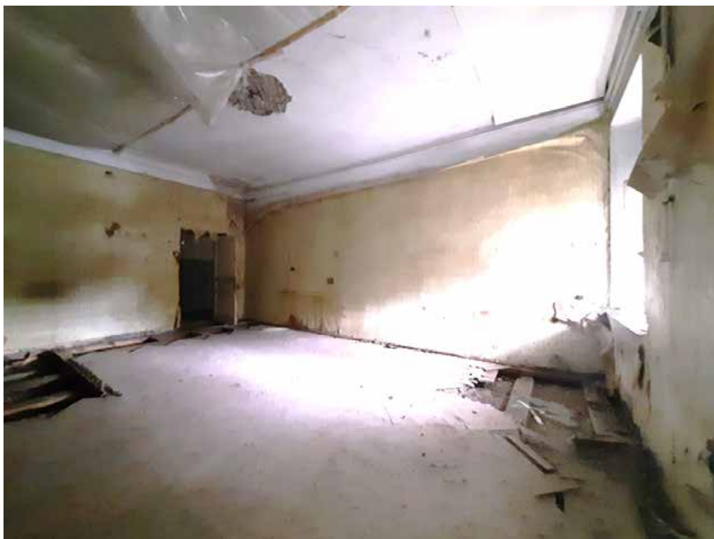
Фото №27. Помещение 3.20 ОКН РЗ «Дом С. Н. Завальевского-М.В. Северова», расположенный по адресу: Санкт-Петербург, муниципальный округ Коломна, пер. Прядильный, д. 12/163, литера А. Дата: 19.04.2025 г.
