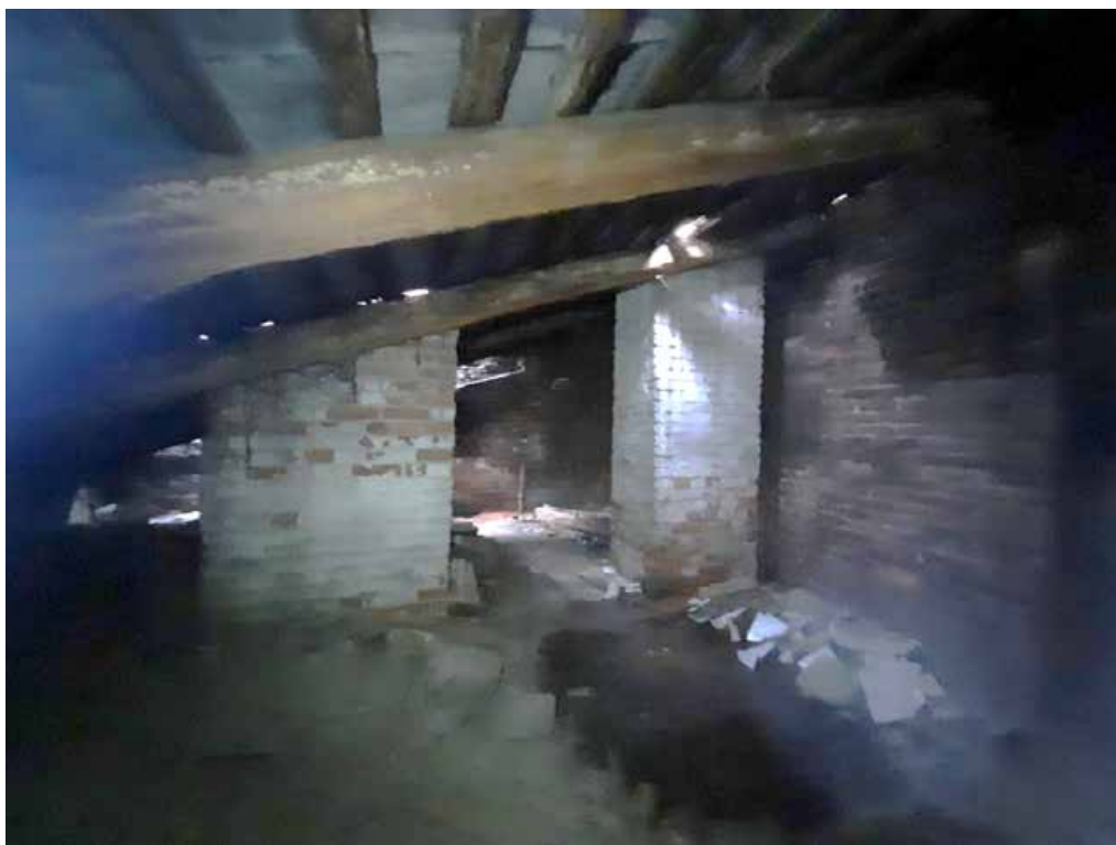
Фото №3. Помещение 4.2. ОКН РЗ «Дом С. Н. Завальевского-М.В. Северова», расположенный по адресу: Санкт-Петербург, муниципальный округ Коломна, пер. Прядильный, д. 12/163, литера А. Дата: 19.04.2025 г.
