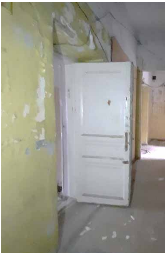
Фото №21. Помещение 3.46 ОКН РЗ «Дом С. Н. Завальевского-М.В. Северова», расположенный по адресу: Санкт-Петербург, муниципальный округ Коломна, пер. Прядильный, д. 12/163, литера А. Дата: 19.04.2025 г.
