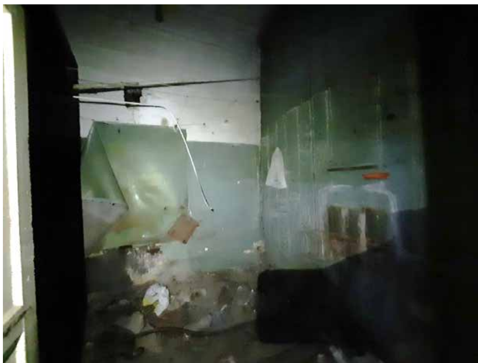
Фото №40. Помещение 3.6 ОКН РЗ «Дом С. Н. Завальевского-М.В. Северова», расположенный по адресу: Санкт-Петербург, муниципальный округ Коломна, пер. Прядильный, д. 12/163, литера А. Дата: 19.04.2025 г.
