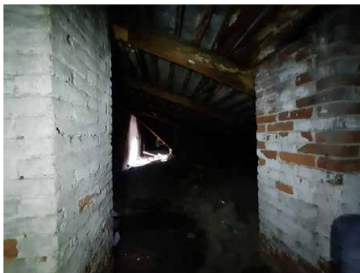
Фото №2. Помещение 4.2. ОКН РЗ «Дом С. Н. Завальевского-М.В. Северова», расположенный по адресу: Санкт-Петербург, муниципальный округ Коломна, пер. Прядильный, д. 12/163, литера А. Дата: 19.04.2025 г.
