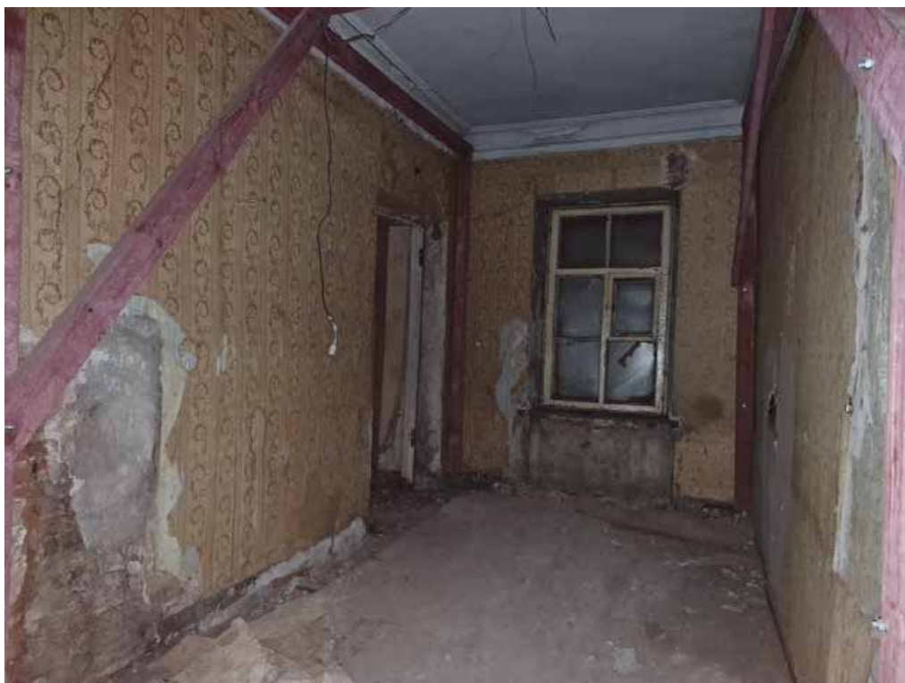
Фото №11. Помещение 1.24 ОКН РЗ «Дом С. Н. Завальевского-М.В. Северова», расположенный по адресу: Санкт-Петербург, муниципальный округ Коломна, пер. Прядильный, д. 12/163, литера А. Дата: 19.04.2025 г.
