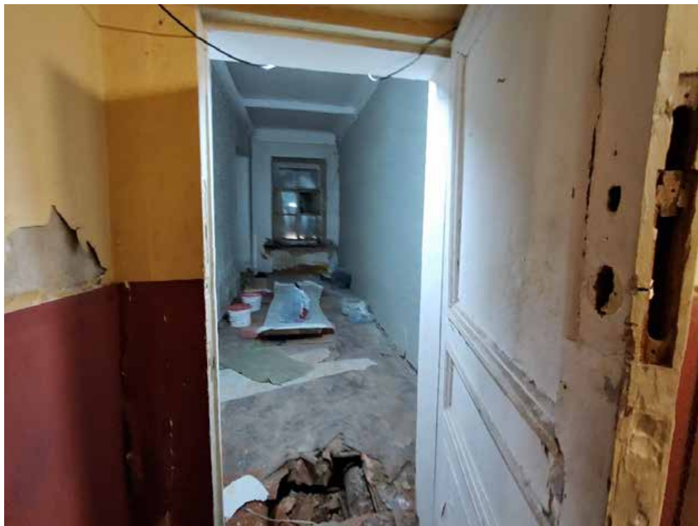
Фото №30. Помещение 1.34 ОКН РЗ «Дом С. Н. Завальевского-М.В. Северова», расположенный по адресу: Санкт-Петербург, муниципальный округ Коломна, пер. Прядильный, д. 12/163, литера А. Дата: 19.04.2025 г.
