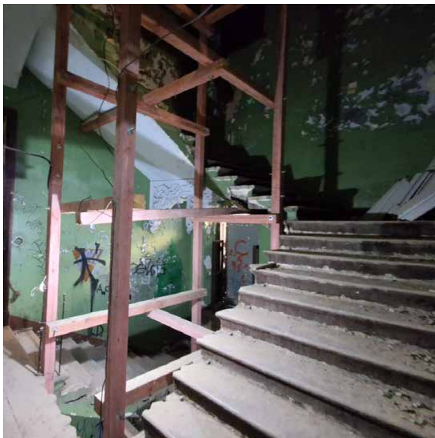
Фото №19. Помещение 2.1 ОКН РЗ «Дом С. Н. Завальевского-М.В. Северова», расположенный по адресу: Санкт-Петербург, муниципальный округ Коломна, пер. Прядильный, д. 12/163, литера А. Дата: 19.04.2025 г.
