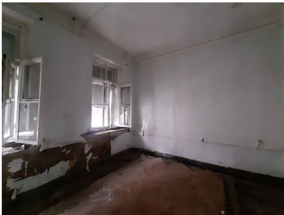
Фото №31. Помещение 3.16 ОКН РЗ «Дом С. Н. Завальевского-М.В. Северова», расположенный по адресу: Санкт-Петербург, муниципальный округ Коломна, пер. Прядильный, д. 12/163, литера А. Дата: 19.04.2025 г.
