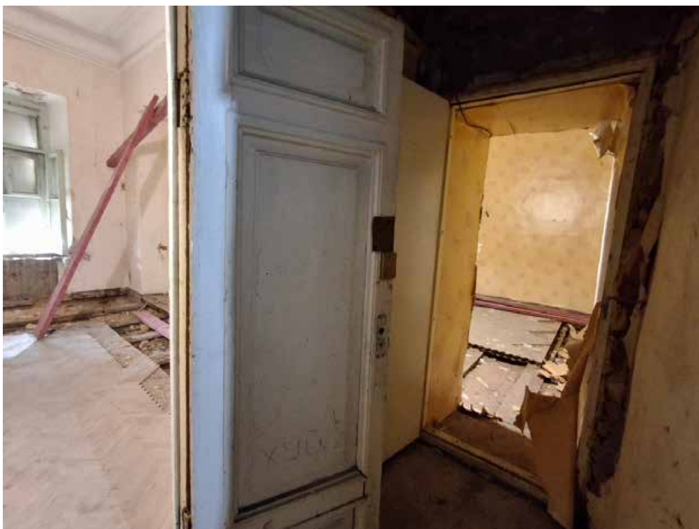
Фото №17. Помещение 2.30 ОКН РЗ «Дом С. Н. Завальевского-М.В. Северова», расположенный по адресу: Санкт-Петербург, муниципальный округ Коломна, пер. Прядильный, д. 12/163, литера А. Дата: 19.04.2025 г.
