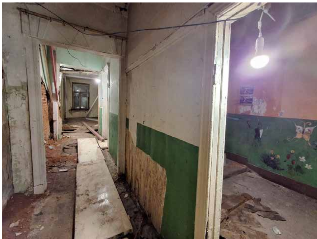
Фото №35. Помещения 1.40 и 1.39 ОКН РЗ «Дом С. Н. Завальевского-М.В. Северова», расположенный по адресу: Санкт-Петербург, муниципальный округ Коломна, пер. Прядильный, д. 12/163, литера А. Дата: 19.04.2025 г.
