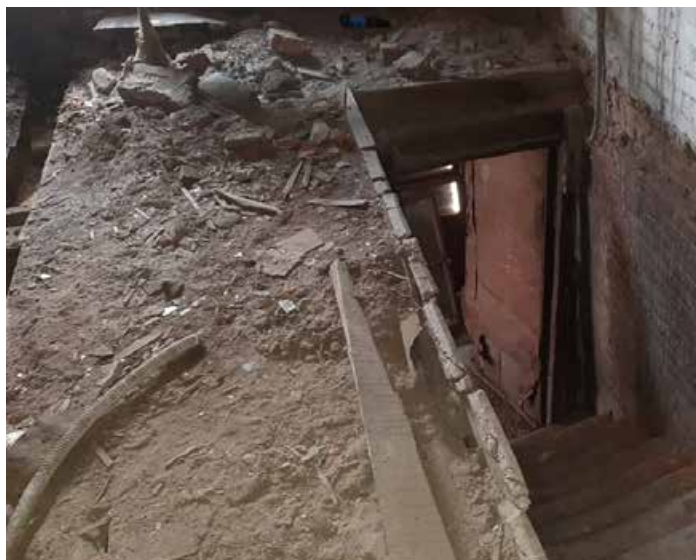
Фото №14. Помещение 4.1. ОКН РЗ «Дом С. Н. Завальевского-М.В. Северова», расположенный по адресу: Санкт-Петербург, муниципальный округ Коломна, пер. Прядильный, д. 12/163, литера А. Дата: 19.04.2025 г.
