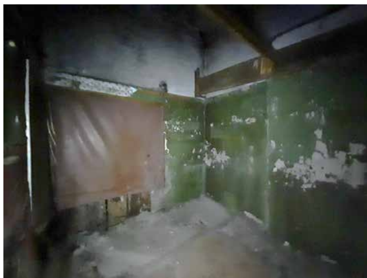
Фото №10. Помещение 3.34 ОКН РЗ «Дом С. Н. Завальевского-М.В. Северова», расположенный по адресу: Санкт-Петербург, муниципальный округ Коломна, пер. Прядильный, д. 12/163, литера А. Дата: 19.04.2025 г.
