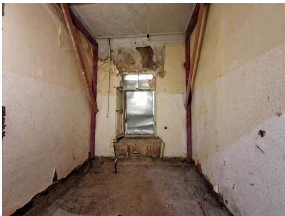
Фото №16. Помещение 2.31 ОКН РЗ «Дом С. Н. Завальевского-М.В. Северова», расположенный по адресу: Санкт-Петербург, муниципальный округ Коломна, пер. Прядильный, д. 12/163, литера А. Дата: 19.04.2025 г.
