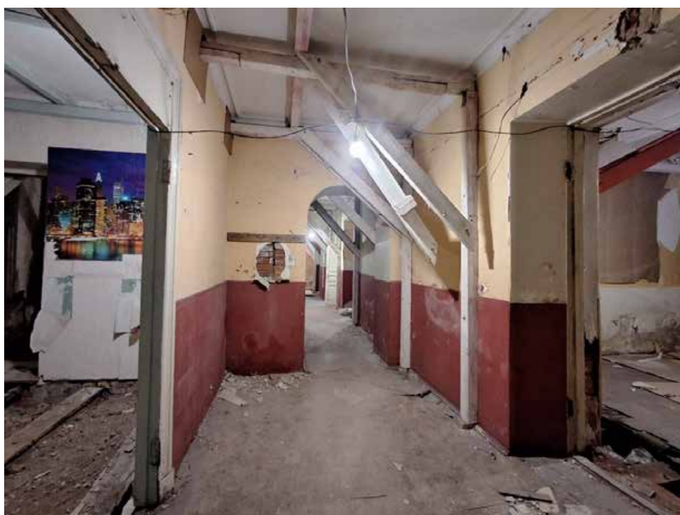
Фото №24. Помещение 1.51 ОКН РЗ «Дом С. Н. Завальевского-М.В. Северова», расположенный по адресу: Санкт-Петербург, муниципальный округ Коломна, пер. Прядильный, д. 12/163, литера А. Дата: 19.04.2025 г.
