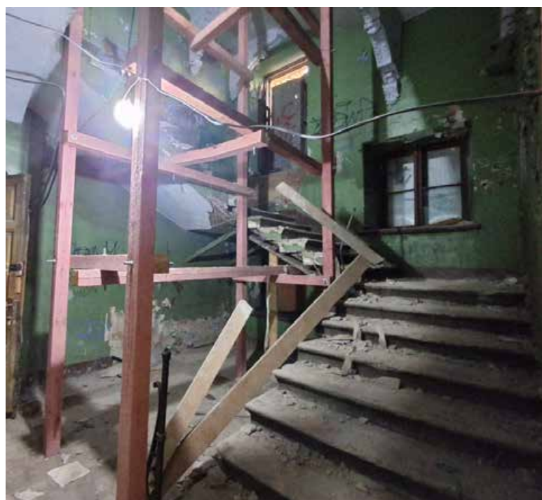
Фото №20. Помещение 1.3 ОКН РЗ «Дом С. Н. Завальевского-М.В. Северова», расположенный по адресу: Санкт-Петербург, муниципальный округ Коломна, пер. Прядильный, д. 12/163, литера А. Дата: 19.04.2025 г.
