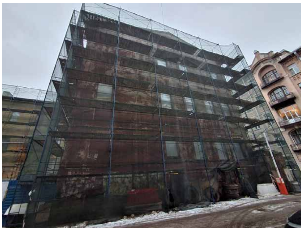
Фото №6. Дворовые фасады ОКН РЗ «Дом С. Н. Завальевского-М.В. Северова», расположенный по адресу: Санкт-Петербург, муниципальный округ Коломна, пер. Пряильный, д. 12/163, литера А. Дата: 19.04.2025 г.
