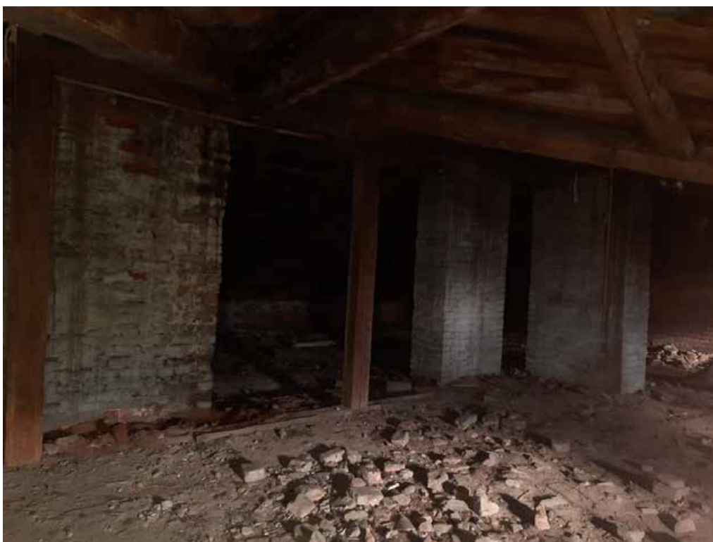
Фото №22. Помещение 4.1. ОКН РЗ «Дом С. Н. Завальевского-М.В. Северова», расположенный по адресу: Санкт-Петербург, муниципальный округ Коломна, пер. Прядильный, д. 12/163, литера А. Дата: 19.04.2025 г.
