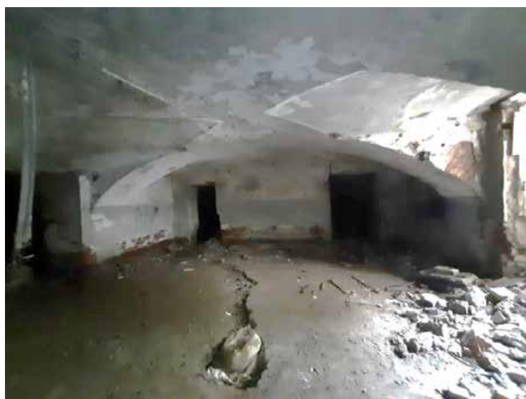
Фото №2. Помещение 0.19 ОКН РЗ «Дом С. Н. Завальевского-М.В. Северова», расположенный по адресу: Санкт-Петербург, муниципальный округ Коломна, пер. Прядильный, д. 12/163, литера А. Дата: 19.04.2025 г.
