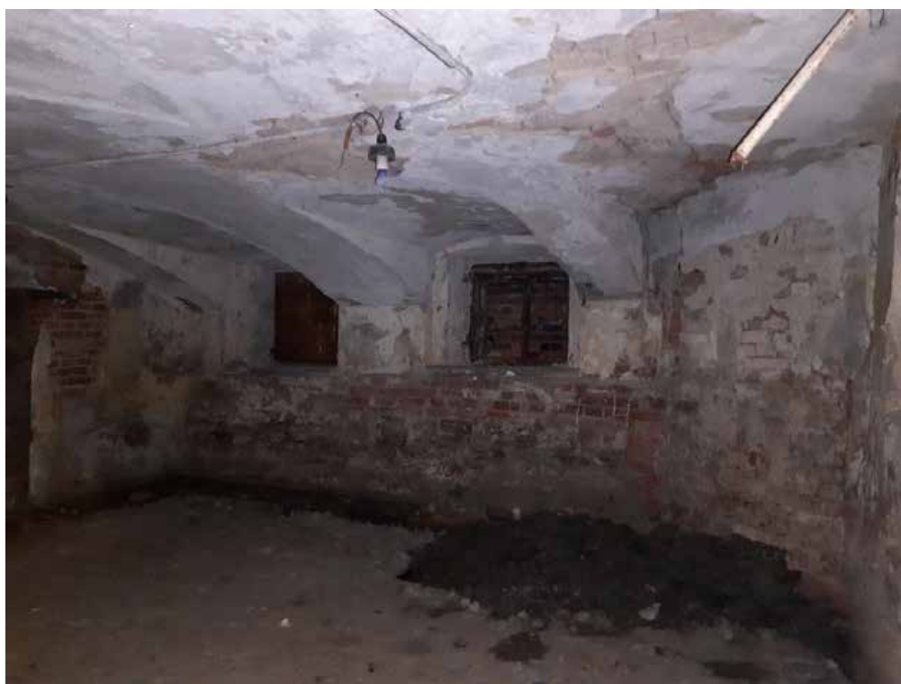
Фото №14. Помещение 0.4 ОКН РЗ «Дом С. Н. Завальевского-М.В. Северова», расположенный по адресу: Санкт-Петербург, муниципальный округ Коломна, пер. Прядильный, д. 12/163, литера А. Дата: 19.04.2025 г.
