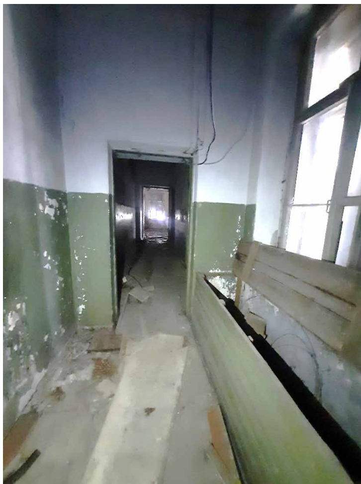
Фото №9. Помещение 3.35 ОКН РЗ «Дом С. Н. Завальевского-М.В. Северова», расположенный по адресу: Санкт-Петербург, муниципальный округ Коломна, пер. Прядильный, д. 12/163, литера А. Дата: 19.04.2025 г.
