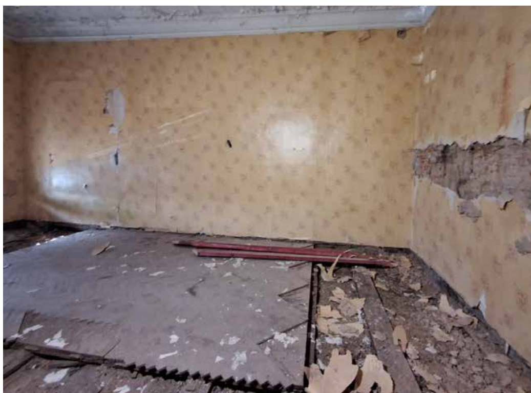
Фото №18. Помещение 2.29 ОКН РЗ «Дом С. Н. Завальевского-М.В. Северова», расположенный по адресу: Санкт-Петербург, муниципальный округ Коломна, пер. Прядильный, д. 12/163, литера А. Дата: 19.04.2025 г.
