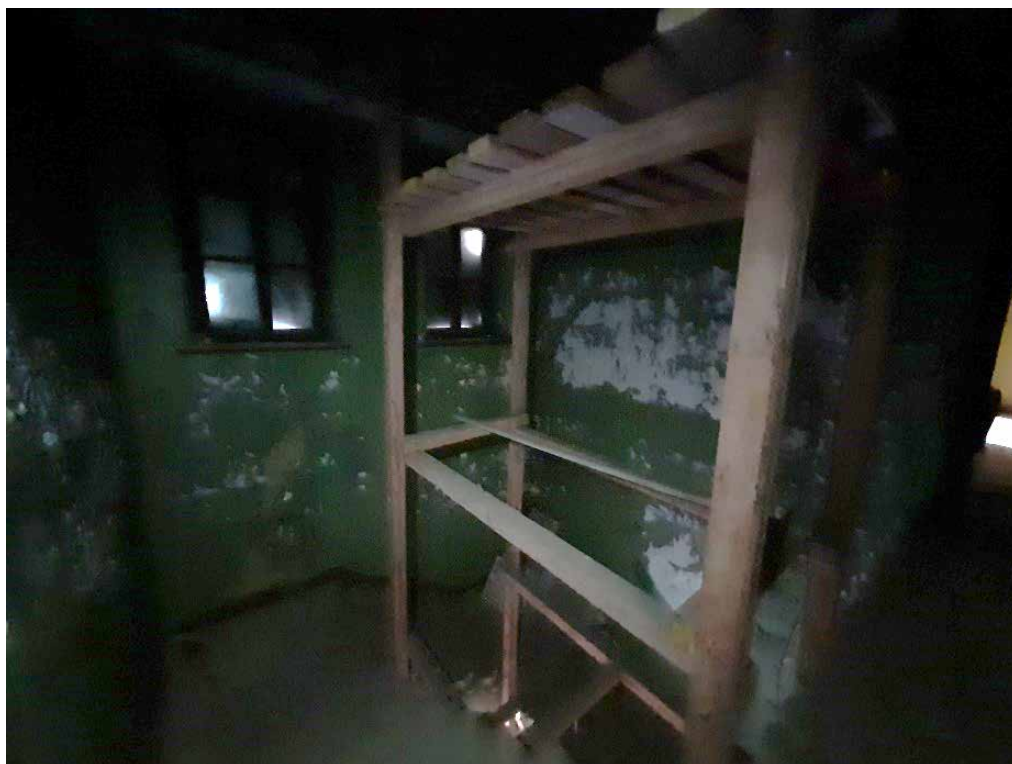
Фото №43. Помещение 3.1 ОКН РЗ «Дом С. Н. Завальевского-М.В. Северова», расположенный по адресу: Санкт-Петербург, муниципальный округ Коломна, пер. Прядильный, д. 12/163, литера А. Дата: 19.04.2025 г.
