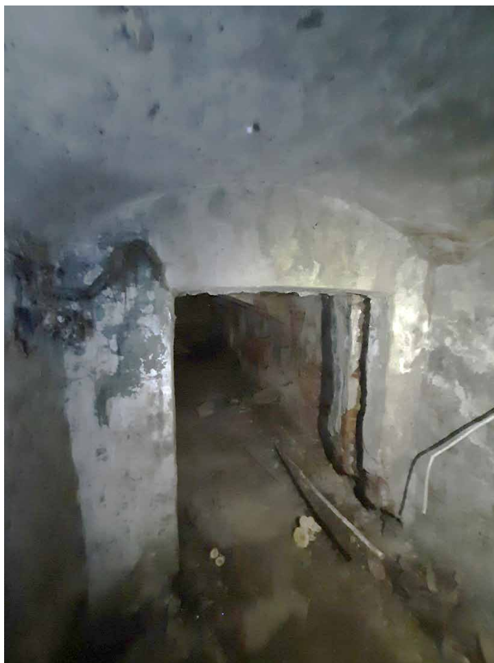
Фото №5. Помещение 0.21 ОКН РЗ «Дом С. Н. Завальевского-М.В. Северова», расположенный по адресу: Санкт-Петербург, муниципальный округ Коломна, пер. Прядильный, д. 12/163, литера А. Дата: 19.04.2025 г.
