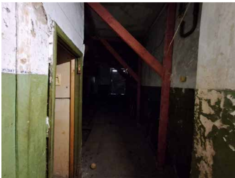
Фото №3. Помещение 1.15 ОКН РЗ «Дом С. Н. Завальевского-М.В. Северова», расположенный по адресу: Санкт-Петербург, муниципальный округ Коломна, пер. Прядильный, д. 12/163, литера А. Дата: 19.04.2025 г.
