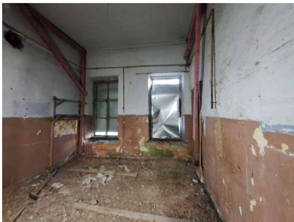
Фото №4. Помещение 2.42 ОКН РЗ «Дом С. Н. Завальевского-М.В. Северова», расположенный по адресу: Санкт-Петербург, муниципальный округ Коломна, пер. Прядильный, д. 12/163, литера А. Дата: 19.04.2025 г.
