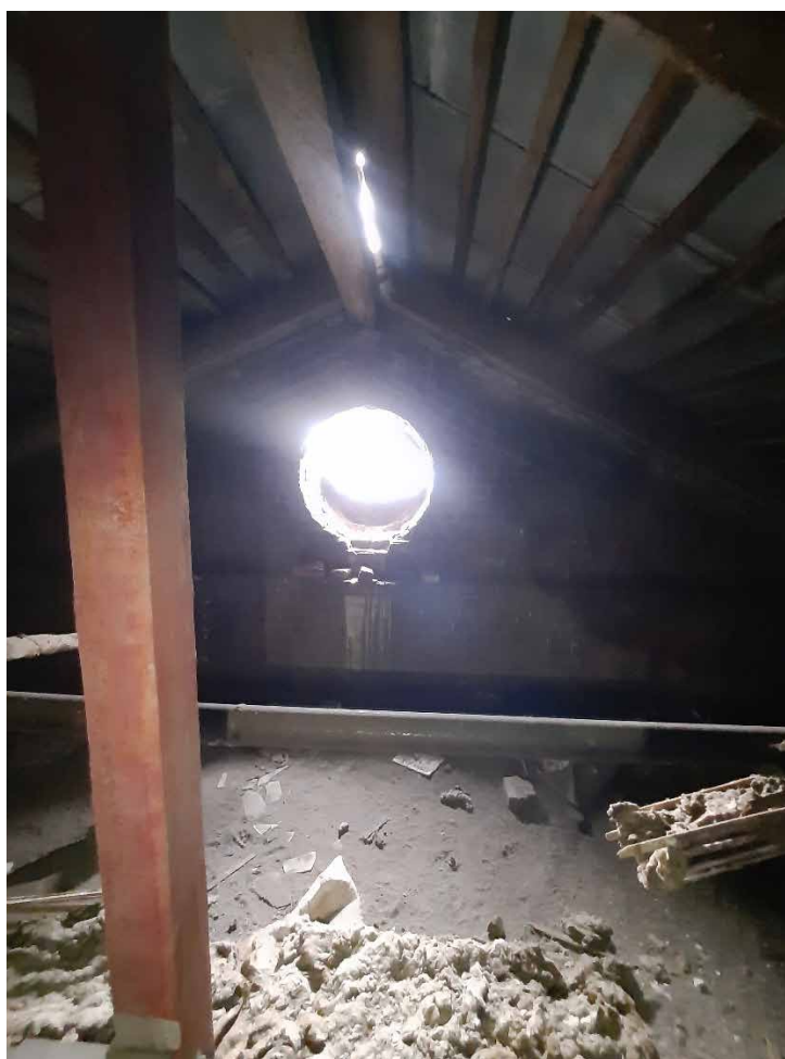
Фото №10. Помещение 4.2. ОКН РЗ «Дом С. Н. Завальевского-М.В. Северова», расположенный по адресу: Санкт-Петербург, муниципальный округ Коломна, пер. Прядильный, д. 12/163, литера А. Дата: 19.04.2025 г.
