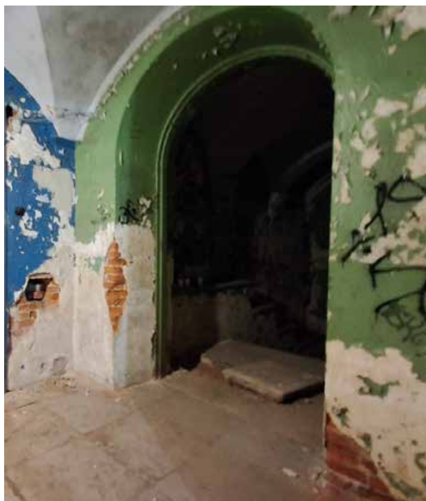
Фото №21. Помещение 1.2 ОКН РЗ «Дом С. Н. Завальевского-М.В. Северова», расположенный по адресу: Санкт-Петербург, муниципальный округ Коломна, пер. Прядильный, д. 12/163, литера А. Дата: 19.04.2025 г.
