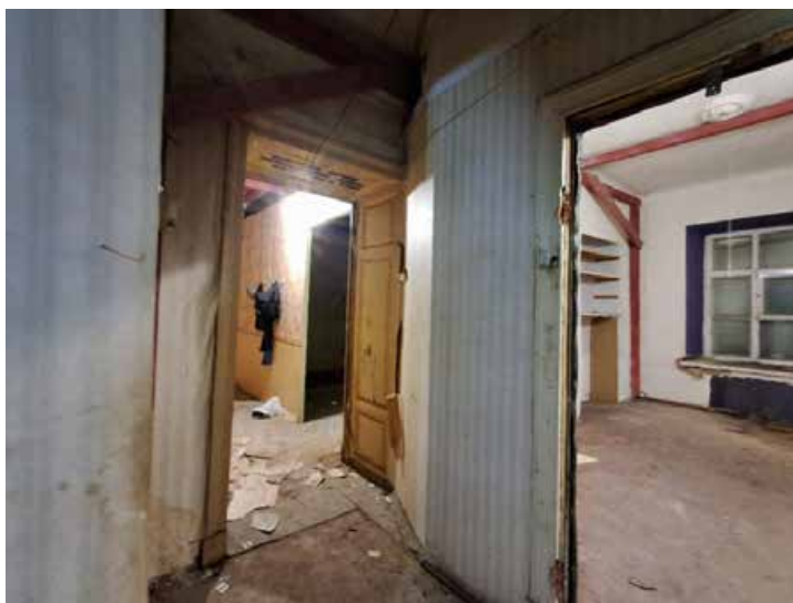
Фото №17. Помещения 1.30 и 1.31 ОКН РЗ «Дом С. Н. Завальевского-М.В. Северова», расположенный по адресу: Санкт-Петербург, муниципальный округ Коломна, пер. Прядильный, д. 12/163, литера А. Дата: 19.04.2025 г.
