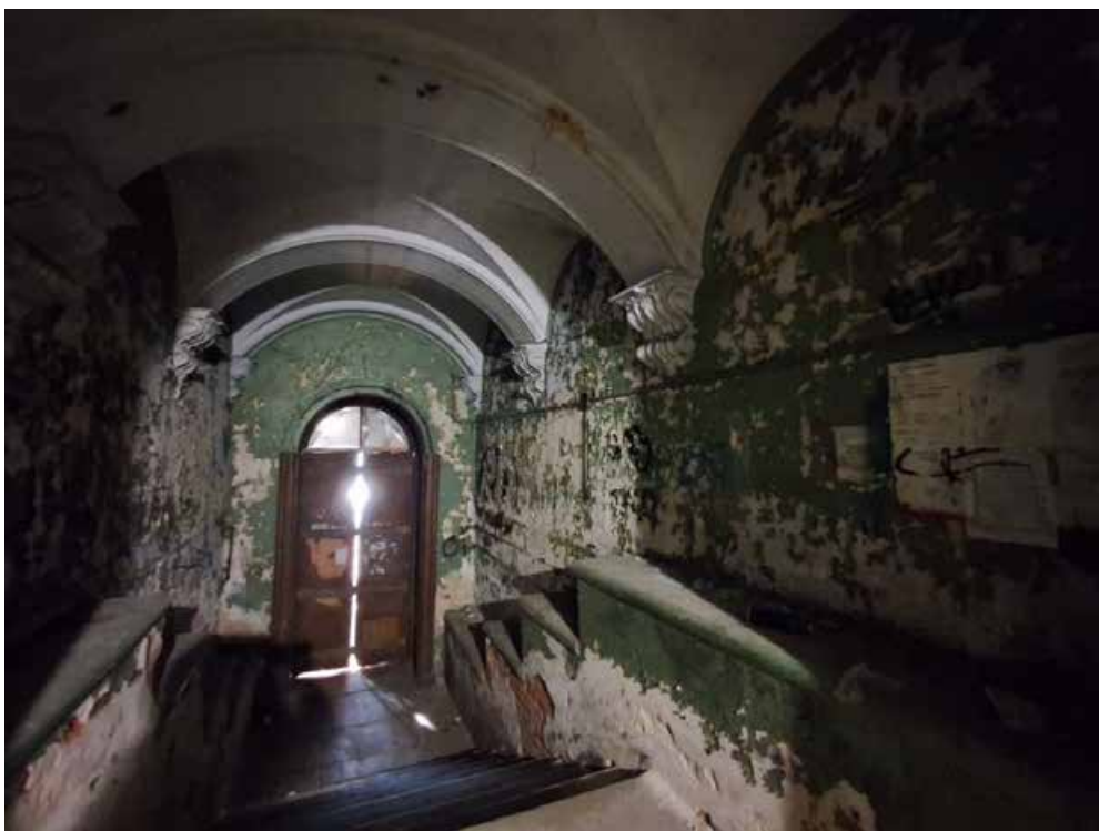
Фото №23. Помещение 1.1 ОКН РЗ «Дом С. Н. Завальевского-М.В. Северова», расположенный по адресу: Санкт-Петербург, муниципальный округ Коломна, пер. Прядильный, д. 12/163, литера А. Дата: 19.04.2025 г.
