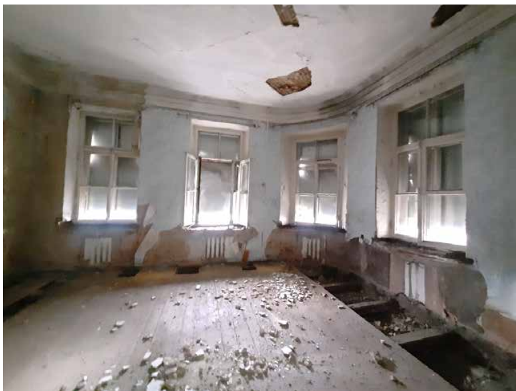
Фото №28. Помещение 3.19 ОКН РЗ «Дом С. Н. Завальевского-М.В. Северова», расположенный по адресу: Санкт-Петербург, муниципальный округ Коломна, пер. Прядильный, д. 12/163, литера А. Дата: 19.04.2025 г.
