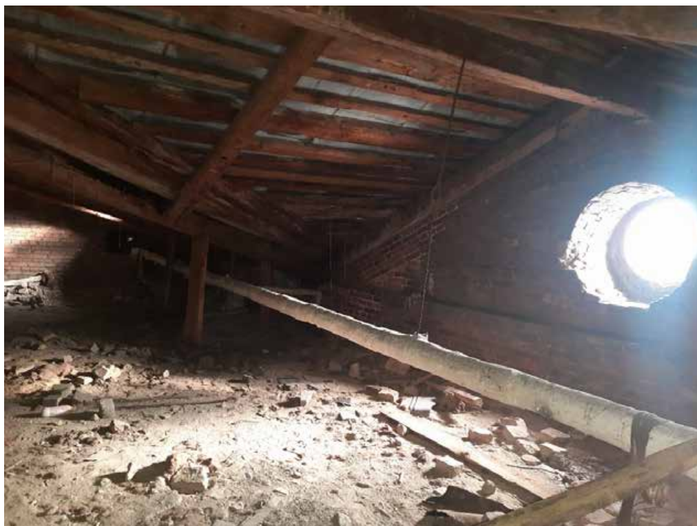
Фото №21. Помещение 4.1. ОКН РЗ «Дом С. Н. Завальевского-М.В. Северова», расположенный по адресу: Санкт-Петербург, муниципальный округ Коломна, пер. Прядильный, д. 12/163, литера А. Дата: 19.04.2025 г.
