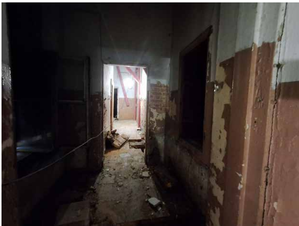
Фото №5. Помещение 2.40 ОКН РЗ «Дом С. Н. Завальевского-М.В. Северова», расположенный по адресу: Санкт-Петербург, муниципальный округ Коломна, пер. Прядильный, д. 12/163, литера А. Дата: 19.04.2025 г.
