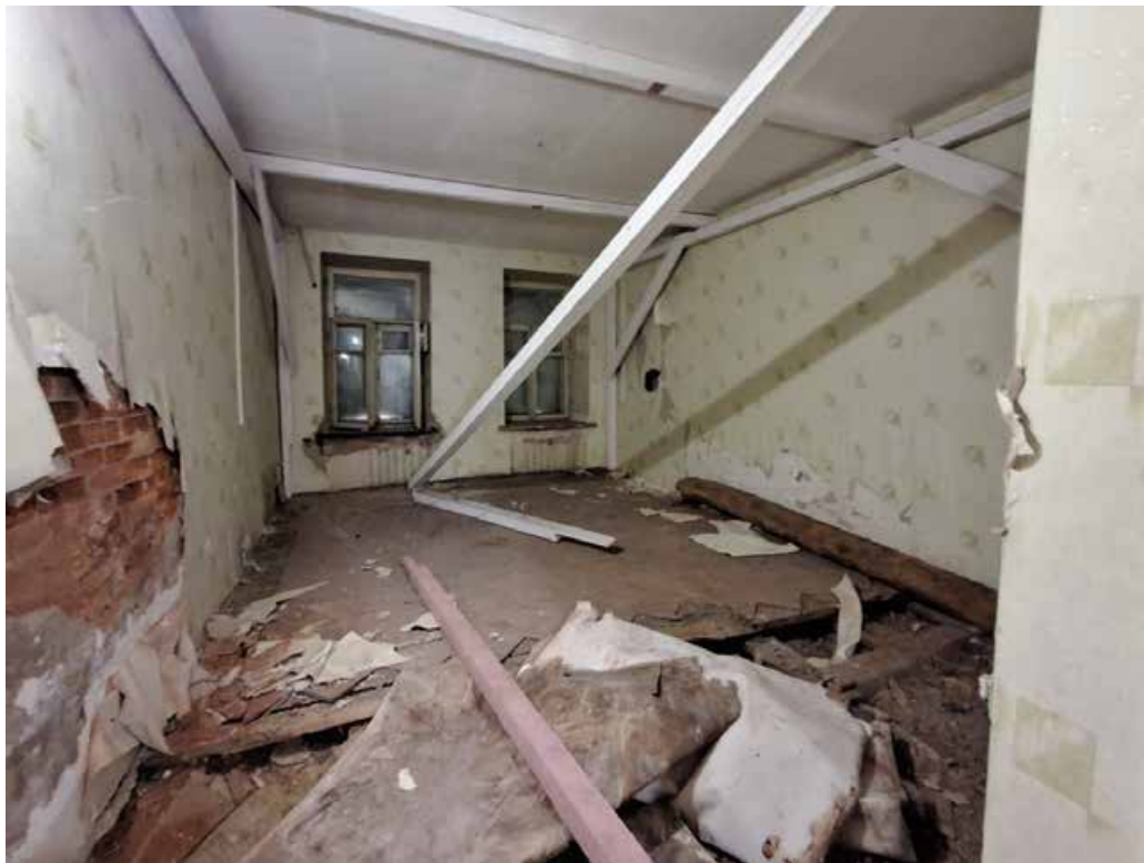
Фото №32. Помещение 1.35 ОКН РЗ «Дом С. Н. Завальевского-М.В. Северова», расположенный по адресу: Санкт-Петербург, муниципальный округ Коломна, пер. Прядильный, д. 12/163, литера А. Дата: 19.04.2025 г.
