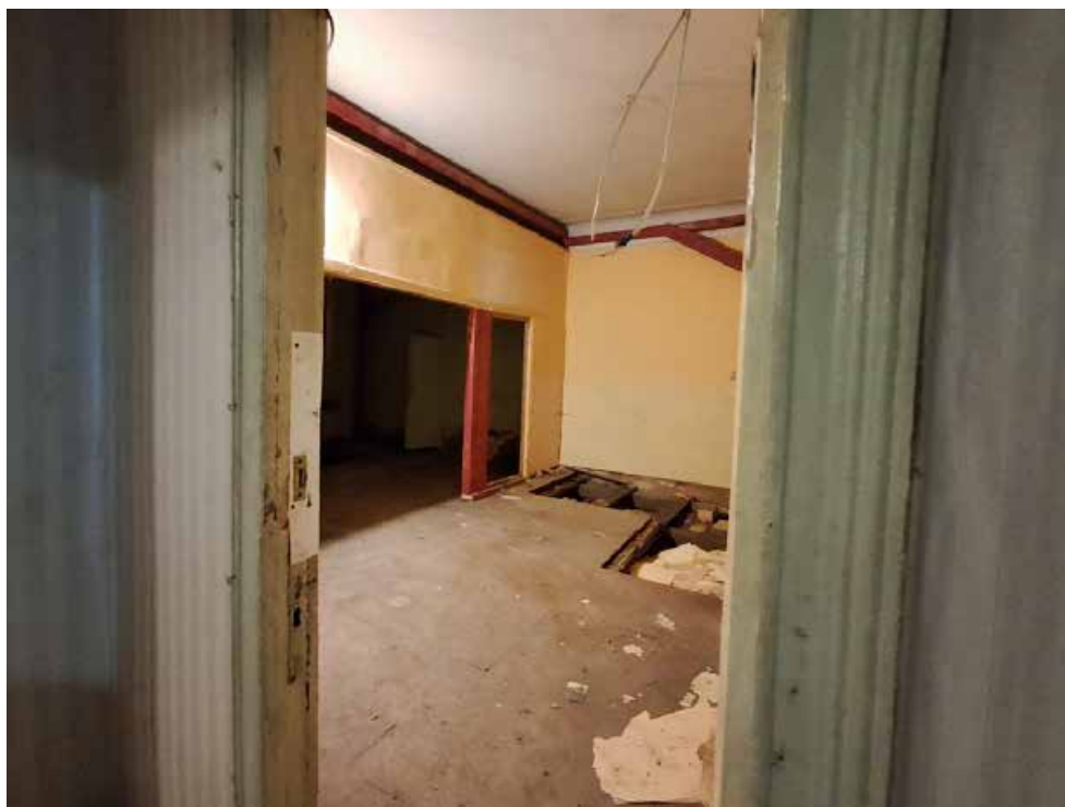
Фото №15. Помещение 1.27 ОКН РЗ «Дом С. Н. Завальевского-М.В. Северова», расположенный по адресу: Санкт-Петербург, муниципальный округ Коломна, пер. Прядильный, д. 12/163, литера А. Дата: 19.04.2025 г.
