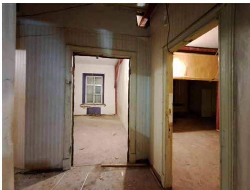
Фото №14. Помещение 1.28 ОКН РЗ «Дом С. Н. Завальевского-М.В. Северова», расположенный по адресу: Санкт-Петербург, муниципальный округ Коломна, пер. Прядильный, д. 12/163, литера А. Дата: 19.04.2025 г.
