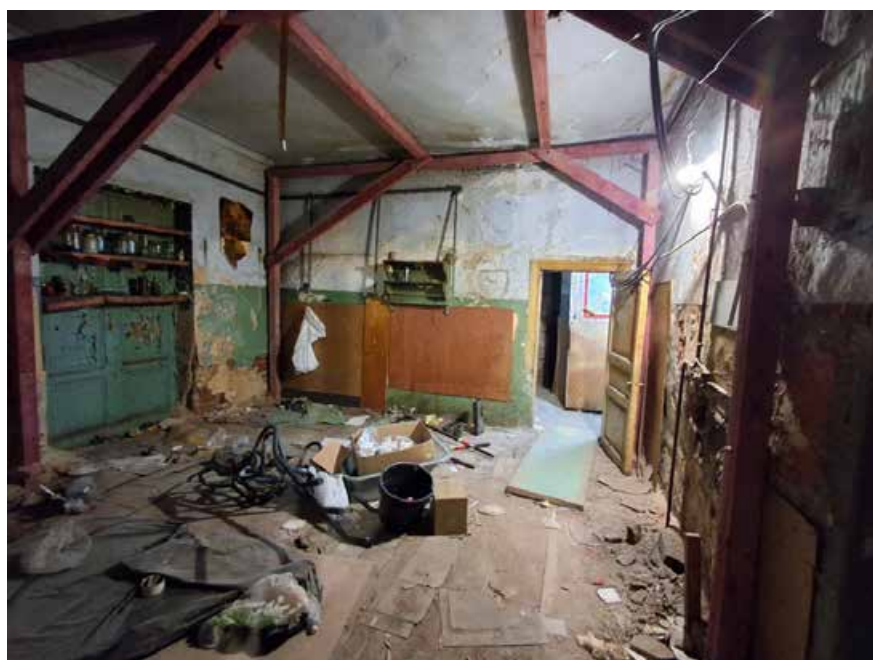
Фото №8. Помещение 1.11 ОКН РЗ «Дом С. Н. Завальевского-М.В. Северова», расположенный по адресу: Санкт-Петербург, муниципальный округ Коломна, пер. Прядильный, д. 12/163, литера А. Дата: 19.04.2025 г.
