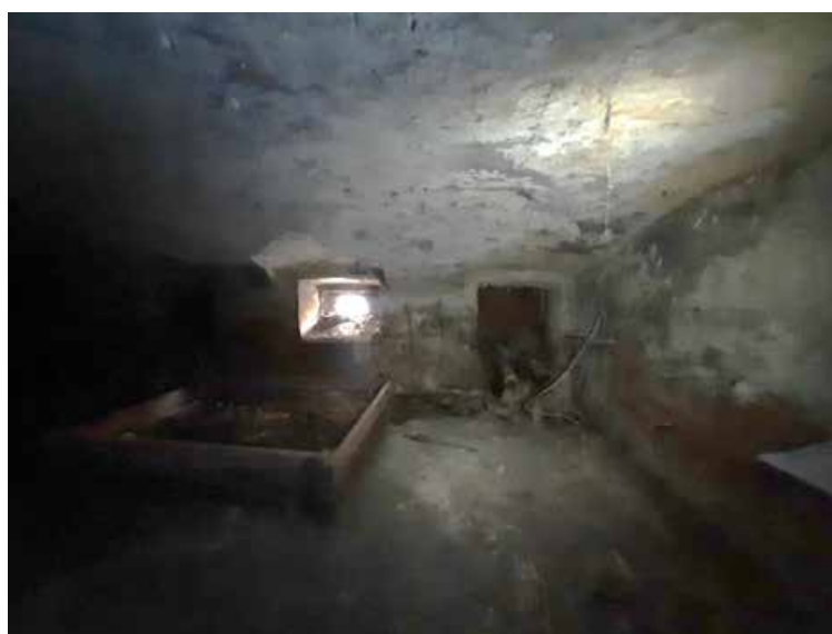
Фото №6. Помещение 0.22 ОКН РЗ «Дом С. Н. Завальевского-М.В. Северова», расположенный по адресу: Санкт-Петербург, муниципальный округ Коломна, пер. Прядильный, д. 12/163, литера А. Дата: 19.04.2025 г.
