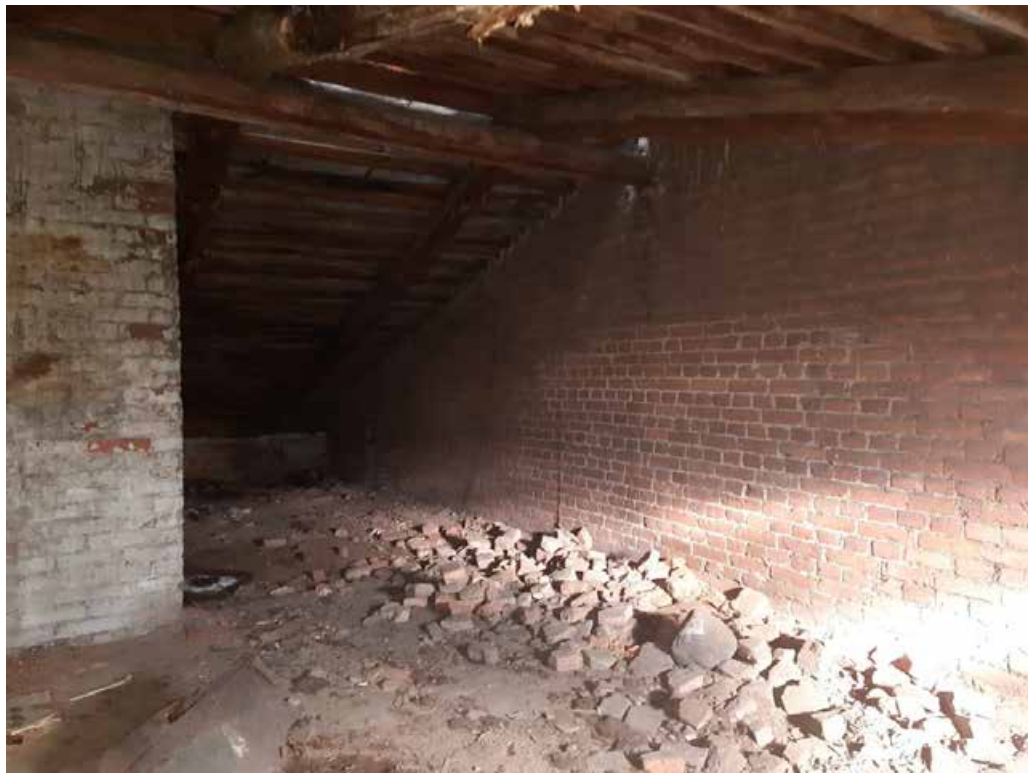
Фото №24. Помещение 4.1. ОКН РЗ «Дом С. Н. Завальевского-М.В. Северова», расположенный по адресу: Санкт-Петербург, муниципальный округ Коломна, пер. Прядильный, д. 12/163, литера А. Дата: 19.04.2025 г.
