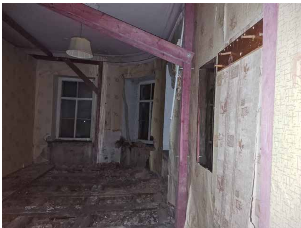
Фото №12. Помещение 1.25 ОКН РЗ «Дом С. Н. Завальевского-М.В. Северова», расположенный по адресу: Санкт-Петербург, муниципальный округ Коломна, пер. Прядильный, д. 12/163, литера А. Дата: 19.04.2025 г.
