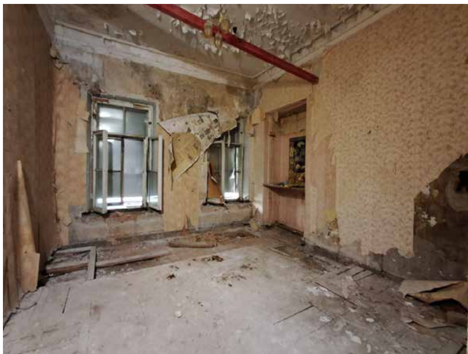
Фото №11. Помещение 2.47 ОКН РЗ «Дом С. Н. Завальевского-М.В. Северова», расположенный по адресу: Санкт-Петербург, муниципальный округ Коломна, пер. Прядильный, д. 12/163, литера А. Дата: 19.04.2025 г.
