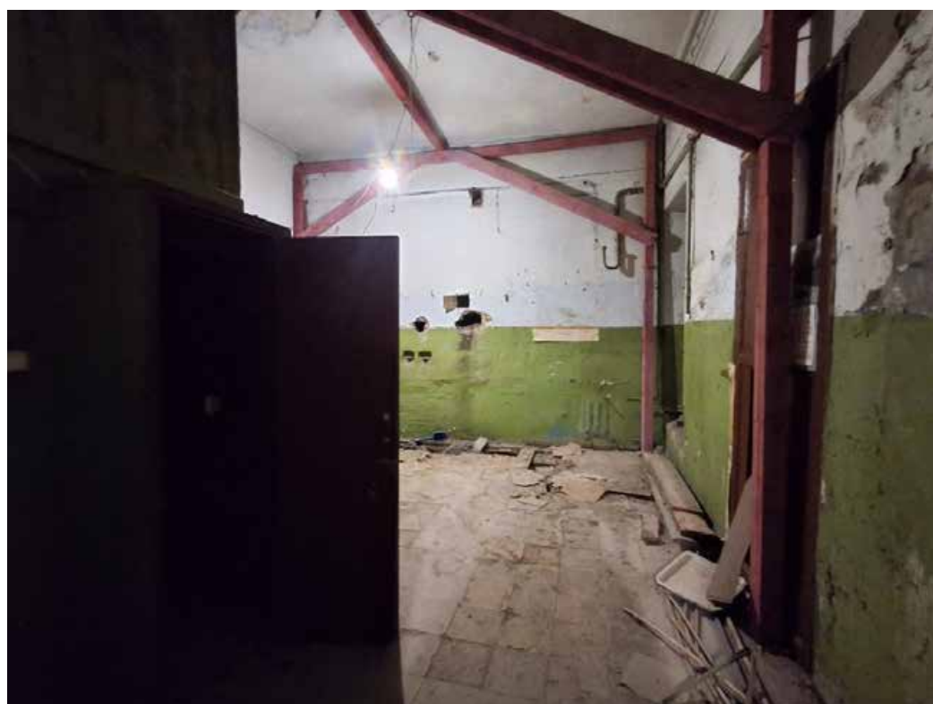
Фото №26. Помещение 2.7 ОКН РЗ «Дом С. Н. Завальевского-М.В. Северова», расположенный по адресу: Санкт-Петербург, муниципальный округ Коломна, пер. Прядильный, д. 12/163, литера А. Дата: 19.04.2025 г.
