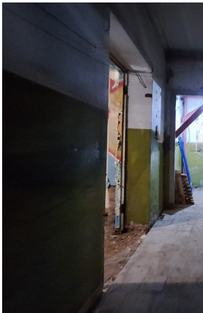
Фото №13. Помещения 2.49 и 2.51 ОКН РЗ «Дом С. Н. Завальевского-М.В. Северова», расположенный по адресу: Санкт-Петербург, муниципальный округ Коломна, пер. Прядильный, д. 12/163, литера А. Дата: 19.04.2025 г.
