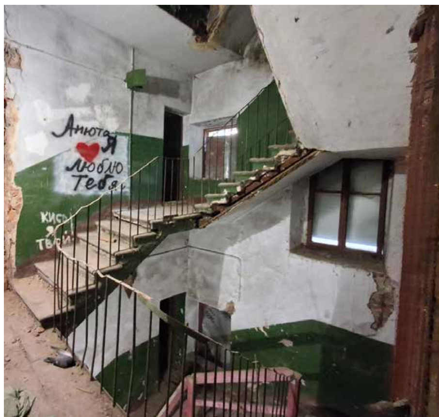
Фото №28. Помещение 2.9 ОКН РЗ «Дом С. Н. Завальевского-М.В. Северова», расположенный по адресу: Санкт-Петербург, муниципальный округ Коломна, пер. Прядильный, д. 12/163, литера А. Дата: 19.04.2025 г.
