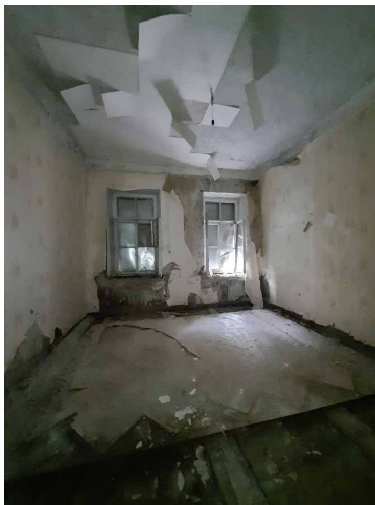
Фото №2. Помещение 3.45 ОКН РЗ «Дом С. Н. Завальевского-М.В. Северова», расположенный по адресу: Санкт-Петербург, муниципальный округ Коломна, пер. Прядильный, д. 12/163, литера А. Дата: 19.04.2025 г.
