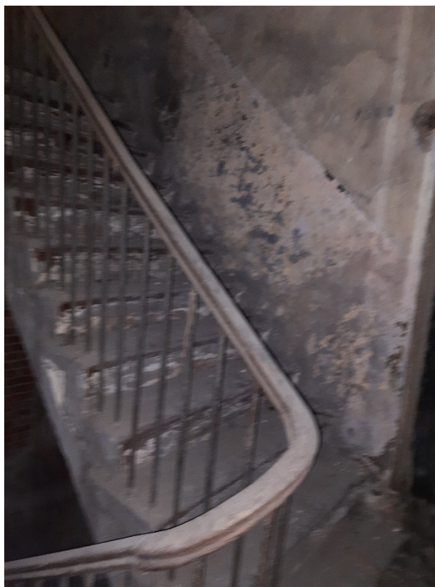
Фото №33. Помещение 2.16 ОКН РЗ «Дом С. Н. Завальевского-М.В. Северова», расположенный по адресу: Санкт-Петербург, муниципальный округ Коломна, пер. Прядильный, д. 12/163, литера А. Дата: 19.04.2025 г.
