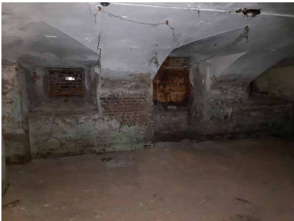
Фото №13. Помещение 0.3 ОКН РЗ «Дом С. Н. Завальевского-М.В. Северова», расположенный по адресу: Санкт-Петербург, муниципальный округ Коломна, пер. Прядильный, д. 12/163, литера А. Дата: 19.04.2025 г.
