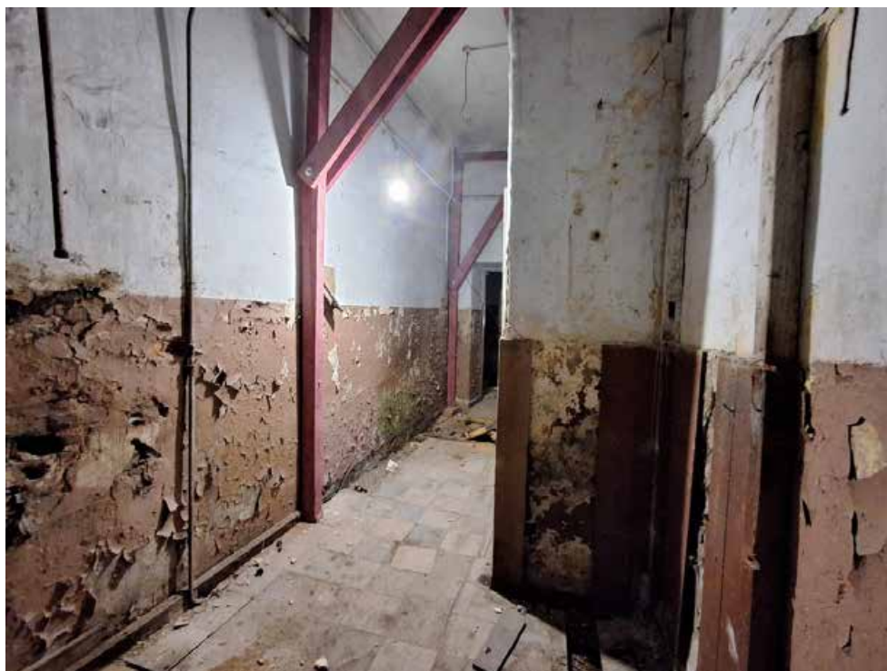
Фото №2. Помещение 2.41 ОКН РЗ «Дом С. Н. Завальевского-М.В. Северова», расположенный по адресу: Санкт-Петербург, муниципальный округ Коломна, пер. Прядильный, д. 12/163, литера А. Дата: 19.04.2025 г.
