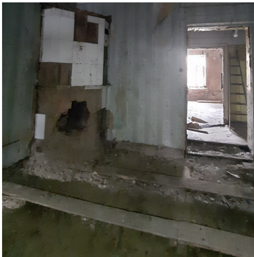
Фото №17. Помещение 3.27 ОКН РЗ «Дом С. Н. Завальевского-М.В. Северова», расположенный по адресу: Санкт-Петербург, муниципальный округ Коломна, пер. Прядильный, д. 12/163, литера А. Дата: 19.04.2025 г.
