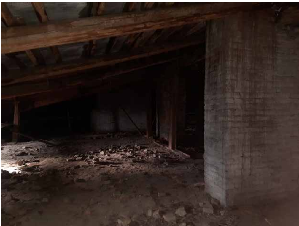
Фото №25. Помещение 4.1. ОКН РЗ «Дом С. Н. Завальевского-М.В. Северова», расположенный по адресу: Санкт-Петербург, муниципальный округ Коломна, пер. Прядильный, д. 12/163, литера А. Дата: 19.04.2025 г.
