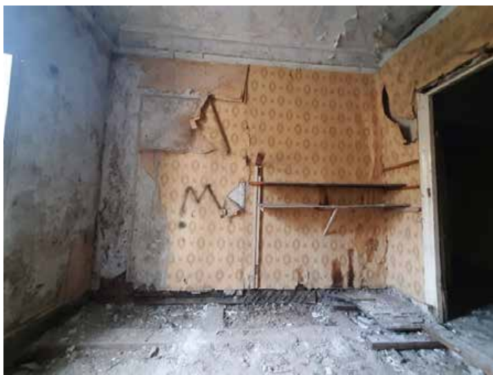
Фото №1. Помещение 3.47 ОКН РЗ «Дом С. Н. Завальевского-М.В. Северова», расположенный по адресу: Санкт-Петербург, муниципальный округ Коломна, пер. Прядильный, д. 12/163, литера А. Дата: 19.04.2025 г.
