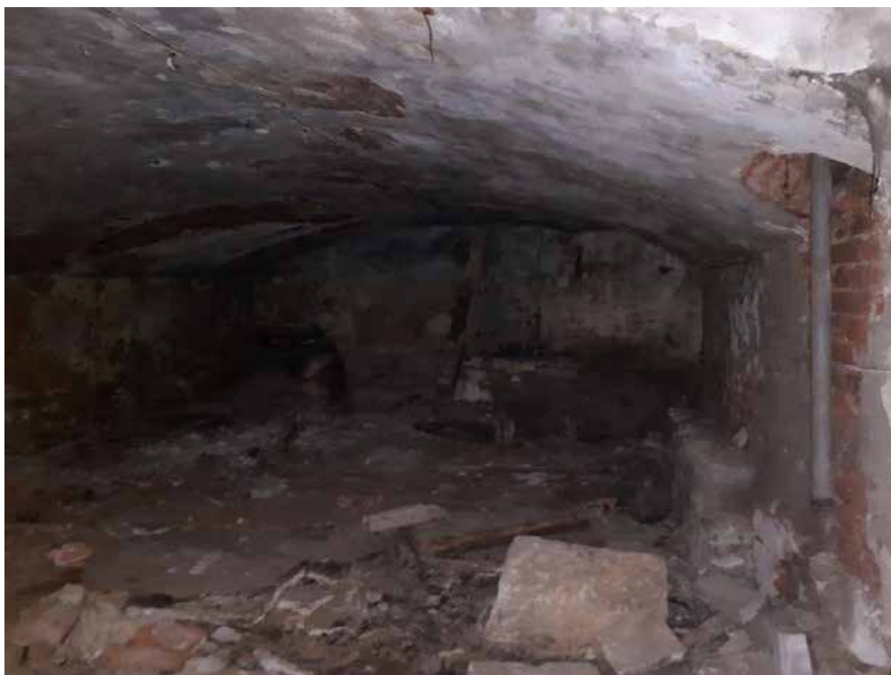
Фото №19. Помещение 0.14 ОКН РЗ «Дом С. Н. Завальевского-М.В. Северова», расположенный по адресу: Санкт-Петербург, муниципальный округ Коломна, пер. Прядильный, д. 12/163, литера А. Дата: 19.04.2025 г.
