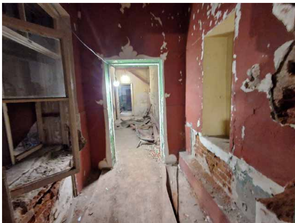
Фото №36. Помещения 1.41 и 1.42 ОКН РЗ «Дом С. Н. Завальевского-М.В. Северова», расположенный по адресу: Санкт-Петербург, муниципальный округ Коломна, пер. Прядильный, д. 12/163, литера А. Дата: 19.04.2025 г.
