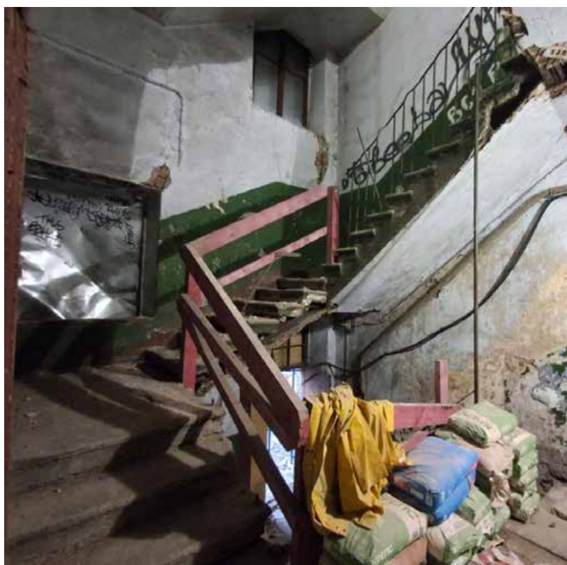
Фото №6. Помещение 1.12 ОКН РЗ «Дом С. Н. Завальевского-М.В. Северова», расположенный по адресу: Санкт-Петербург, муниципальный округ Коломна, пер. Прядильный, д. 12/163, литера А. Дата: 19.04.2025 г.
