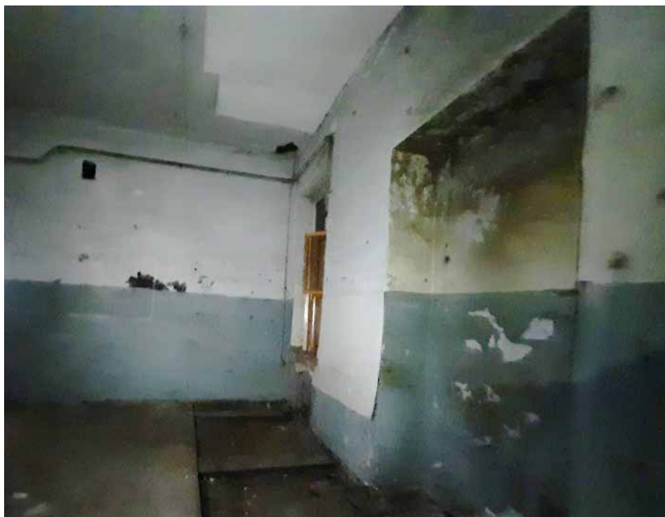
Фото №39. Помещение 3.7 ОКН РЗ «Дом С. Н. Завальевского-М.В. Северова», расположенный по адресу: Санкт-Петербург, муниципальный округ Коломна, пер. Прядильный, д. 12/163, литера А. Дата: 19.04.2025 г.
