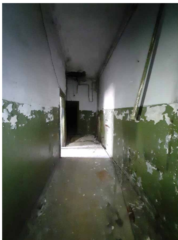
Фото №8. Помещение 3.36 ОКН РЗ «Дом С. Н. Завальевского-М.В. Северова», расположенный по адресу: Санкт-Петербург, муниципальный округ Коломна, пер. Прядильный, д. 12/163, литера А. Дата: 19.04.2025 г.
