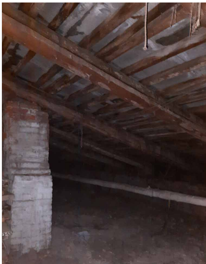
Фото №16. Помещение 4.1. ОКН РЗ «Дом С. Н. Завальевского-М.В. Северова», расположенный по адресу: Санкт-Петербург, муниципальный округ Коломна, пер. Прядильный, д. 12/163, литера А. Дата: 19.04.2025 г.
