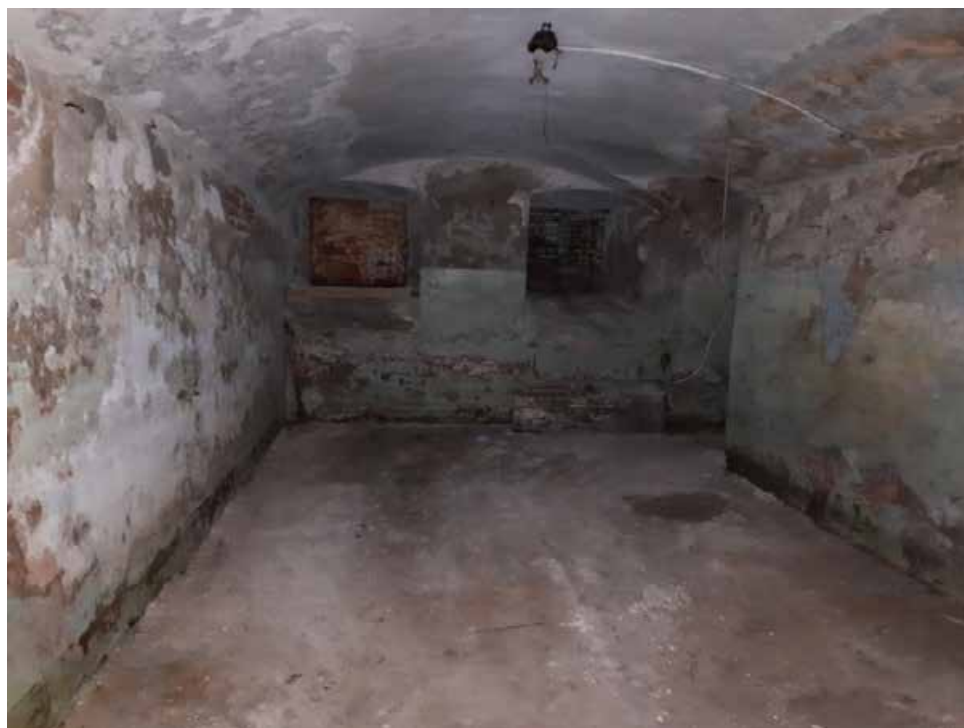
Фото №12. Помещение 0.2 ОКН РЗ «Дом С. Н. Завальевского-М.В. Северова», расположенный по адресу: Санкт-Петербург, муниципальный округ Коломна, пер. Прядильный, д. 12/163, литера А. Дата: 19.04.2025 г.
