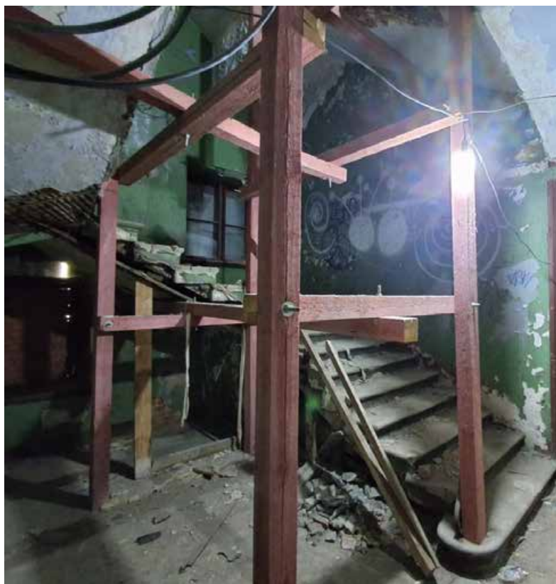
Фото №19. Помещение 1.3 ОКН РЗ «Дом С. Н. Завальевского-М.В. Северова», расположенный по адресу: Санкт-Петербург, муниципальный округ Коломна, пер. Прядильный, д. 12/163, литера А. Дата: 19.04.2025 г.
