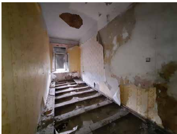
Фото №20. Помещение 3.25 ОКН РЗ «Дом С. Н. Завальевского-М.В. Северова», расположенный по адресу: Санкт-Петербург, муниципальный округ Коломна, пер. Прядильный, д. 12/163, литера А. Дата: 19.04.2025 г.
