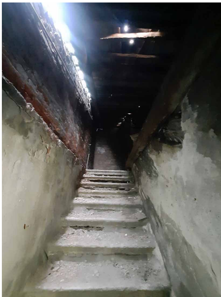
Фото №1. Помещение 4.2. ОКН РЗ «Дом С. Н. Завальевского-М.В. Северова», расположенный по адресу: Санкт-Петербург, муниципальный округ Коломна, пер. Прядильный, д. 12/163, литера А. Дата: 19.04.2025 г.
