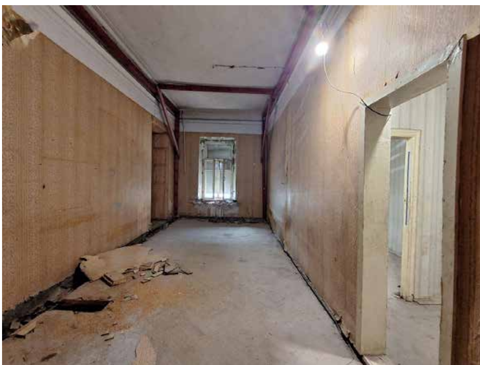
Фото №22. Помещения 2.27, 2.28 и 2.26 ОКН РЗ «Дом С. Н. Завальевского-М.В. Северова», расположенный по адресу: Санкт-Петербург, муниципальный округ Коломна, пер. Прядильный, д. 12/163, литера А. Дата: 19.04.2025 г.
