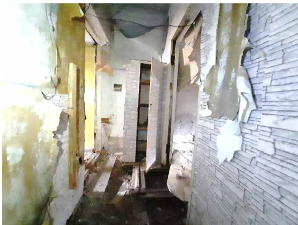
Фото №24. Помещение 3.23 ОКН РЗ «Дом С. Н. Завальевского-М.В. Северова», расположенный по адресу: Санкт-Петербург, муниципальный округ Коломна, пер. Прядильный, д. 12/163, литера А. Дата: 19.04.2025 г.
