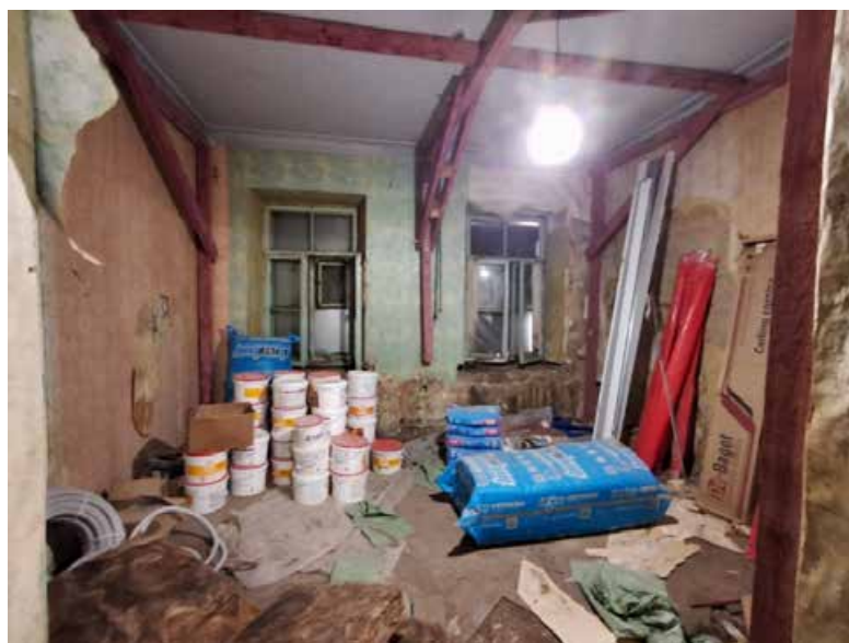
Фото №5. Помещение 1.20 ОКН РЗ «Дом С. Н. Завальевского-М.В. Северова», расположенный по адресу: Санкт-Петербург, муниципальный округ Коломна, пер. Прядильный, д. 12/163, литера А. Дата: 19.04.2025 г.
