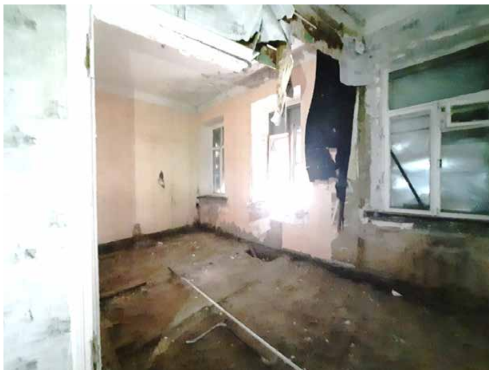
Фото №30. Помещение 3.17 ОКН РЗ «Дом С. Н. Завальевского-М.В. Северова», расположенный по адресу: Санкт-Петербург, муниципальный округ Коломна, пер. Прядильный, д. 12/163, литера А. Дата: 19.04.2025 г.
