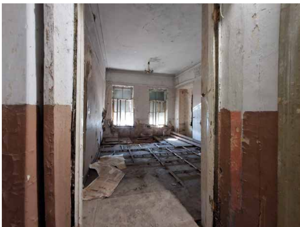
Фото №8. Помещение 2.34 ОКН РЗ «Дом С. Н. Завальевского-М.В. Северова», расположенный по адресу: Санкт-Петербург, муниципальный округ Коломна, пер. Прядильный, д. 12/163, литера А. Дата: 19.04.2025 г.
