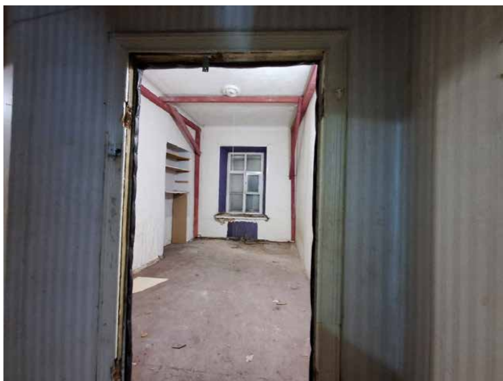
Фото №16. Помещение 1.29 ОКН РЗ «Дом С. Н. Завальевского-М.В. Северова», расположенный по адресу: Санкт-Петербург, муниципальный округ Коломна, пер. Прядильный, д. 12/163, литера А. Дата: 19.04.2025 г.
