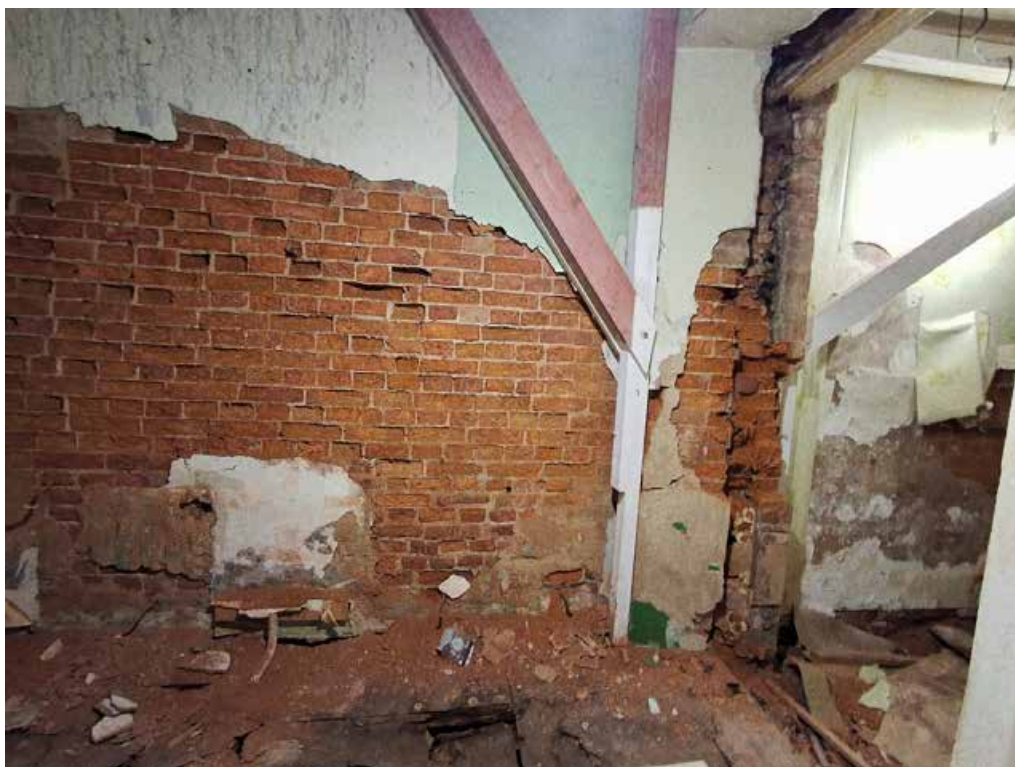
Фото №31. Помещение 1.37 ОКН РЗ «Дом С. Н. Завальевского-М.В. Северова», расположенный по адресу: Санкт-Петербург, муниципальный округ Коломна, пер. Прядильный, д. 12/163, литера А. Дата: 19.04.2025 г.
