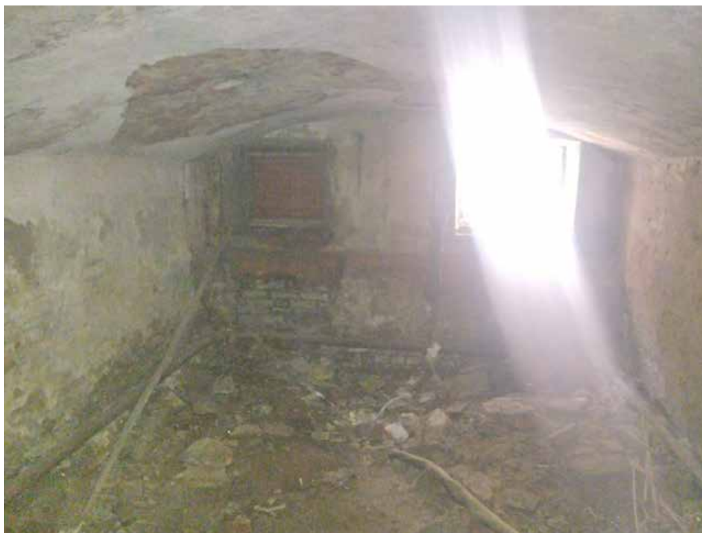
Фото №21. Помещение 0.15 ОКН РЗ «Дом С. Н. Завальевского-М.В. Северова», расположенный по адресу: Санкт-Петербург, муниципальный округ Коломна, пер. Прядильный, д. 12/163, литера А. Дата: 19.04.2025 г.
