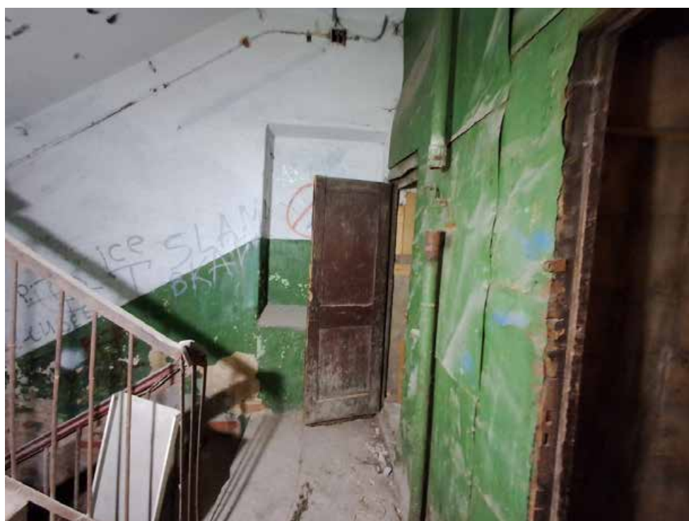
Фото №38. Помещение 1.44 ОКН РЗ «Дом С. Н. Завальевского-М.В. Северова», расположенный по адресу: Санкт-Петербург, муниципальный округ Коломна, пер. Прядильный, д. 12/163, литера А. Дата: 19.04.2025 г.
