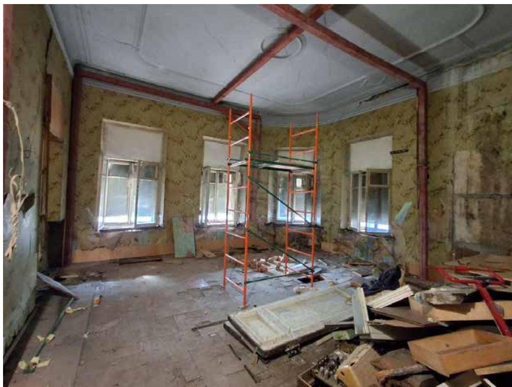
Фото №25. Помещение 2.24 ОКН РЗ «Дом С. Н. Завальевского-М.В. Северова», расположенный по адресу: Санкт-Петербург, муниципальный округ Коломна, пер. Прядильный, д. 12/163, литера А. Дата: 19.04.2025 г.
