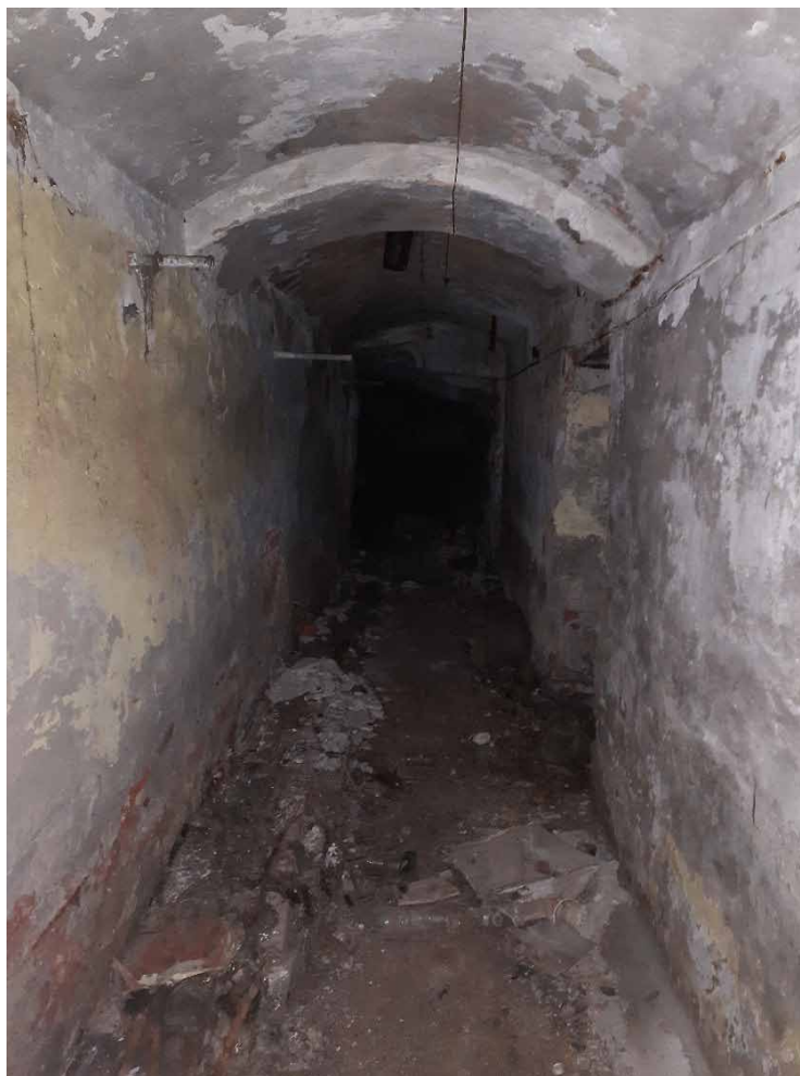
Фото №17. Помещение 0.12 ОКН РЗ «Дом С. Н. Завальевского-М.В. Северова», расположенный по адресу: Санкт-Петербург, муниципальный округ Коломна, пер. Прядильный, д. 12/163, литера А. Дата: 19.04.2025 г.
