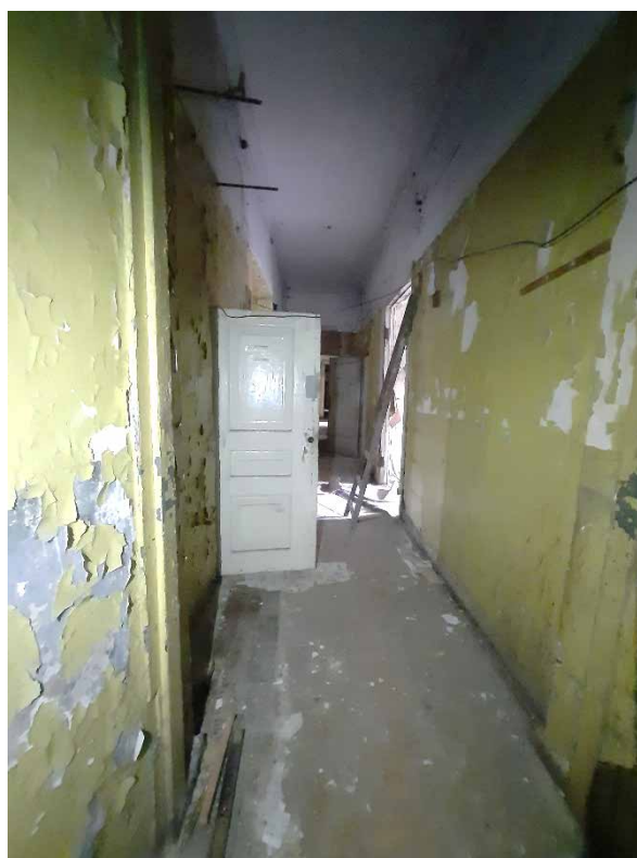
Фото №14. Помещение 3.43 ОКН РЗ «Дом С. Н. Завальевского-М.В. Северова», расположенный по адресу: Санкт-Петербург, муниципальный округ Коломна, пер. Прядильный, д. 12/163, литера А. Дата: 19.04.2025 г.
