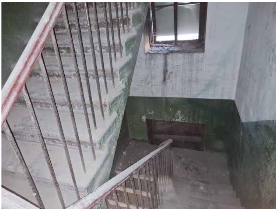
Фото №1. Помещение 2.44 ОКН РЗ «Дом С. Н. Завальевского-М.В. Северова», расположенный по адресу: Санкт-Петербург, муниципальный округ Коломна, пер. Прядильный, д. 12/163, литера А. Дата: 19.04.2025 г.
