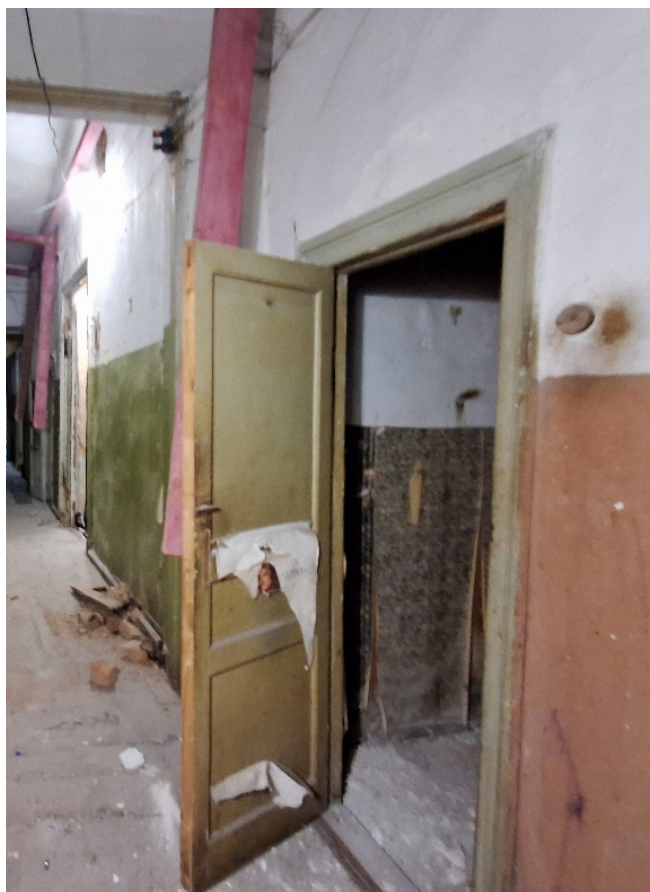
Фото №10. Помещение 2.46 ОКН РЗ «Дом С. Н. Завальевского-М.В. Северова», расположенный по адресу: Санкт-Петербург, муниципальный округ Коломна, пер. Прядильный, д. 12/163, литера А. Дата: 19.04.2025 г.
