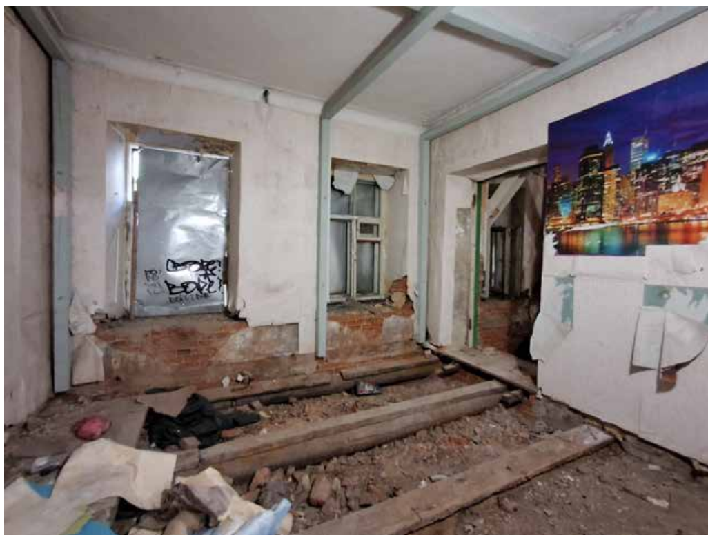
Фото №25. Помещение 1.49 ОКН РЗ «Дом С. Н. Завальевского-М.В. Северова», расположенный по адресу: Санкт-Петербург, муниципальный округ Коломна, пер. Прядильный, д. 12/163, литера А. Дата: 19.04.2025 г.
