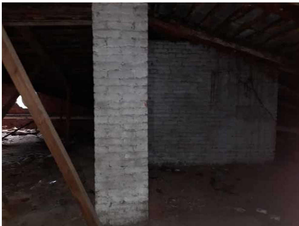
Фото №18. Помещение 4.1. ОКН РЗ «Дом С. Н. Завальевского-М.В. Северова», расположенный по адресу: Санкт-Петербург, муниципальный округ Коломна, пер. Прядильный, д. 12/163, литера А. Дата: 19.04.2025 г.
