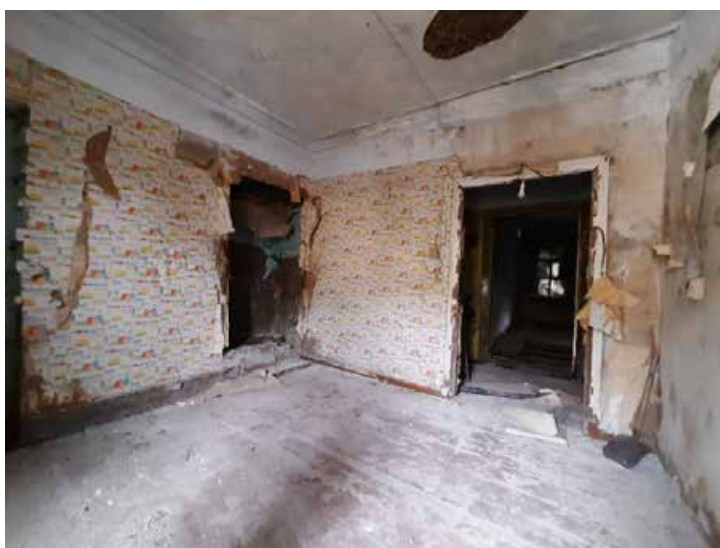
Фото №4. Помещение 3.42 ОКН РЗ «Дом С. Н. Завальевского-М.В. Северова», расположенный по адресу: Санкт-Петербург, муниципальный округ Коломна, пер. Прядильный, д. 12/163, литера А. Дата: 19.04.2025 г.
