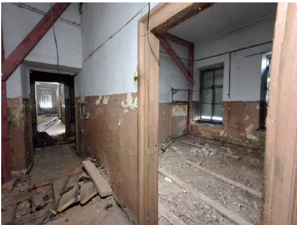
Фото №3. Помещение 2.41 ОКН РЗ «Дом С. Н. Завальевского-М.В. Северова», расположенный по адресу: Санкт-Петербург, муниципальный округ Коломна, пер. Прядильный, д. 12/163, литера А. Дата: 19.04.2025 г.
