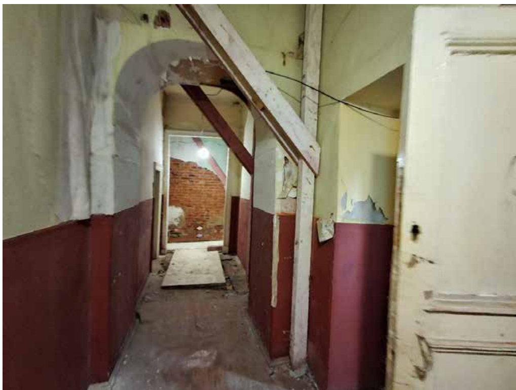
Фото №29. Помещение 1.47 ОКН РЗ «Дом С. Н. Завальевского-М.В. Северова», расположенный по адресу: Санкт-Петербург, муниципальный округ Коломна, пер. Прядильный, д. 12/163, литера А. Дата: 19.04.2025 г.
