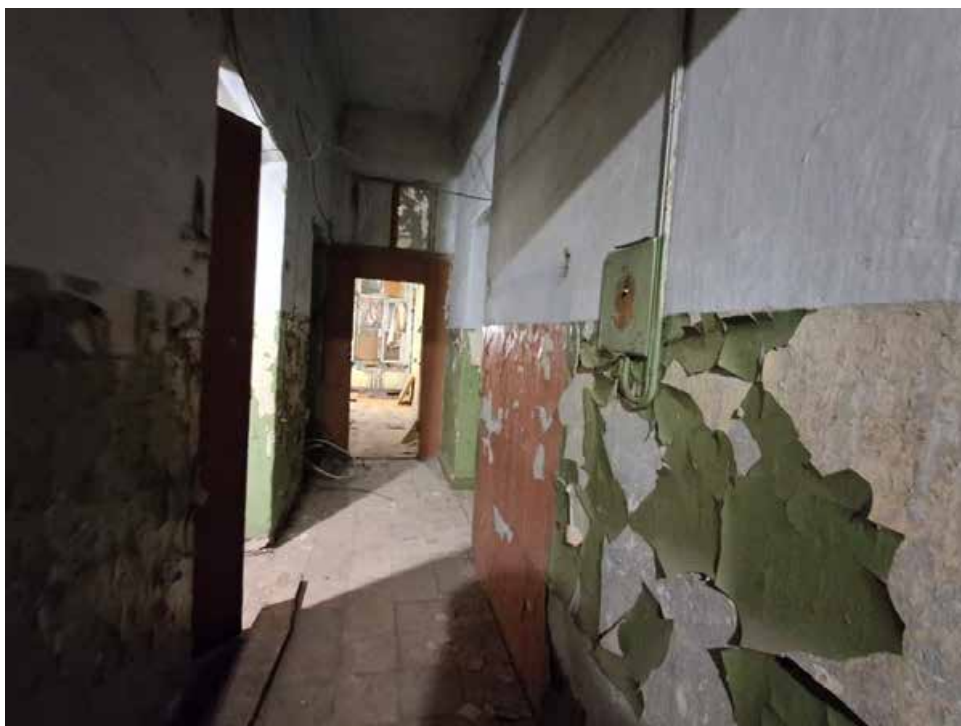
Фото №29. Помещение 2.11 ОКН РЗ «Дом С. Н. Завальевского-М.В. Северова», расположенный по адресу: Санкт-Петербург, муниципальный округ Коломна, пер. Прядильный, д. 12/163, литера А. Дата: 19.04.2025 г.
