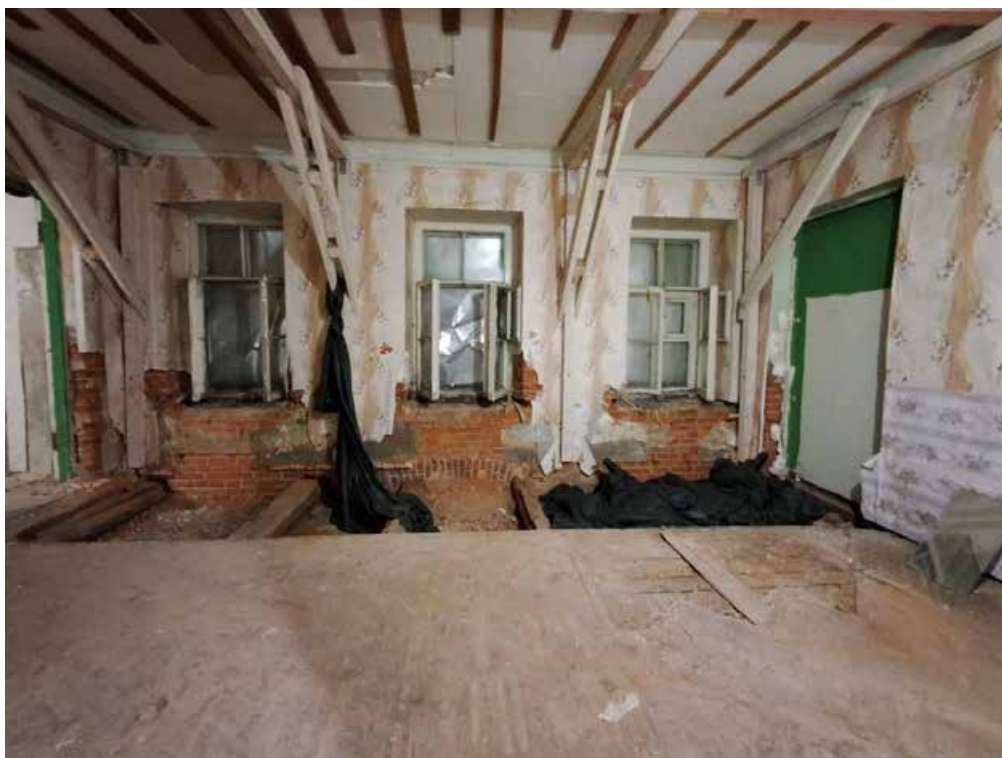
Фото №27. Помещение 1.48 ОКН РЗ «Дом С. Н. Завальевского-М.В. Северова», расположенный по адресу: Санкт-Петербург, муниципальный округ Коломна, пер. Прядильный, д. 12/163, литера А. Дата: 19.04.2025 г.
