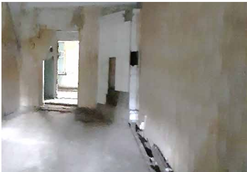
Фото №26. Помещение 3.21 ОКН РЗ «Дом С. Н. Завальевского-М.В. Северова», расположенный по адресу: Санкт-Петербург, муниципальный округ Коломна, пер. Прядильный, д. 12/163, литера А. Дата: 19.04.2025 г.
