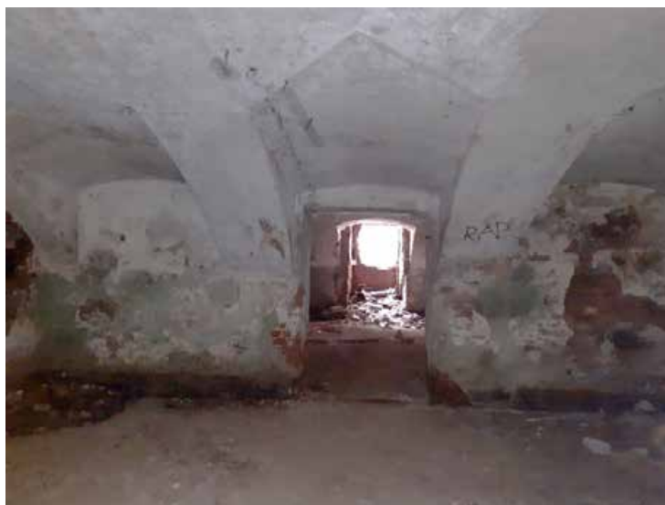
Фото №9. Помещения 0.25 и 0.19 ОКН РЗ «Дом С. Н. Завальевского-М.В. Северова», расположенный по адресу: Санкт-Петербург, муниципальный округ Коломна, пер. Прядильный, д. 12/163, литера А. Дата: 19.04.2025 г.
