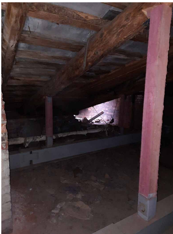
Фото №12. Помещение 4.2. ОКН РЗ «Дом С. Н. Завальевского-М.В. Северова», расположенный по адресу: Санкт-Петербург, муниципальный округ Коломна, пер. Прядильный, д. 12/163, литера А. Дата: 19.04.2025 г.
