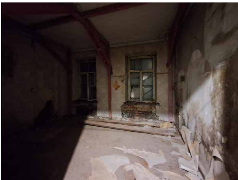
Фото №2. Помещение 1.19 ОКН РЗ «Дом С. Н. Завальевского-М.В. Северова», расположенный по адресу: Санкт-Петербург, муниципальный округ Коломна, пер. Прядильный, д. 12/163, литера А. Дата: 19.04.2025 г.
