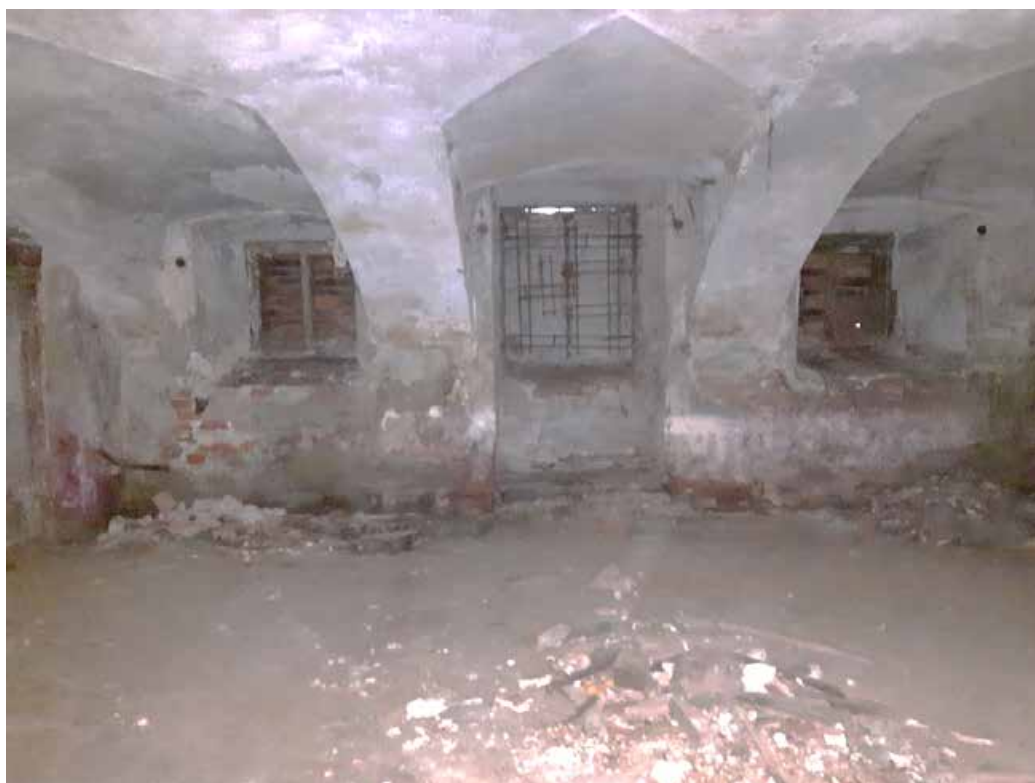
Фото №8. Помещение 0.25 ОКН РЗ «Дом С. Н. Завальевского-М.В. Северова», расположенный по адресу: Санкт-Петербург, муниципальный округ Коломна, пер. Прядильный, д. 12/163, литера А. Дата: 19.04.2025 г.
