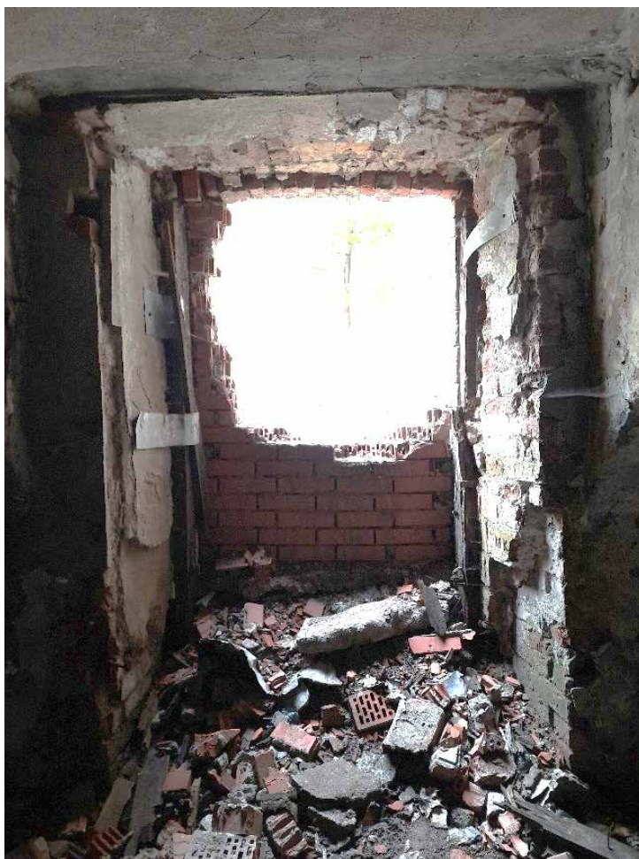
Фото №1. Помещение 0.19 ОКН РЗ «Дом С. Н. Завальевского-М.В. Северова», расположенный по адресу: Санкт-Петербург, муниципальный округ Коломна, пер. Прядильный, д. 12/163, литера А. Дата: 19.04.2025 г.
