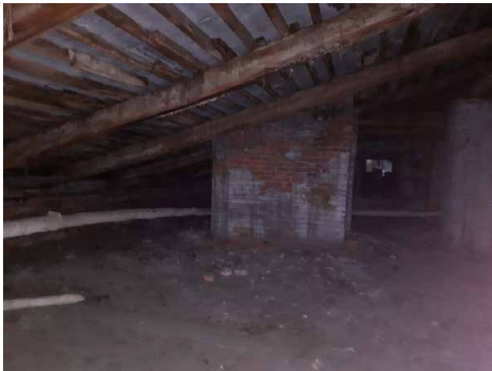
Фото №17. Помещение 4.1. ОКН РЗ «Дом С. Н. Завальевского-М.В. Северова», расположенный по адресу: Санкт-Петербург, муниципальный округ Коломна, пер. Прядильный, д. 12/163, литера А. Дата: 19.04.2025 г.
