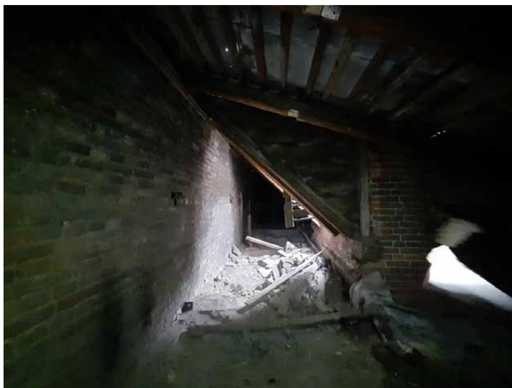
Фото №4. Помещение 4.2. ОКН РЗ «Дом С. Н. Завальевского-М.В. Северова», расположенный по адресу: Санкт-Петербург, муниципальный округ Коломна, пер. Прядильный, д. 12/163, литера А. Дата: 19.04.2025 г.
