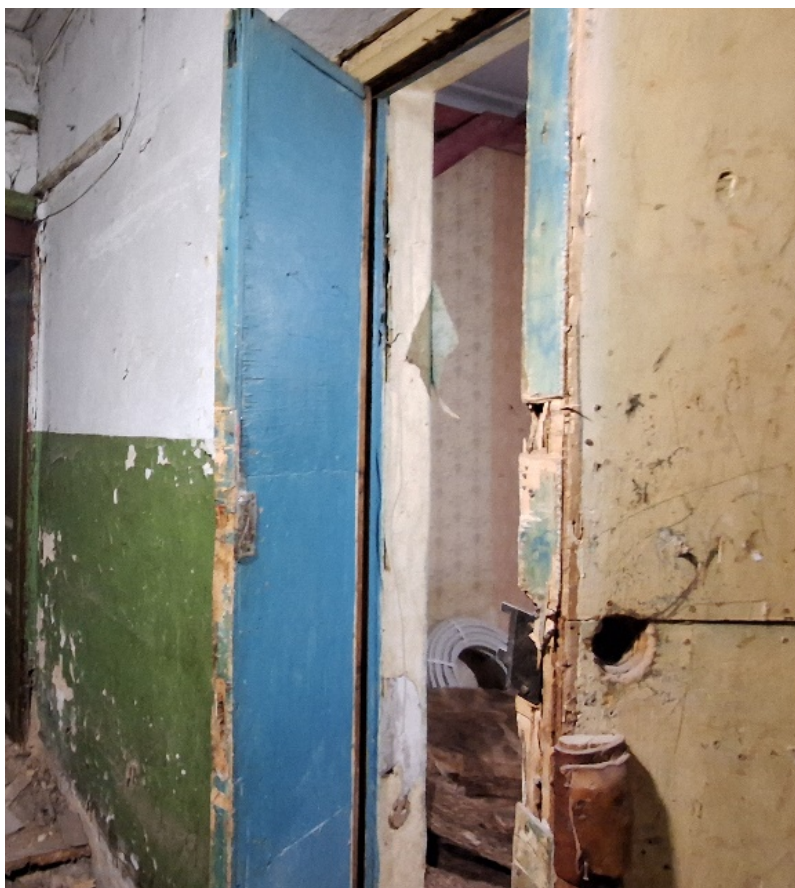
Фото №4. Помещение 1.14 ОКН РЗ «Дом С. Н. Завальевского-М.В. Северова», расположенный по адресу: Санкт-Петербург, муниципальный округ Коломна, пер. Прядильный, д. 12/163, литера А. Дата: 19.04.2025 г.
