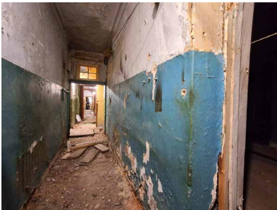
Фото №1. Помещение 1.14 ОКН РЗ «Дом С. Н. Завальевского-М.В. Северова», расположенный по адресу: Санкт-Петербург, муниципальный округ Коломна, пер. Прядильный, д. 12/163, литера А. Дата: 19.04.2025 г.
