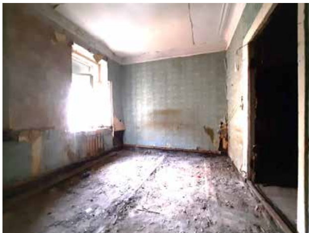
Фото №41. Помещение 3.3 ОКН РЗ «Дом С. Н. Завальевского-М.В. Северова», расположенный по адресу: Санкт-Петербург, муниципальный округ Коломна, пер. Прядильный, д. 12/163, литера А. Дата: 19.04.2025 г.
