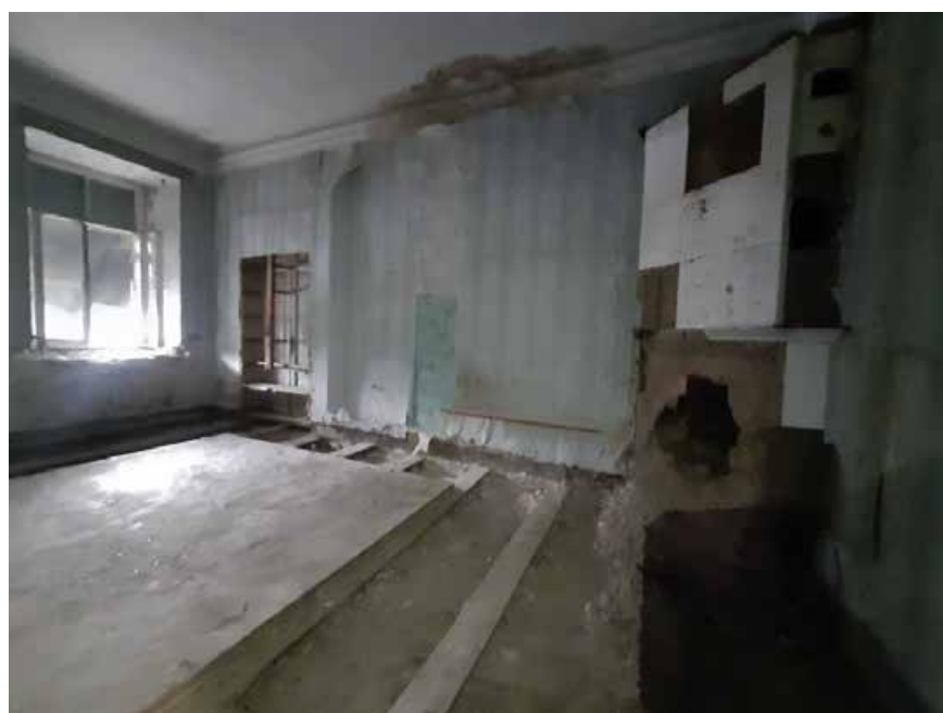
Фото №18. Помещение 3.28 ОКН РЗ «Дом С. Н. Завальевского-М.В. Северова», расположенный по адресу: Санкт-Петербург, муниципальный округ Коломна, пер. Прядильный, д. 12/163, литера А. Дата: 19.04.2025 г.
