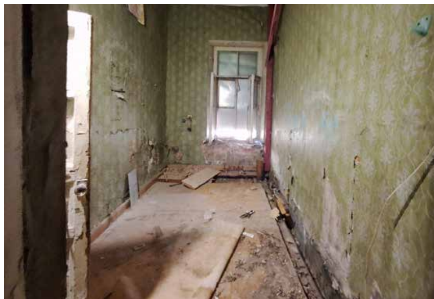
Фото №27. Помещение 2.21 ОКН РЗ «Дом С. Н. Завальевского-М.В. Северова», расположенный по адресу: Санкт-Петербург, муниципальный округ Коломна, пер. Прядильный, д. 12/163, литера А. Дата: 19.04.2025 г.
