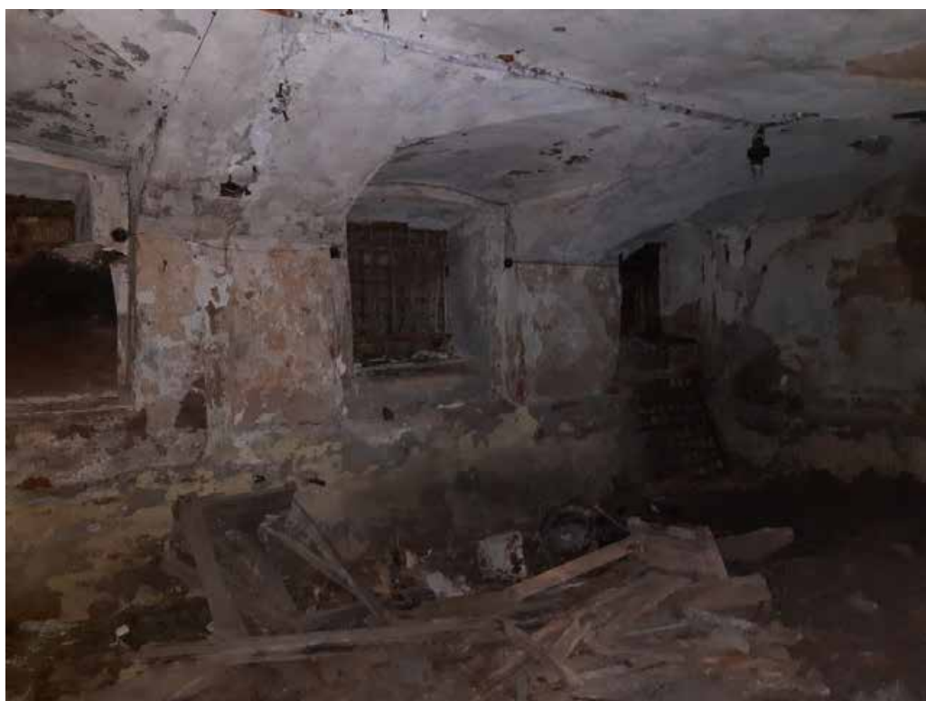
Фото №20. Помещение 0.6 ОКН РЗ «Дом С. Н. Завальевского-М.В. Северова», расположенный по адресу: Санкт-Петербург, муниципальный округ Коломна, пер. Прядильный, д. 12/163, литера А. Дата: 19.04.2025 г.
