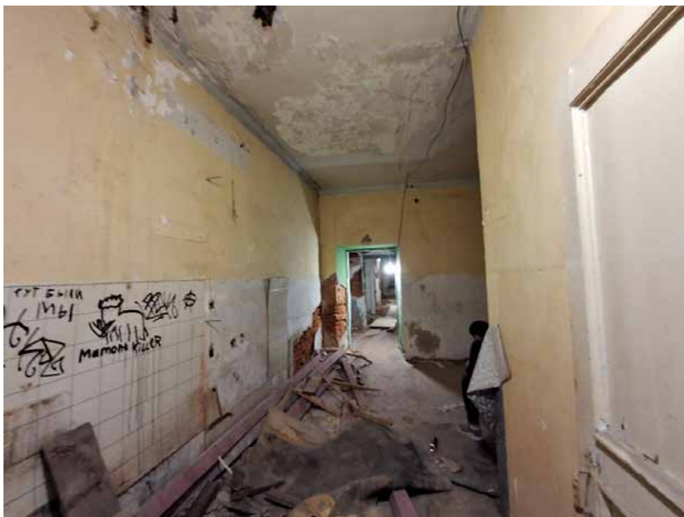
Фото №37. Помещение 1.42 ОКН РЗ «Дом С. Н. Завальевского-М.В. Северова», расположенный по адресу: Санкт-Петербург, муниципальный округ Коломна, пер. Прядильный, д. 12/163, литера А. Дата: 19.04.2025 г.
