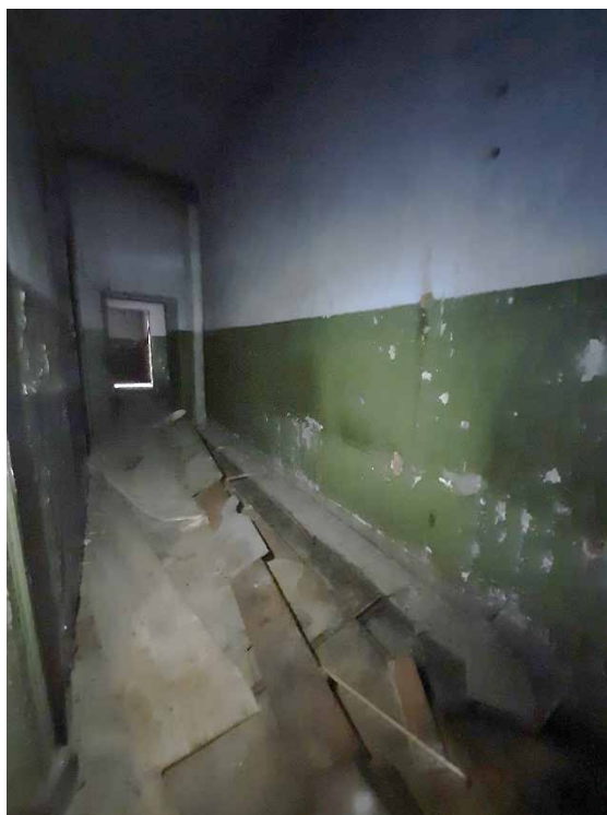
Фото №12. Помещение 3.30 ОКН РЗ «Дом С. Н. Завальевского-М.В. Северова», расположенный по адресу: Санкт-Петербург, муниципальный округ Коломна, пер. Прядильный, д. 12/163, литера А. Дата: 19.04.2025 г.
