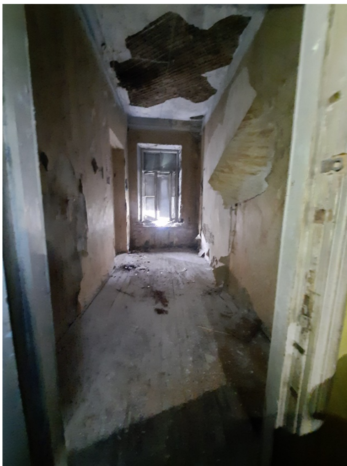
Фото №3. Помещение 3.44 ОКН РЗ «Дом С. Н. Завальевского-М.В. Северова», расположенный по адресу: Санкт-Петербург, муниципальный округ Коломна, пер. Прядильный, д. 12/163, литера А. Дата: 19.04.2025 г.
