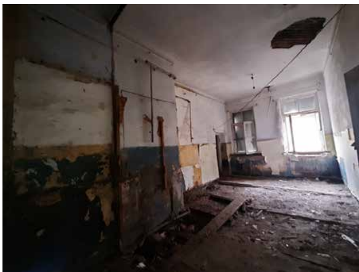
Фото №37. Помещение 3.10 ОКН РЗ «Дом С. Н. Завальевского-М.В. Северова», расположенный по адресу: Санкт-Петербург, муниципальный округ Коломна, пер. Прядильный, д. 12/163, литера А. Дата: 19.04.2025 г.
