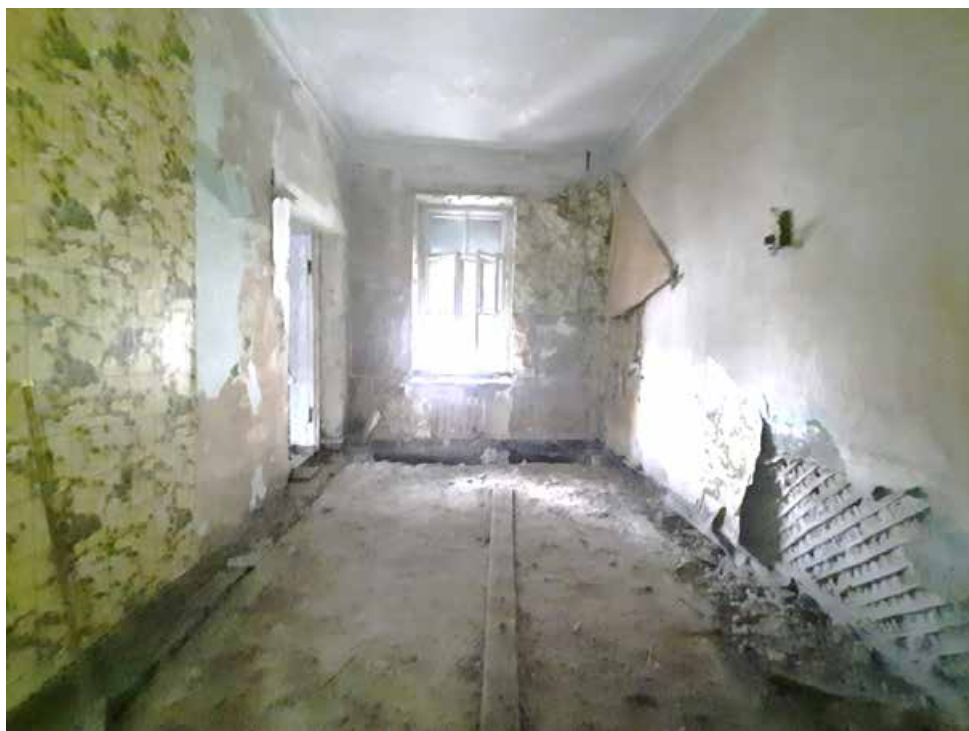
Фото №29. Помещение 3.18 ОКН РЗ «Дом С. Н. Завальевского-М.В. Северова», расположенный по адресу: Санкт-Петербург, муниципальный округ Коломна, пер. Прядильный, д. 12/163, литера А. Дата: 19.04.2025 г.
