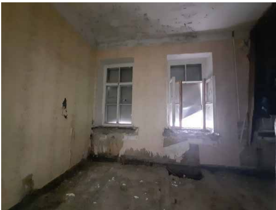
Фото №32. Помещение 3.15 ОКН РЗ «Дом С. Н. Завальевского-М.В. Северова», расположенный по адресу: Санкт-Петербург, муниципальный округ Коломна, пер. Прядильный, д. 12/163, литера А. Дата: 19.04.2025 г.
