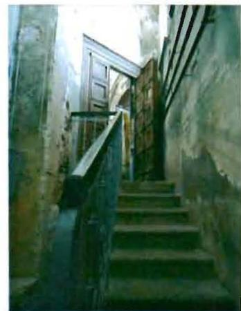
историческая лестница в подвальный этаж, на хоры и в трапезную, на третий этаж и его антресоли в западном приделе – многомаршевая с забежными известняковыми ступенями на металлических оштукатуренных косоурах и металлическим кованым ограждением с деревянным поручнем, ее местоположение, материалы, конструкции и габариты;
