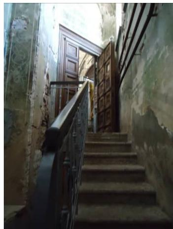
историческая лестница в подвальный этаж, на хоры и в трапезную, на третий этаж и его антресоли в западном приделе – многомаршевая с забежными известняковыми ступенями на металлических оштукатуренных косоурах и металлическим кованым ограждением с деревянным поручнем, ее местоположение, материалы, конструкции и габариты;
