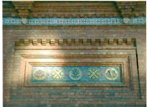
поребрики и ширинки из красного формованного кирпича;
