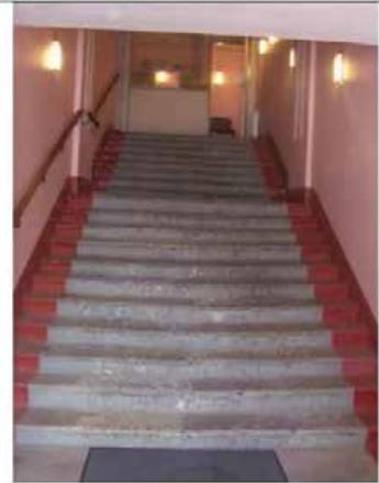
черная лестница по 7-й оси лицевого корпуса по Невскому пр. - тип сводов (крестовые с распалубками, на подпружных арках); местоположение, габариты, конструкция лестницы (на ползучих арках), тип и конфигурация (маршевая с поворотом), материал ступеней (лещадная плита);
