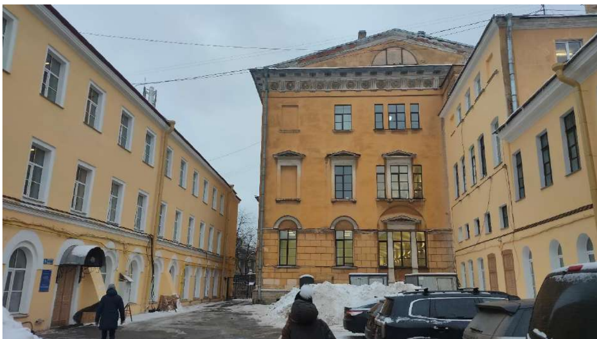
Фото 38. Дворовое пространство объекта культурного наследия федерального значения
