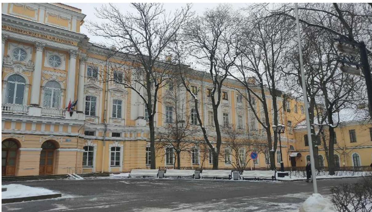
Фото 29. Фрагмент северо-западного фасада объекта культурного наследия федерального значения «Дворец Разумовского К.Г. Никольский сиротский институт», входящего в состав объекта культурного наследия федерального значения «Воспитательный дом Императорский», расположенный по адресу: Санкт-Петербург, наб. р. Мойки, д. 48, лит. А, корп. 5
