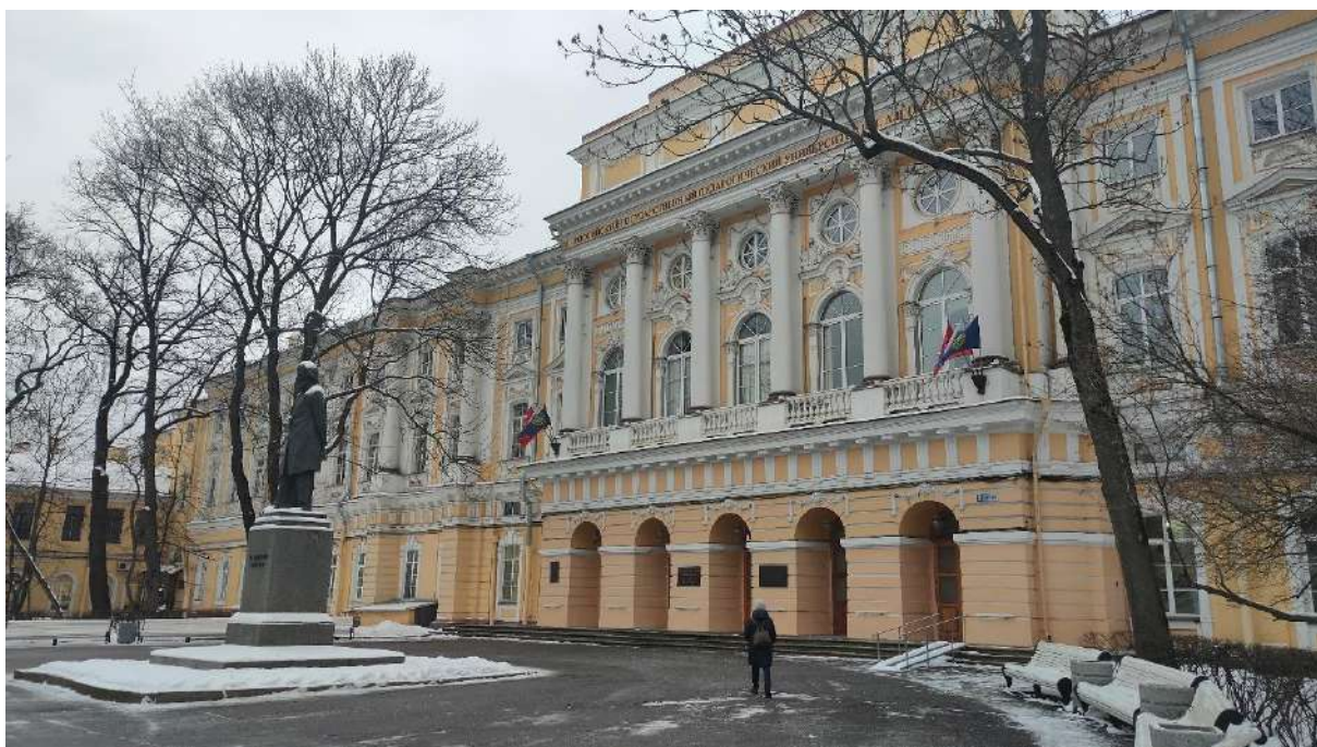
Фото 28. Вид на ризалит, фрагмент северо-западного фасада объекта культурного наследия федерального значения «Дворец Разумовского К.Г. Никольский сиротский институт», входящего в состав объекта культурного наследия федерального значения «Воспитательный дом Императорский», расположенный по адресу: Санкт-Петербург, наб. р. Мойки, д. 48, лит. А, корп. 5
