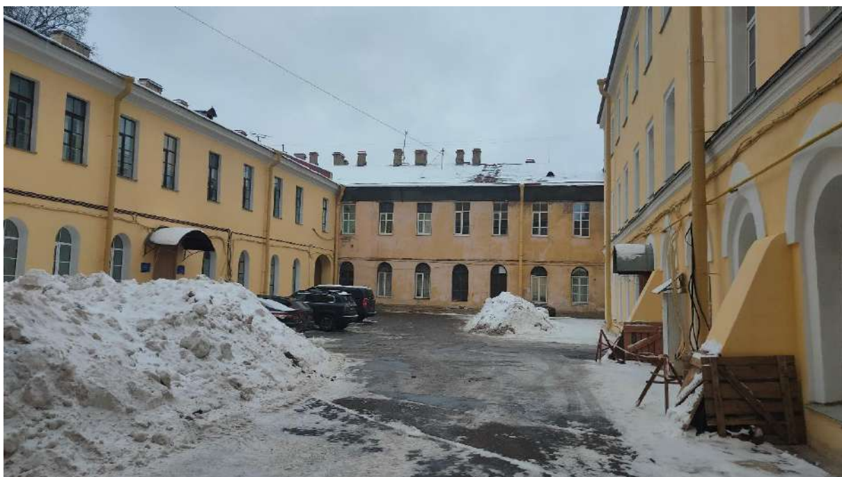
Фото 39. Дворовое пространство объекта культурного наследия федерального значения
