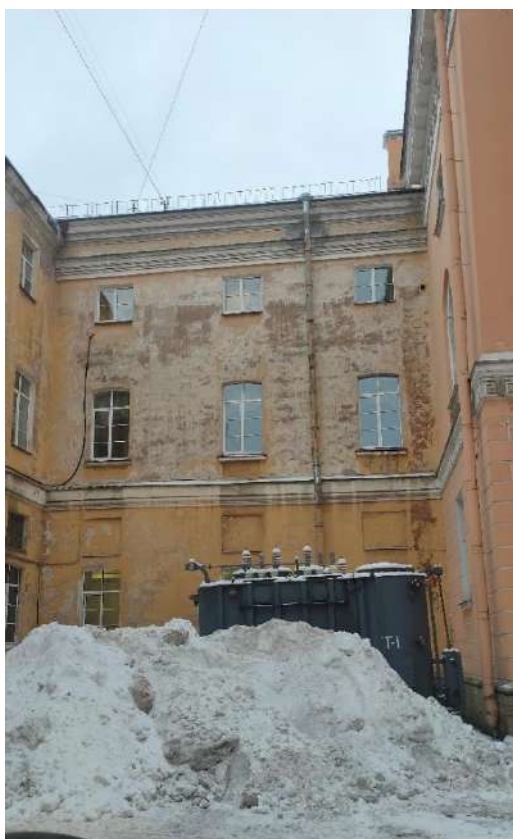
Фото 22. Фрагмент юго-восточного фасада объекта культурного наследия федерального значения «Дворец Разумовского К.Г. Никольский сиротский институт», входящего в состав объекта культурного наследия федерального значения «Воспитательный дом Императорский», расположенный по адресу: Санкт-Петербург, наб. р. Мойки, д. 48, лит. А, корп. 5
