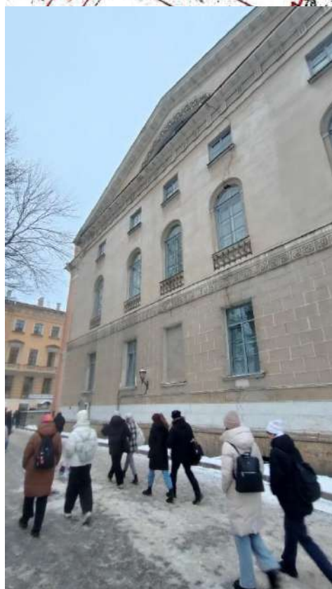
Фото 17. Фасад фасада корпуса, примыкающего к юго-восточному фасаду объекта культурного наследия федерального значения «Дворец Разумовского К.Г. Никольский сиротский институт», входящего в состав объекта культурного наследия федерального значения «Воспитательный дом Императорский»,
