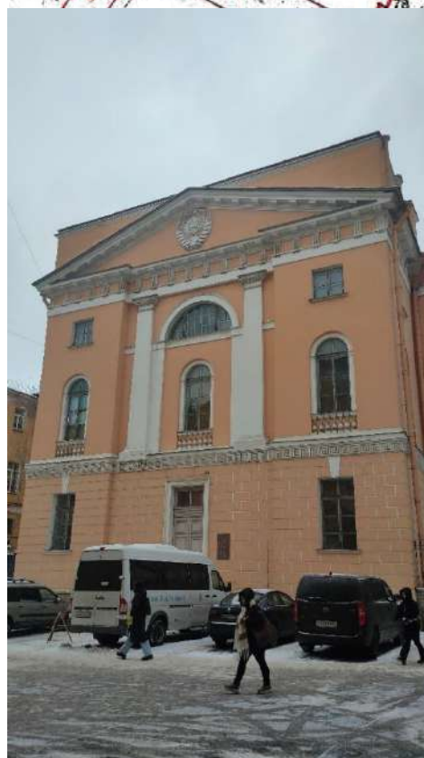
Фото 18. Фасад фасада корпуса, примыкающего к юго-восточному фасаду объекта культурного наследия федерального значения «Дворец Разумовского К.Г. Никольский сиротский институт», входящего в состав объекта культурного наследия федерального значения «Воспитательный дом Императорский»,
