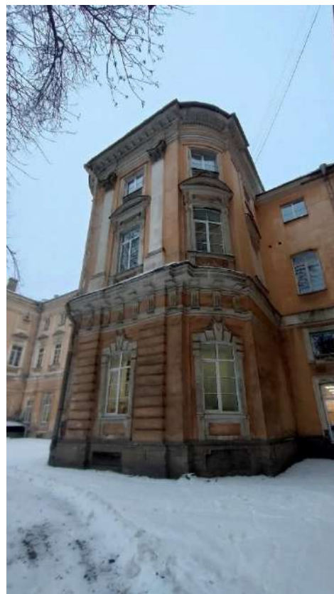
Фото 8. Фрагмент юго-восточного фасада объекта культурного наследия федерального значения «Дворец Разумовского К.Г. Никольский сиротский институт», входящего в состав объекта культурного наследия федерального значения «Воспитательный дом Императорский», расположенный по адресу: Санкт-Петербург, наб. р. Мойки, д. 48, лит. А, корп. 5
