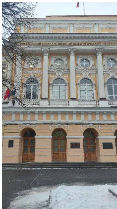
Фото 32. Фрагмент северо-западного фасада объекта культурного наследия федерального значения «Дворец Разумовского К.Г. Никольский сиротский институт», входящего в состав объекта культурного наследия федерального значения «Воспитательный дом Императорский», расположенный по адресу: Санкт-Петербург, наб. р. Мойки, д. 48, лит. А,
