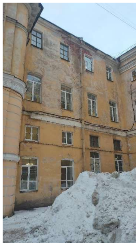
Фото 23. Фрагмент юго-восточного фасада объекта культурного наследия федерального значения «Дворец Разумовского К.Г. Никольский сиротский институт», входящего в состав объекта культурного наследия федерального значения «Воспитательный дом Императорский», расположенный по адресу: Санкт-Петербург, наб. р. Мойки, д. 48, лит. А,
