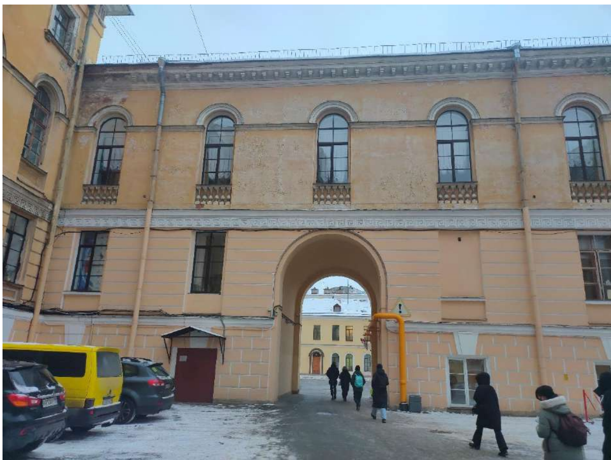
Фото 20. Фрагмент юго-восточного фасада объекта культурного наследия федерального значения «Дворец Разумовского К.Г. Никольский сиротский институт», входящего в состав объекта культурного наследия федерального значения «Воспитательный дом Императорский», расположенный по адресу: Санкт-Петербург, наб. р. Мойки, д. 48, лит. А, корп. 5
