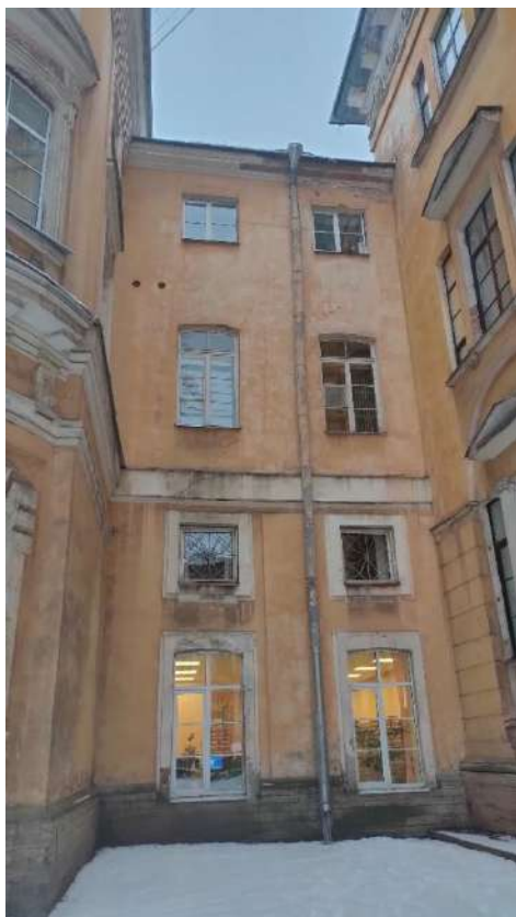
Фото 7. Фрагмент юго-восточного фасада объекта культурного наследия федерального значения «Дворец Разумовского К.Г. Никольский сиротский институт», входящего в состав объекта культурного наследия федерального значения «Воспитательный дом Императорский», расположенный по адресу: Санкт-Петербург, наб. р. Мойки, д. 48, лит. А, корп. 5
