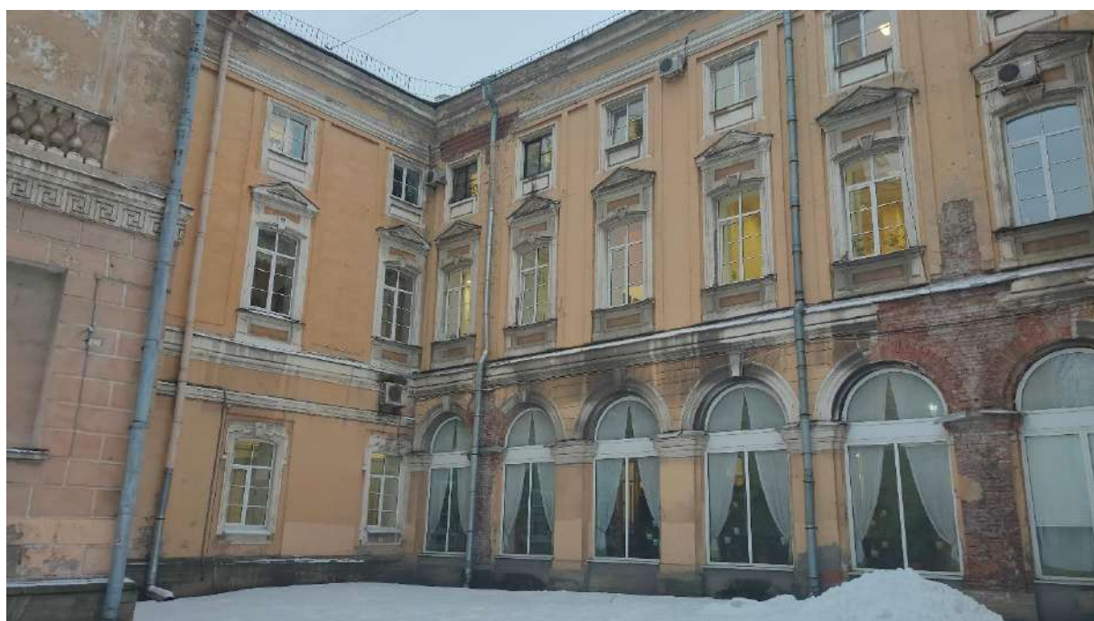
Фото 14. Фрагмент юго-восточного фасада объекта культурного наследия федерального значения «Дворец Разумовского К.Г. Никольский сиротский институт», входящего в состав объекта культурного наследия федерального значения «Воспитательный дом Императорский», расположенный по адресу: Санкт-Петербург, наб. р. Мойки, д. 48, лит. А, корп. 5
