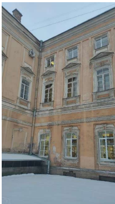
Фото 11. Фрагмент юго-восточного фасада объекта культурного наследия федерального значения «Дворец Разумовского К.Г. Никольский сиротский институт», входящего в состав объекта культурного наследия федерального значения «Воспитательный дом Императорский», расположенный по адресу: Санкт-Петербург, наб. р. Мойки, д.
