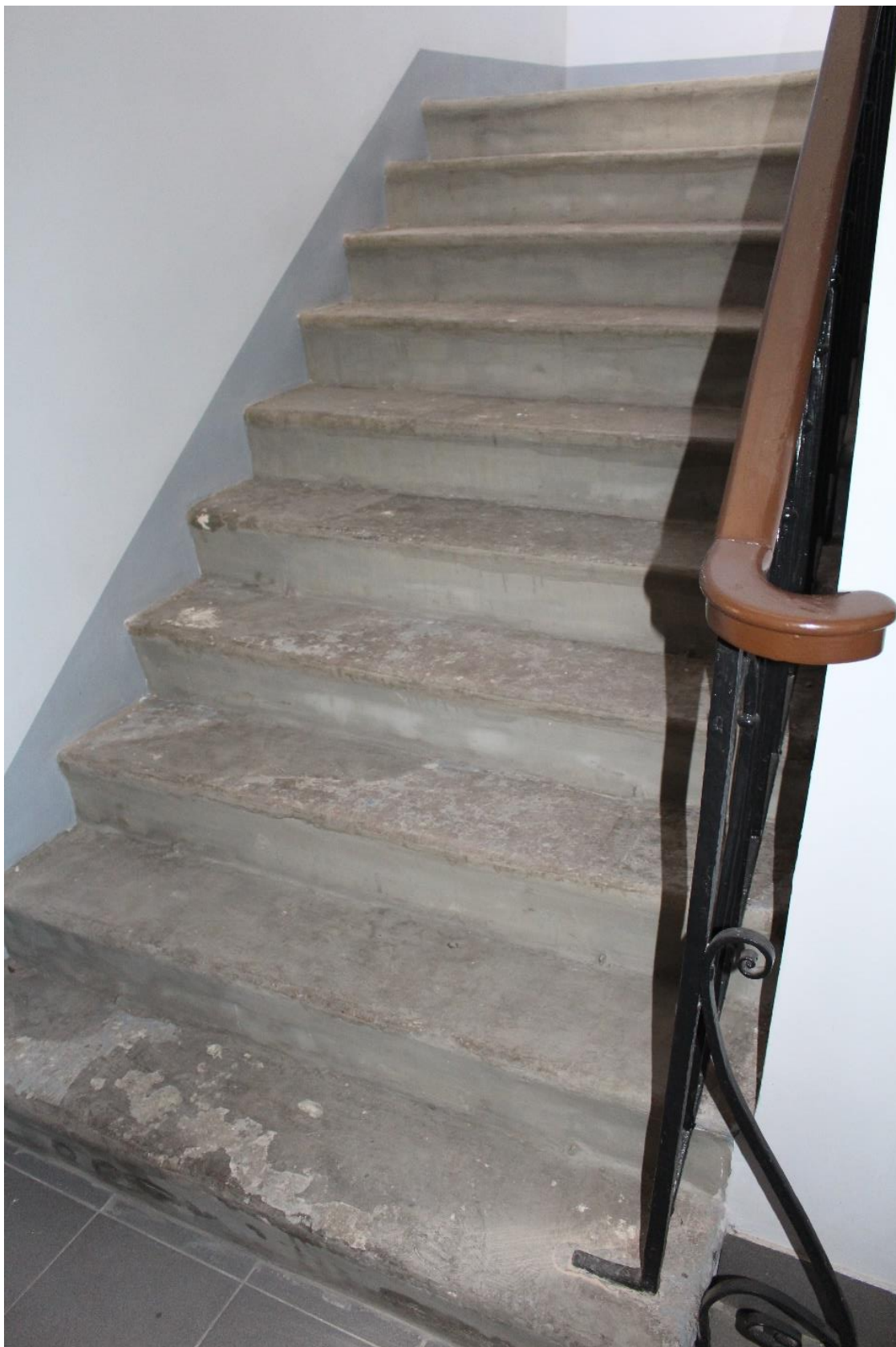
Фото 101. Объект культурного наследия федерального значения «Дом плац-майорский». Лестница в северной части здания.
