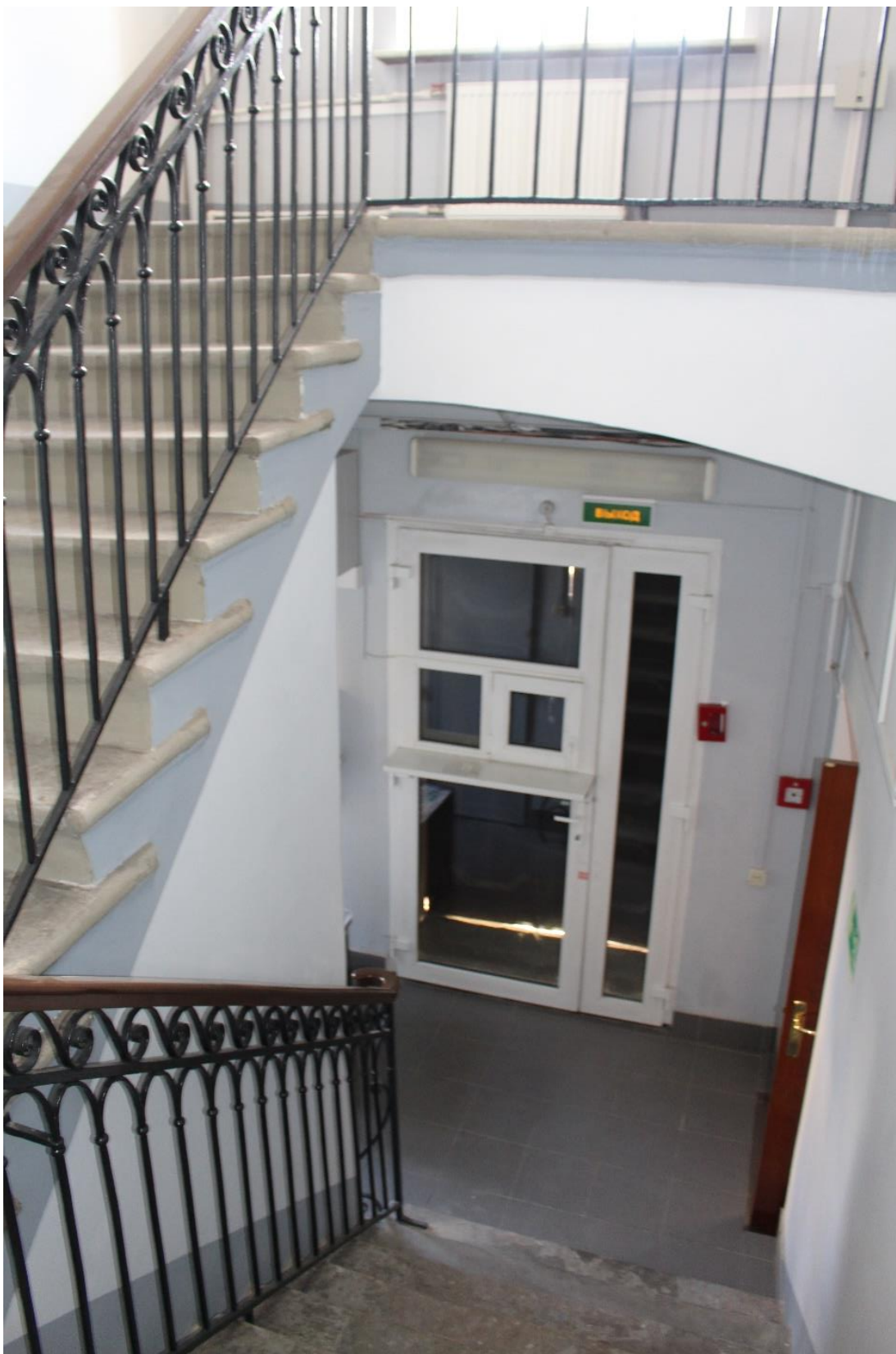
Фото 102. Объект культурного наследия федерального значения «Дом плац-майорский». Лестница в северной части здания.
