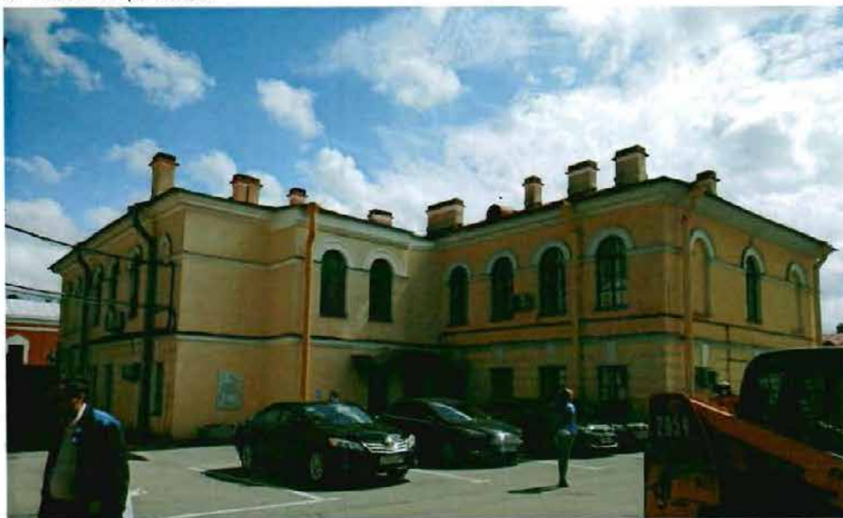
2. Вид с северо-запада.
