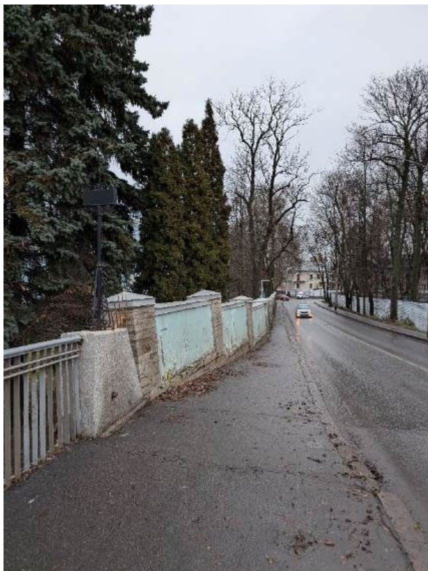
7. Ограждение вдоль юго-восточной границы территории объекта культурного наследия регионального значения «Парк «Тихий отдых». Дом Вургафта с участком парка». 08.04.2025
