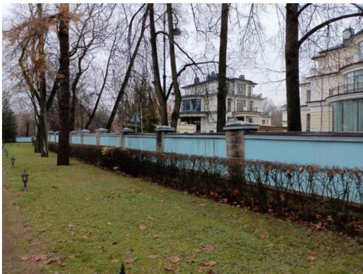
14. Ограждение вдоль северо-восточной границы земельного участка, кадастровый номер 78:07:0323601:1, с внутренней стороны. 08.04.2025
