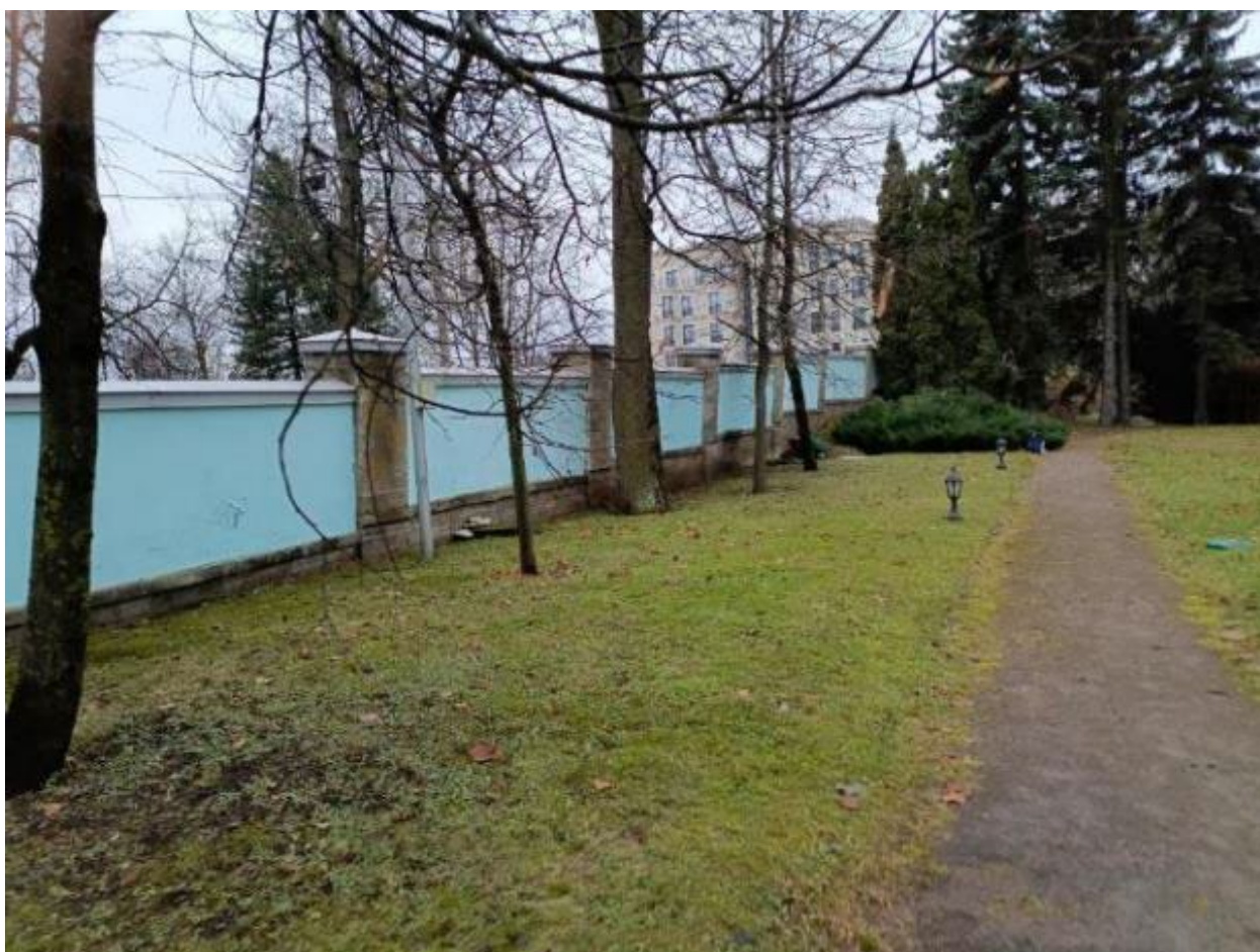
9. Ограждение вдоль юго-восточной границы территории объекта культурного наследия регионального значения «Парк «Тихий отдых». Дом Вургафта с участком парка» с внутренней стороны. 08.04.2025
