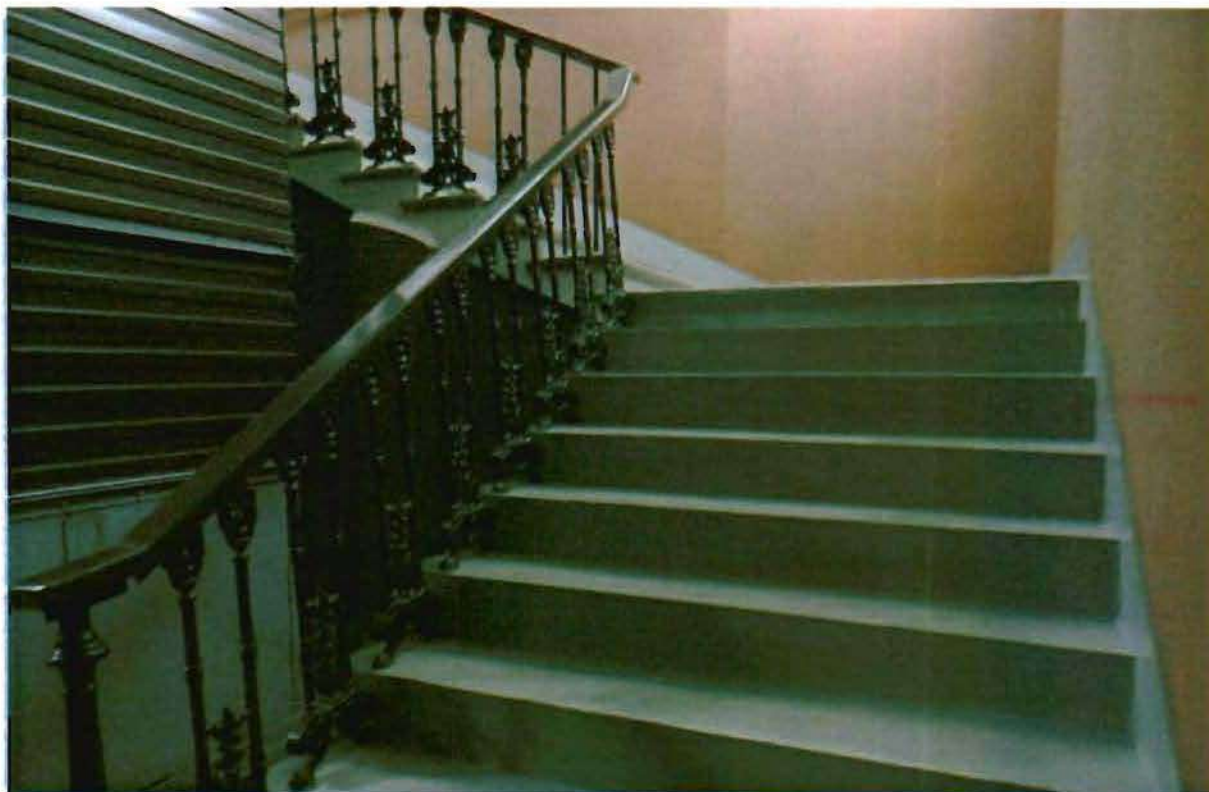
9. Историческая межэтажная лестница (корпус № 2).
