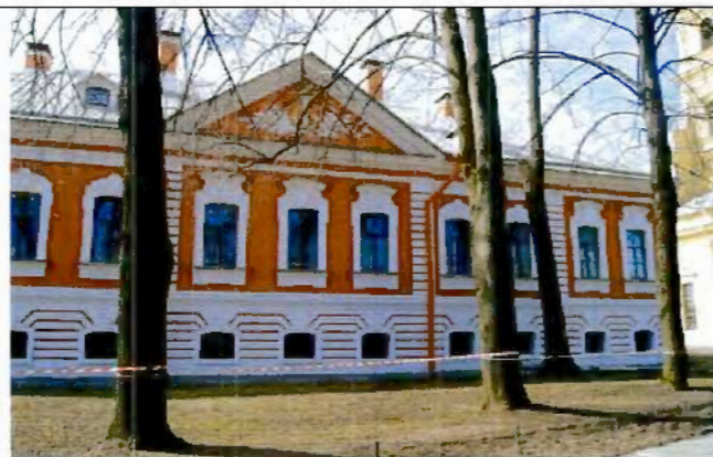
4. Фрагмент восточного фасада
