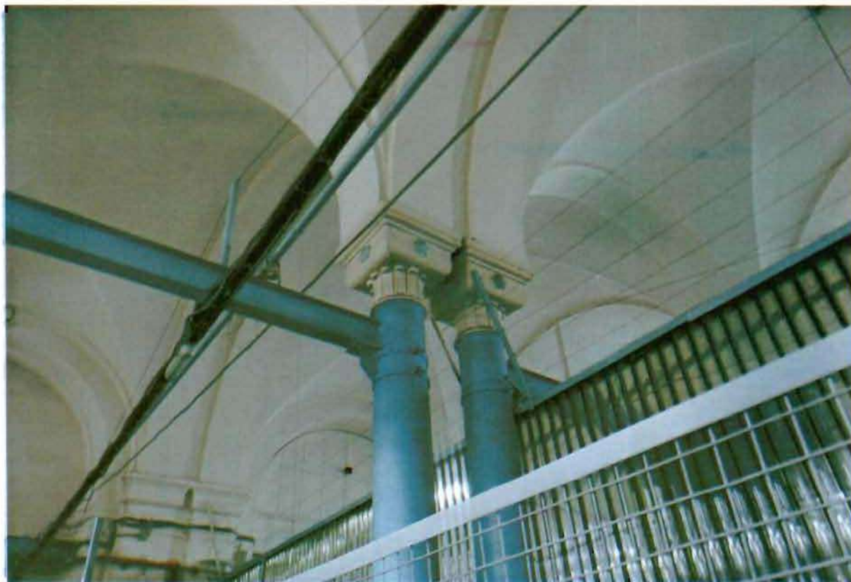
12. Чугунные опорные колонны (корпус № 3).
