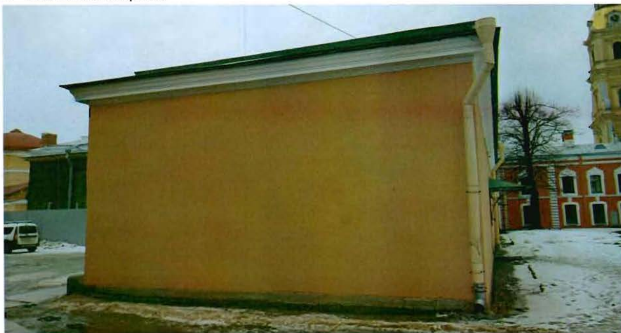
2. Вид на южный фасад.
