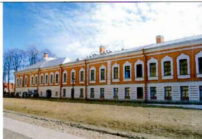
1. Фрагмент северного фасада
