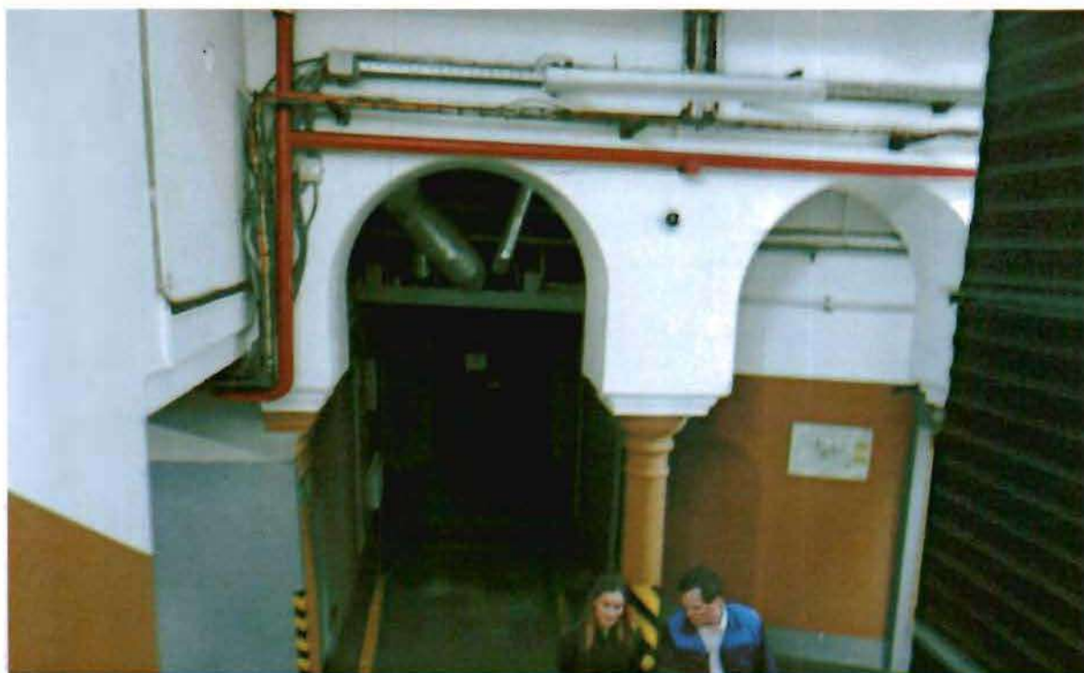
10. Арочное перекрытие центральной части вестибюля (корпус № 2).
