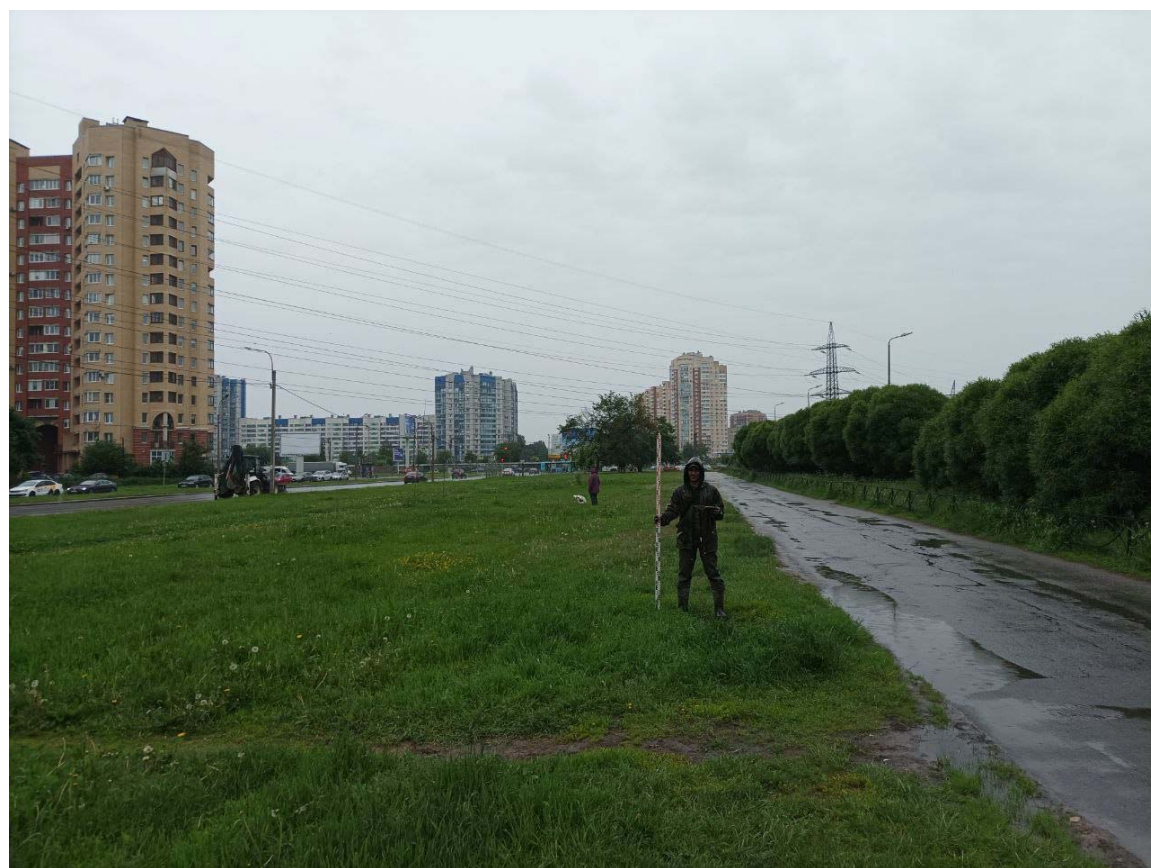
Рис. 14. СПб-2025, Мурзинка – ул. Орджоникидзе (НВ). Точка фотофиксации 1, вид с запада.
