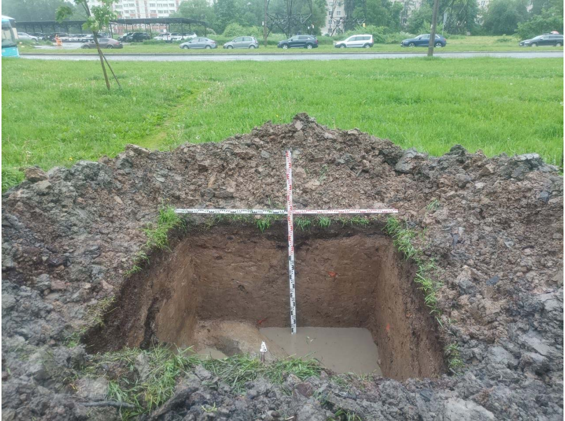
Рис. 37. СПб-2025, Мурзинка – ул. Орджоникидзе (НВ). Шурф 1, фиксация по уровню окончания работ, вид с юга.
