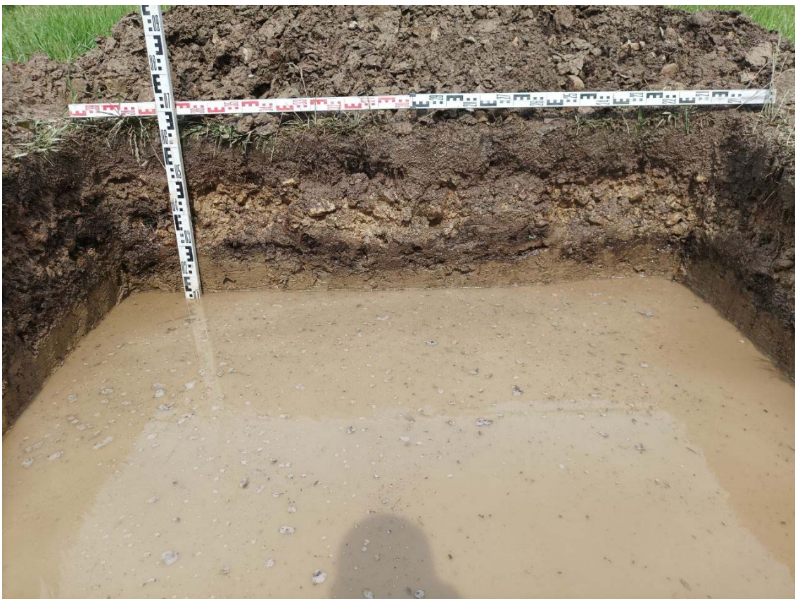
Рис. 48. СПб-2025, Мурзинка – ул. Орджоникидзе (НВ). Шурф 2, фиксация по уровню окончания работ, северная стенка.
