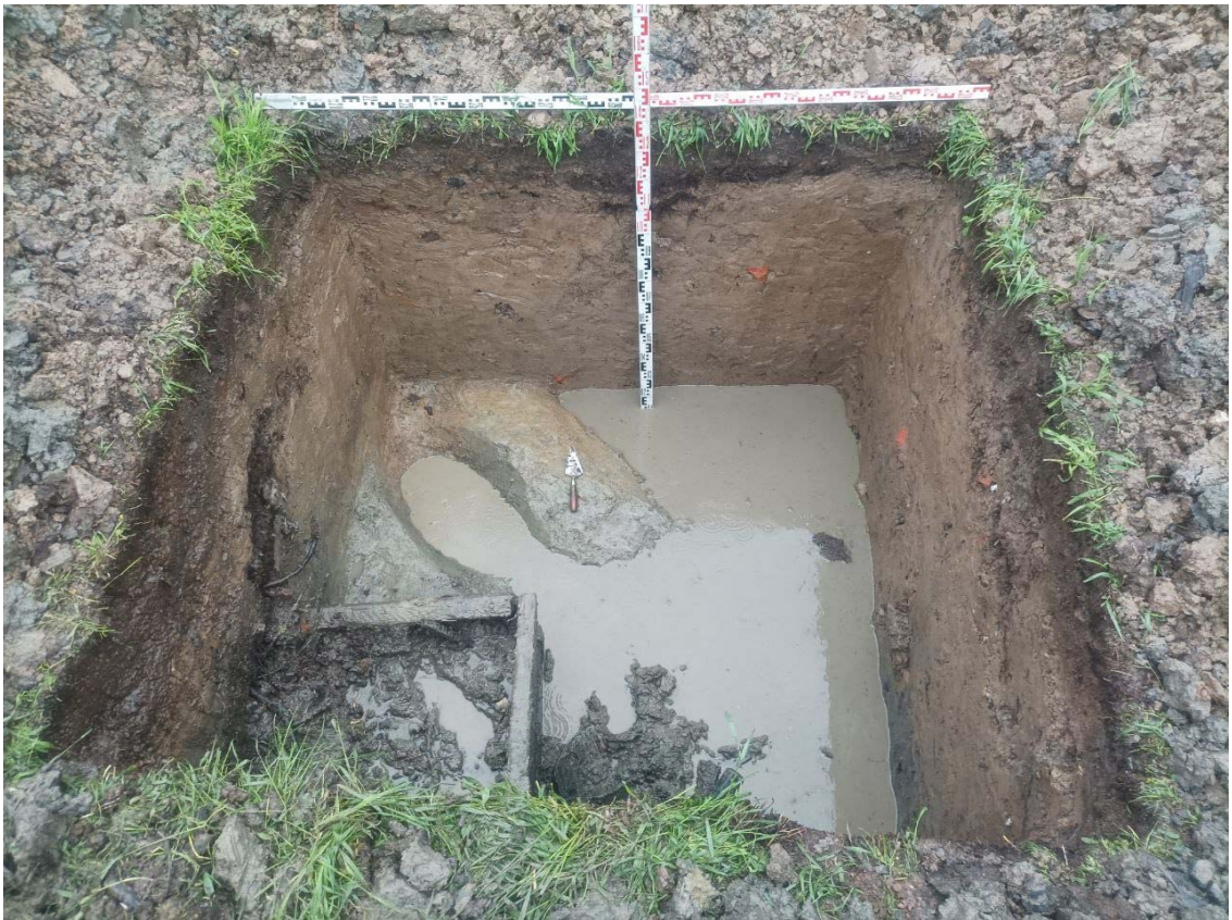
Рис. 38. СПб-2025, Мурзинка – ул. Орджоникидзе (НВ). Шурф 1, фиксация по уровню окончания работ, вид с юга.
