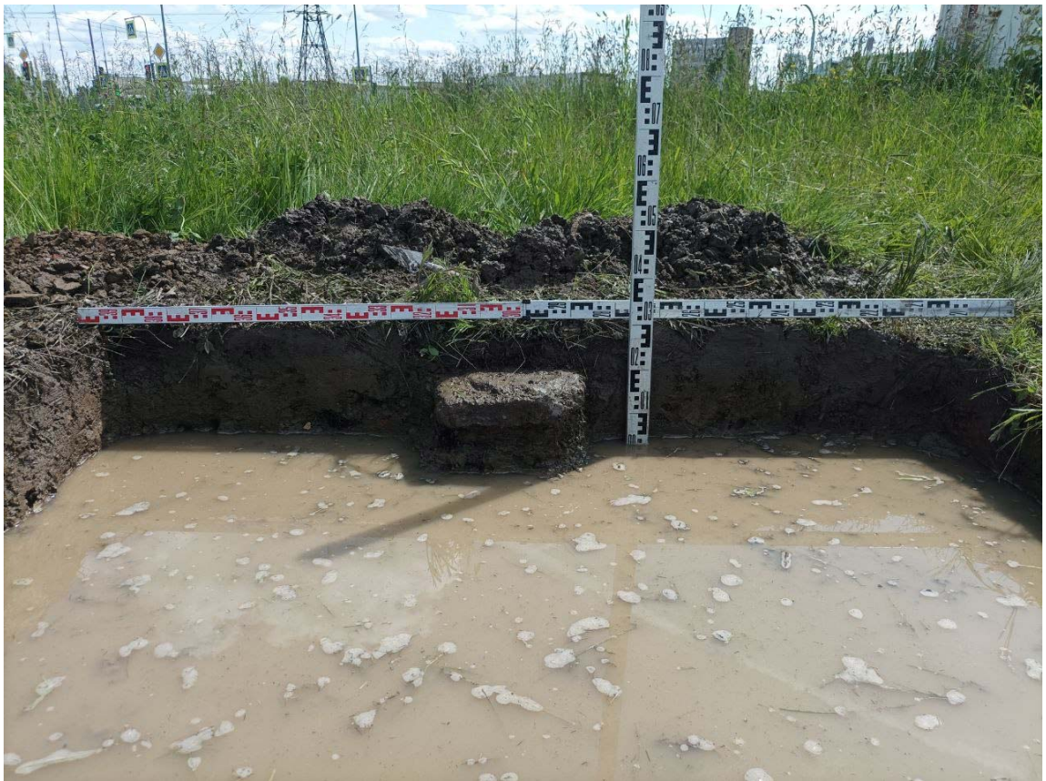
Рис. 74. СПб-2025, Мурзинка – ул. Орджоникидзе (НВ). Шурф 5, фиксация по уровню окончания работ, восточная стенка.
