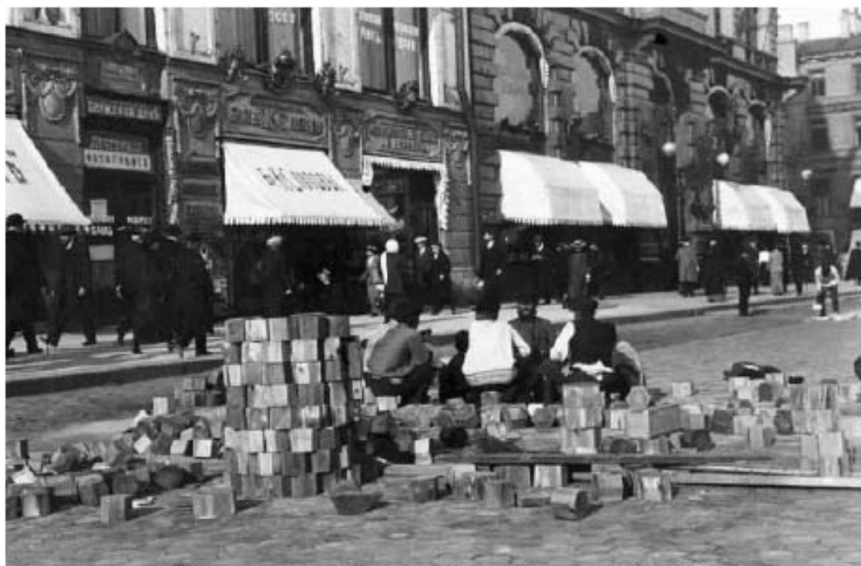
27. Ремонт торцовой мостовой у дома Зингера. 1907-1917 гг.
