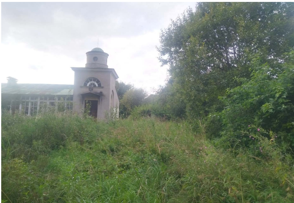
67. Вид на южную часть усадьбы. Южный фасад объекта культурного наследия федерального значения «Дача». Восточное крыло
