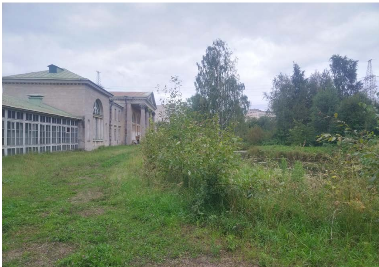
19. Вид на южную часть усадьбы. Фрагмент южного фасада объекта культурного наследия федерального значения «Дача»
