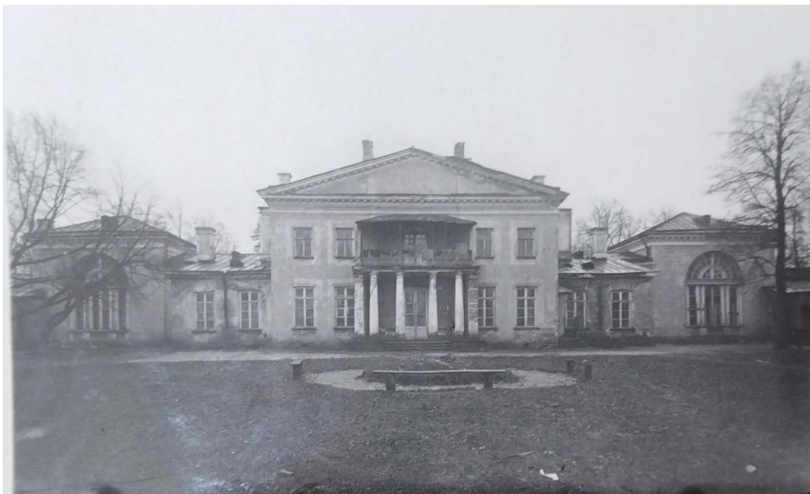
31. Дача Безобразовых. Северный фасад. Архив КГИОП. П. 32. Н-157. Архитектурный паспорт здания общежития Охтинского лесозавода (бывшая дача Безобразовых). Альбом фотографий. Сост.: Вальберг В.П., Липман А.И. 1939 г.
