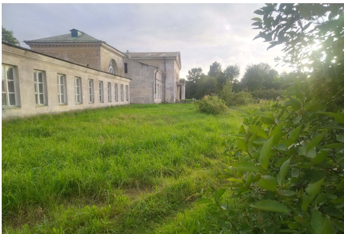
72. Северо-восточная часть усадьбы. Северный фасад объекта культурного наследия федерального значения «Дача».
