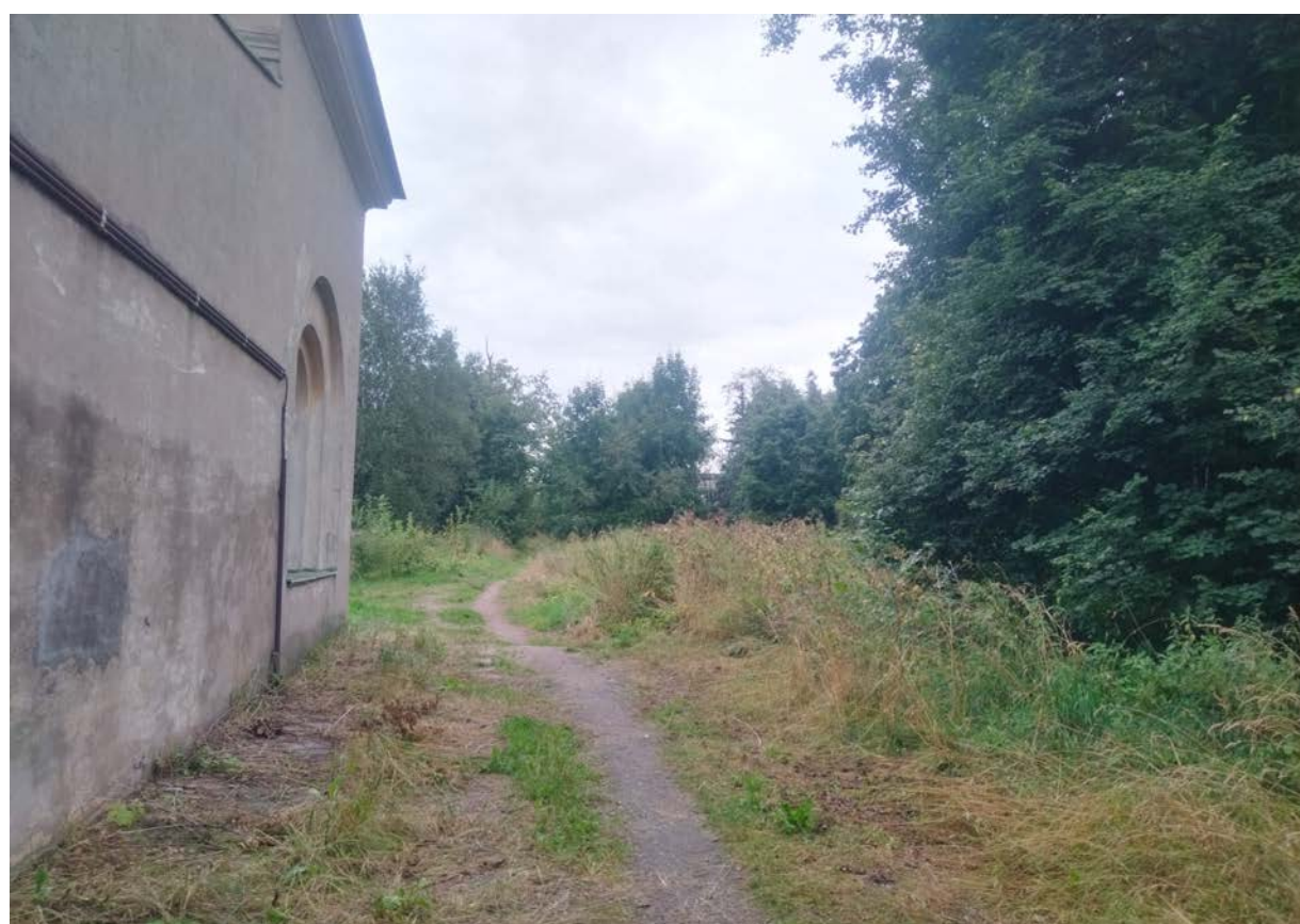
16. Северо-западная часть усадьбы. Вид на фрагмент западного фасада объекта культурного наследия федерального значения «Дача»: западное крыло. Тропинка вдоль фасада, проложенная параллельно реке Охте
