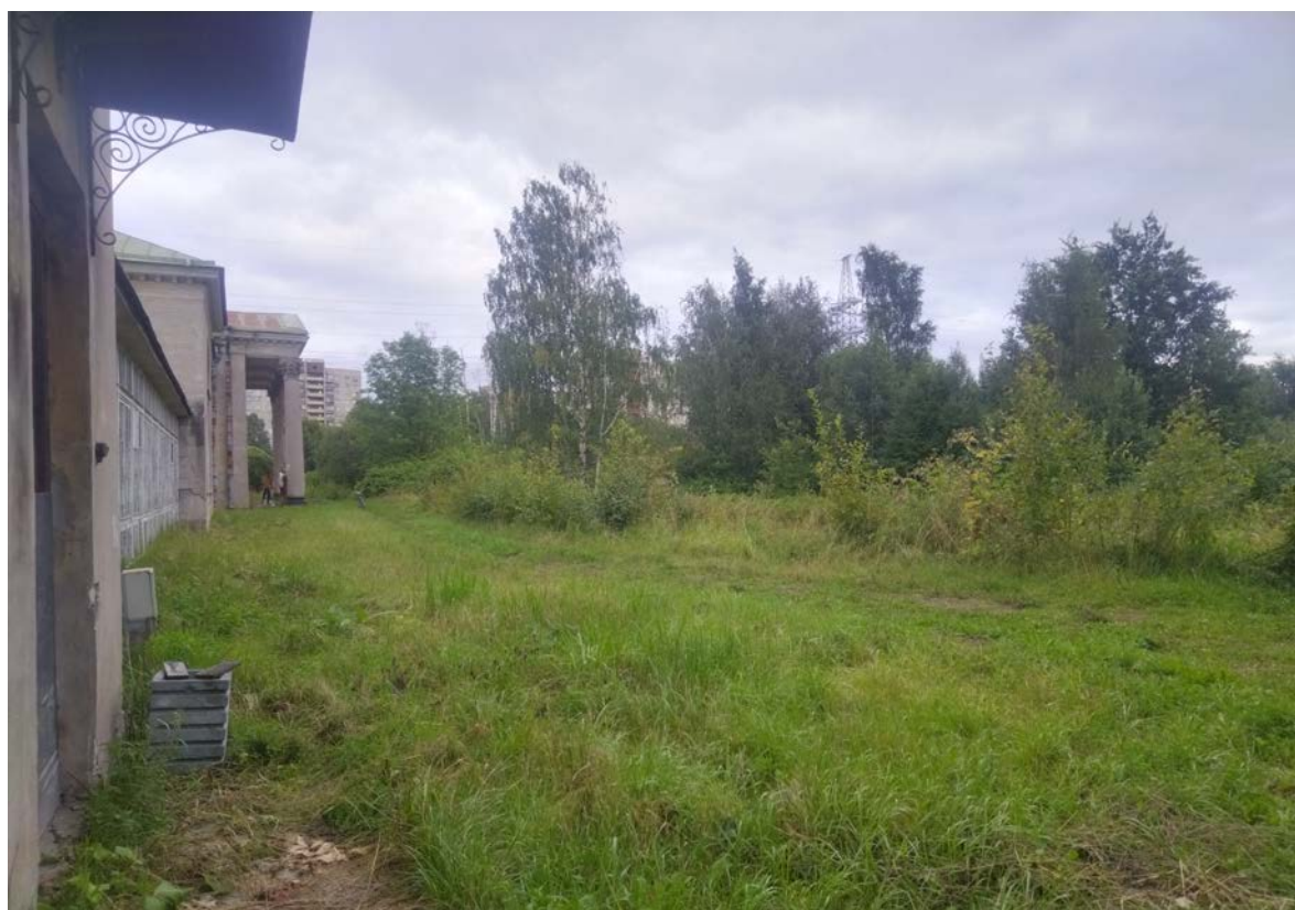
18. Вид на южную часть усадьбы. Фрагмент южного фасада объекта культурного наследия федерального значения «Дача»
