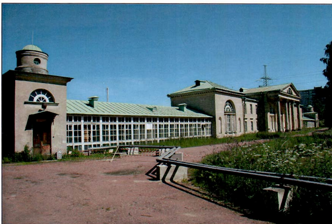
1. Общий вид. Южный фасад.
