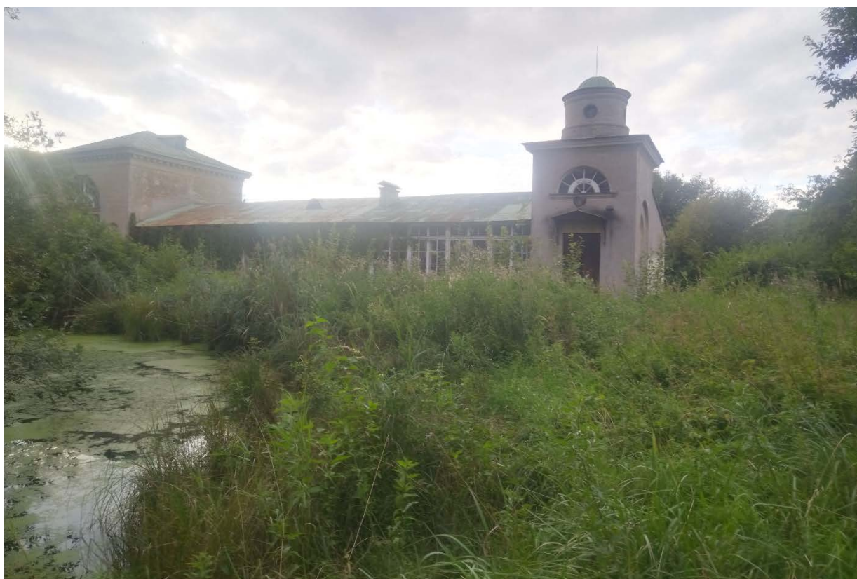
66. Вид на южную часть усадьбы. Южный фасад объекта культурного наследия федерального значения «Дача». Восточное крыло
