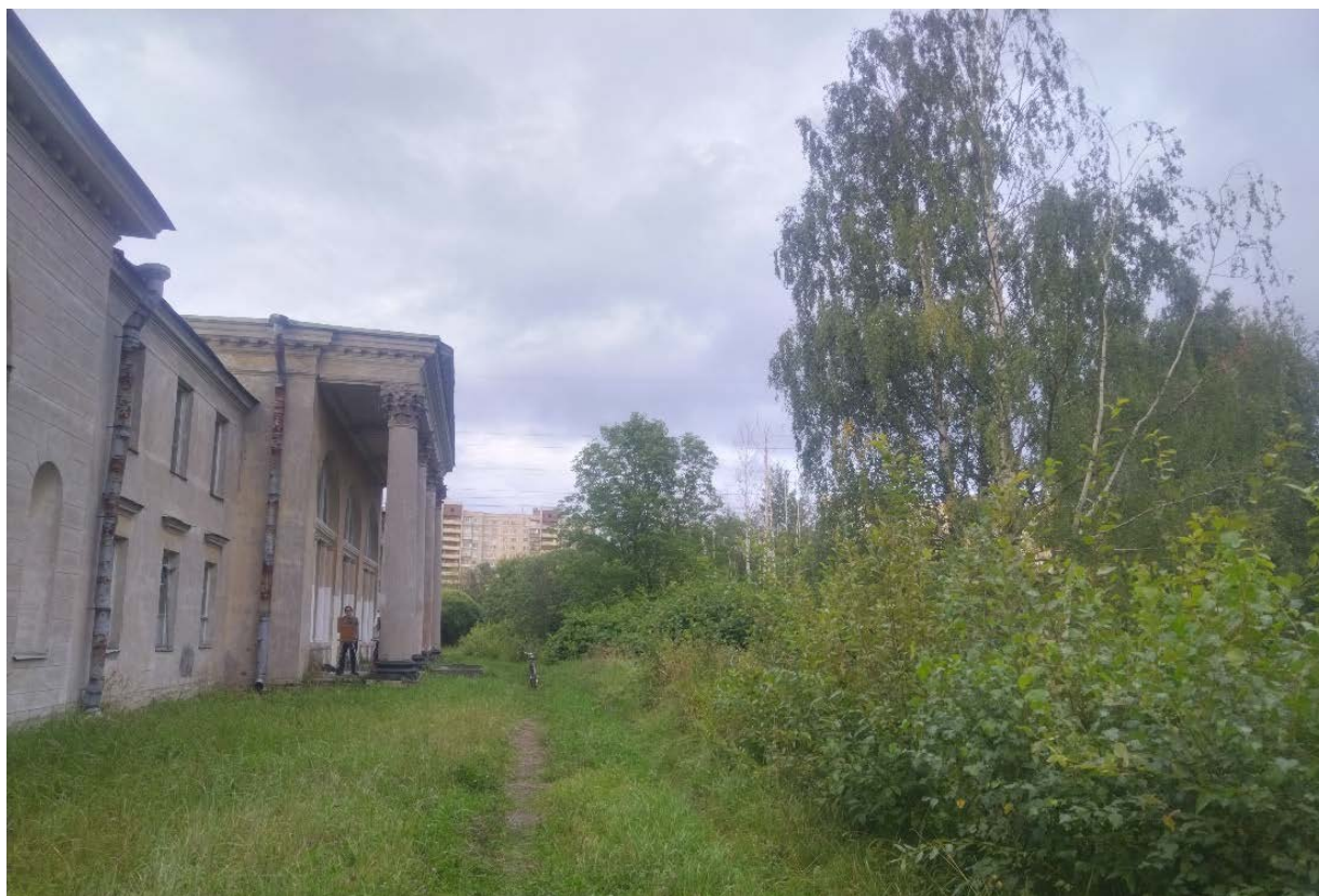
52. Вид на южную часть усадьбы. Южный фасад объекта культурного наследия федерального значения «Дача». Тропинка вдоль фасада
