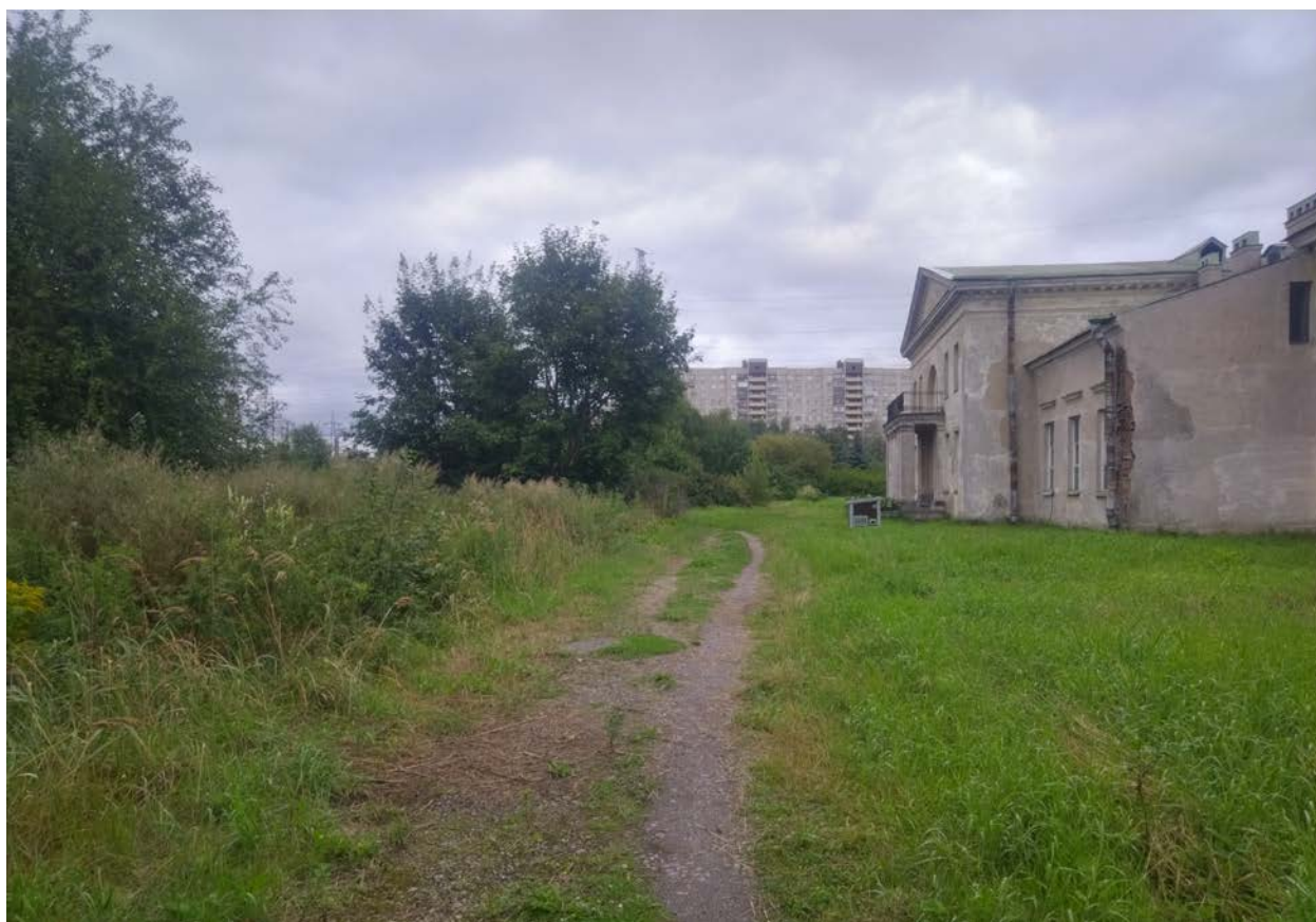
14. Северная часть усадьбы. Вид на фрагмент северного фасада объекта культурного наследия федерального значения «Дача»: западное крыло. Тропинка вдоль фасада
