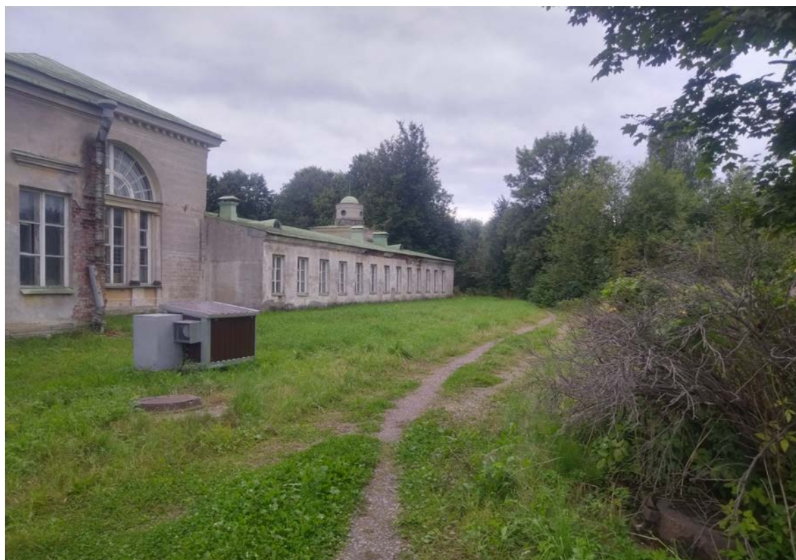
12. Северная часть усадьбы. Вид на объект культурного наследия федерального значения «Дача». Фрагмент северного фасада: западное крыло. Тропинка вдоль фасада
