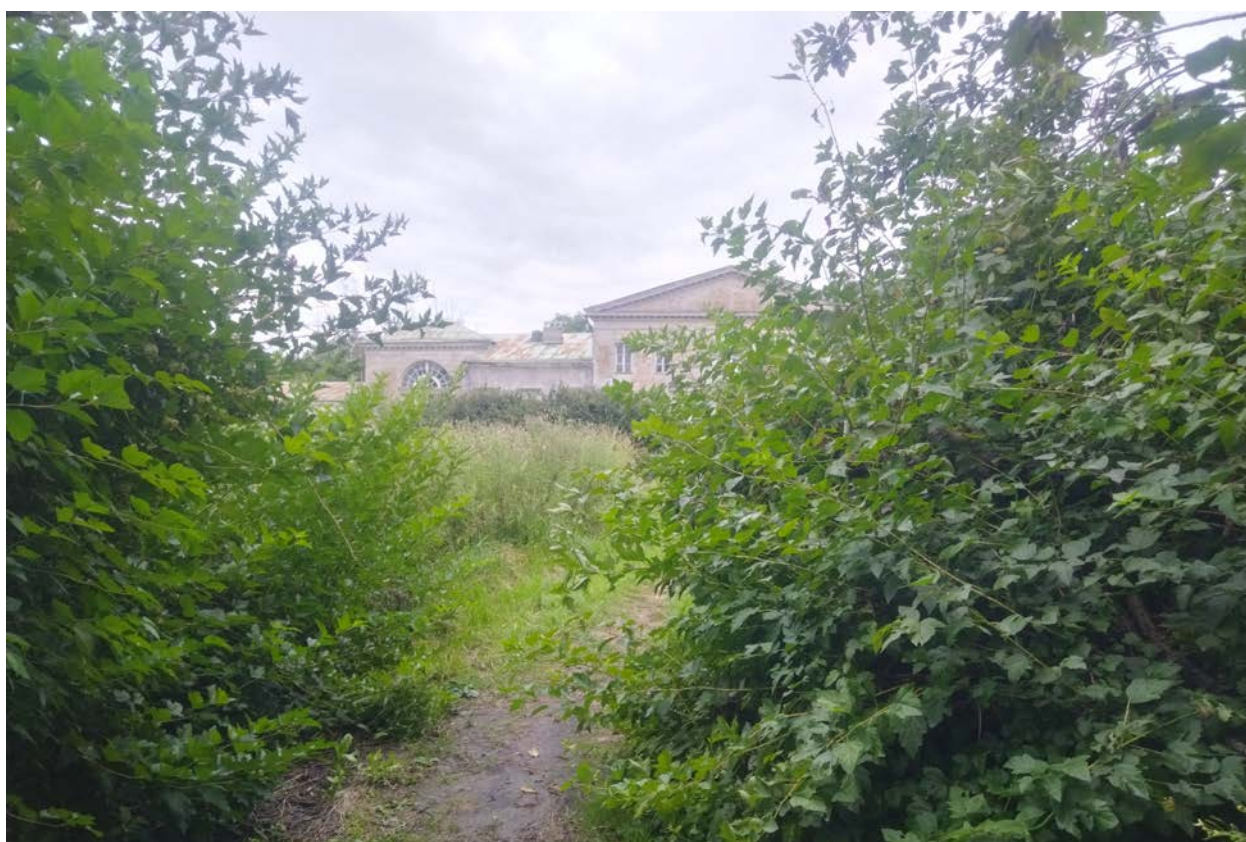
6. Северная часть усадьбы. Вид на Объект культурного наследия федерального значения «Дача». Фрагмент северного фасада.
