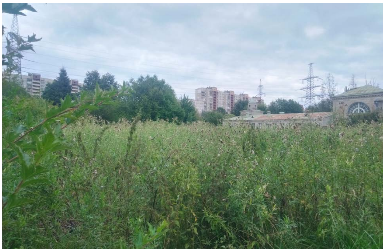
8. Северо-восточная часть усадьбы. Вид на Объект культурного наследия федерального значения «Дача». Фрагмент северного фасада.
