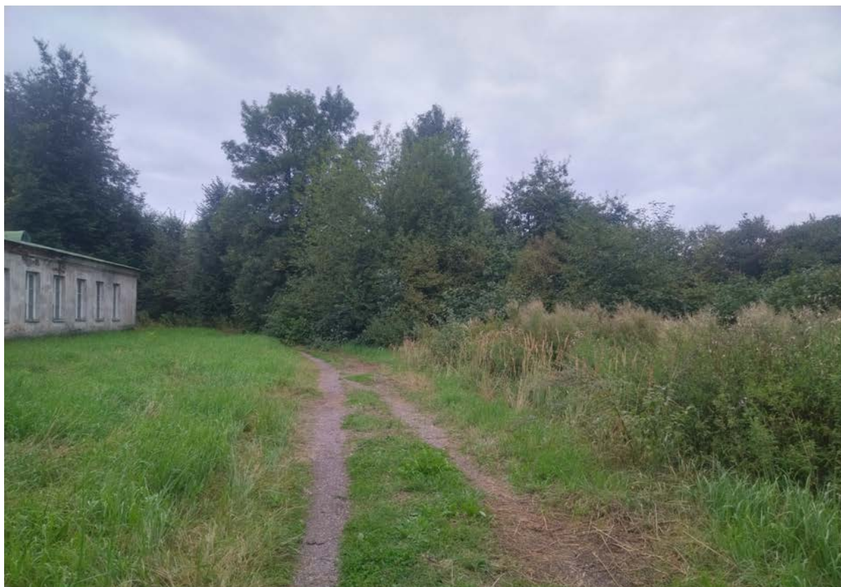
13. Северная часть усадьбы. Вид на фрагмент северного фасада объекта культурного наследия федерального значения «Дача»: западное крыло. Тропинка вдоль фасада
