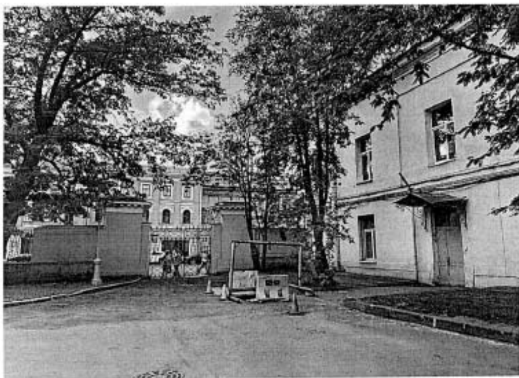
2. Дворовый фасад корпуса лит.Б
