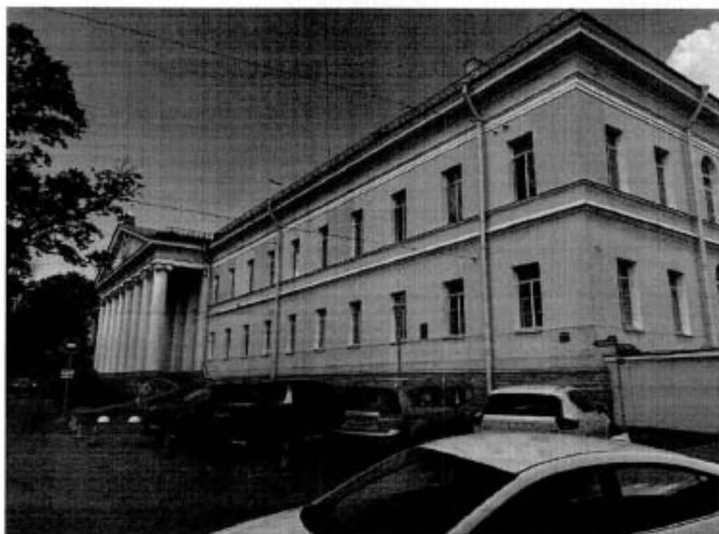
2. Фрагмент лицевого фасада по Литейному пр.
