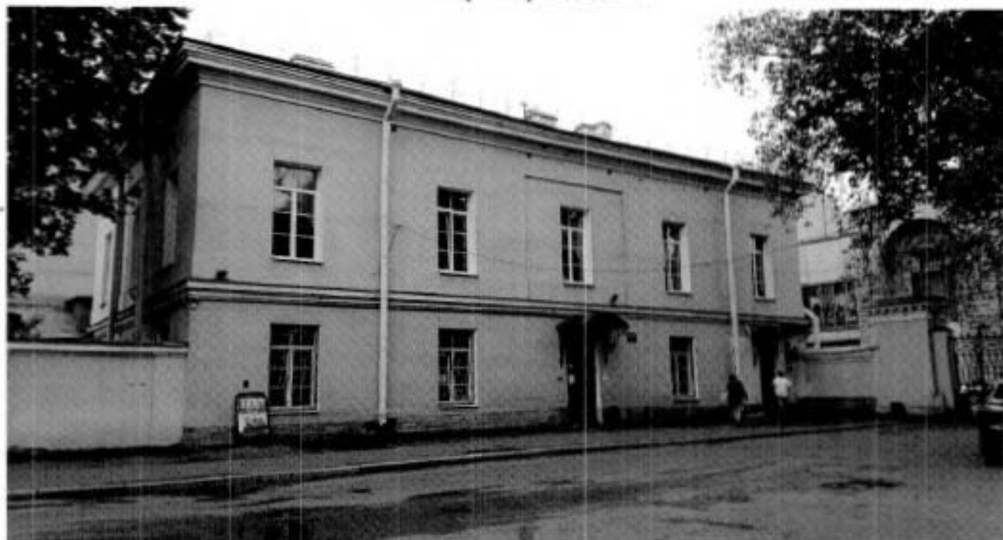
15. Северный фасад здания
