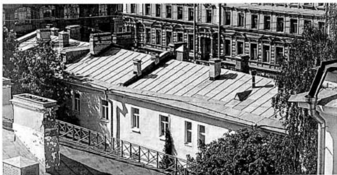
3. Крыша корпуса лит.Б
