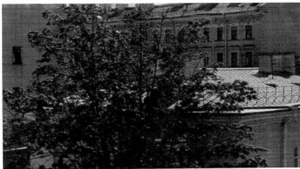
8. Фрагмент крыши корпуса лит.Б.
