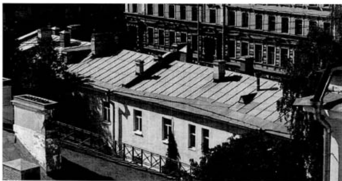
2. Крыша корпуса лит.Б
