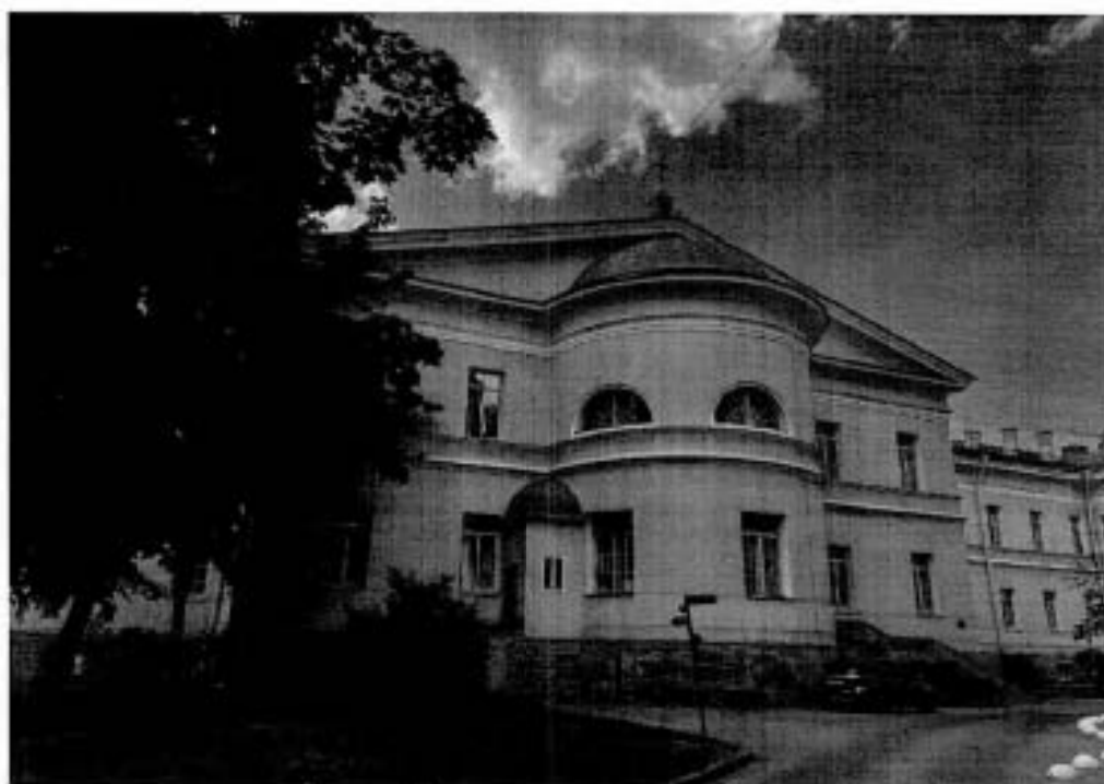
4. Фрагмент дворового фасада
