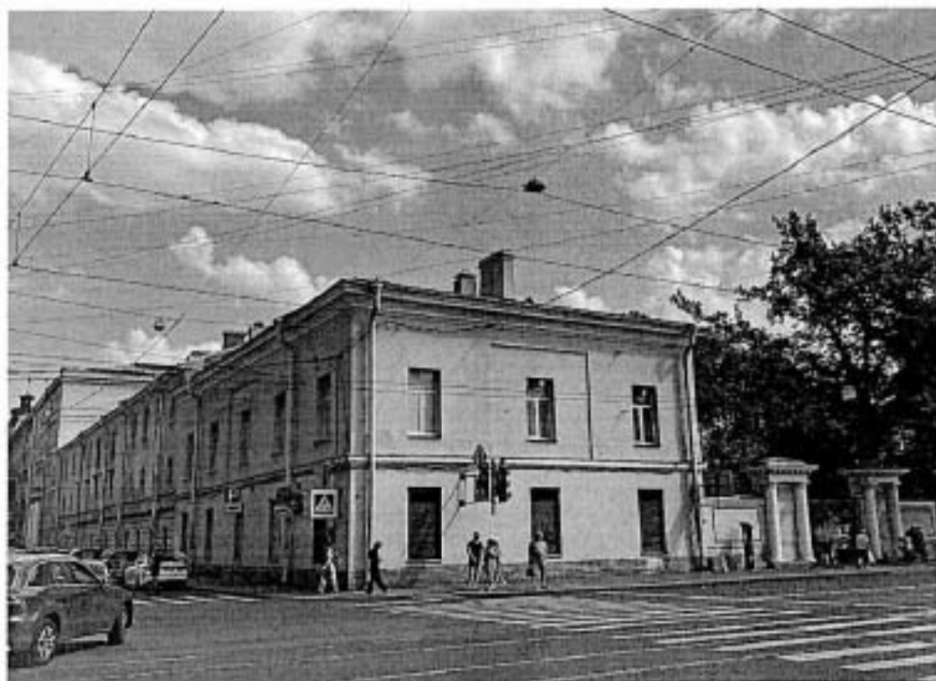
1. Лицевые фасады корпуса лит.Б
