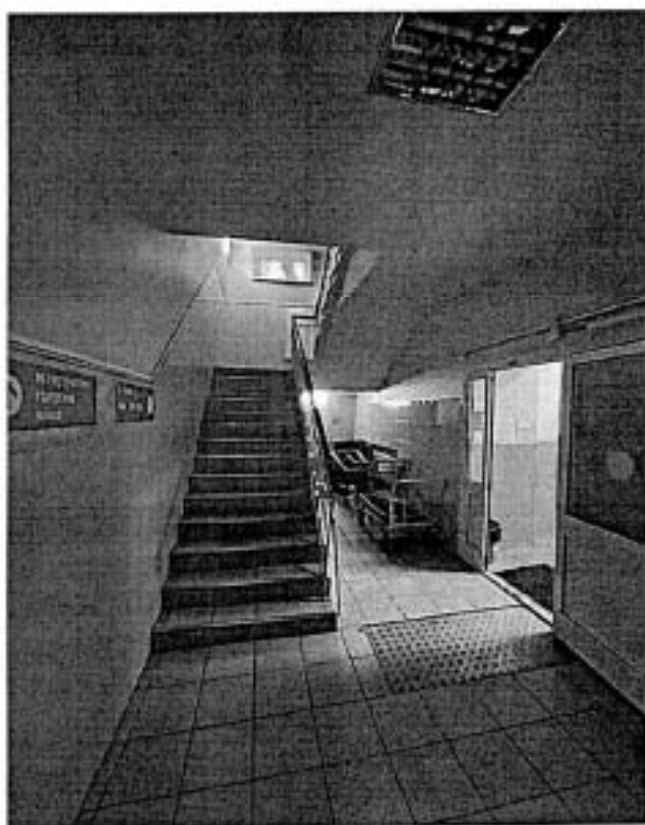
Фрагмент интерьеров 1-го этажа корпуса лит.Б
