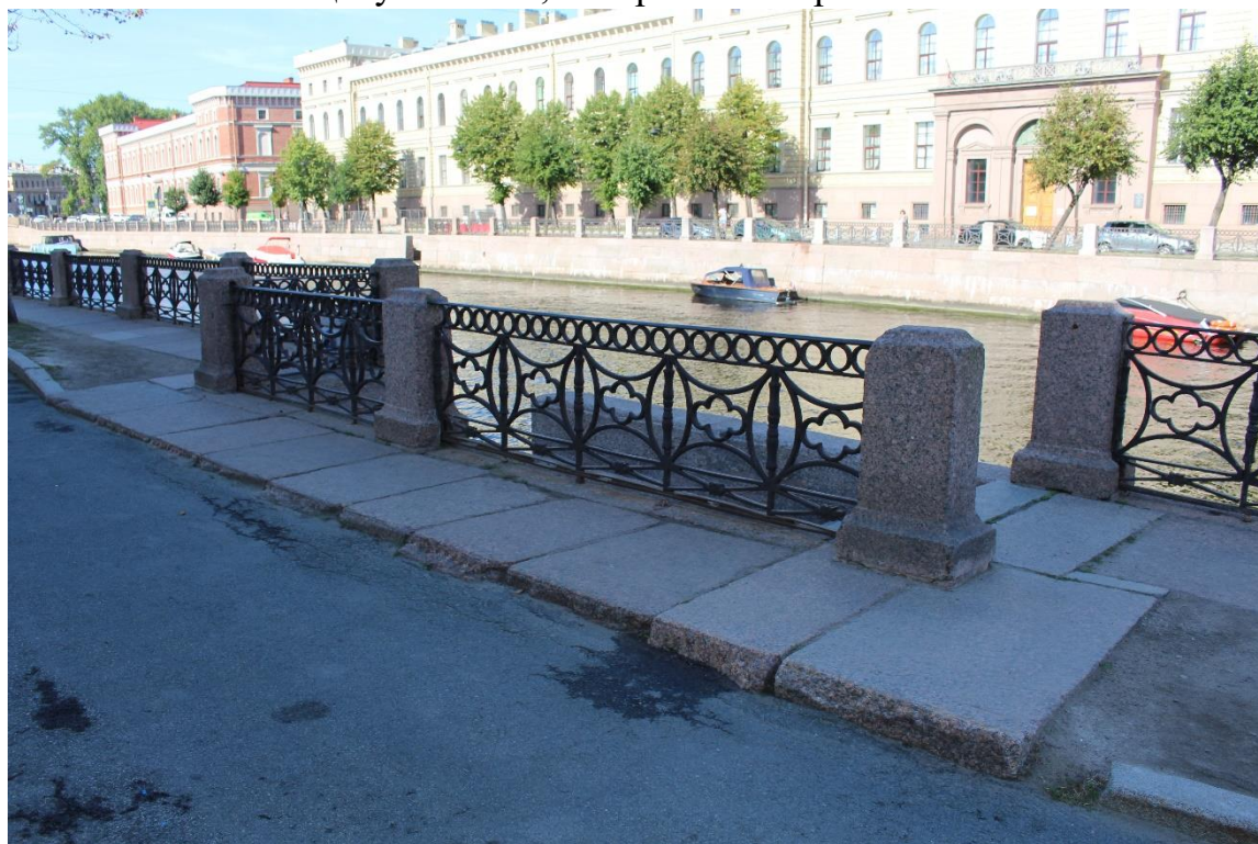
Фото 2. Вид на спуск № 17 объекта культурного наследия федерального значения «Набережные со спусками» на уч. наб. р. Мойки «Почтамтский мост - Поцелуев мост», литера Б с востока.
