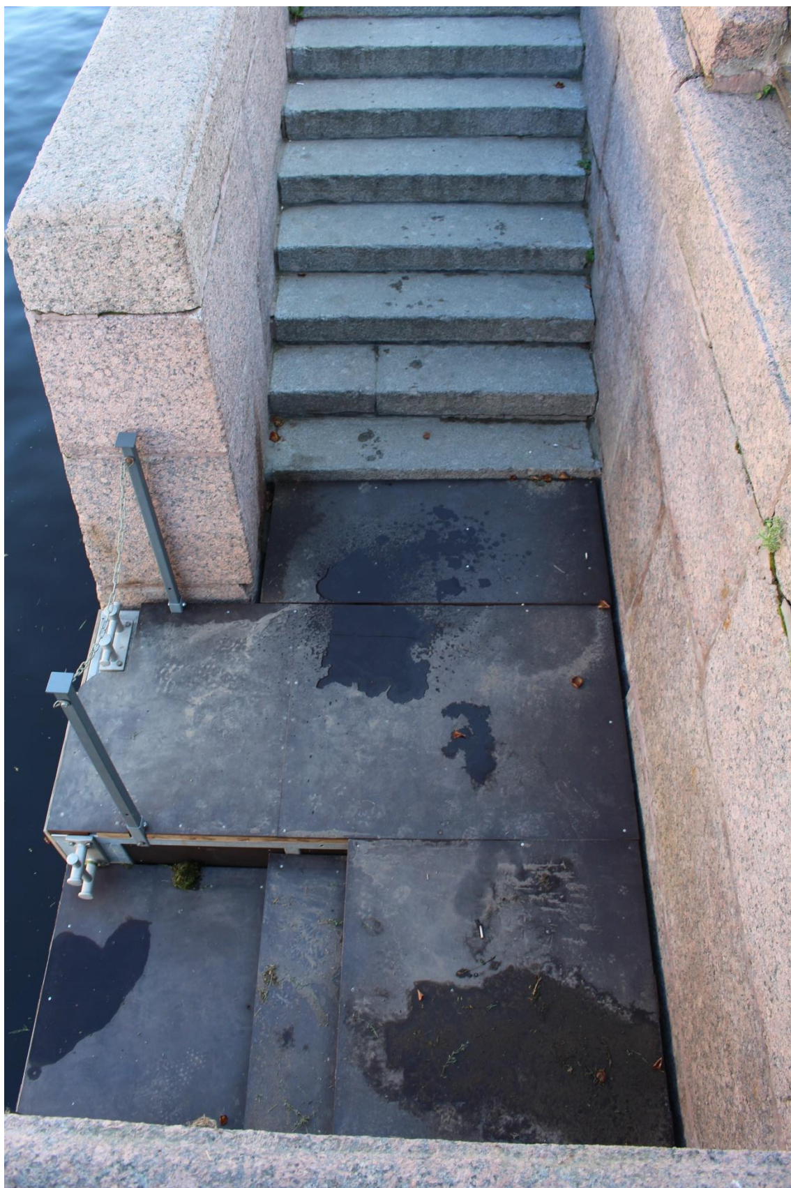
Фото 5. Вид на нижнюю спуска № 17 объекта культурного наследия федерального значения «Набережные со спусками» на уч. наб. р. Мойки «Почтамтский мост - Поцелуев мост», литера Б с юго-запада.
