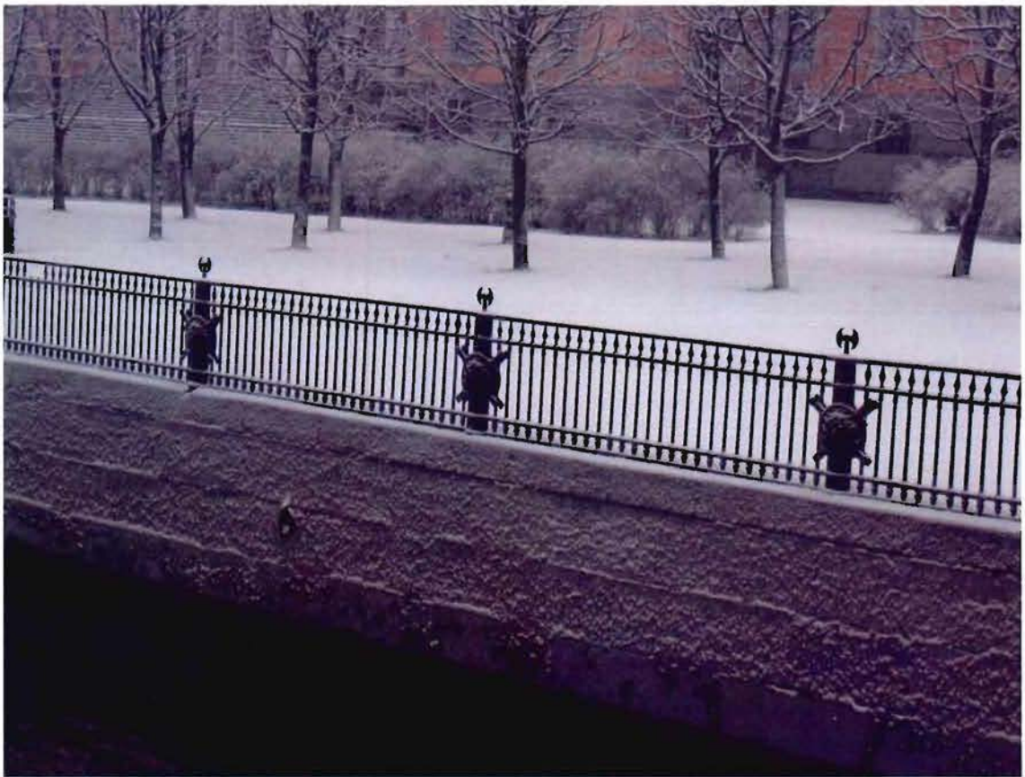
3. Ограждение набережной со стороны Михайловского (Инженерного) замка
