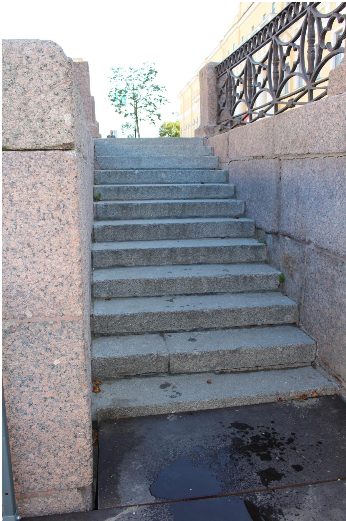
Фото 4. Вид на одномаршевую лестницу спуска № 17 объекта культурного наследия федерального значения «Набережные со спусками» на уч. наб. р. Мойки «Почтамтский мост - Поцелуев мост», литера Б с нижней площадки спуска.
