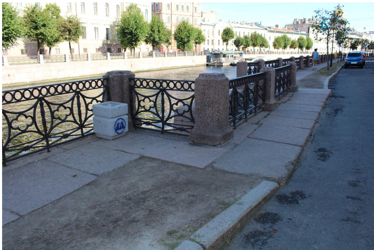
Фото 3. Вид на спуск № 17 объекта культурного наследия федерального значения «Набережные со спусками» на уч. наб. р. Мойки «Почтамтский мост - Поцелуев мост», литера Б с юга.
