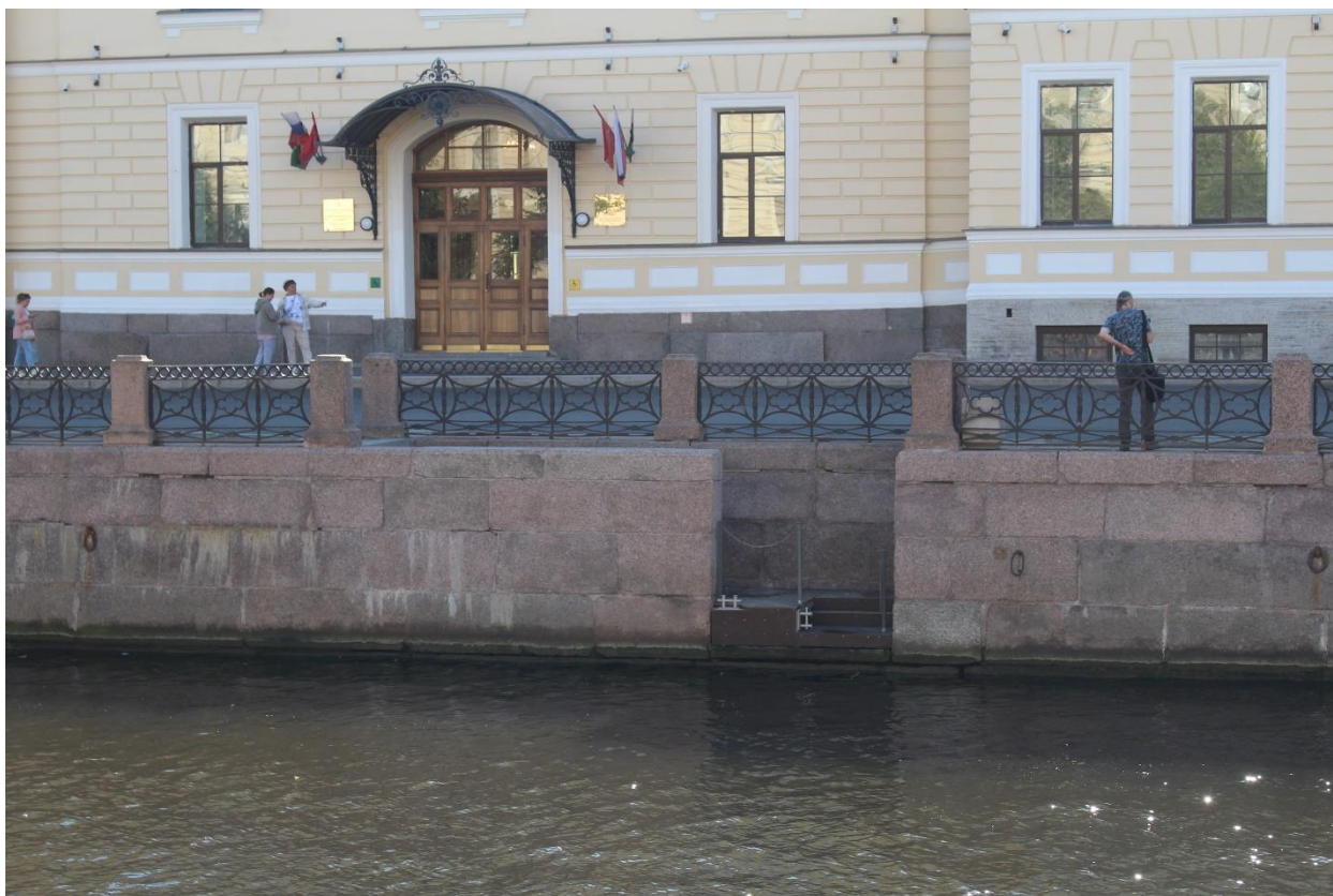
Фото 6. Вид на спуск № 17 объекта культурного наследия федерального значения «Набережные со спусками» на уч. наб. р. Мойки «Почтамтский мост - Поцелуев мост», литера Б с северо-запада.
