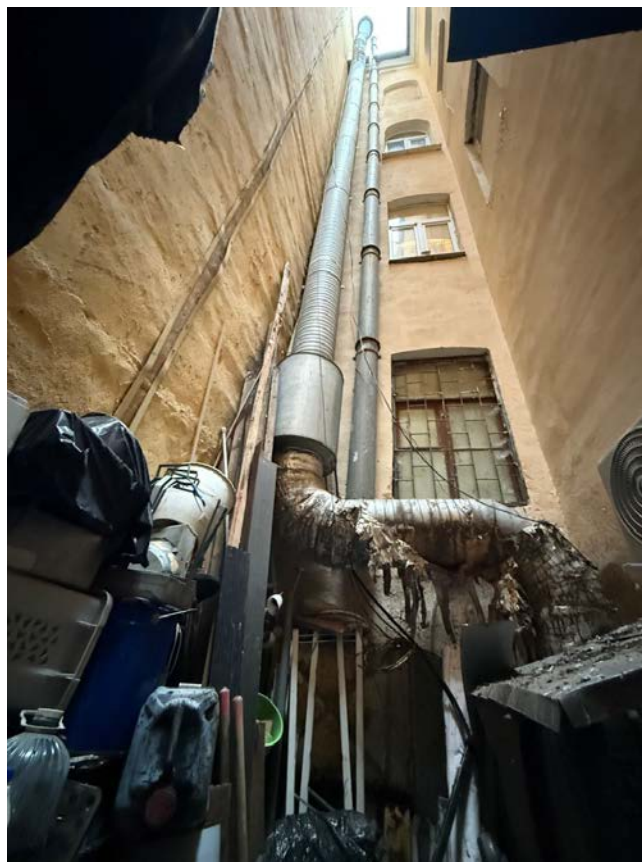
Фото 4 Фрагмент двора-колодца выявленного объекта культурного наследия «Доходный дом подворья Троице-Сергиевой лавры»
