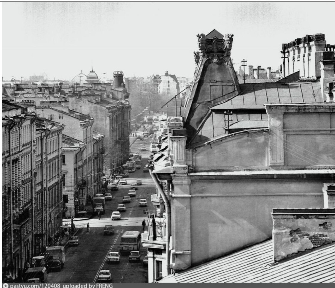
21. Загородный проспект. Вид с северо-восточной стороны на крышу левой части доходного дома Коммерческого училища. 1988 г.
