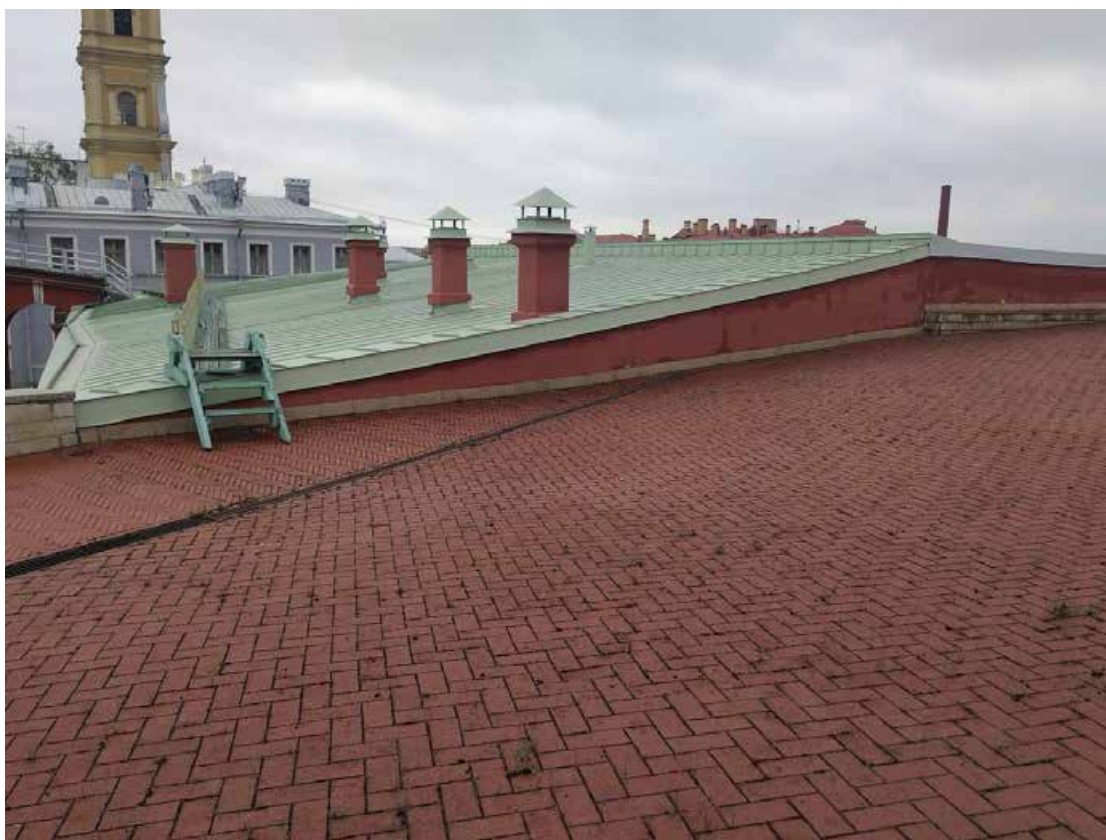
Фото 20. Кровля над правым фланком. 01 августа 2025г.
