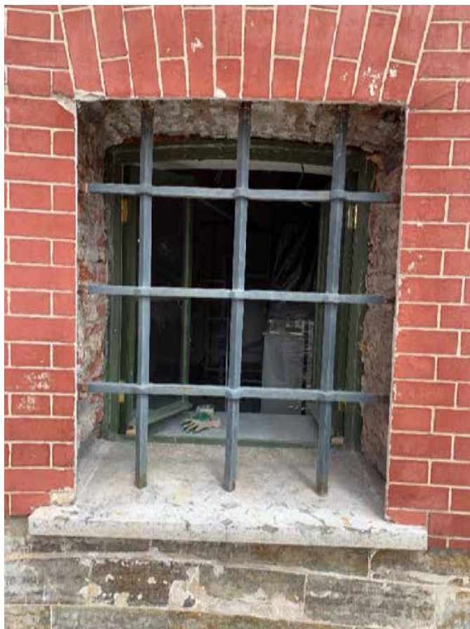
Фото 25. Окно устроенное в валганговой стене бастиона. 01 августа 2025г.
