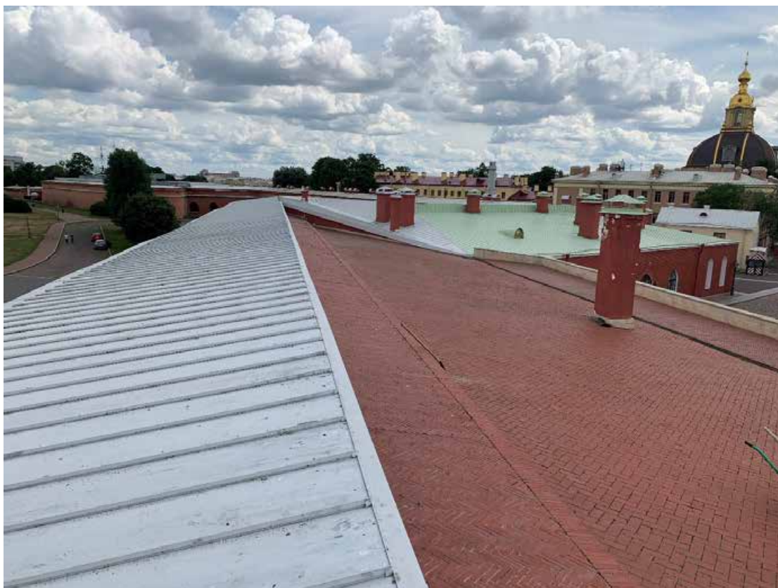
Фото 19. Валганг, барбет и бруствер Головкина бастиона над левым фасом. 01 августа 2025г.
