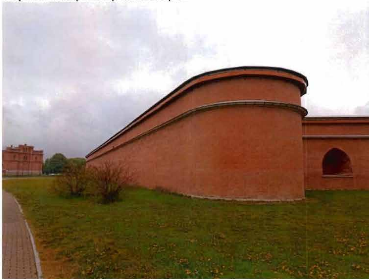
6. Орильон и эскарповый фасад левого фаса.
