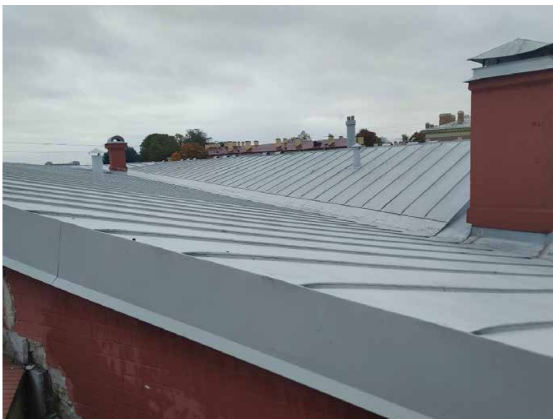
Фото 24. Кровля над орильоном левого фаса. 01 августа 2025г.
