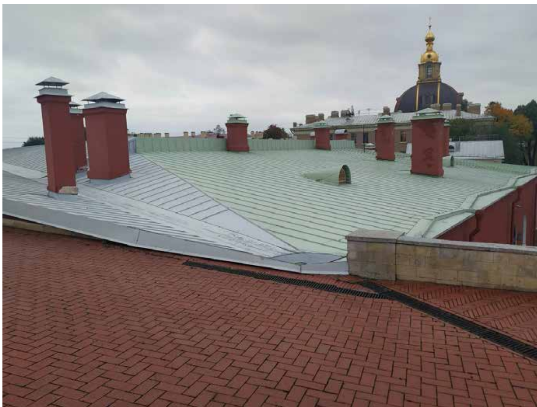
Фото 23. Кровля над левым фланком. 01 августа 2025г.
