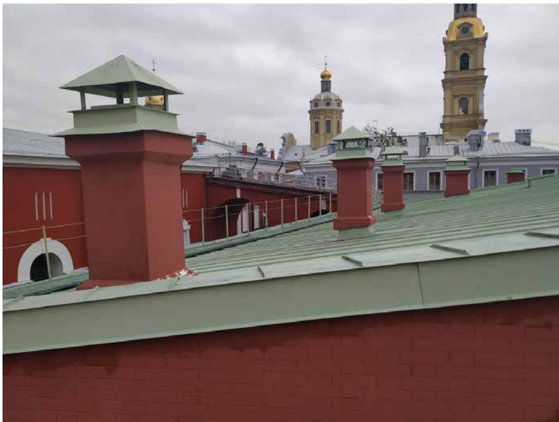
Фото 26. Кирпичные вентканалы. 01 августа 2025г.
