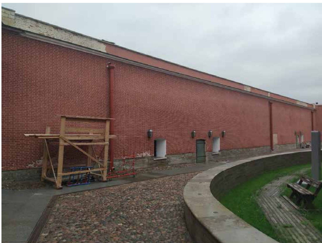
Фото 16. Валганговая стена правого фаса Головкина бастиона. 01 августа 2025г.
