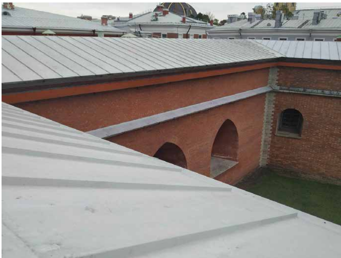
Фото 21. Кровля над правым фланком. 01 августа 2025г.
