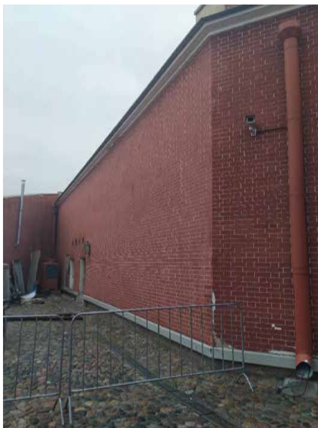
Фото 14. Валганговая стена левого фаса Головкина бастиона. 01 августа 2025г.
