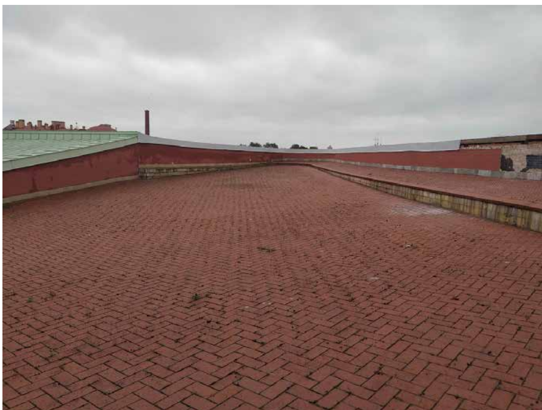
Фото 22. Валганг орильяна правого фаса. 01 августа 2025г.
