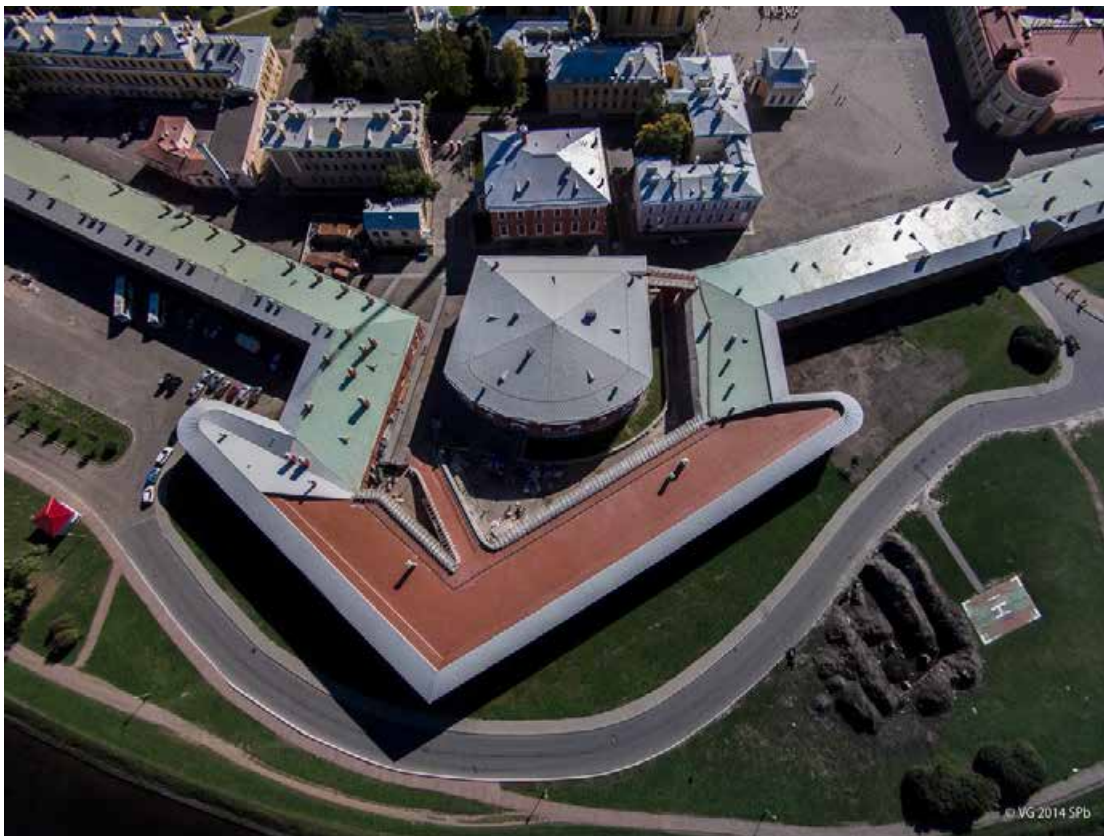
Фото 1. Общий вид сверху на Головкин бастион Петропавловской крепости. 01 августа 2025г.
