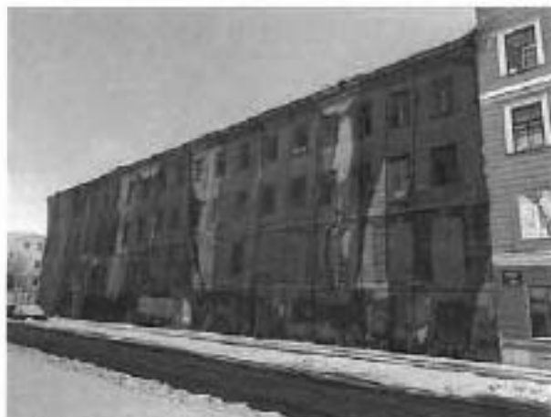
2. Лицевой фасад по набережной реки Пряжки.
