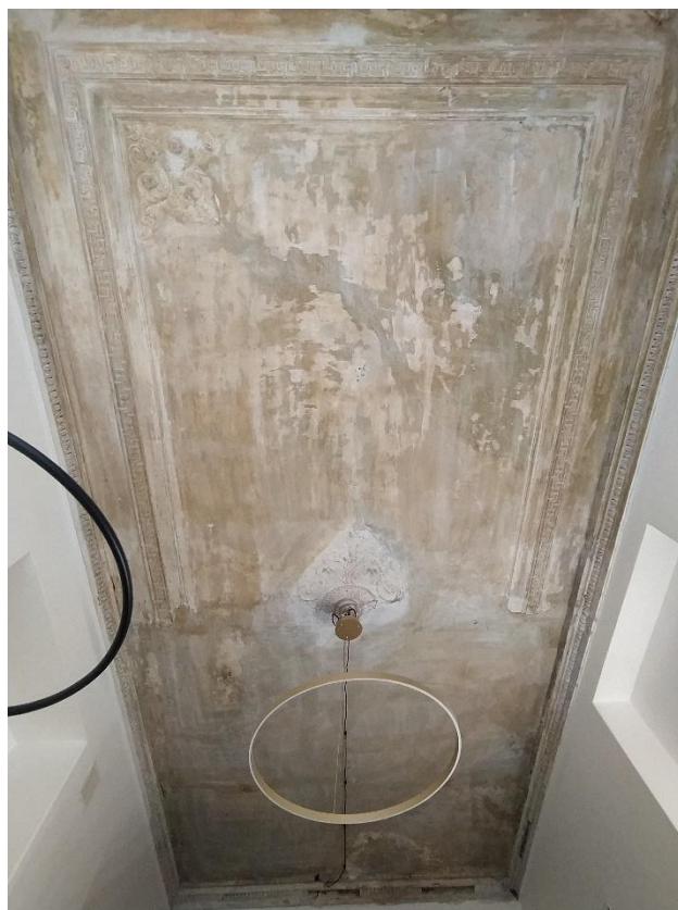
Фото 56. Вид на потолок в пом. № 19. Потолок очищен от грязи, без дальнейшего оштукатуривания и окраски.
