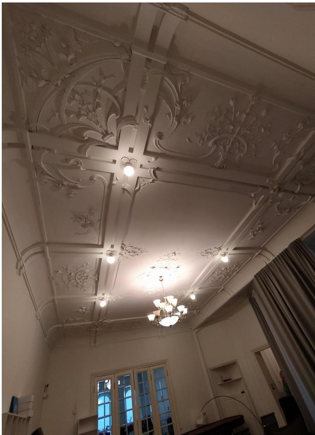
Фото 21. Обзор потолка в пом. № 2.
