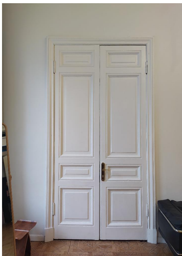
Фото 40. Дверь между помещениями № 13 и № 16.
