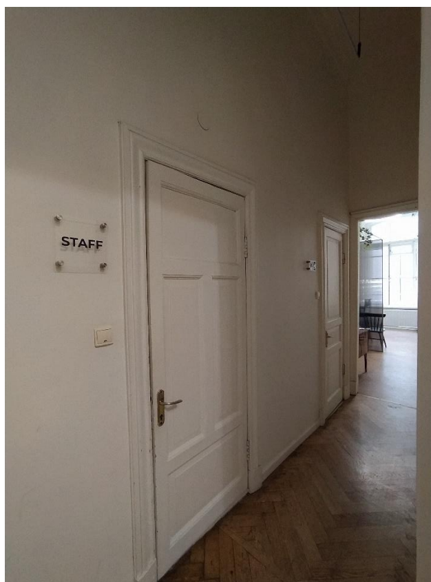
Фото 50. Продолжение помещения коридора № 14, вид. на входы в санузлы.
