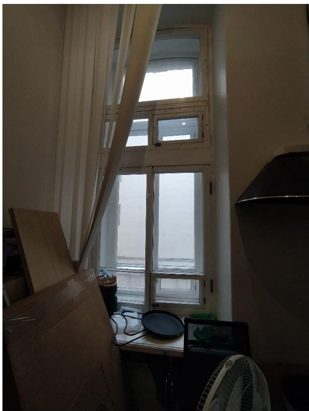
Фото 26. Вид на окно в хозяйственном помещении № 8.
