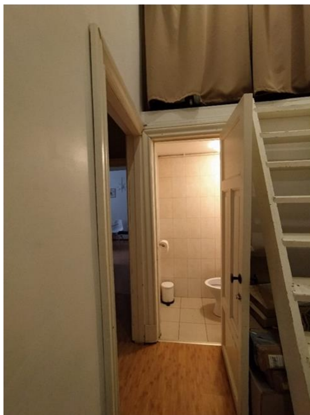
Фото 25. Помещение туалета № 6, кв. № 2.
