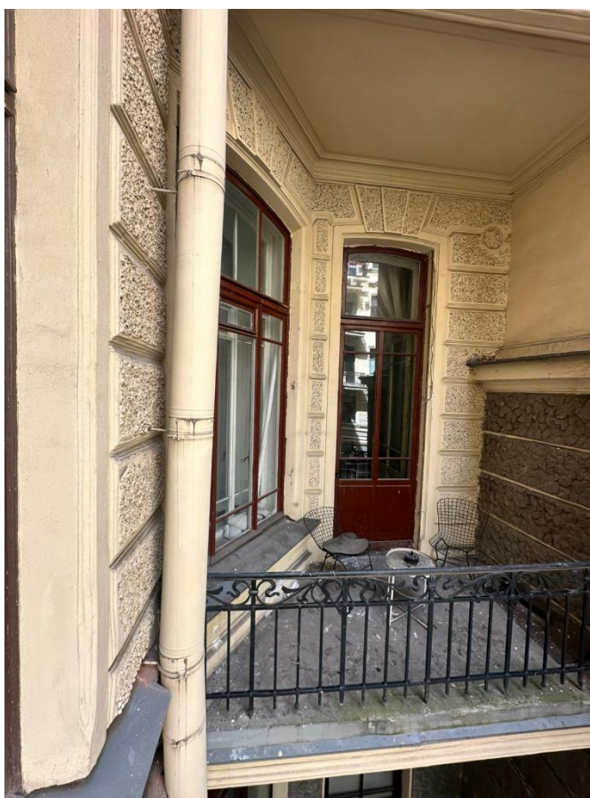
Фото 4. Западный внутренний двор. Западный и северный фасады здания. Вид на окно кв. №2 (окна в пом. 12) и балкон (пом. 1).
