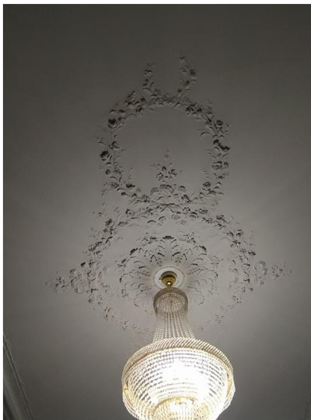
Фото 33. Потолочная розетка в пом. № 12, справа.
