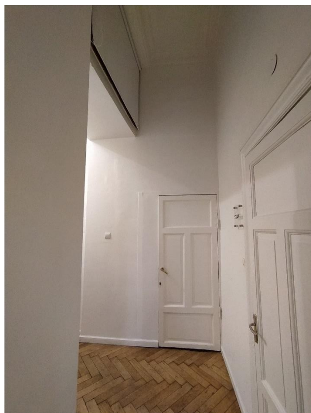
Фото 47. Помещение № 16, вид на второй вход.
