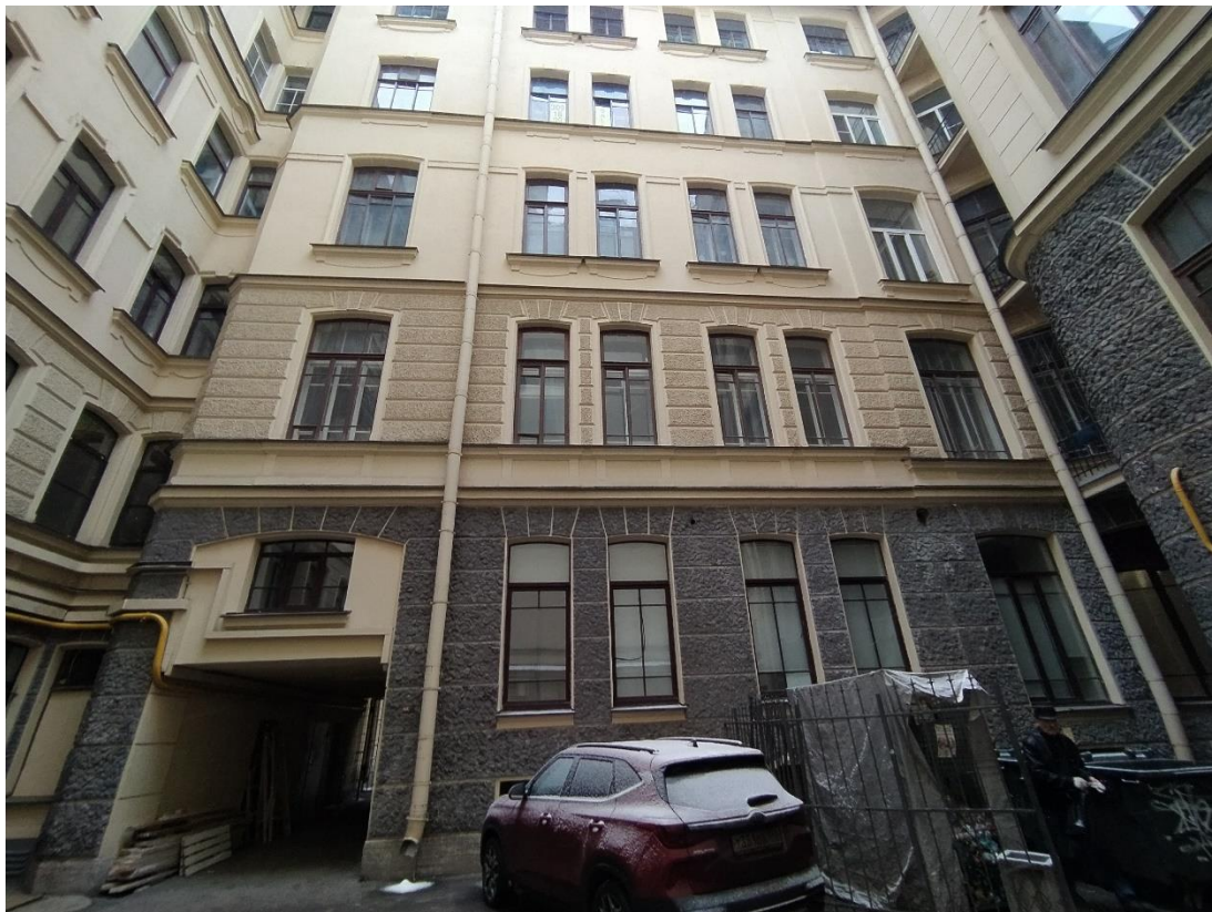
Фото 5. Западный фасад дворового корпуса здания
