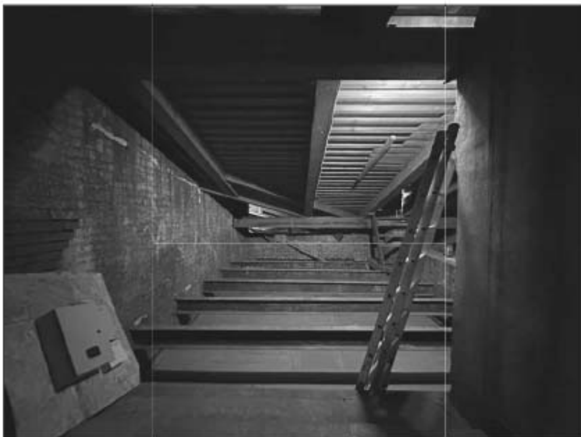
17. ОКНФЗ «Дом, где в первой половине XIX в. размещалась Российско-Американская компания. Здесь в 1820-х гг. жили декабристы Бестужев-Марлинский А.А. и Рылев К.Ф.». Юго-западная часть чердака в осях 3-4/Е-Ж. Металлические балки перекрытия. 28.05.2024г.
