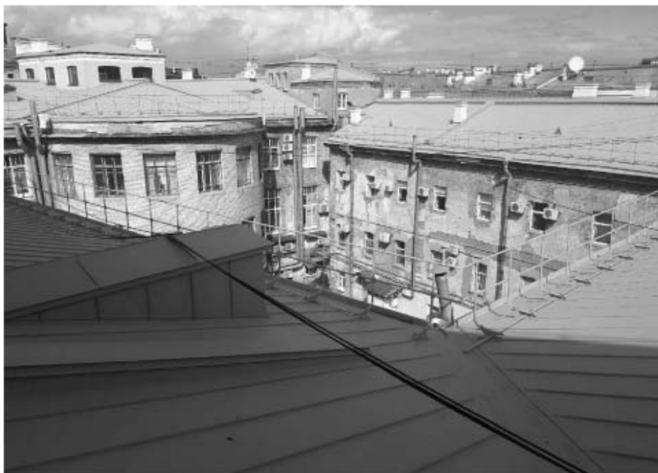
67. Кровля над корпусами первого двора. Март 2022г.
