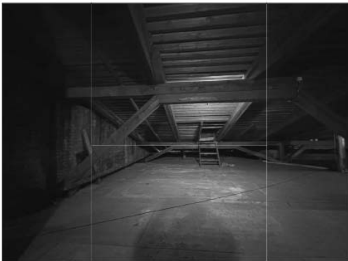
45. ОКНФЗ «Дом, где в первой половине XIX в. размещалась Российско-Американская компания. Здесь в 1820-х гг. жили декабристы Бестужев-Марлинский А.А. и Рылеев К.Ф.». Юго-восточная часть чердака в осях 3/1-6/-М. Восточное чердачное окно. Фрагмент стропильной системы. Балки из бруса. 28.05.2024г.
