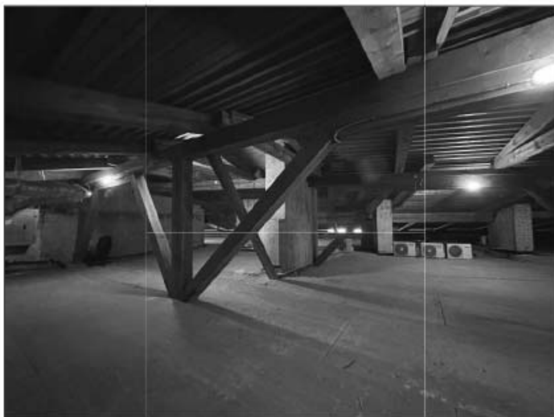
41. ОКНФЗ «Дом, где в первой половине XIX в. размещалась Российско-Американская компания. Здесь в 1820-х гг. жили декабристы Бестужев-Марлинский А.А. и Рылов К.Ф.». Восточная часть чердака в осях 1-5/1/И-П. Фрагмент стропильной системы. Балка из бруса. 28.05.2024г.
