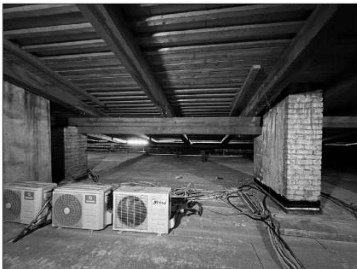
35. ОКНФЗ «Дом, где в первой половине XIX в. размещалась Российско-Американская компания. Здесь в 1820-х гг. жили декабристы Бестужев-Марлинский А.А. и Рылеев К.Ф.». Северо-восточная часть чердака в осях 1-2/Н-П. Фрагмент стропильной системы. Балка из бруса. Обрешетка. 28.05.2024г.
