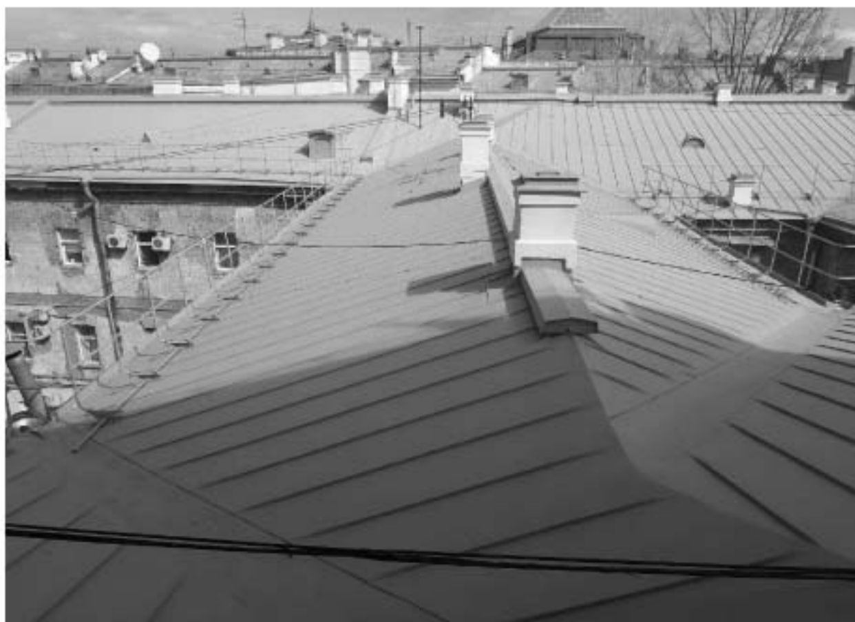
69. Кровля над поперечным корпусом. Март 2022г.
