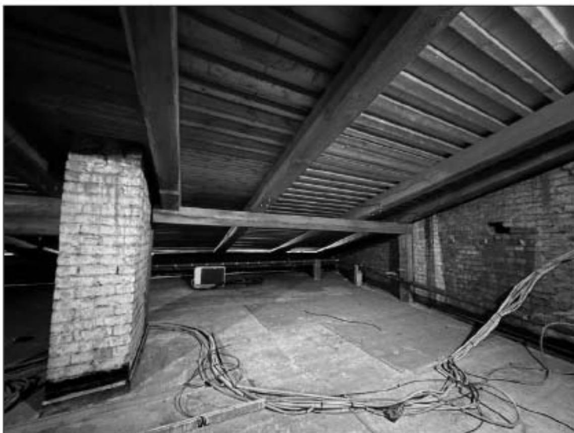
34. ОКНФЗ «Дом, где в первой половине XIX в. размещалась Российско-Американская компания. Здесь в 1820-х гг. жили декабристы Бестужев-Марлинский А.А. и Рылев К.Ф.». Северо-восточная часть чердака в осях 1-2/П-Р. Фрагмент стропильной системы. Балка из бруса. Обрешетка. 28.05.2024г.
