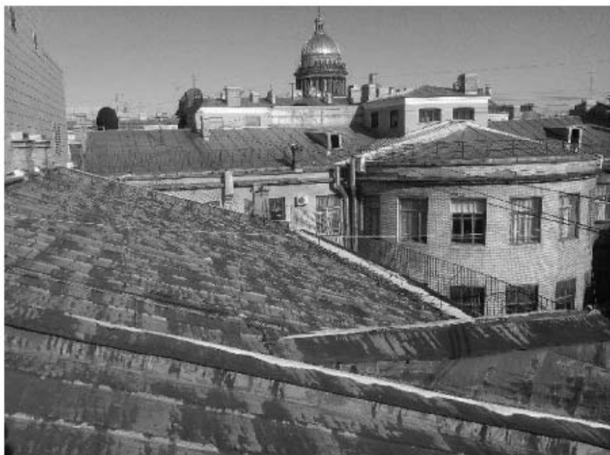
66. Кровля над корпусами первого двора. Февраль 2019г. Отчетная документация о выполненных работах по сохранению объекта культурного наследия федерального значения «Дом, где в первой половине XIX века размещалась Российско-Американская компания. Здесь в 1920-х годах жили декабристы Бестужев-Марлинский А.А. и Рылеев К.Ф.» «Ремонт кровли в осях 6-16/А-Р». СПб, 2022.
