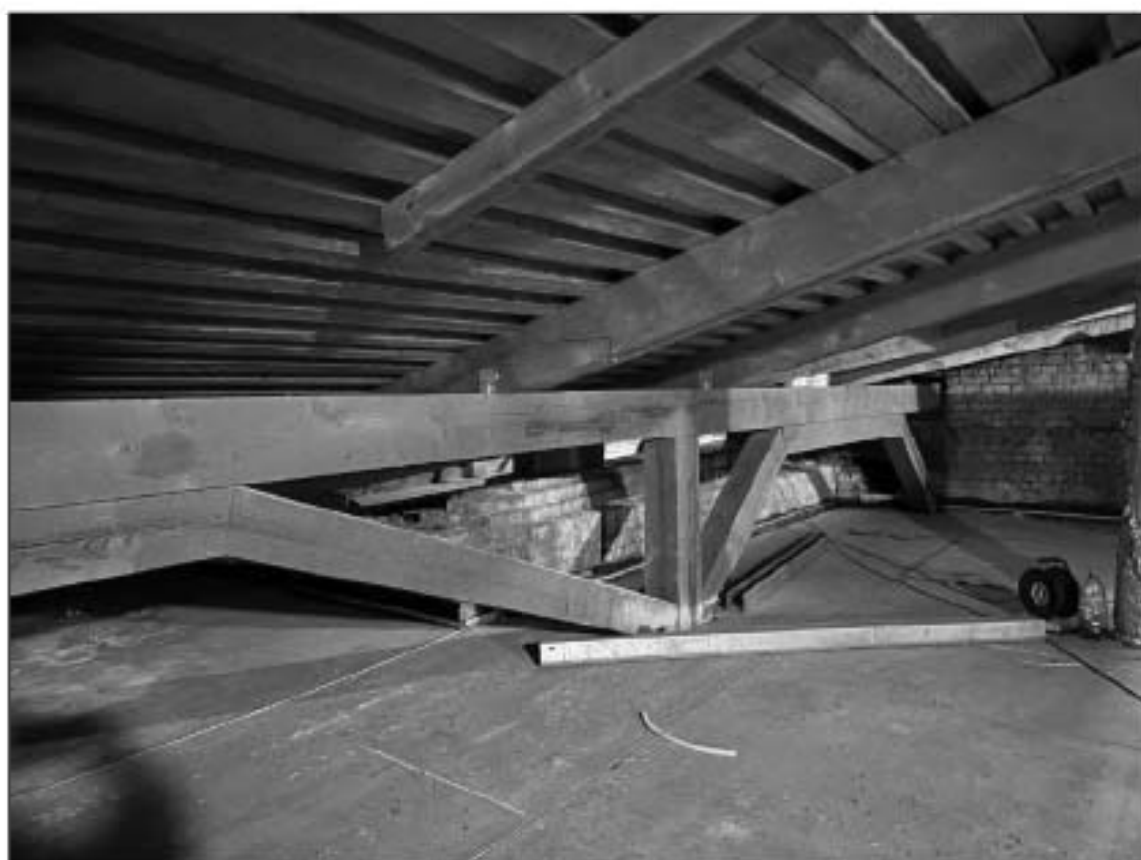
44. ОКНФЗ «Дом, где в первой половине XIX в. размещалась Российско-Американская компания. Здесь в 1820-х гг. жили декабристы Бестужев-Марлинский А.А. и Рылеев К.Ф.». Юго-восточная часть чердака в осях 4-6/1/И-М. Фрагмент стропильной системы. Балка из бруса. 28.05.2024г.
