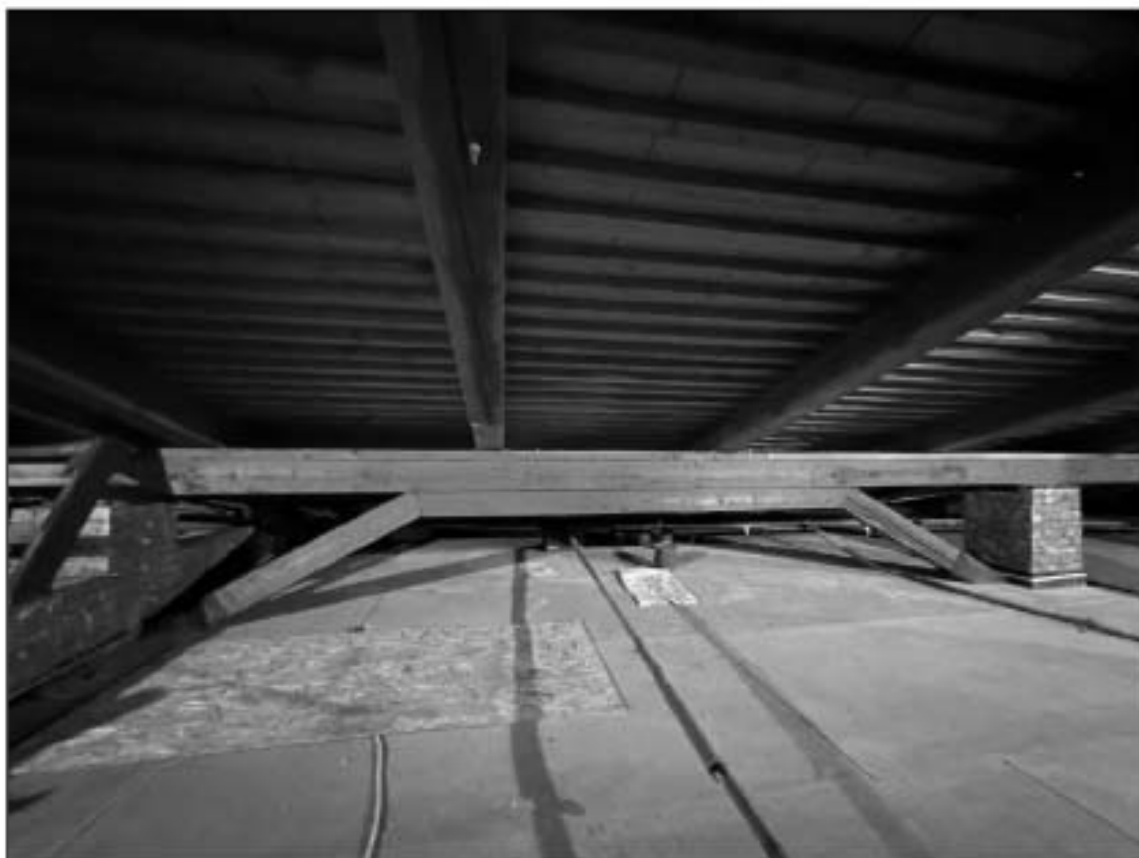
23. ОКНФЗ «Дом, где в первой половине XIX в. размещалась Российско-Американская компания. Здесь в 1820-х гг. жили декабристы Бестужев-Марлинский А.А. и Рылеев К.Ф.». Юго-западная часть чердака в осях 5-6/Е-Г. Фрагмент стропильной системы. Балка из бруса. 28.05.2024г.
