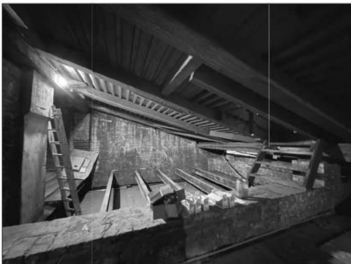
18. ОКНФЗ «Дом, где в первой половине XIX в. размещалась Российско-Американская компания. Здесь в 1820-х гг. жили декабристы Бестужев-Марлинский А.А. и Рылев К.Ф.». Юго-западная часть чердака в осях 3-5/Е-Ж. Металлические балки перекрытия. Западная кирпичная стена парадной лестницы. 28.05.2024г.
