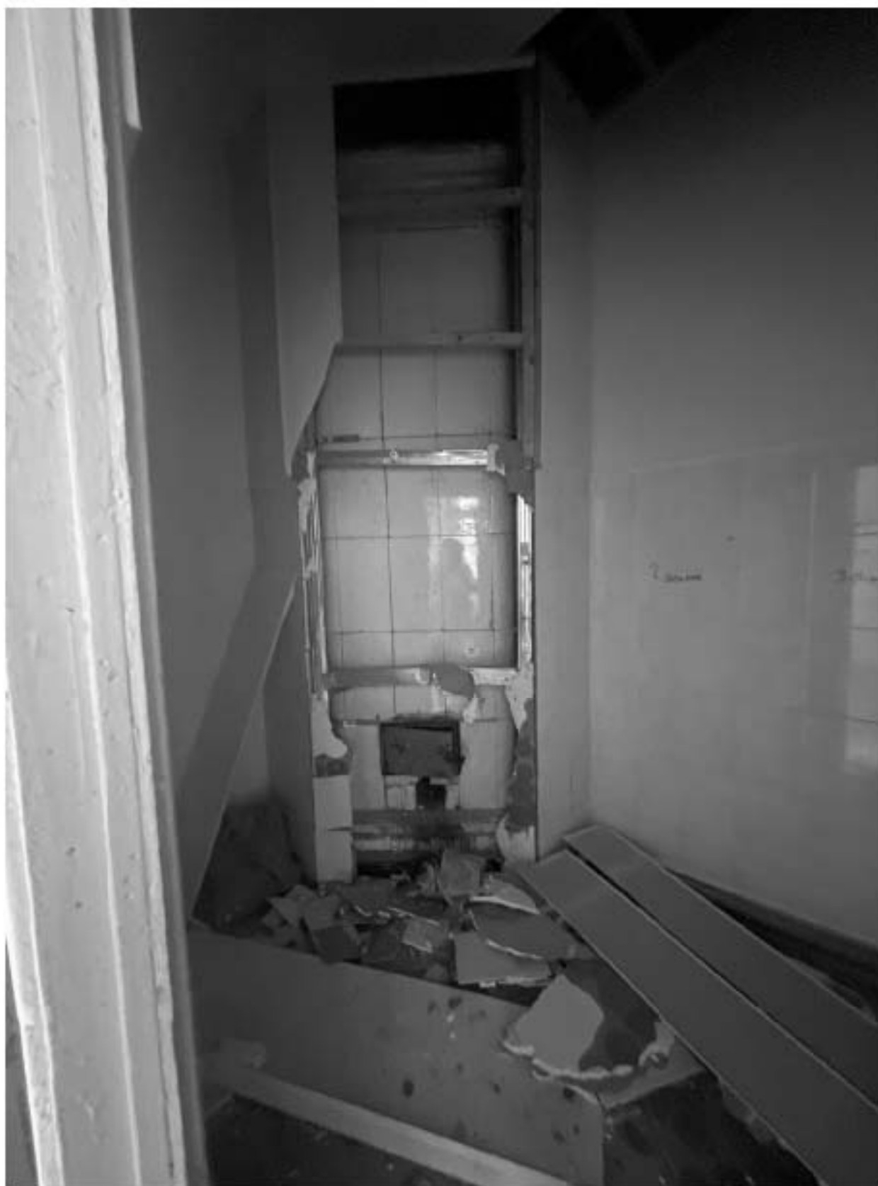
34. Фрагмент интерьера помещения №21 (вид на печь);
