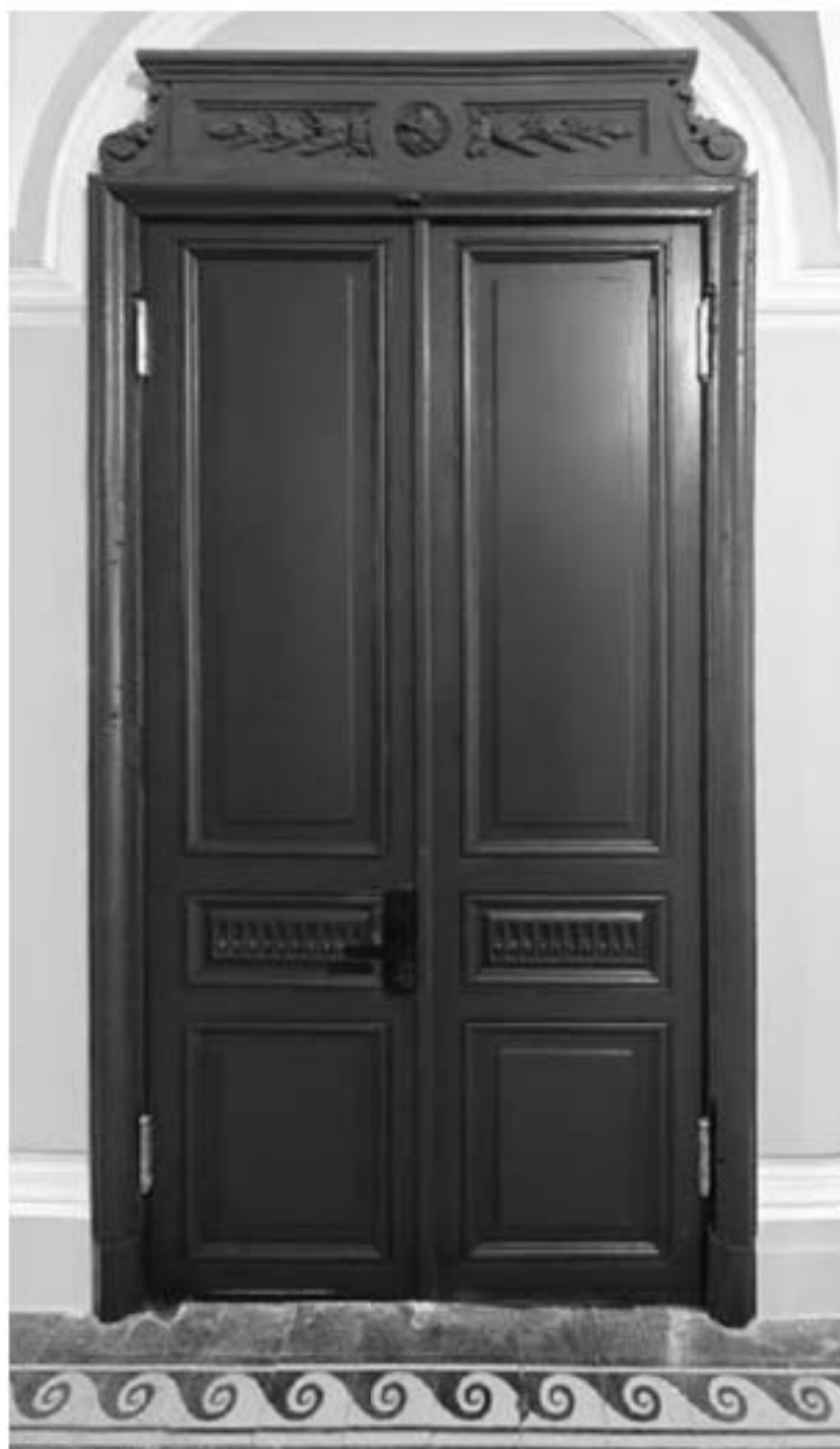
7. Вид на входную дверь в помещение;
