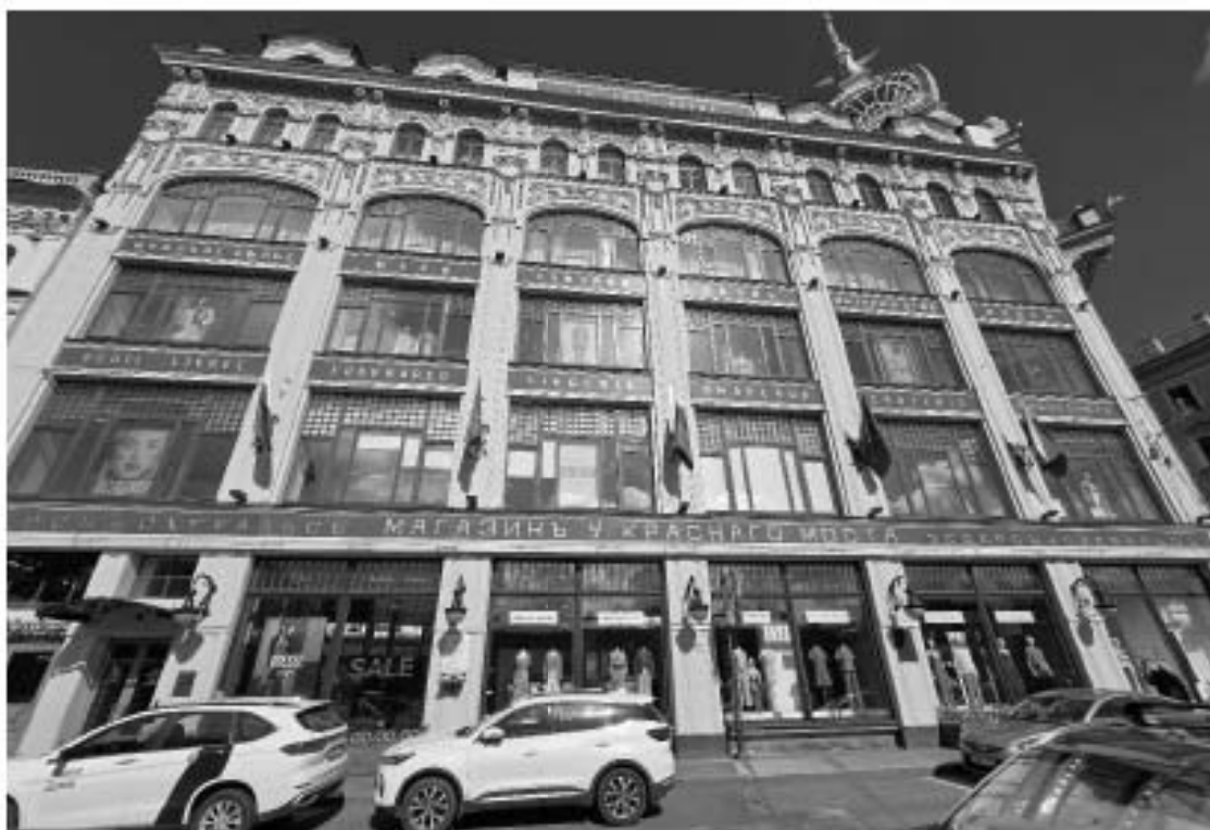
Фото 2. Южный фасад здания.
