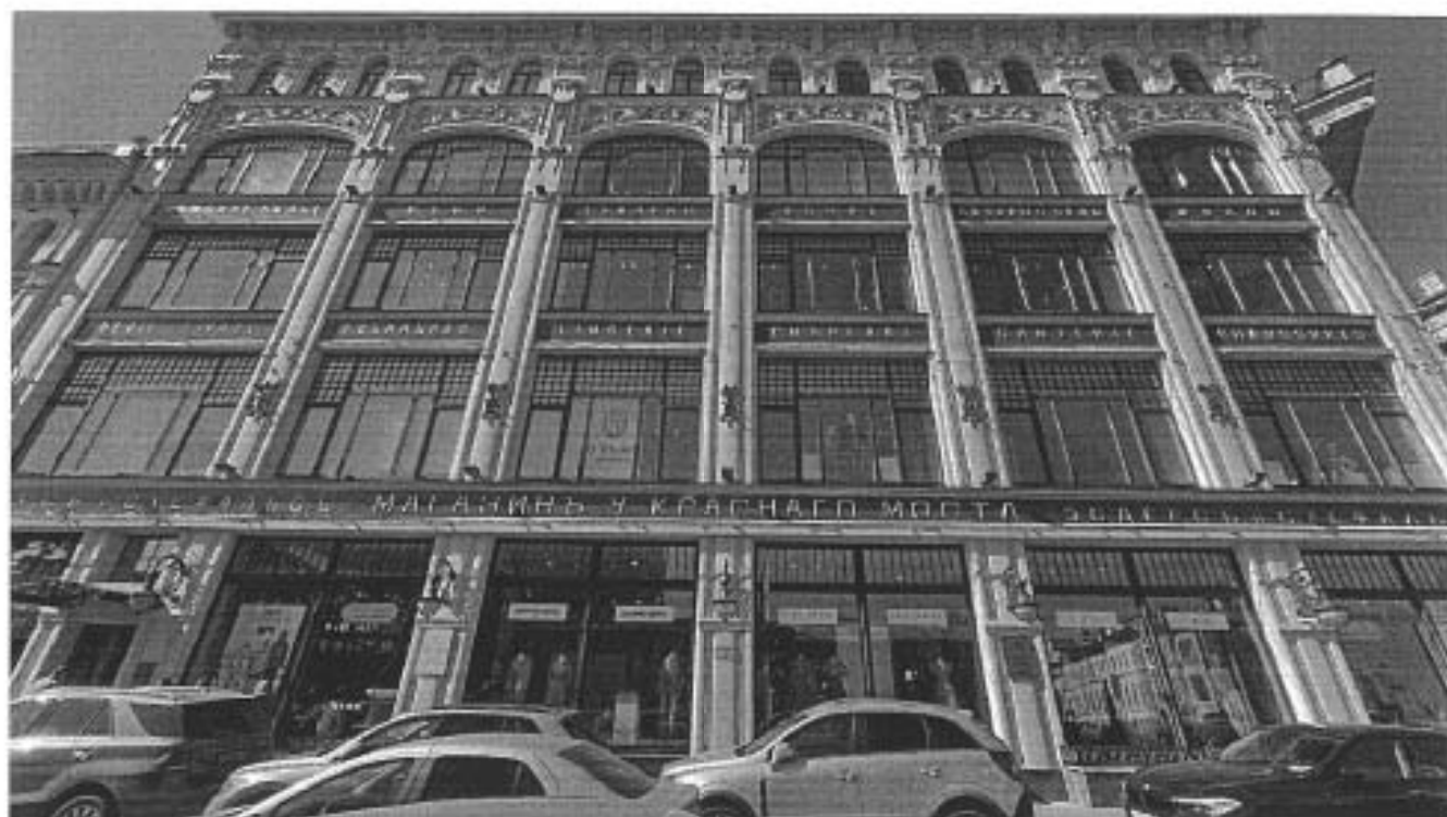
3. Вид на южный фасад объекта культурного наследия
