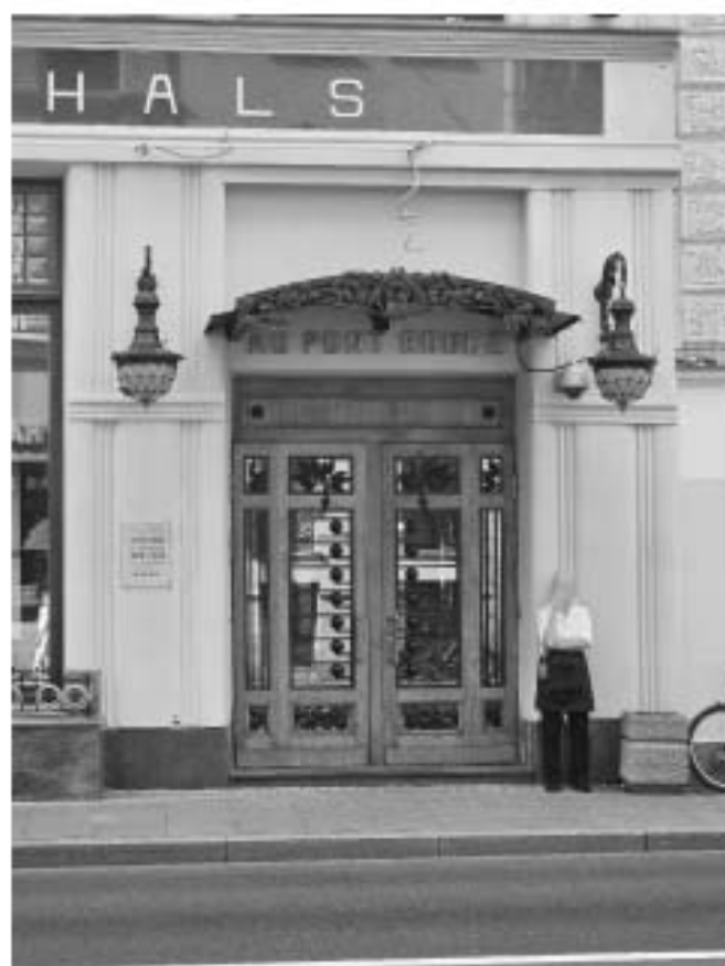
Фото 9. Входная зона, северо-восточный фасад здания.
