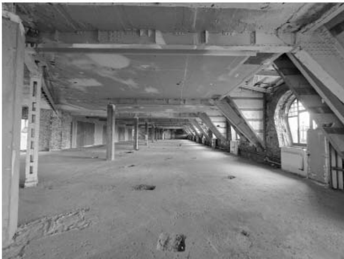
Фото 6.28. 6 этаж, помещение 1-Н (109).
