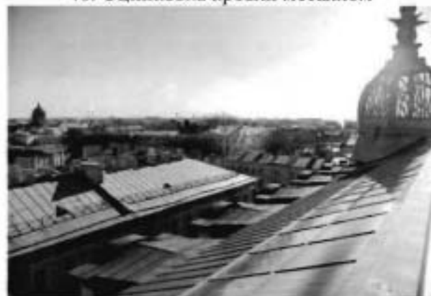
46. Оцинковка кровли металлом
