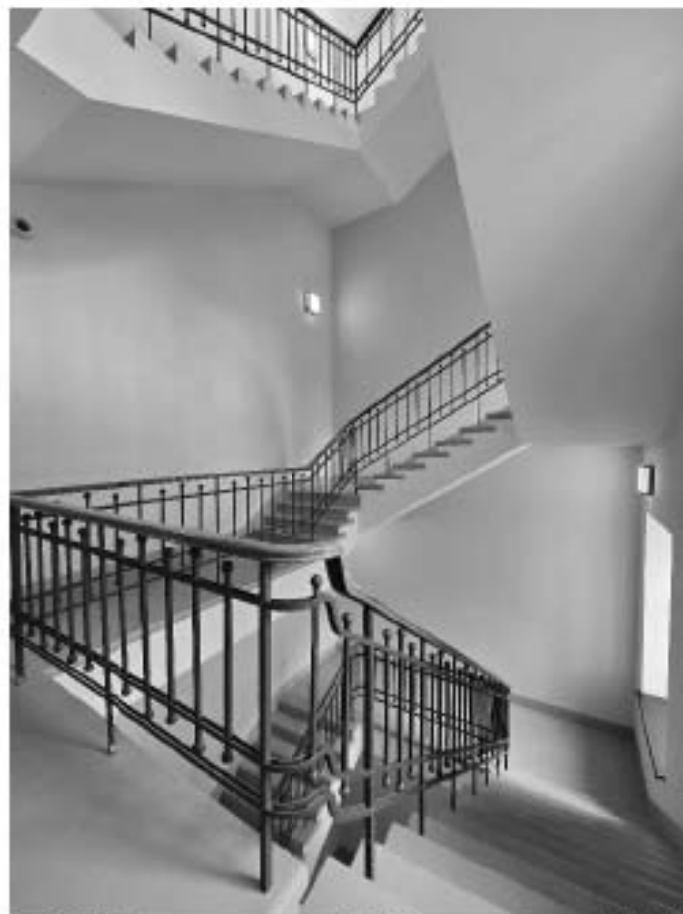
Фото 6.35. 6 этаж, лестница 3-ЛК, помещение 1-Н (112).
