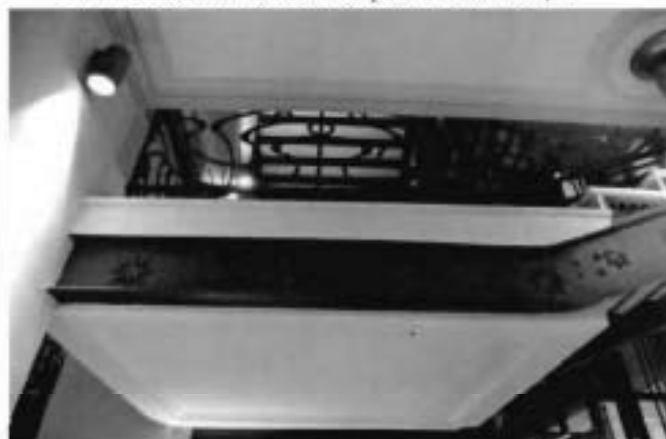
33. Металлический каркас лестницы
