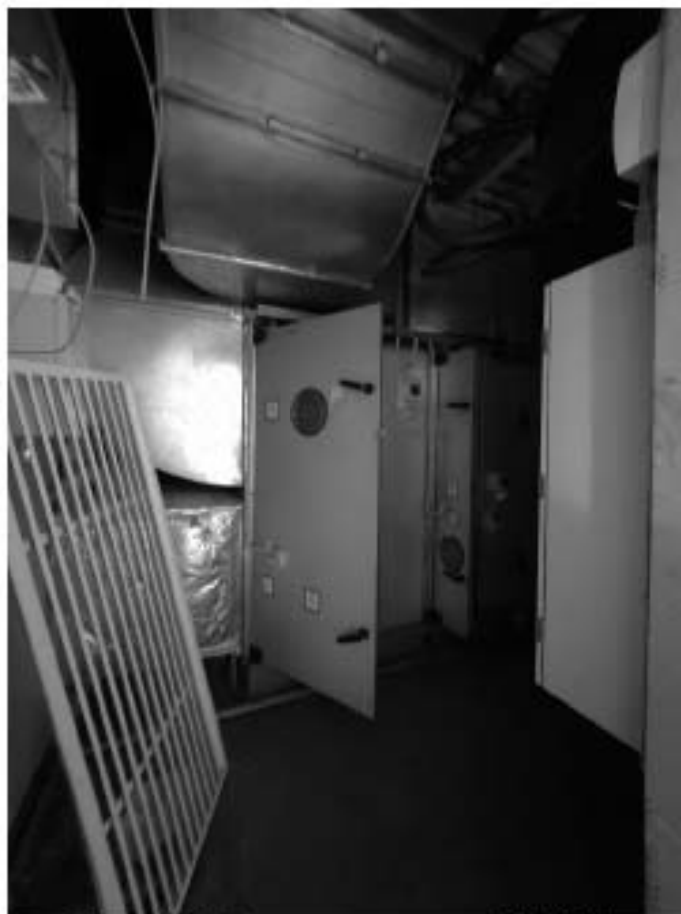
Фото 6.17. 6 этаж, помещение 1-Н (118).
