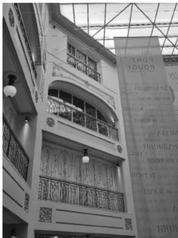
Фото 1.9. Оконные проемы на уровне 5-6 этажей.
