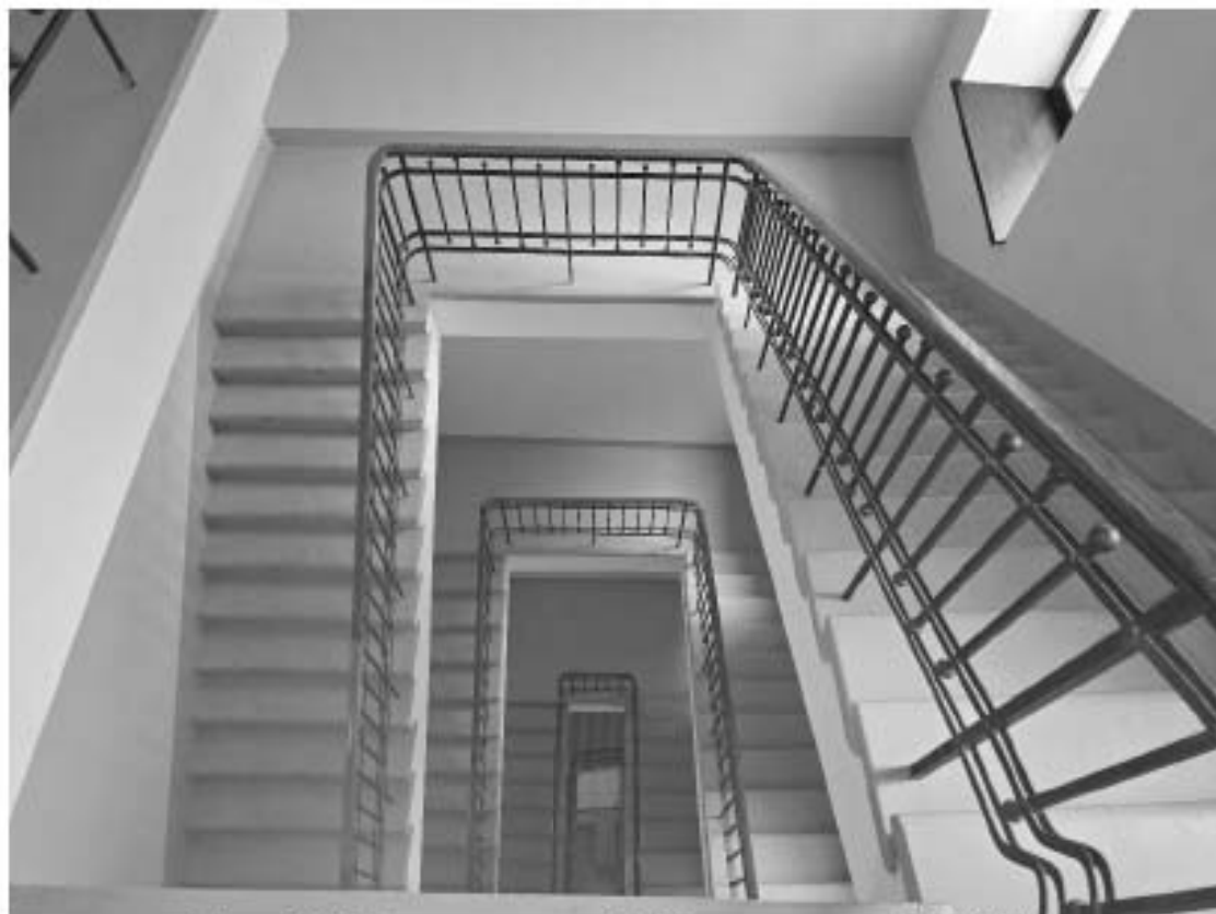
Фото 6.34. 6 этаж, лестница 3-ЛК, помещение 1-Н (112).
