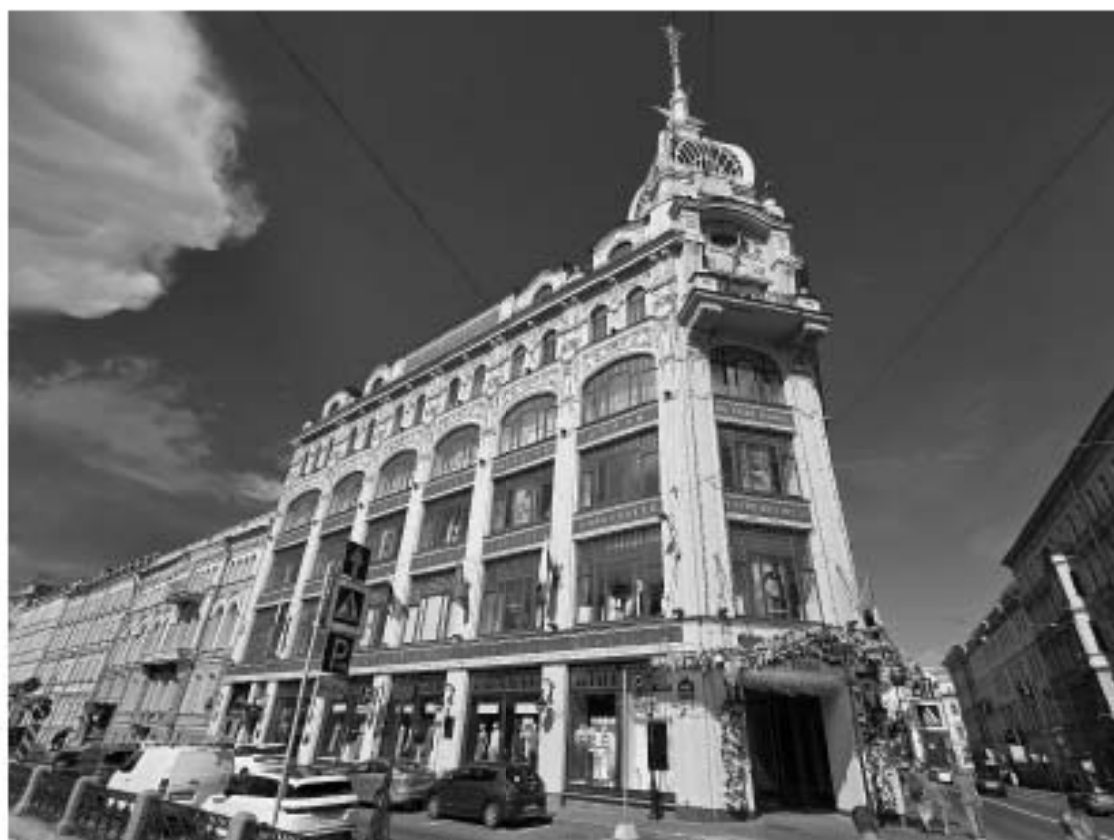
Фото 3. Южный и юго-восточный фасад здания.
