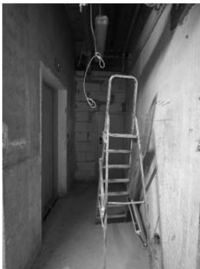
Фото 6.5. 6 этаж, помещение 1-Н (114?).
