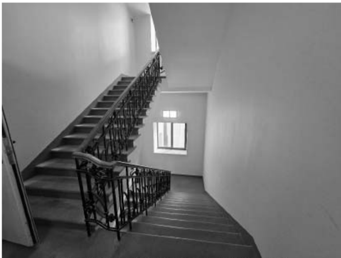
Фото 6.29. 6 этаж, лестница 2-ЛК, помещение 1-Н (119).
