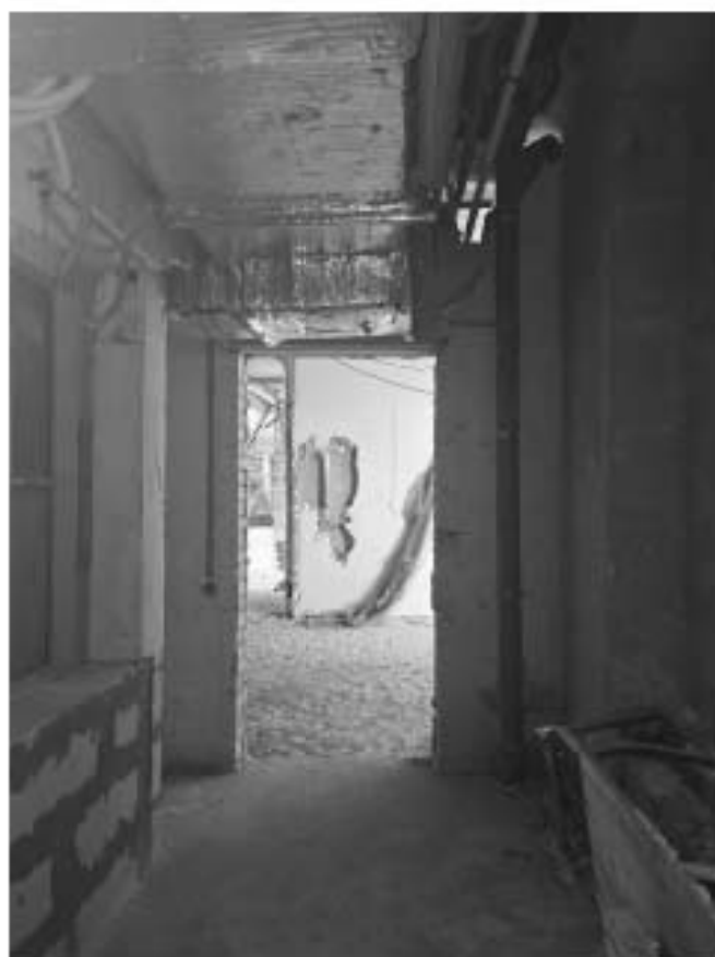
Фото 6.3. 6 этаж, помещение 1-Н (113).
