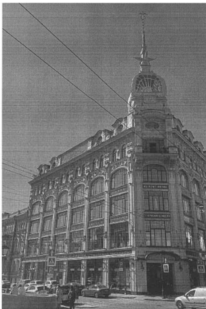
1. Вид на южный фасад объекта культурного наследия
