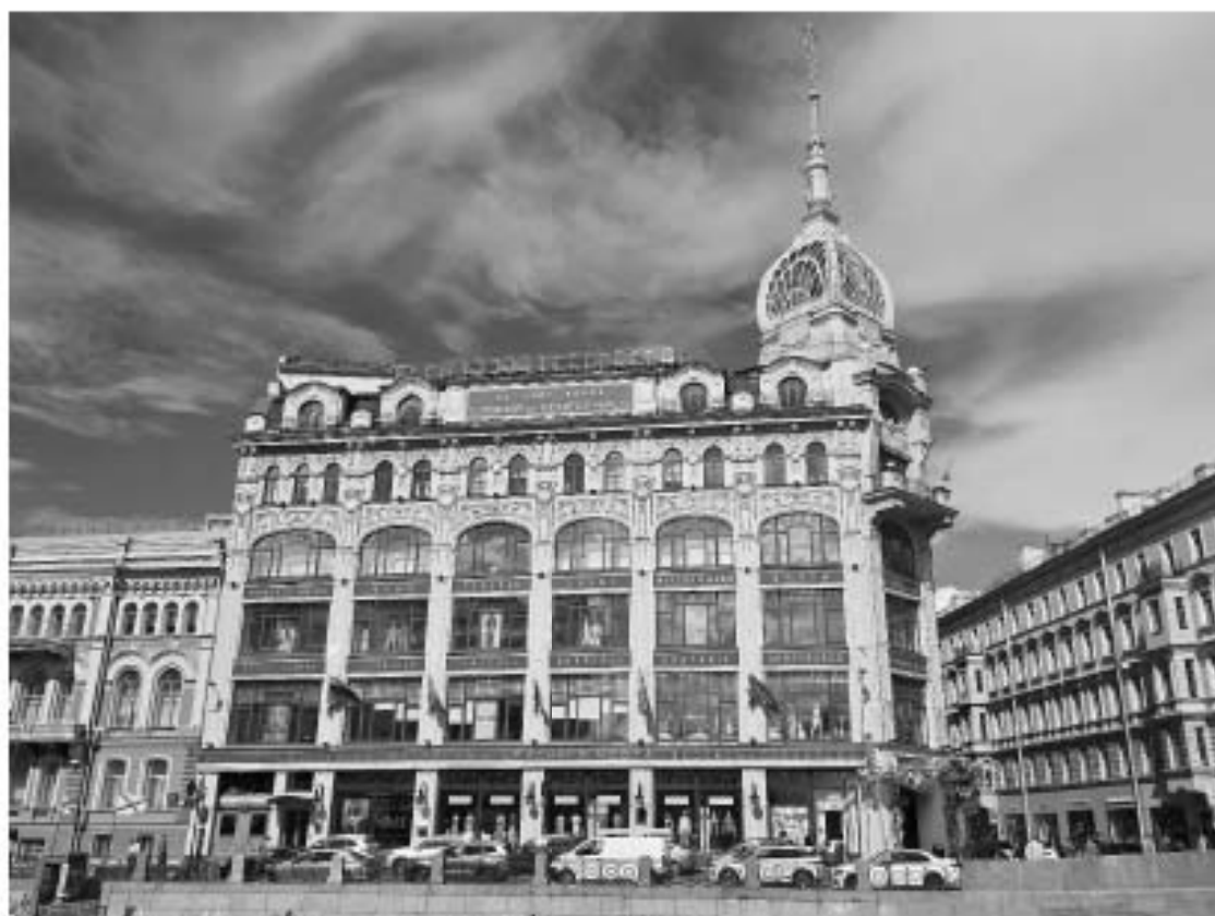
Фото 13. Южный фасад здания.
