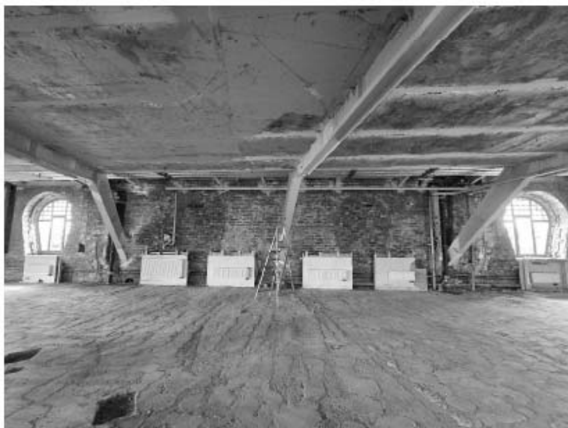
Фото 6.32. 6 этаж, помещение 1-Н (109).
