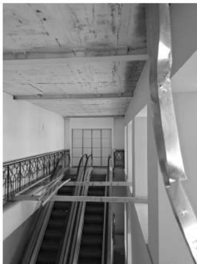
Фото 6.33. 6 этаж, помещение 1-Н (109).
