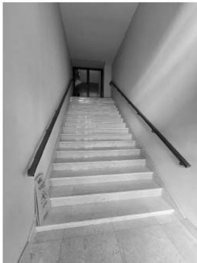
Фото 1.1. 1 этаж, лестница в юго-западной части здания, помещение 1-Н (6).
