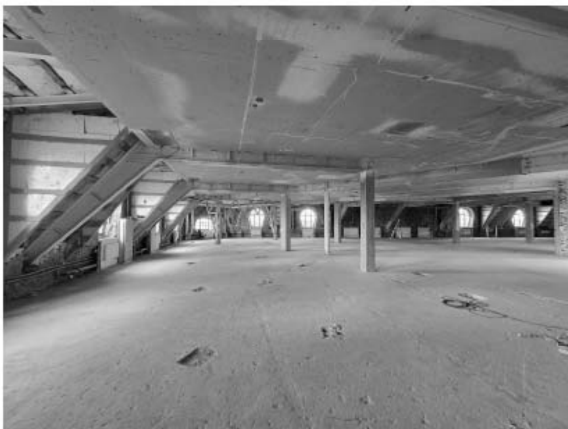
Фото 6.26. 6 этаж, помещение 1-Н (109).
