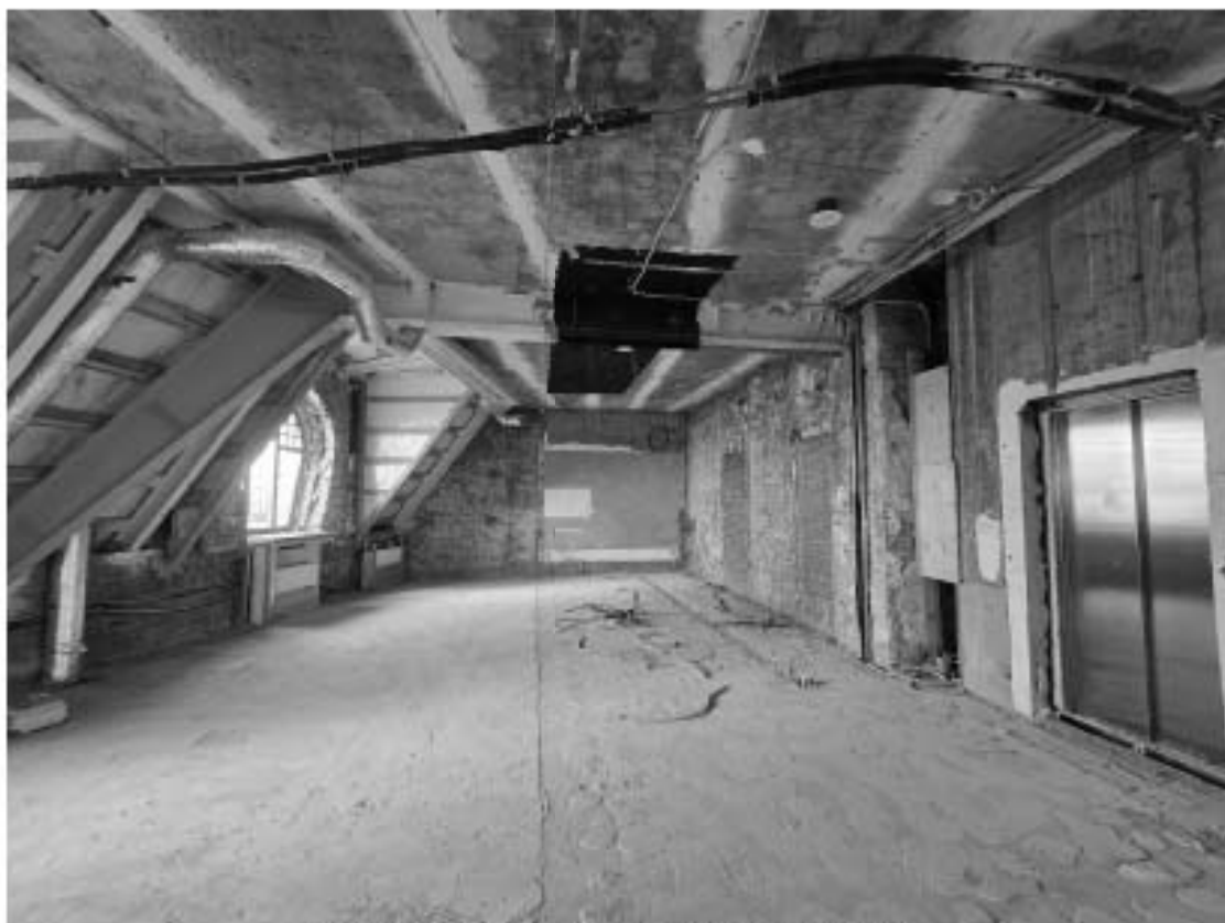
Фото 6.13. 6 этаж, помещение 1-Н (109).
