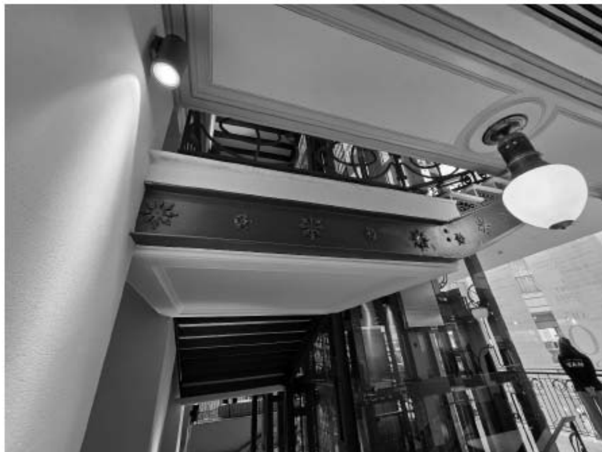
Фото 1.10. Металлический каркас лестницы 1-ЛК.
