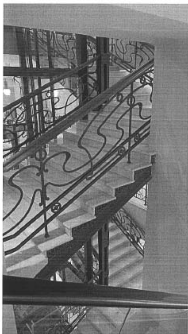
10. Лестница на 3 этаж
