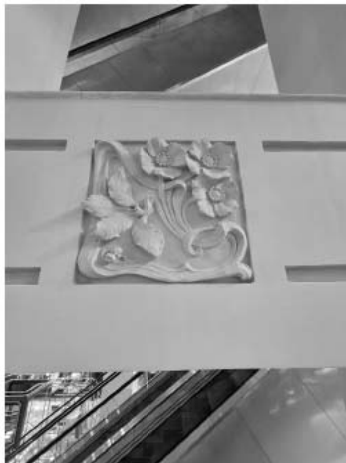
Фото 1.8. 1 этаж, декоративная филенка на междуэтажных перекрытиях, помещение 1-Н (2).
