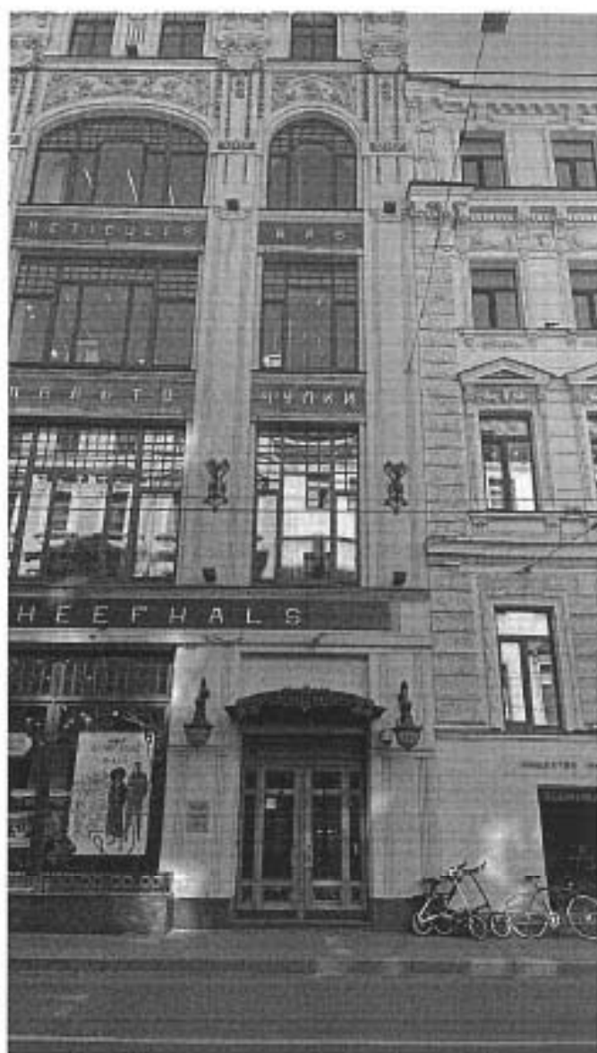
6. Фрагмент западного фасада объекта культурного наследия.
