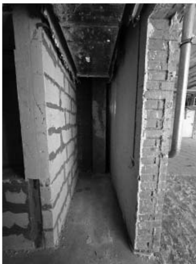
Фото 6.2. 6 этаж, помещение 1-Н (113).
