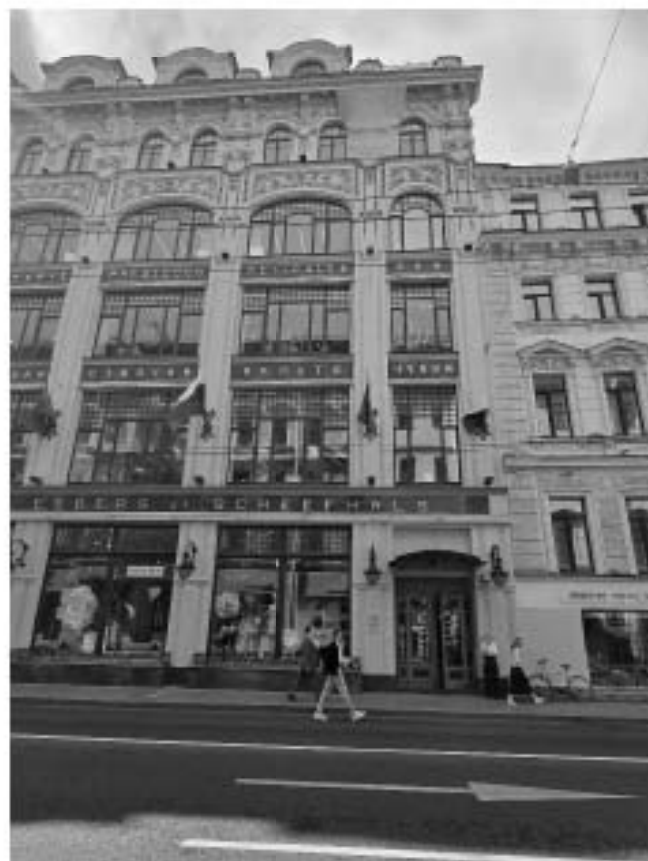
Фото 8. Северо-восточный фасад здания, фрагмент.
