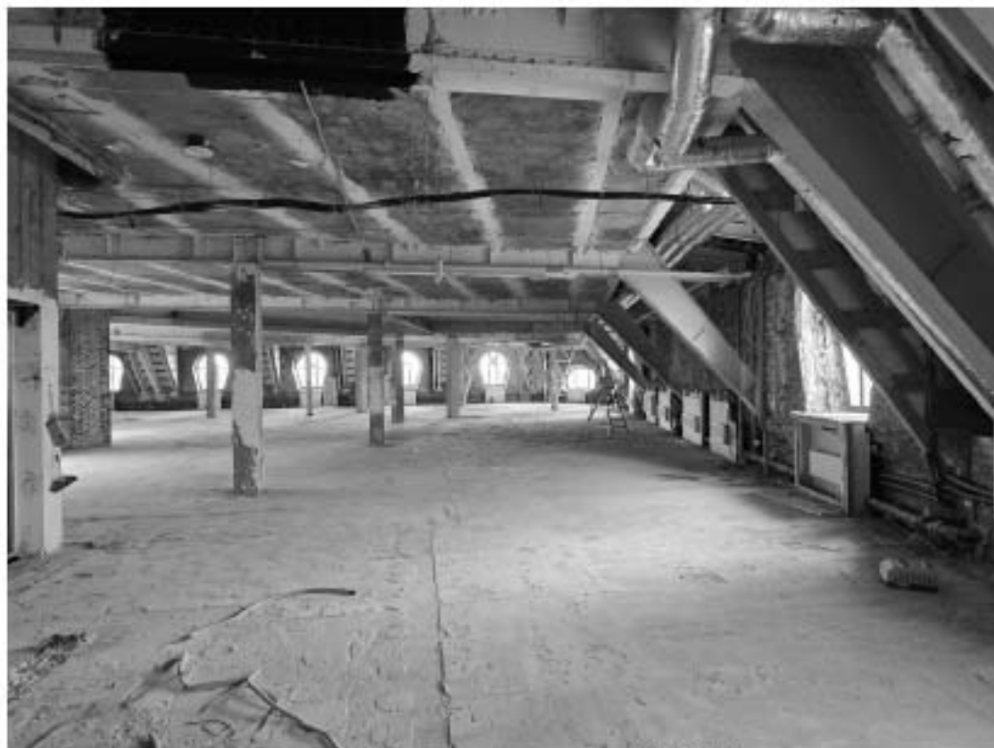
Фото 6.16. 6 этаж, помещение 1-Н (109).
