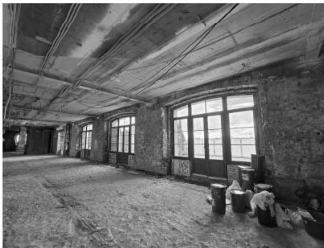
Фото 6.8. 6 этаж, помещение 1-Н (109).
