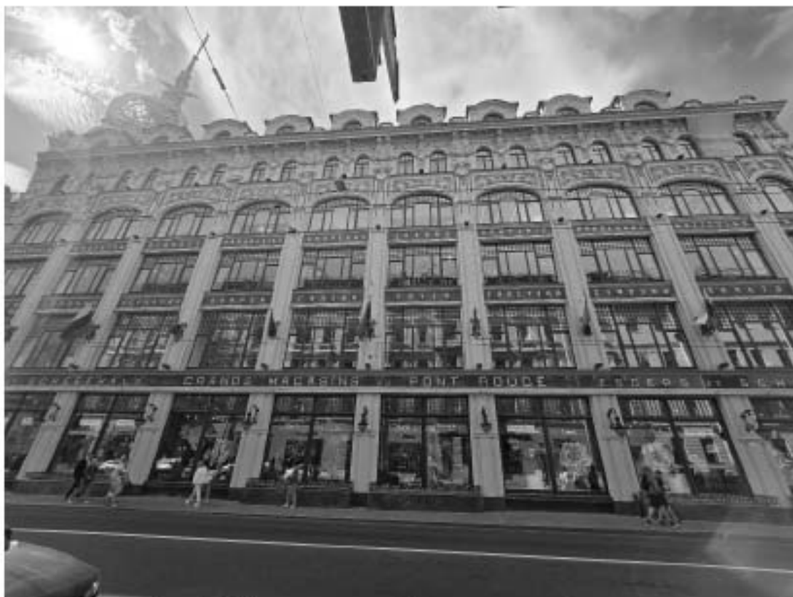
Фото 11. Северо-восточный фасад здания, фрагмент.
