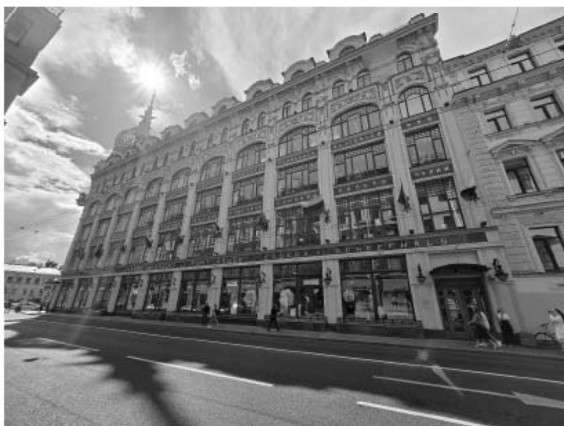
Фото 10. Северо-восточный фасад здания.
