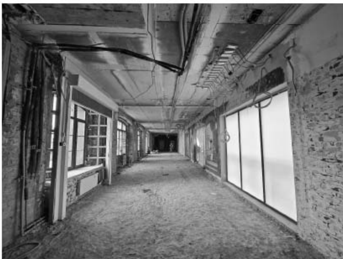
Фото 6.12. 6 этаж, помещение 1-Н (109).
