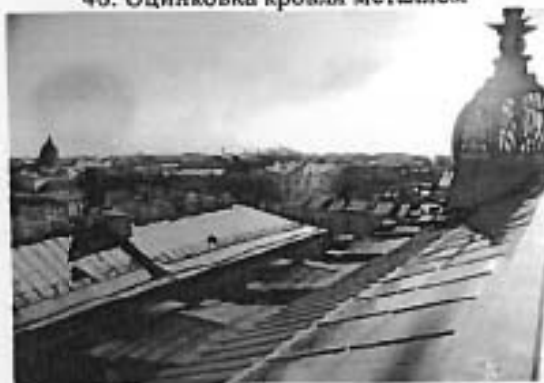
46. Оцинковка кровли металлом
