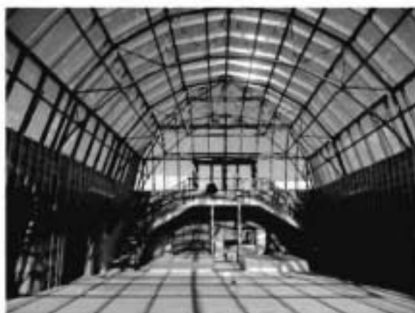
41, 42. Световой колодец естественного освещения
