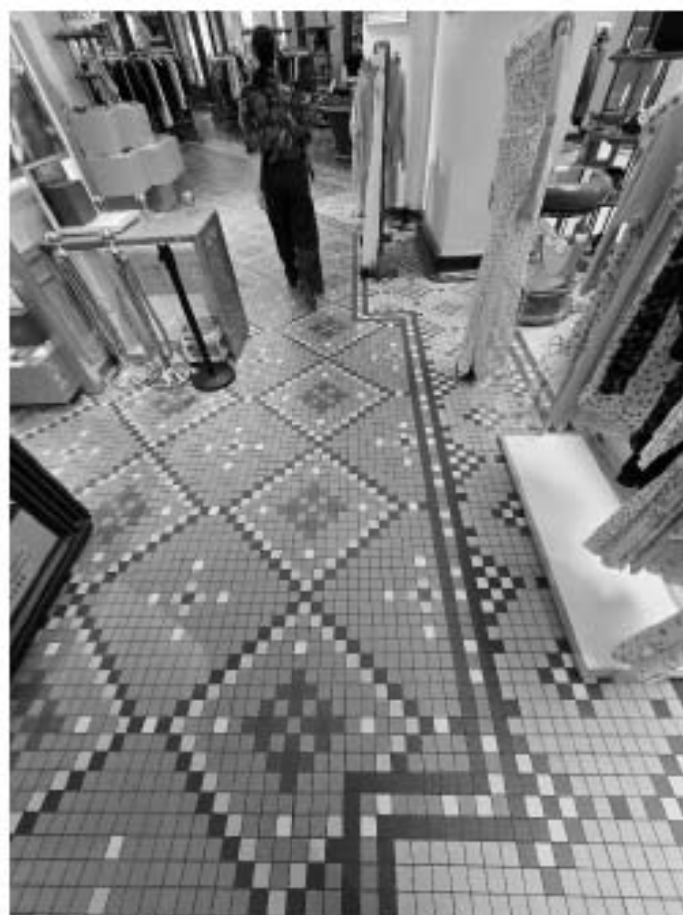
Фото 1.3. 1 этаж, покрытие пола метлахской плиткой, помещение 1-Н (1).
