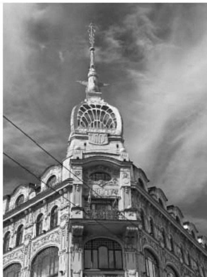
Фото 12. Угловая башня со шпилем и вид на 5-6 этажи юго-восточного фасада.
