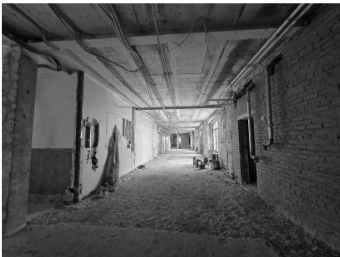
Фото 6.7. 6 этаж, помещение 1-Н (109).
