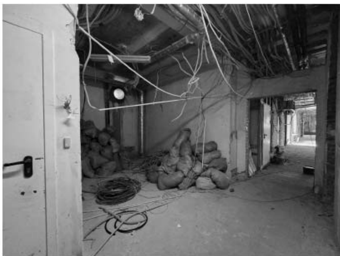
Фото 6.6. 6 этаж, помещение 1-Н (114?).
