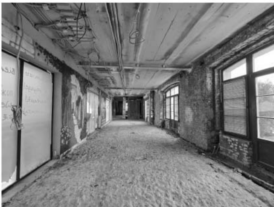
Фото 6.11. 6 этаж, помещение 1-Н (109).
