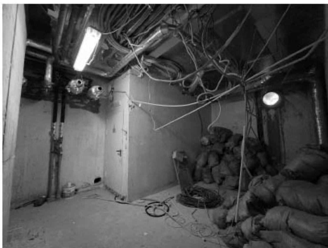
Фото 6.4. 6 этаж, помещение 1-Н (114?).
