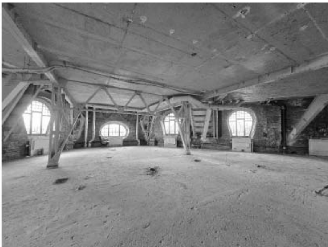
Фото 6.27. 6 этаж, помещение 1-Н (109).
