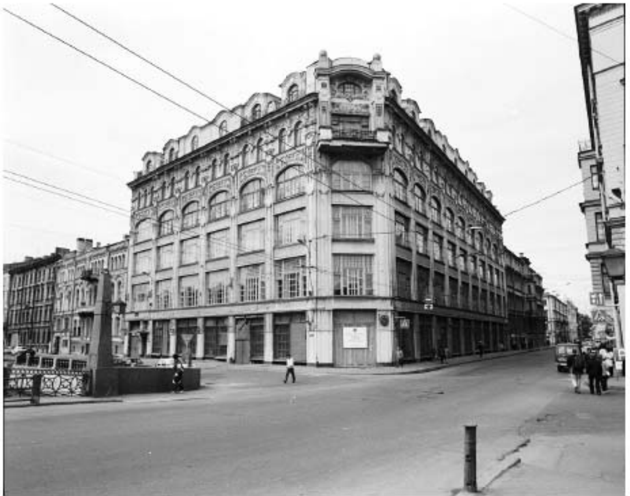
49. Здание Торгового дома «Эсдерс и Схейфальс». Фотография 1996 г. Из открытых интернет-источников.
