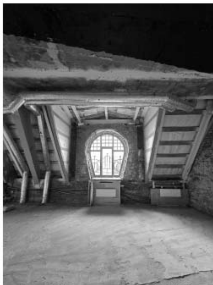
Фото 6.15. 6 этаж, помещение 1-Н (109).
