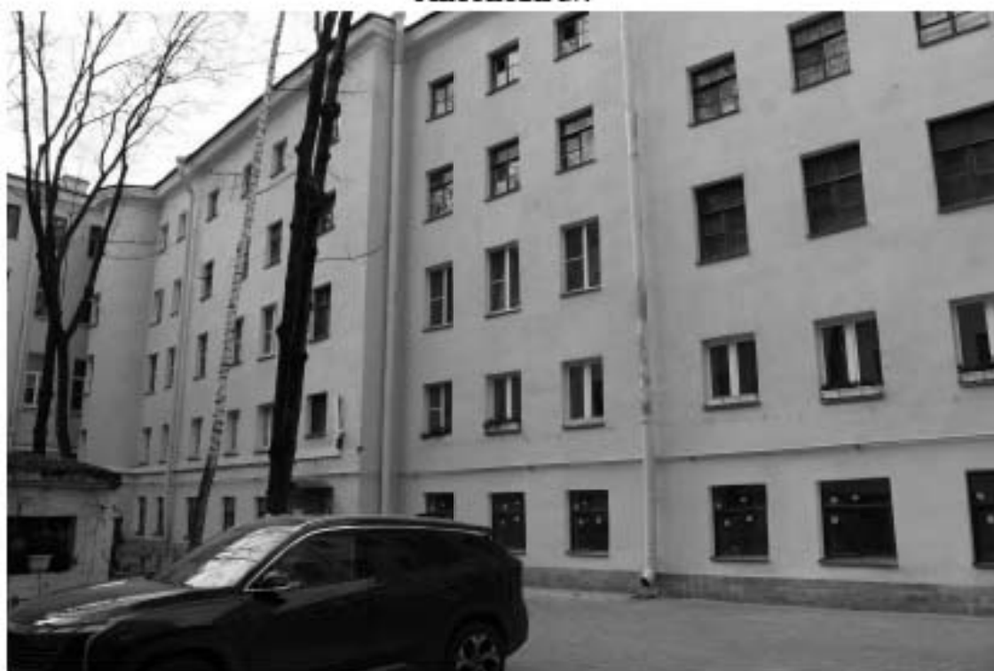
Фото 6. Вид на фасад западного дворового корпуса объекта культурного наследия регионального значения «Дом, где жили в 1872-1875 гг. композитор Мусоргский Модест Петрович и в 1867-1868 гг. композитор Кюн Цезарь Антонович».
