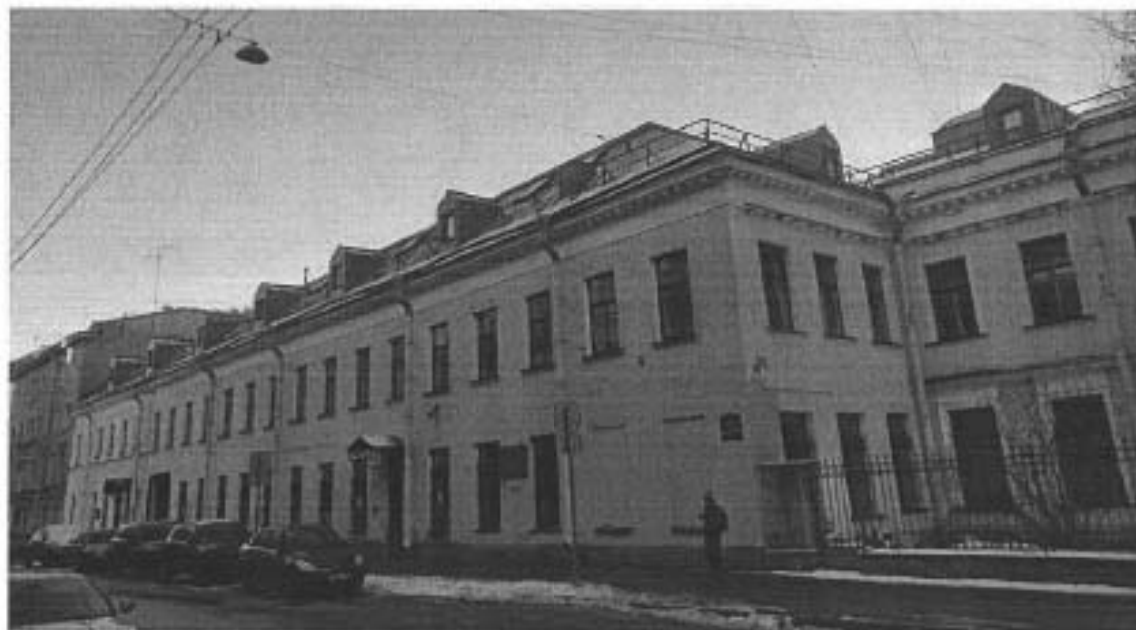
2. Лицевой фасад со стороны ул. 4-я Красноармейская
