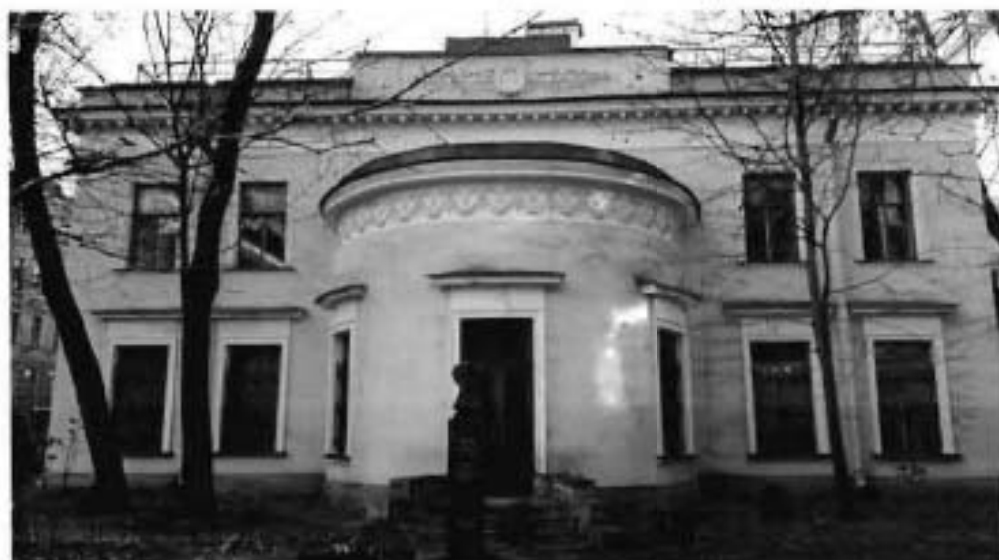
2, 3. Восточный фасад здания
