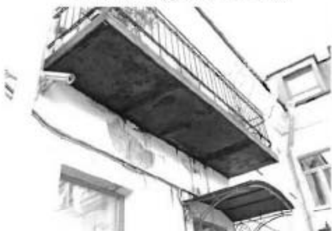
16. Балкон в уровне 2-го этажа
