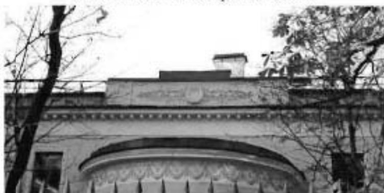
5. Аттик восточного фасада здания
