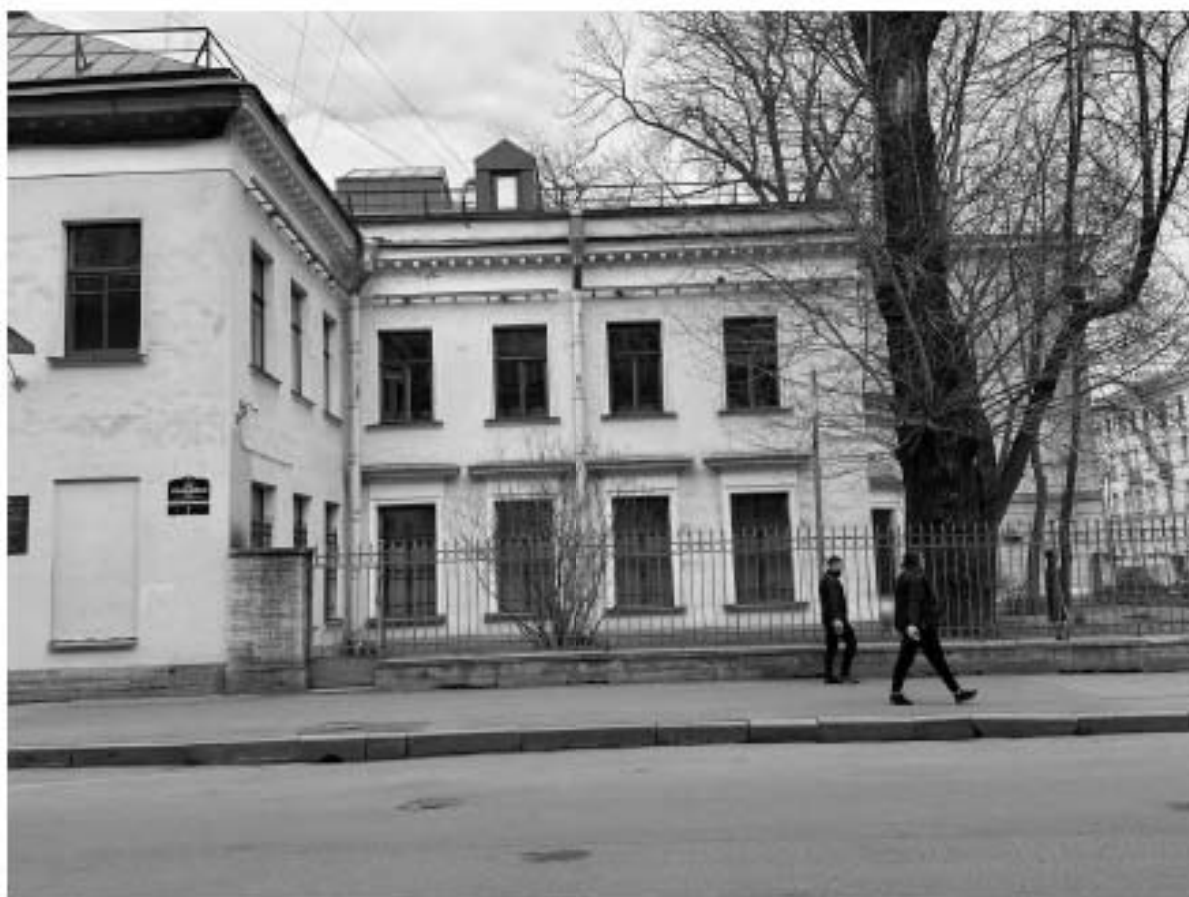
Фото 3. Вид здания по 4-ой Красноармейской ул.
