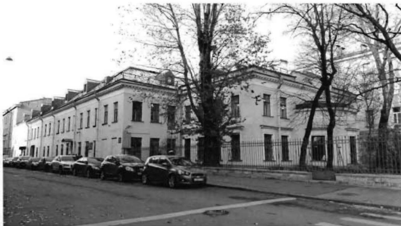
1. Вид с юго-восточной стороны
