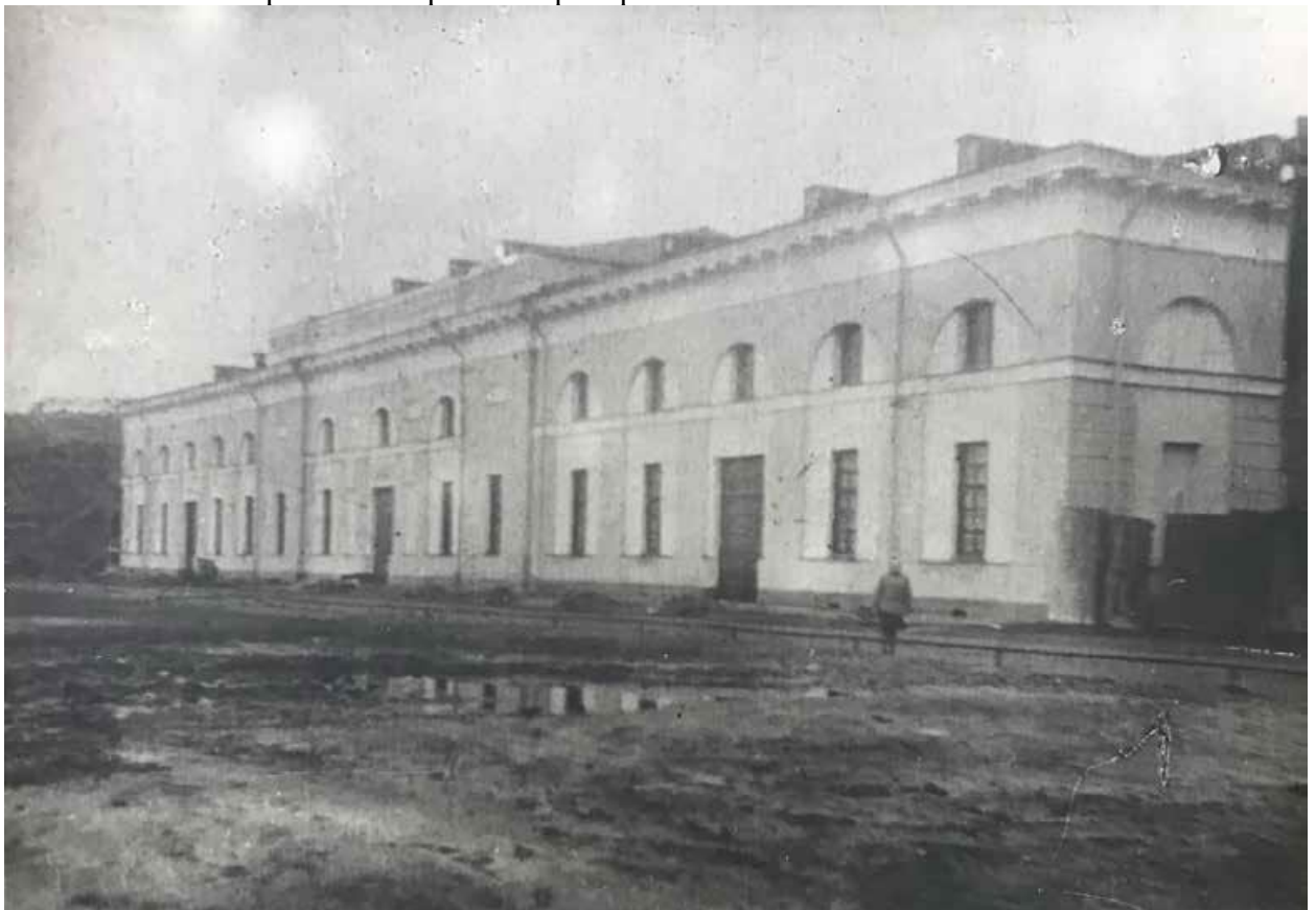
26. Измайловские провиантские магазины. Фасад корпуса № 3 по Обводному. Каналу. 1951 г. // КГИОП. № 37077/1
