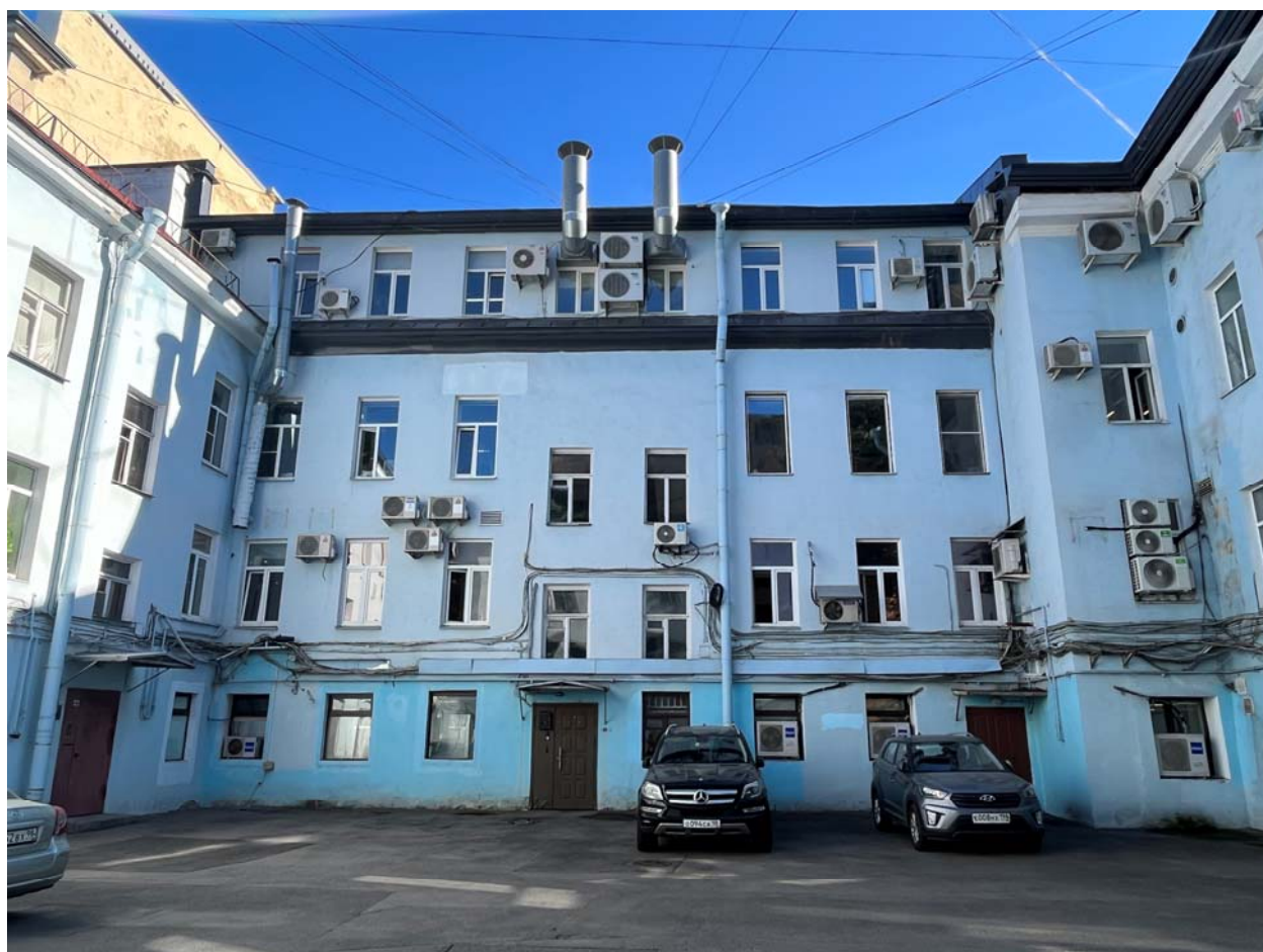
56. Северо-западный дворовый фасад.
