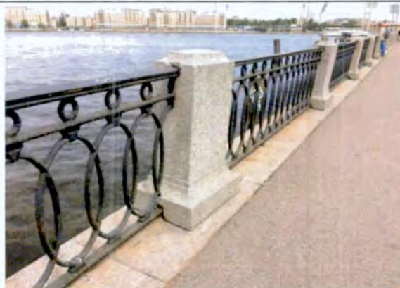
парапетные вертикальные тумбы с профилированным плинтом и завершением в виде усеченной трапеции (розовый овоидальный гранит рапакиви – от восточного берегового устоя Тучкова моста до западного берегового устоя Биржевого моста) с металлическими ажурными решетками между ними – кованые металлические звенья в виде пересекающихся овальных элементов, с фризом из колец по верхнему поясу;
