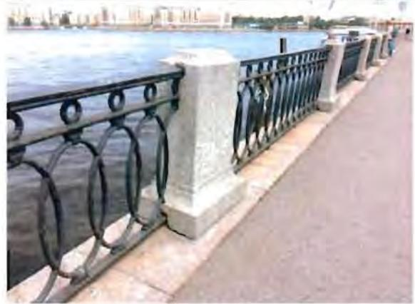
парапетные вертикальные тумбы с профилированным плинтом и завершением в виде усеченной трапеции (розовый овоидальный гранит рапакиви – от восточного берегового устоя Тучкова моста до западного берегового устоя Биржевого моста) с металлическими ажурными решетками между ними – кованые металлические звенья в виде пересекающихся овальных элементов, с фризом из колец по верхнему поясу;
