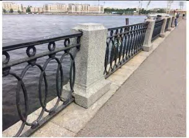
парапетные вертикальные тумбы с профилированным плинтусом и завершением в виде усеченной трапеции (розовый овоидальный гранит рапакиви – от восточного берегового устоя Тучкова моста до западного берегового устоя Биржевого моста) с металлическими ажурными решетками между ними – кованые металлические звенья в виде пересекающихся овальных элементов, с фризом из колец по верхнему поясу;
