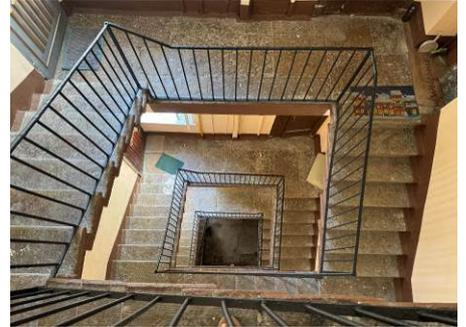
историческая «чёрная» лестница (ЗН) - местоположение, габариты. конфигурация, тип (двухмаршевая), материал ступеней (известняк), ограждение: материал (металл), рисунок (из вертикальных стоек);
