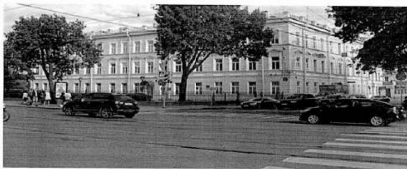
1. Общий вид лицевого фасада.
