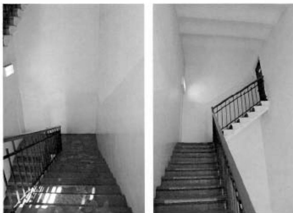
Фото №21, 22. Черная лестница.
