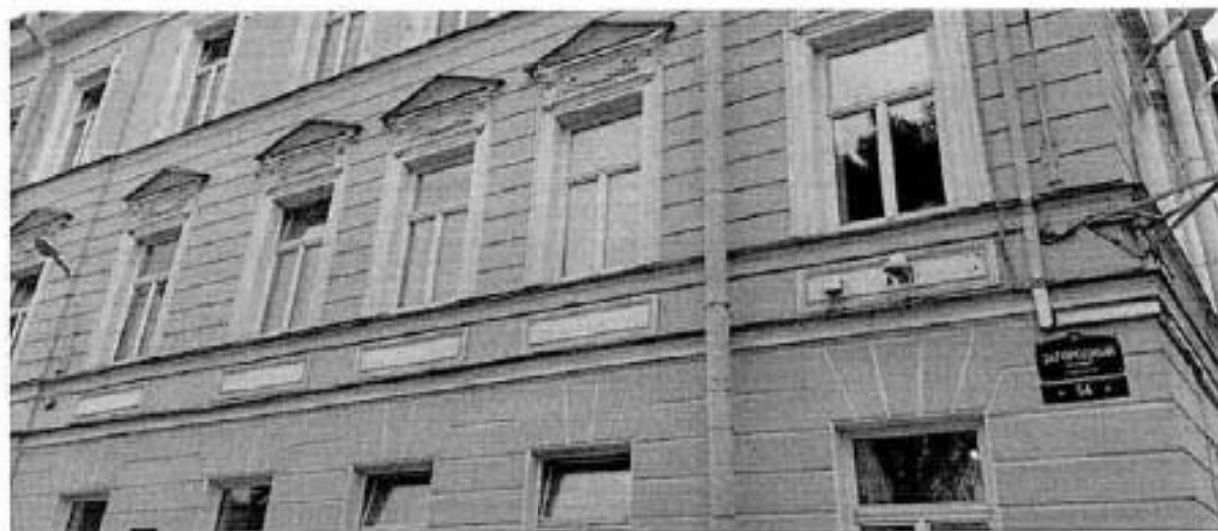
6. Фрагмент лицевого фасада со стороны Загородного проспекта.
