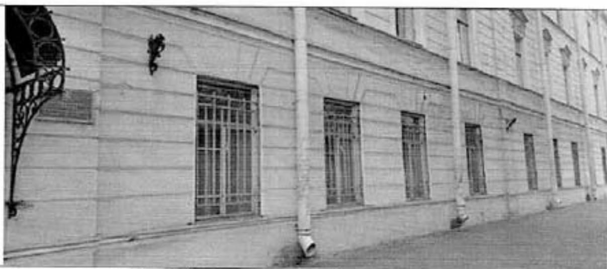
2. Лицевой фасад, со стороны Введенского канала.
