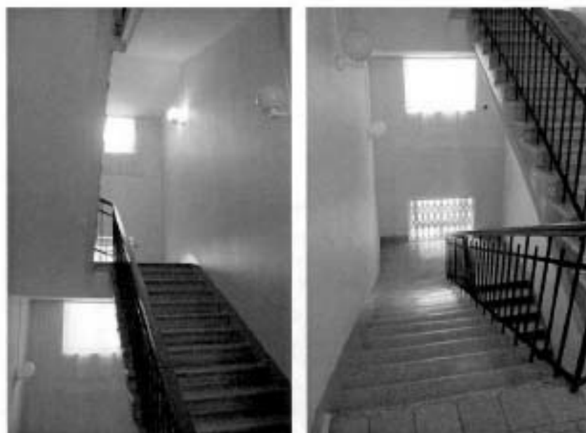
Фото №13, 14. Черная лестница.
