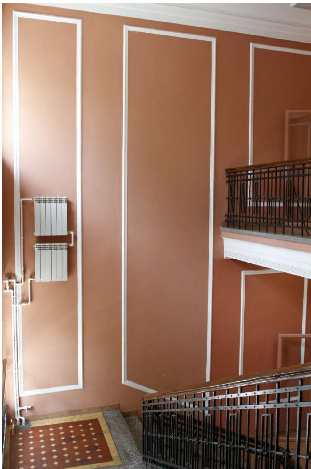
25. «Здание бань (с оградой)» . Санкт-Петербург, Ярославский пр., д.16, литера А. Парадная лестница. Междуэтажная площадка в уровне 2-го этажа. Фото: 05.07.2025.
