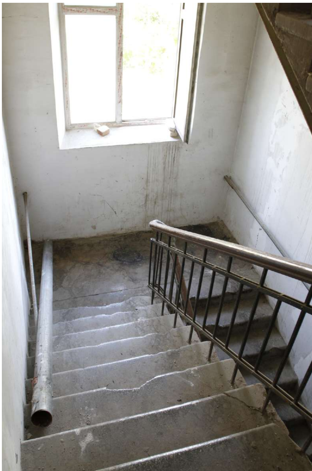
37. «Здание бань (с оградой)» . Санкт-Петербург, Ярославский пр., д.16, литера А. Техническая лестница в уровне 3-го этажа. Фото: 05.07.2025.
