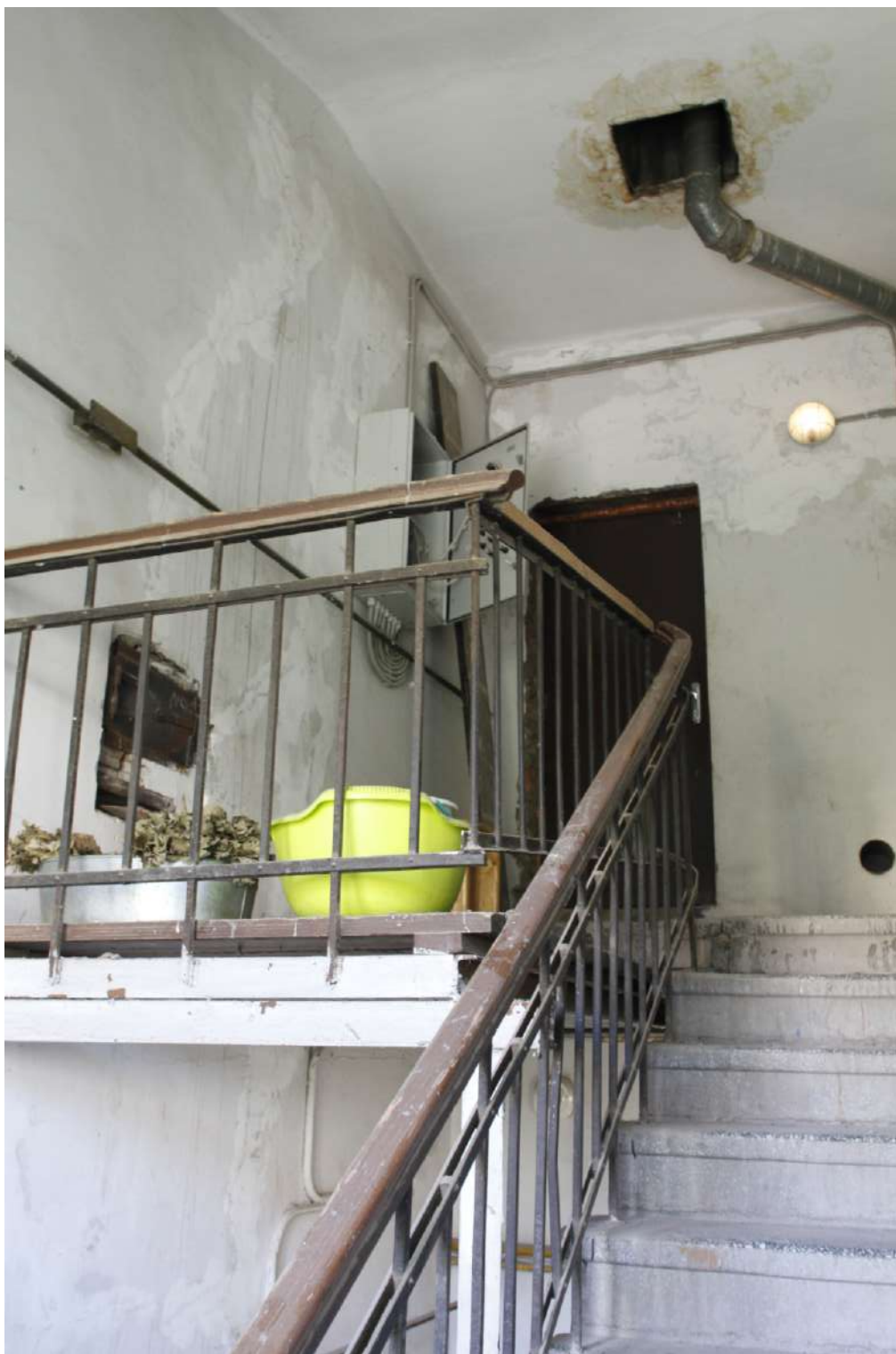
38. «Здание бань (с оградой)» . Санкт-Петербург, Ярославский пр., д.16, литера А. Техническая лестница в уровне чердака. Фото: 05.07.2025.
