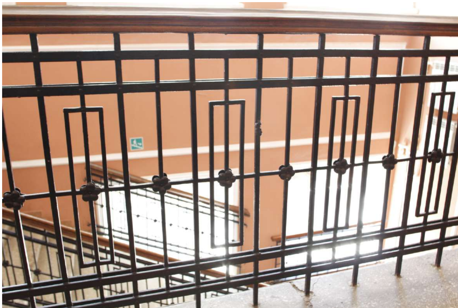
29. «Здание бань (с оградой)» . Санкт-Петербург, Ярославский пр., д.16, литера А. Парадная лестница. Фрагмент лестничного ограждения. Фото: 05.07.2025.
