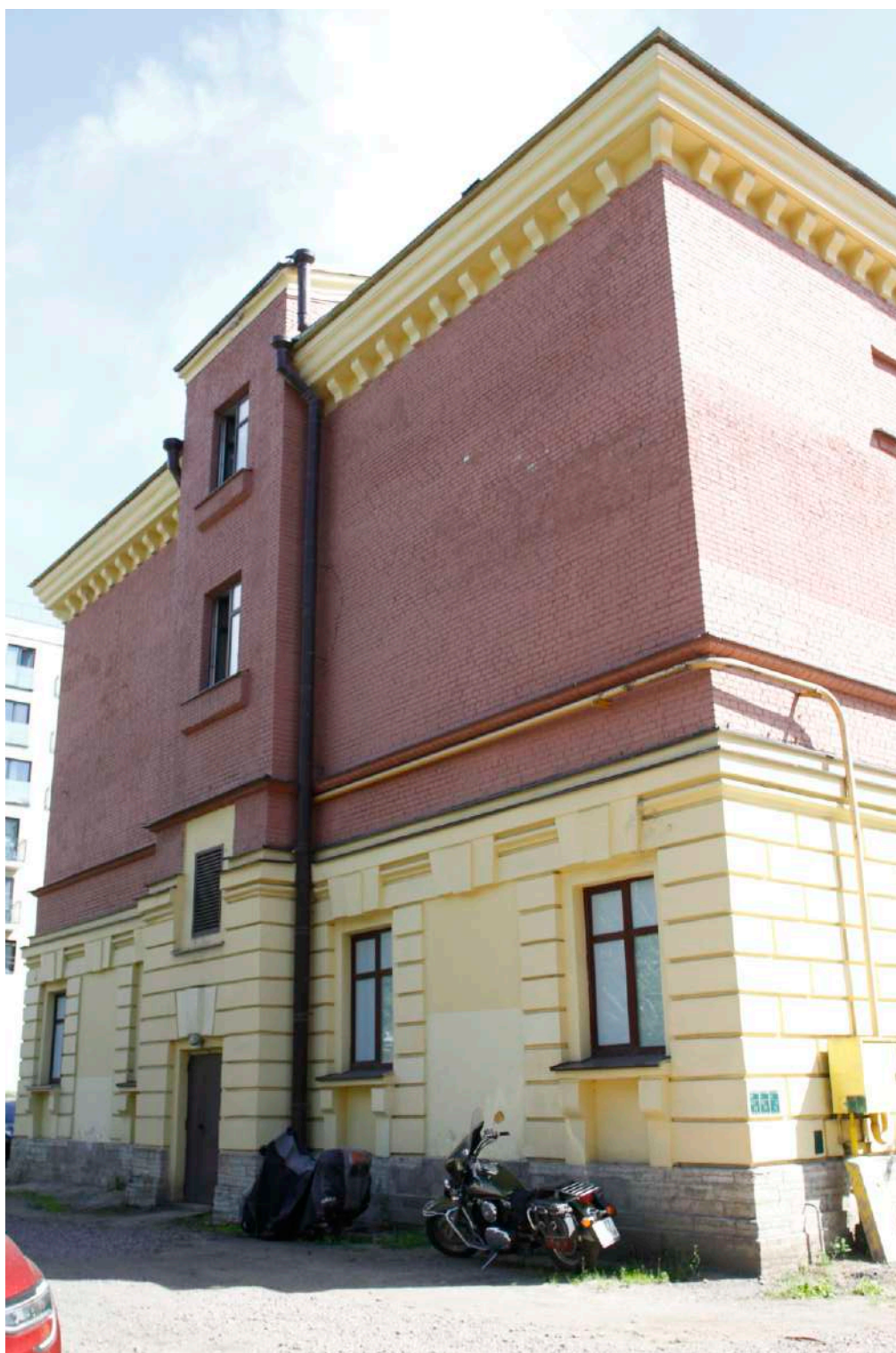
19. «Здание бань (с оградой)» . Санкт-Петербург, Ярославский пр., д.16, литера А. Северный фасад. Общий вид. Фото: 05.07.2025.
