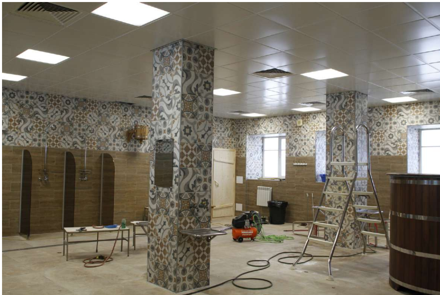
34. «Здание бань (с оградой)» . Санкт-Петербург, Ярославский пр., д.16, литера А. Фрагмент помещения 3-го этажа. Фото: 05.07.2025.
