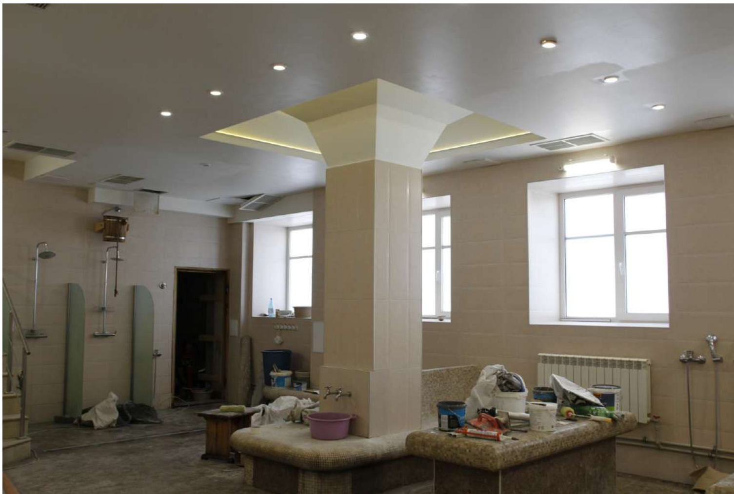
23. «Здание бань (с оградой)» . Санкт-Петербург, Ярославский пр., д.16, литера А. Фрагмент помещения 2-го этажа. Фото: 05.07.2025.
