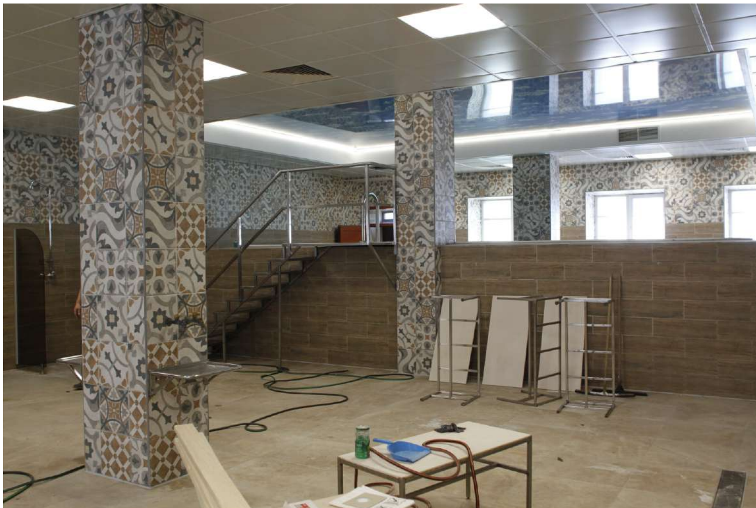
35. «Здание бань (с оградой)» . Санкт-Петербург, Ярославский пр., д.16, литера А. Фрагмент помещения 3-го этажа. Фото: 05.07.2025.
