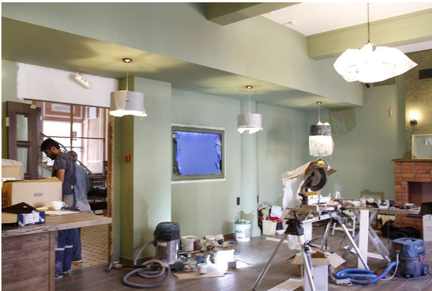
9. «Здание бань (с оградой)» . Санкт-Петербург, Ярославский пр., д.16, литера А. 1-й этаж. Фрагмент помещения (кафе). Фото: 05.07.2025.
