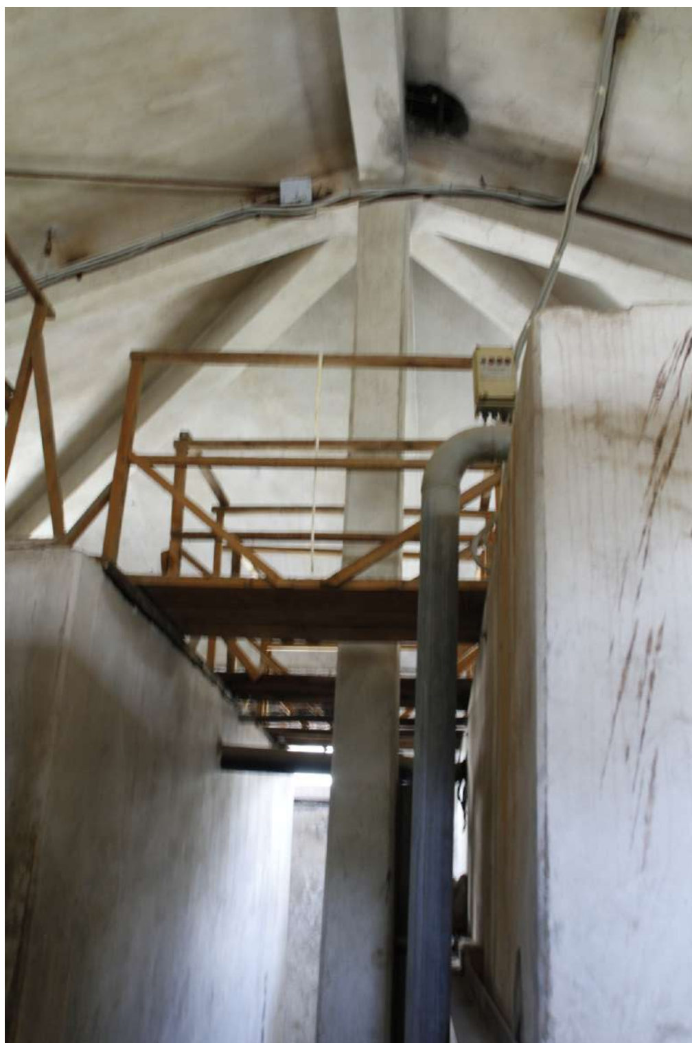
39. «Здание бань (с оградой)» . Санкт-Петербург, Ярославский пр., д.16, литера А. Фрагмент чердачного пространства. Фото: 05.07.2025.
