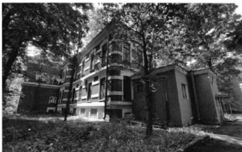
3. Общий вид с северо-восточной стороны.
