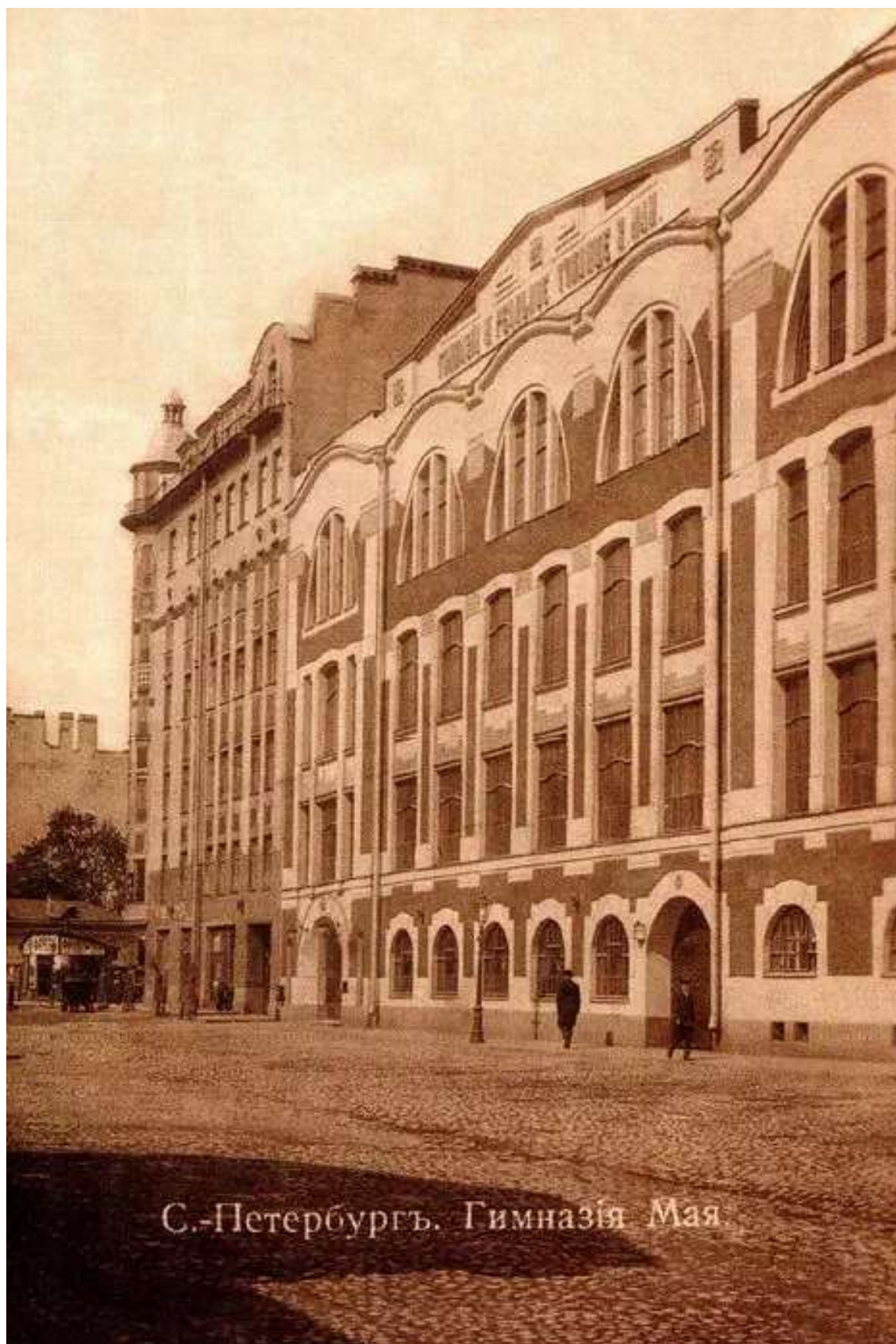
79. Гимназия К. Мая на 14-й линии В.О. Фотография. Автор фото неизвестен. 1914 г. // Источник: [Электронный ресурс] URL: https://pastvu.com/p/121101 .
