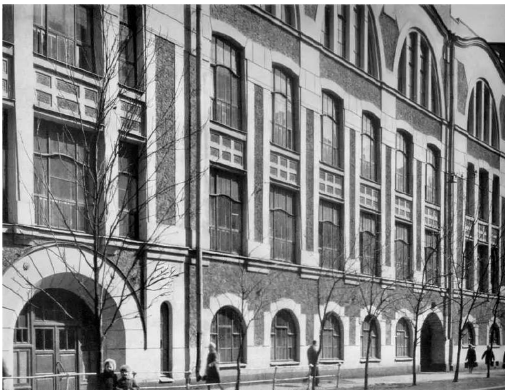
91. 14-я линия Васильевского острова, 39. Фотография. Автор фото неизвестен. 1965–1971 гг. // Источник: [Электронный ресурс] URL: https://pastvu.com/p/946343 .
