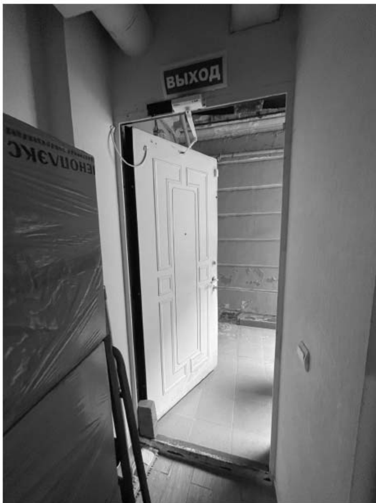
19. Вид входной двери со стороны двора изнутри.
