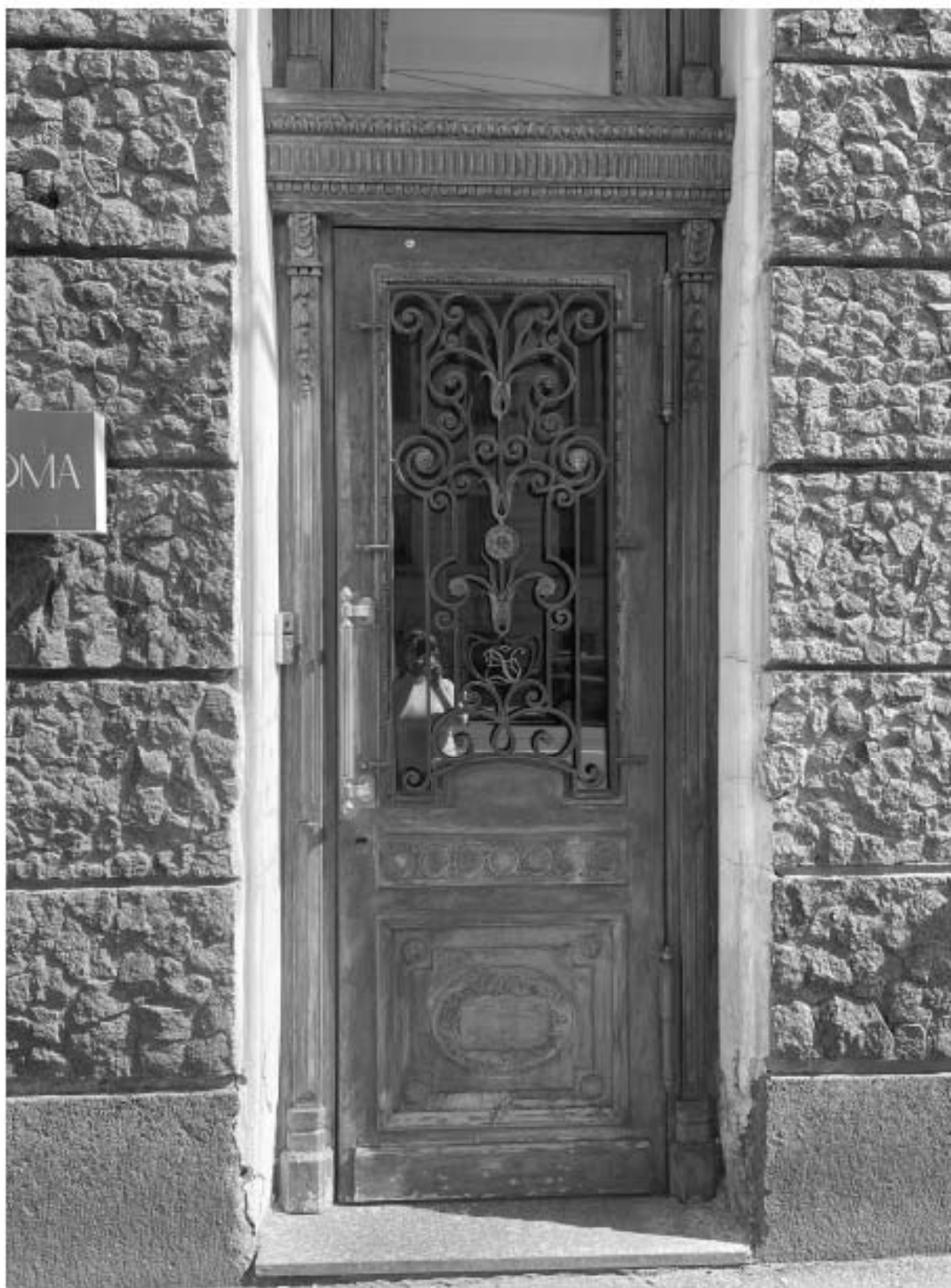
3. Входная дверь в помещение 1-Н со стороны лицевого фасада.
