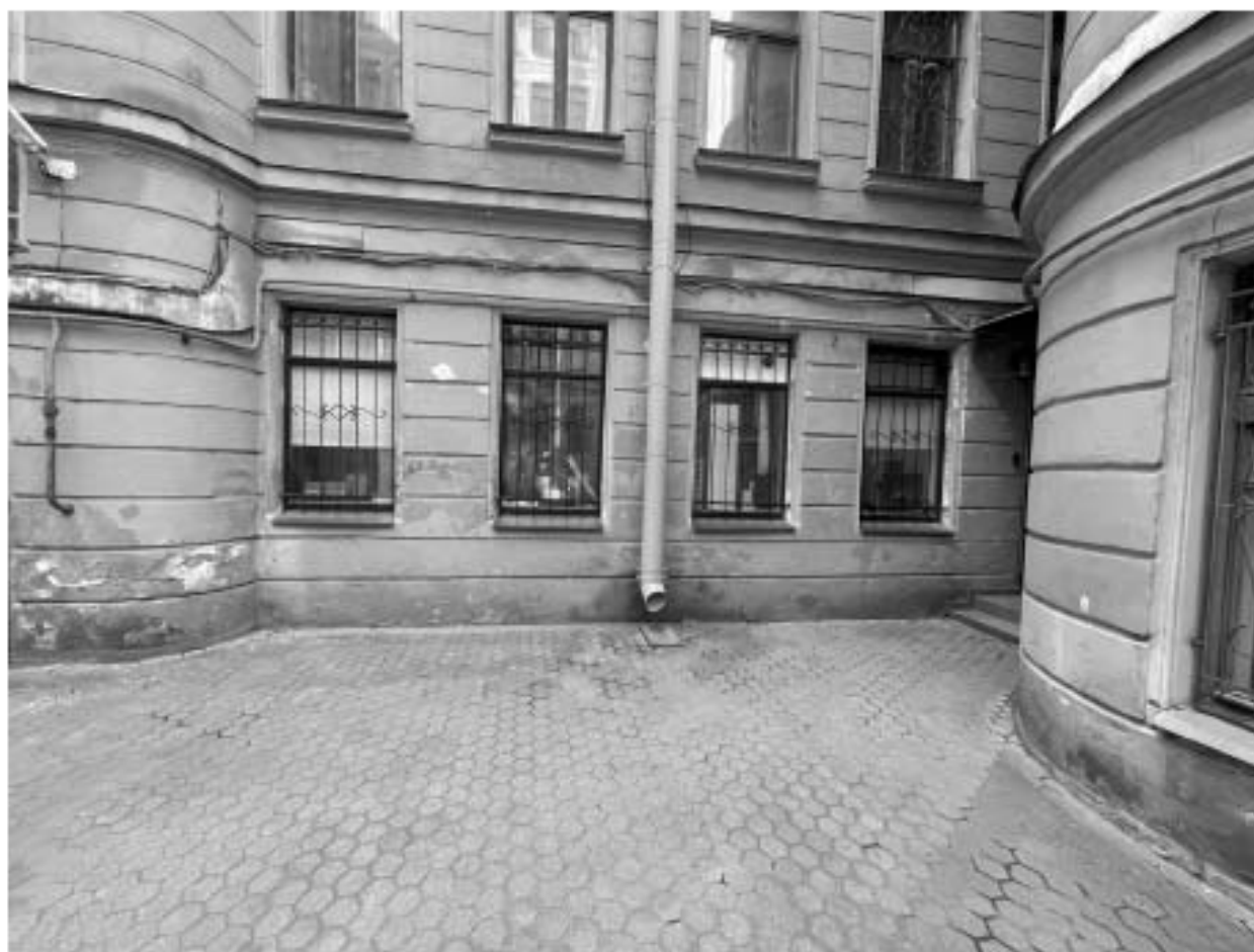
4. Фрагмент дворового фасада. Оконные проемы помещения 1-Н.
